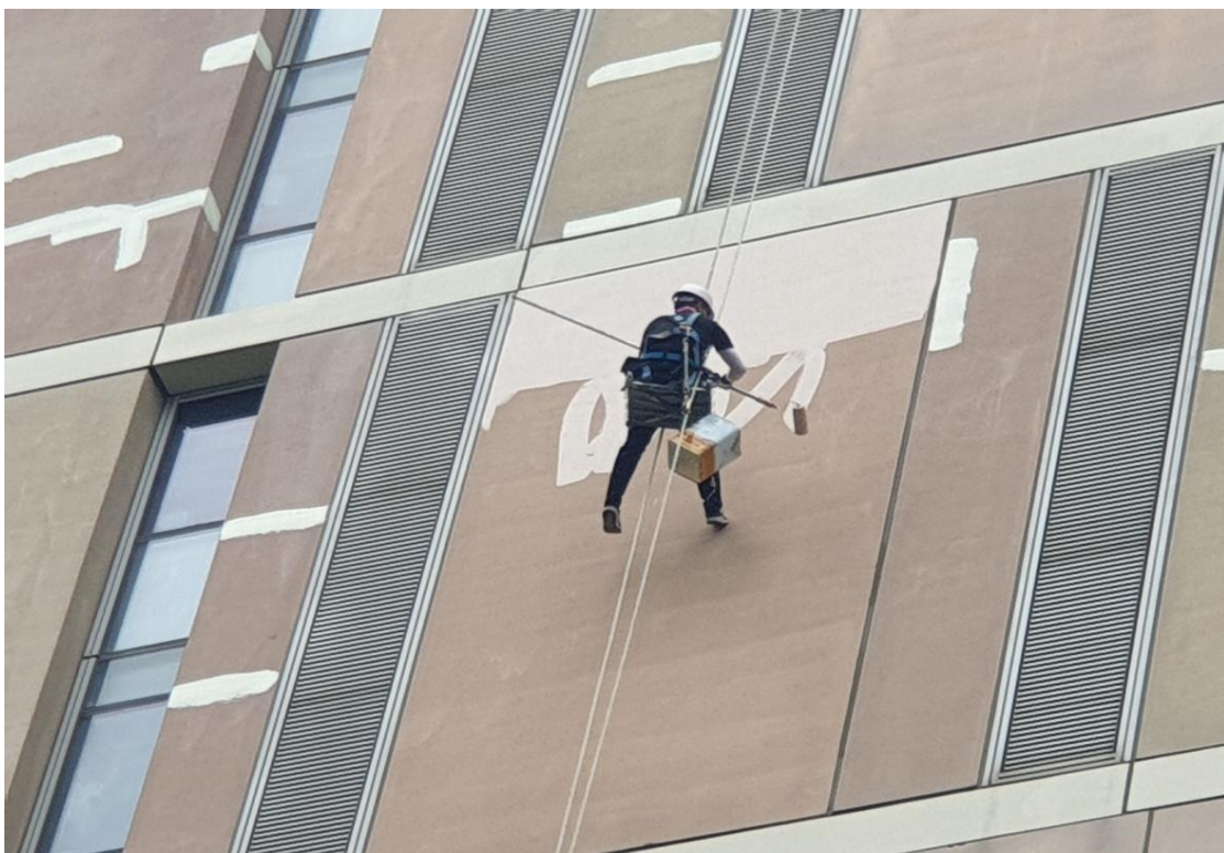
수성페인트 도장
