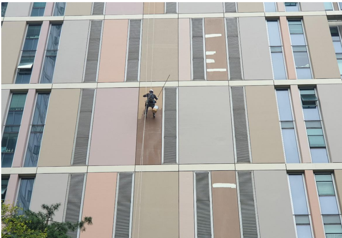
수성페인트 도장
