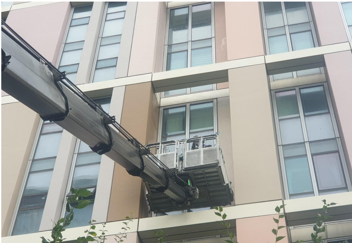
수성페인트 도장
