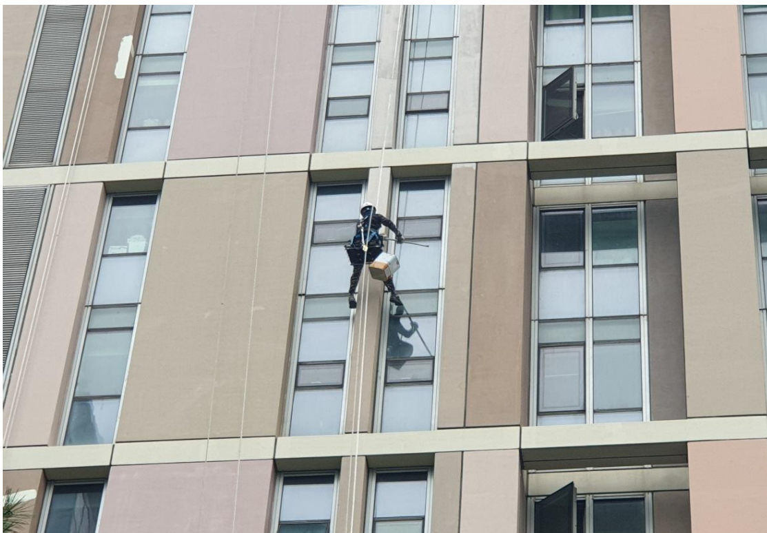
수성페인트 도장
