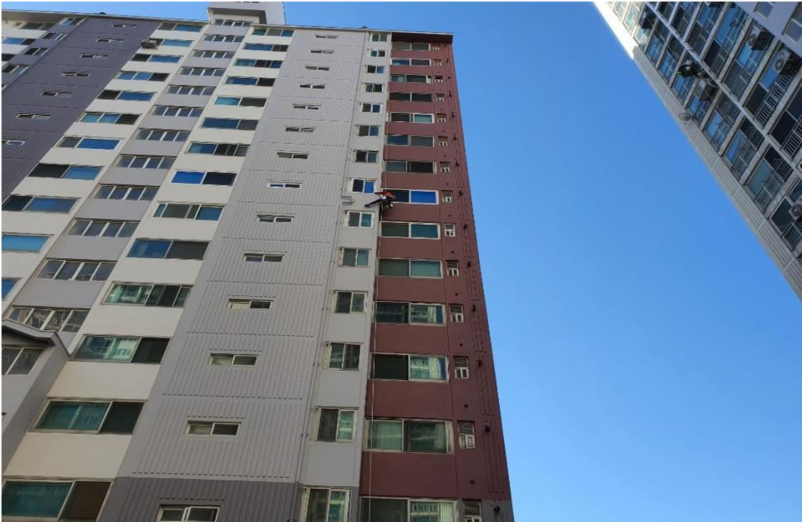
외벽 수성페인트 도장중
