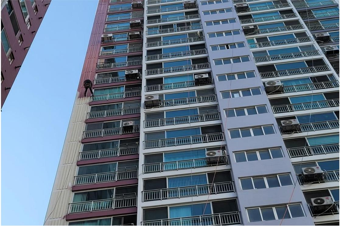
외벽 수성페인트 도장중
