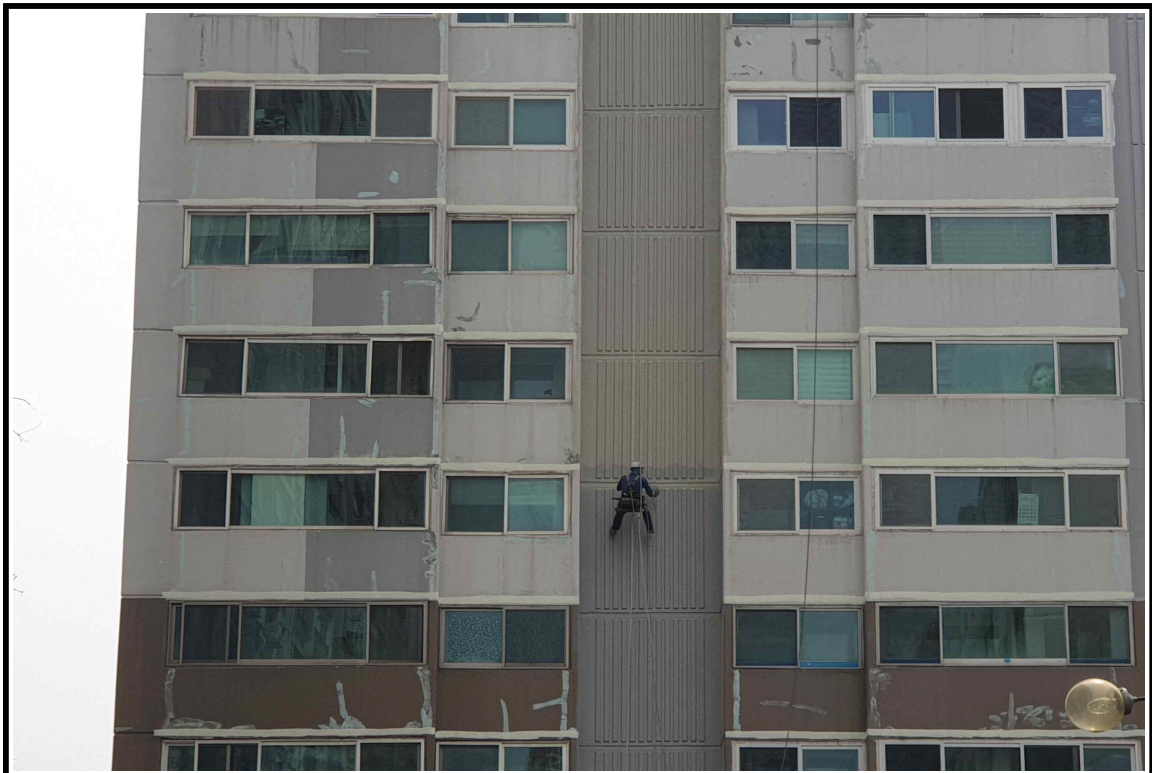
◎ 외부 수성 도장 작업 중
