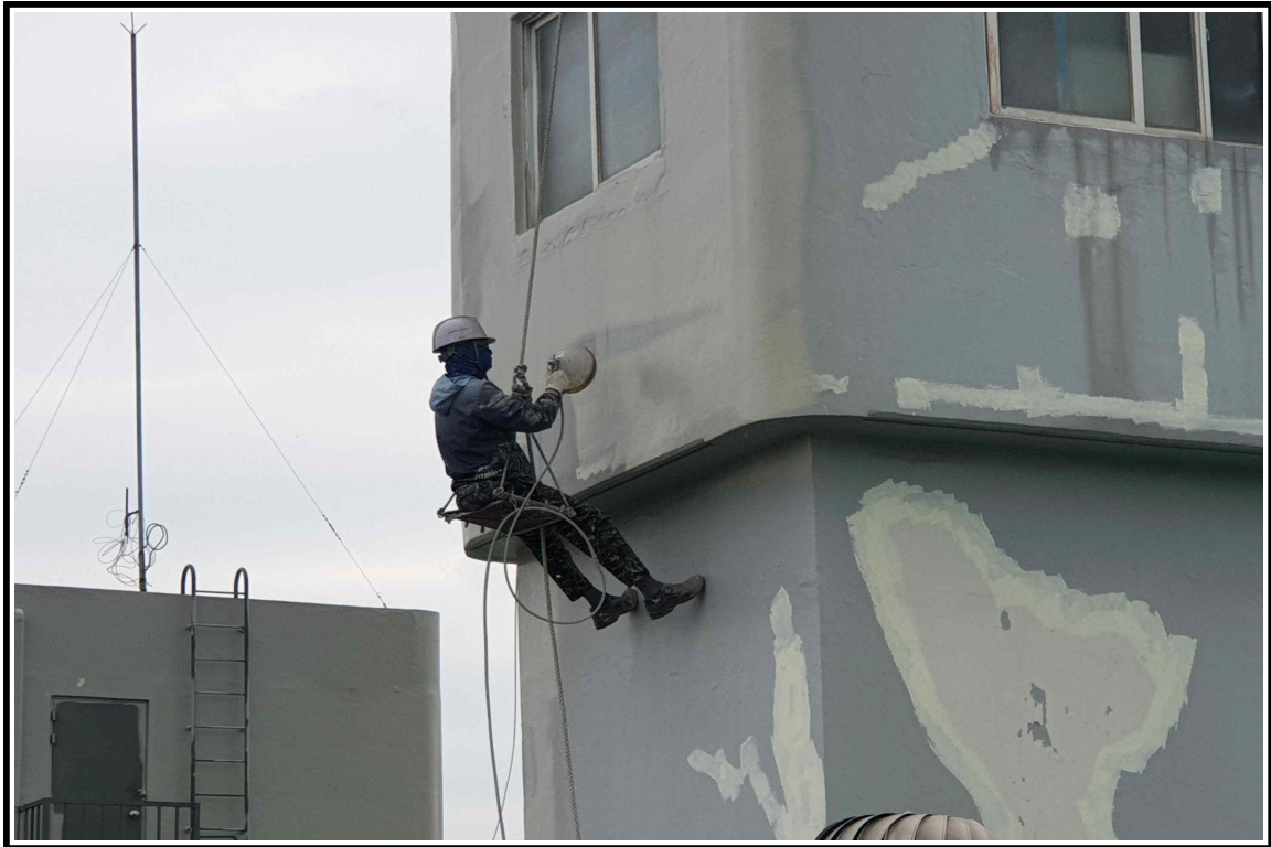
◎ 외부 수성 도장 작업 중
