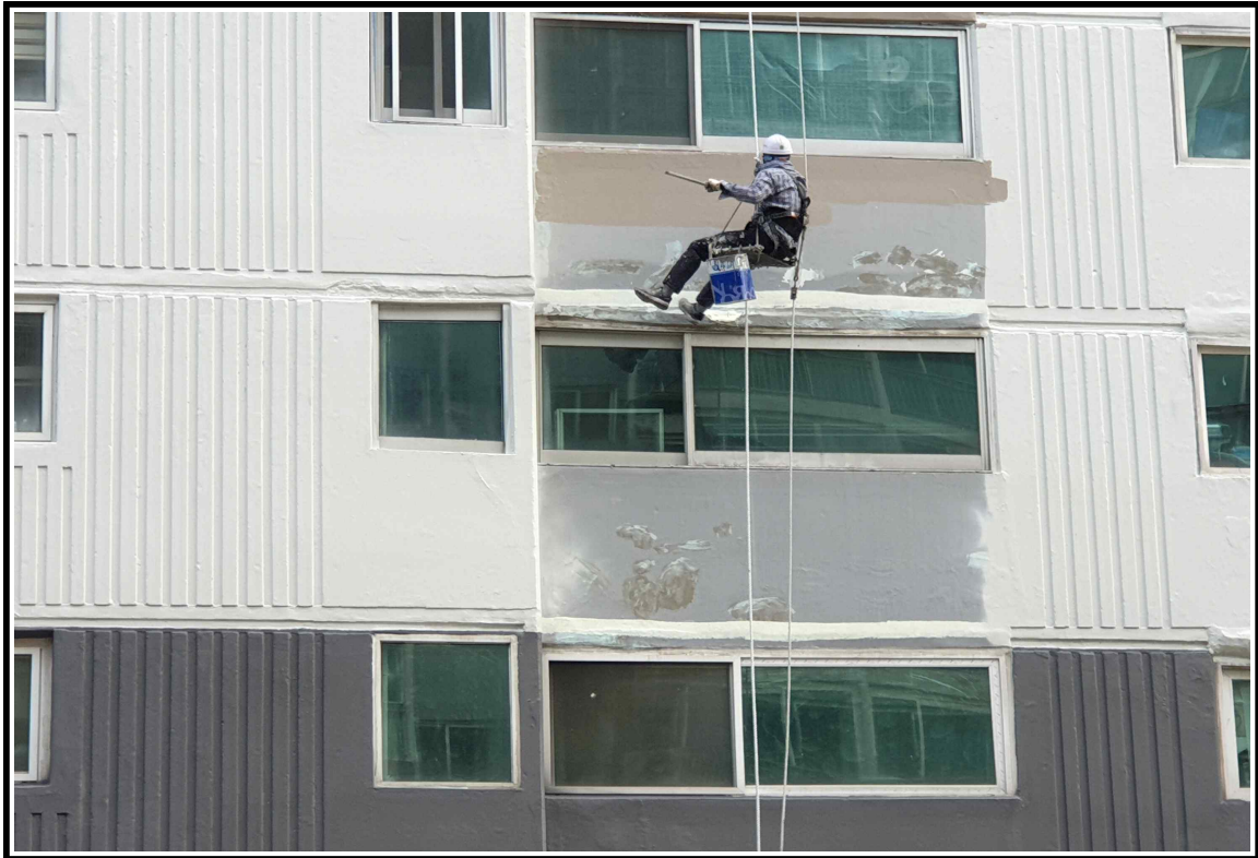
◎ 외부 수성 도장 작업 중
