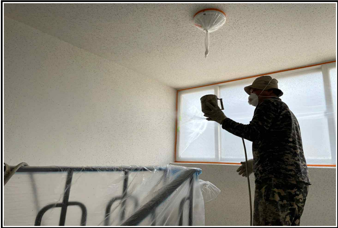
● 내부 무늬코트 작업 중
