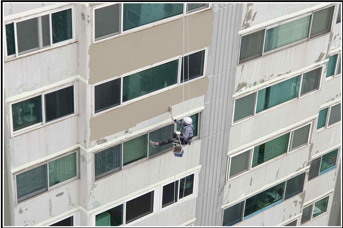
◎ 외부 수성 도장 작업 중
