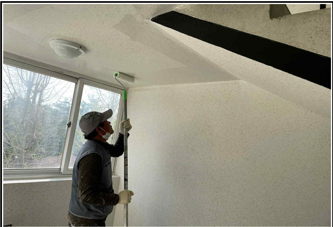
● 내부 코팅 작업 중
