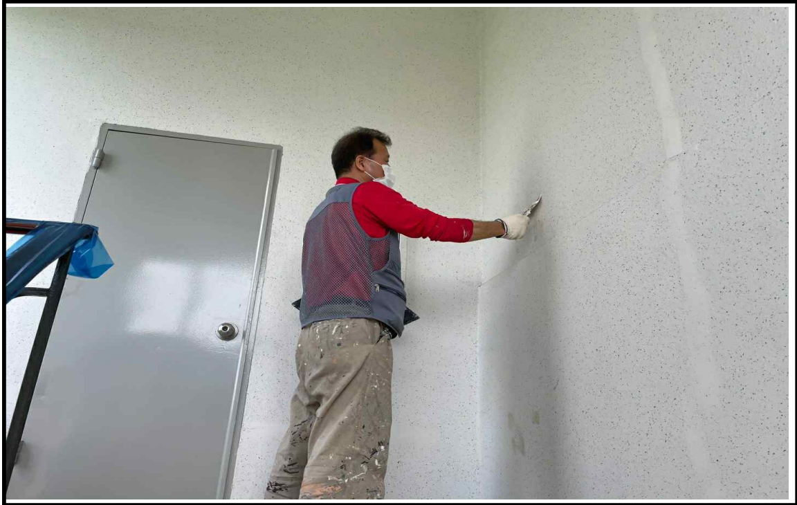
◎ 내부 균열보수 작업 중
