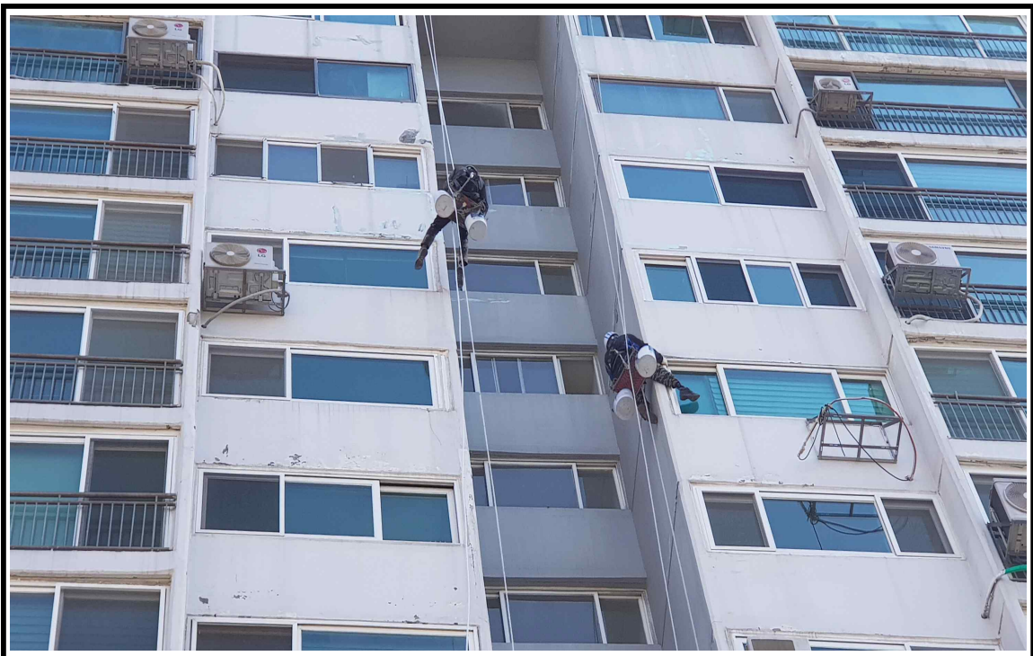
◎ 외부 균열보수 작업 중
