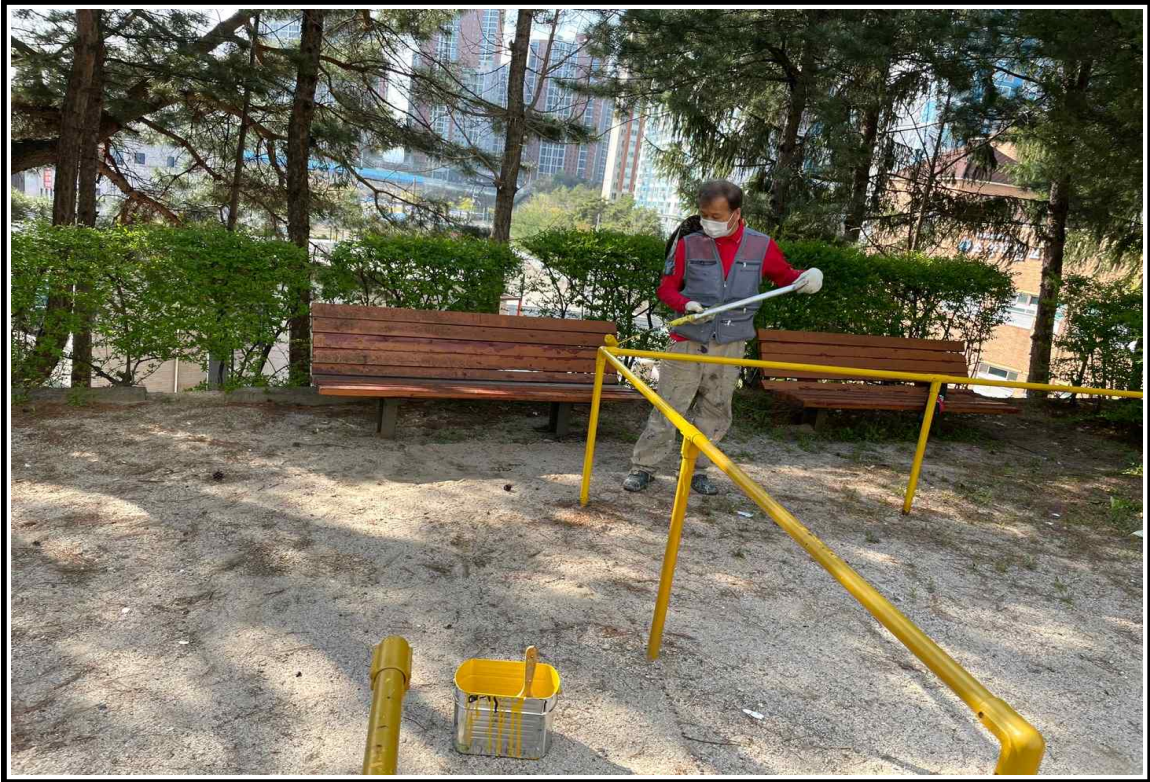
◎ 부대시설 작업 중
