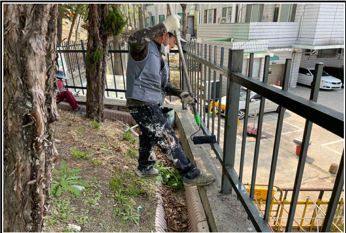
◎ 부대시설 작업 중
