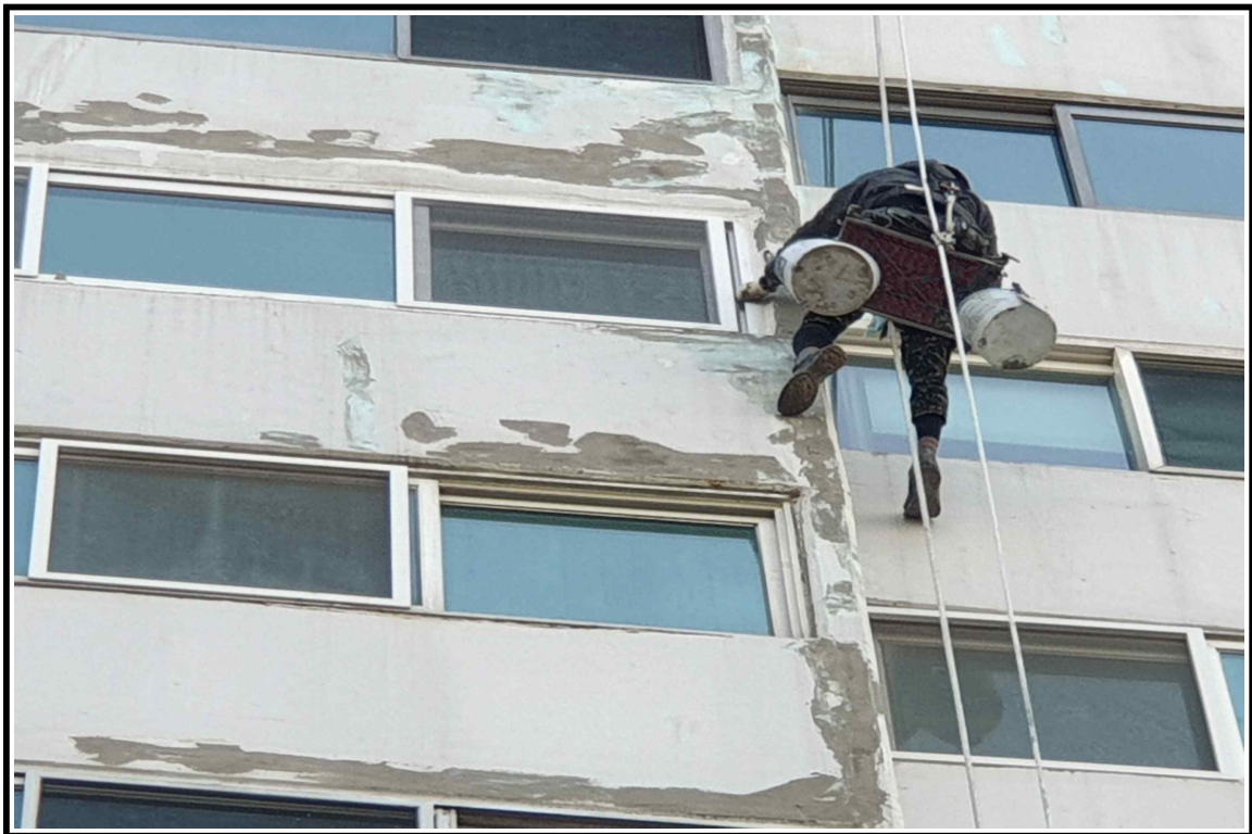
◎ 외부 균열보수 작업 중
