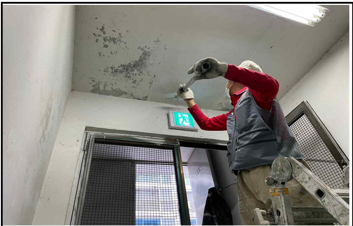
◎ 내부 균열보수 작업 중
