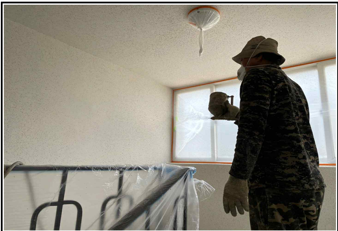
● 내부 무늬코트 작업 중
