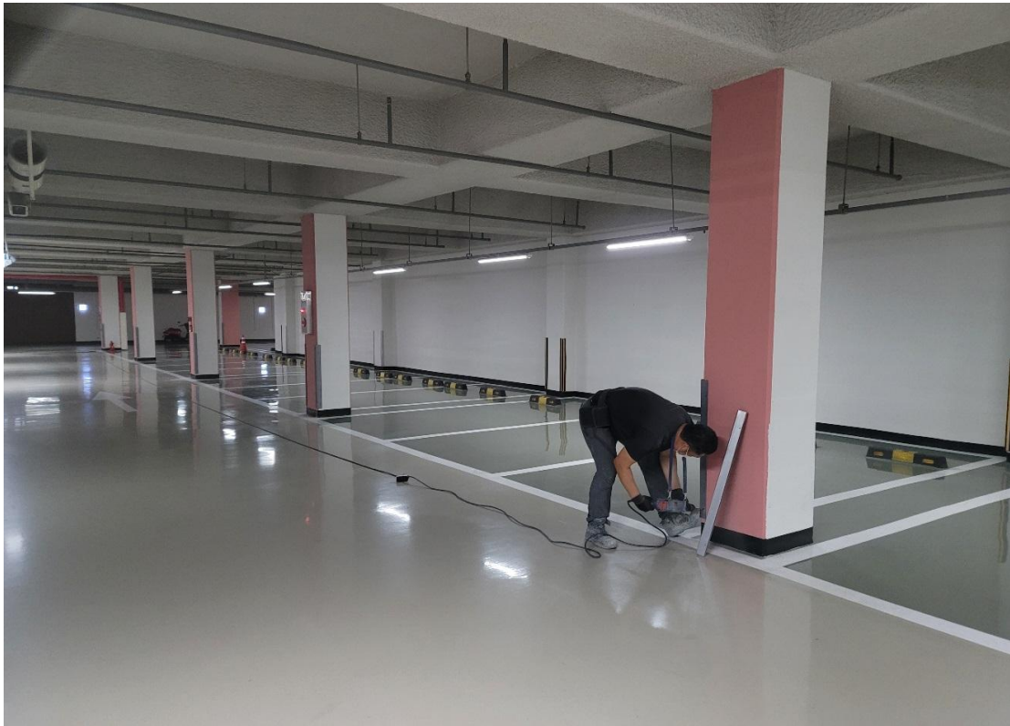
기둥 코너 보호대 설치
