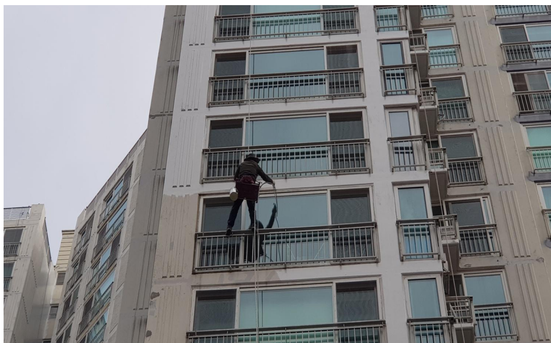
외벽 균열보수 및 도장
