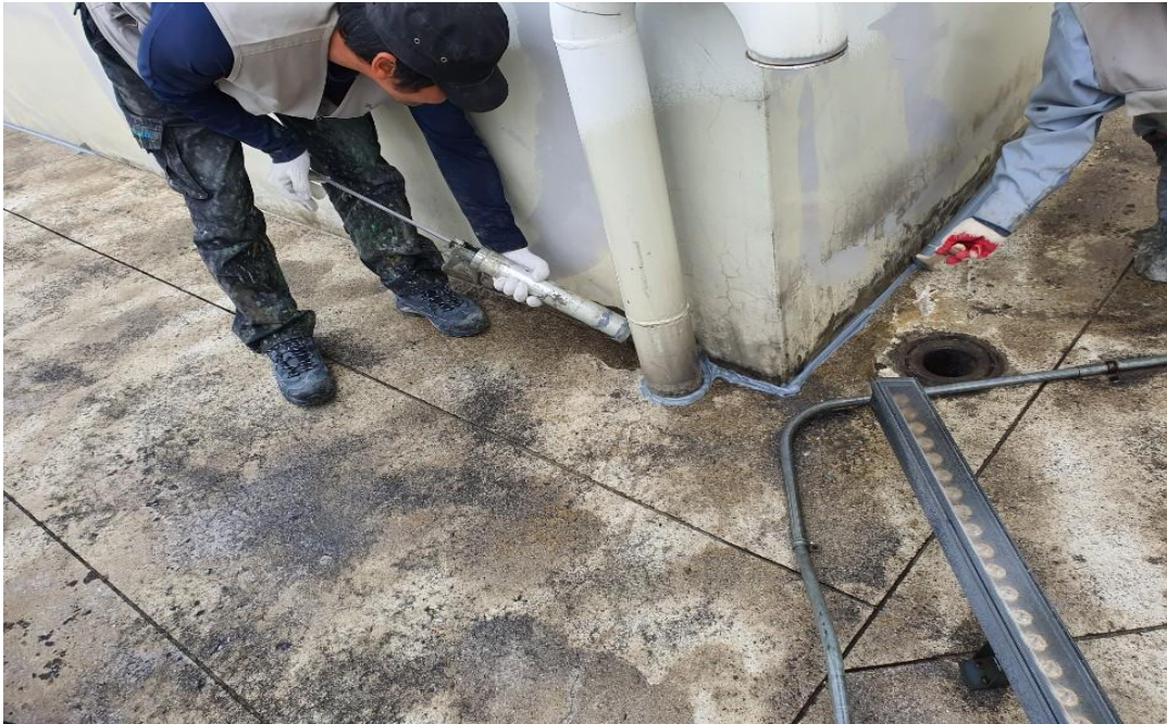
옥상 코너 및 균열부위 우레탄 실란트 충전
