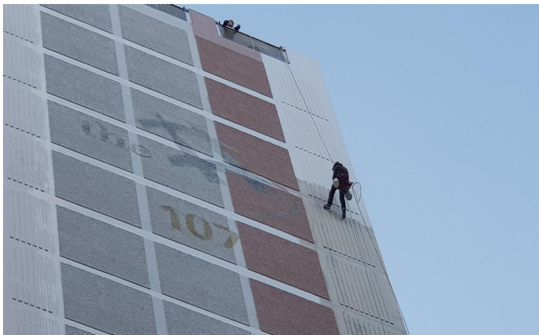
외벽 균열보수 및 도장
