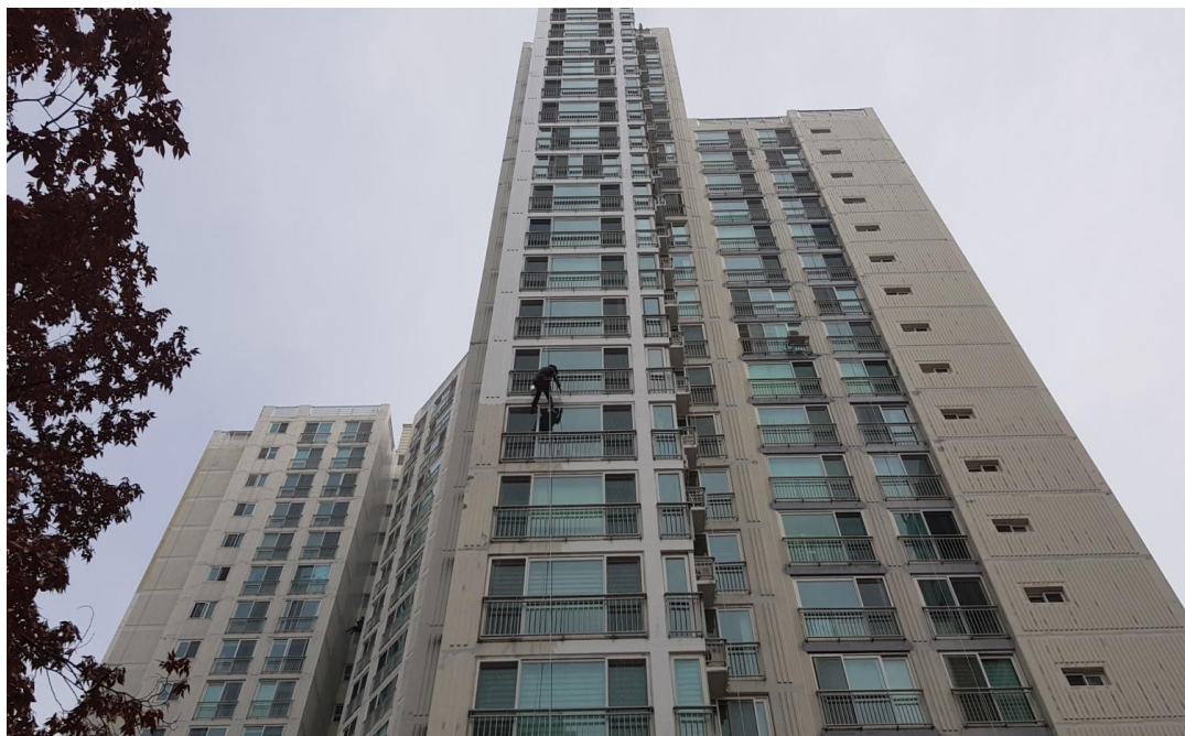
외벽 균열보수 및 도장
