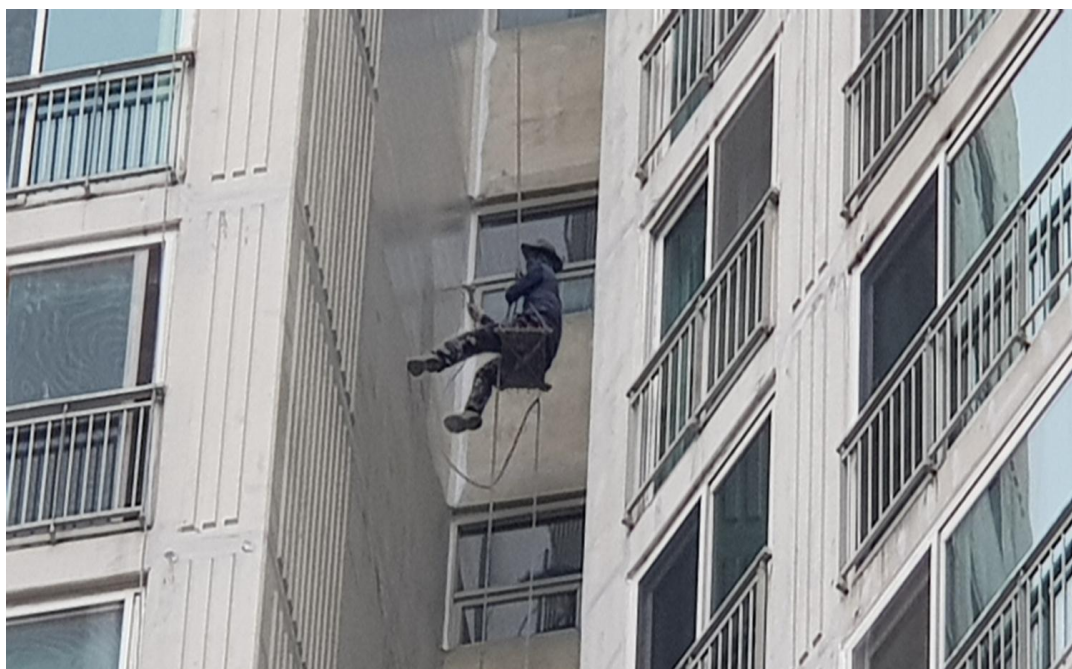
외벽 균열보수 및 도장
