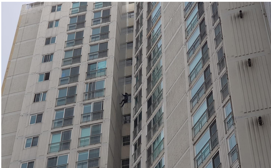
외벽 균열보수 및 도장
