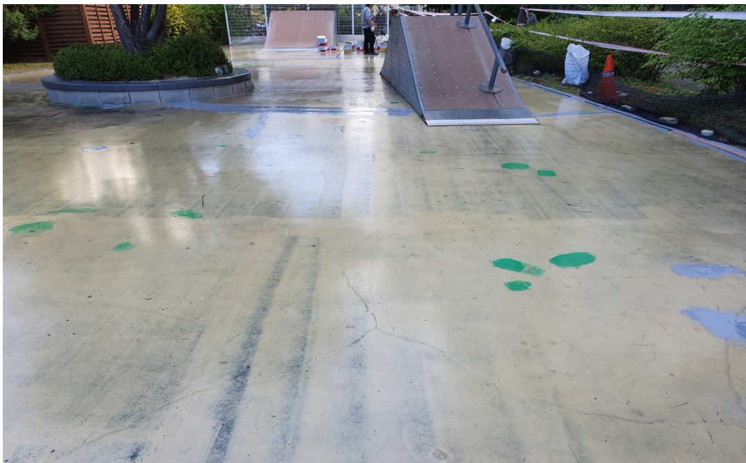
인라인장 우레탄하도 및 균열보수
