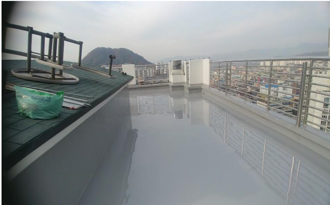
아파트 옥상 우레탄방수 완료 후
