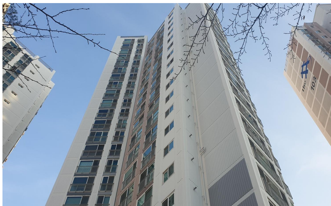
외벽 도장 완료전경
