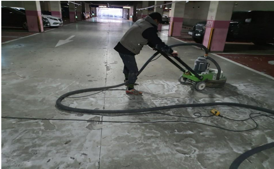
지하주차장 바닥 바탕정리
