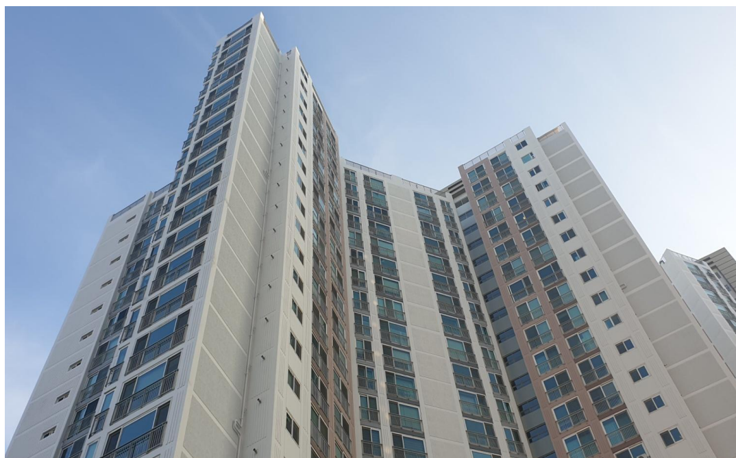
외벽 도장 완료전경
