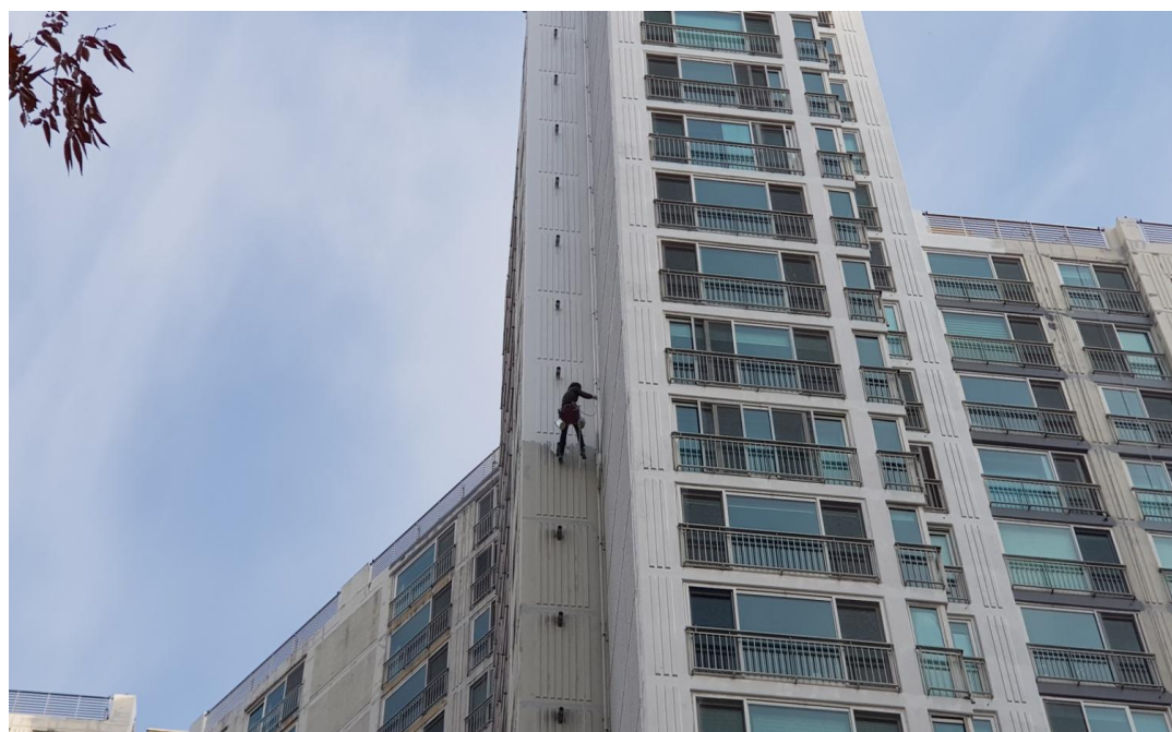
외벽 균열보수 및 도장
