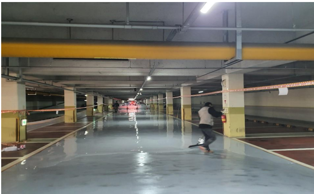
지하주차장 에폭시무용제 도포
