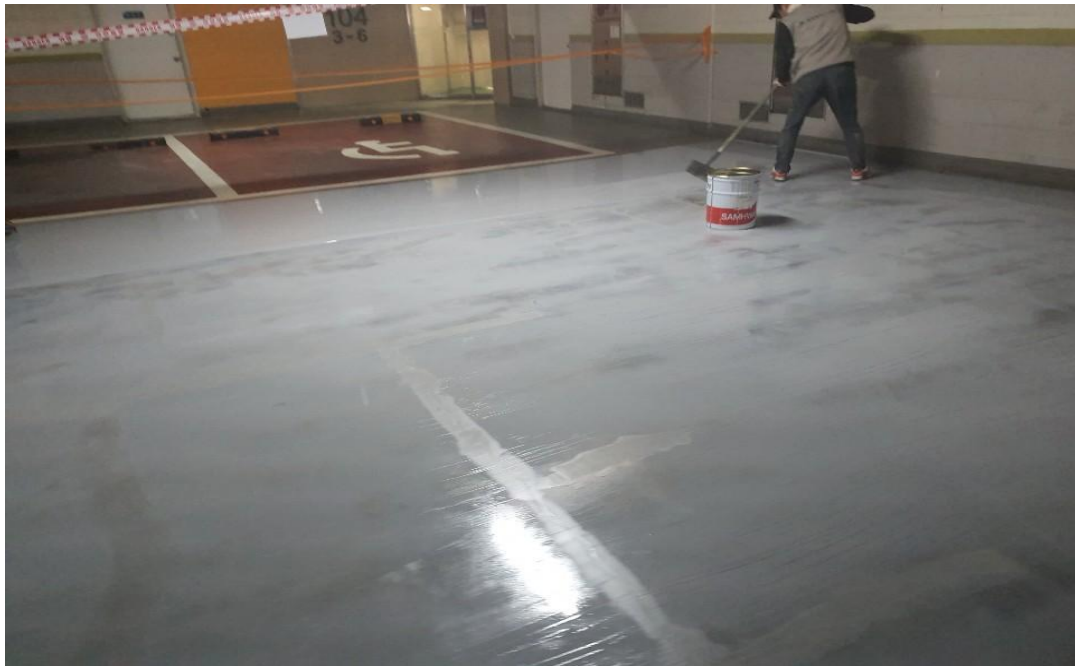
지하주차장 에폭시무용제 도포
