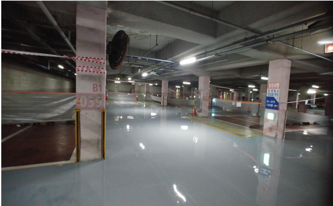
주차장 에폭시도장 완료 후
