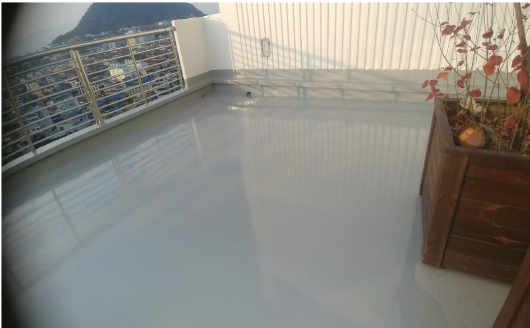
아파트 옥상 우레탄방수 완료 후
