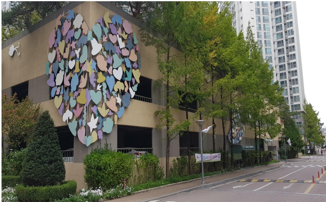
기존모습 지하주차장 외벽
