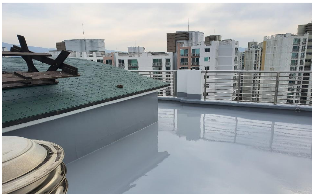
아파트 옥상 우레탄방수 완료 후
