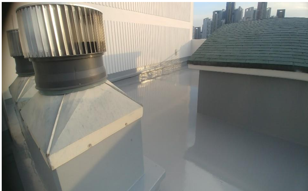
아파트 옥상 우레탄방수 완료 후
