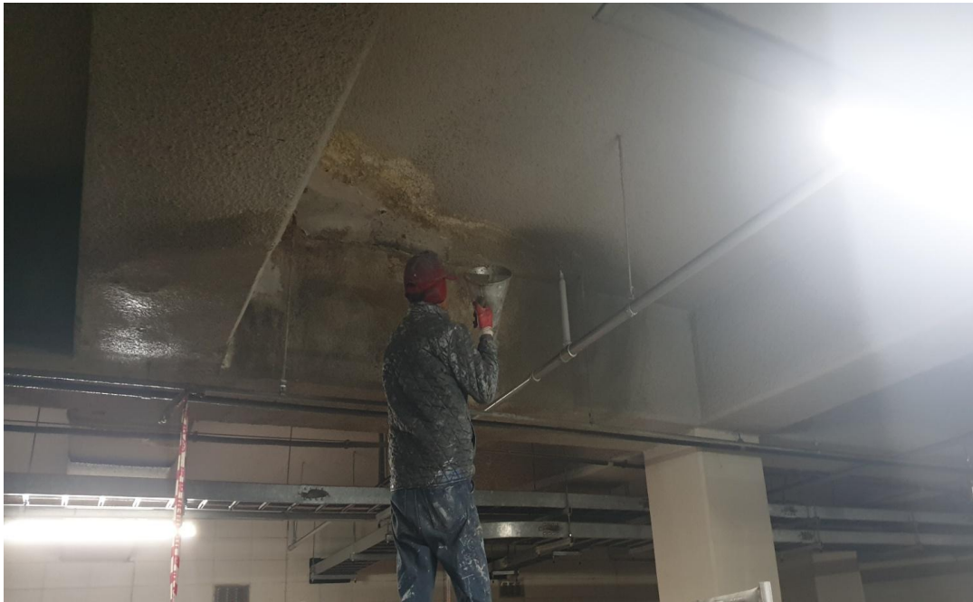
지하주차장 천장 뽐칠공사
