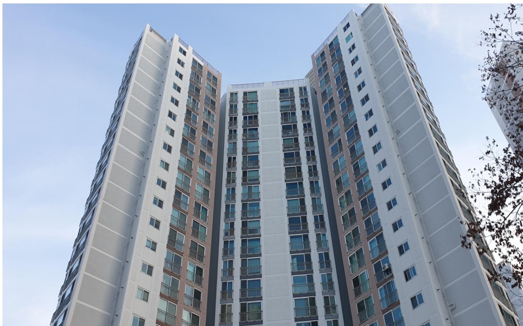
외벽 도장 완료전경
