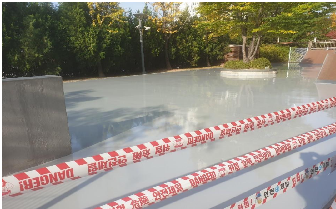
인라인장 완료 후
