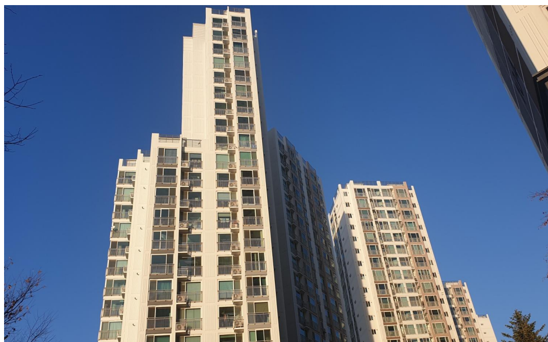
외벽 도장 완료전경
