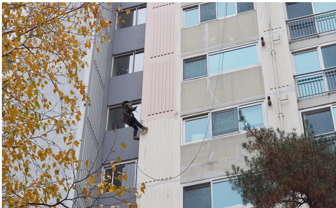
외벽 균열보수 및 도장
