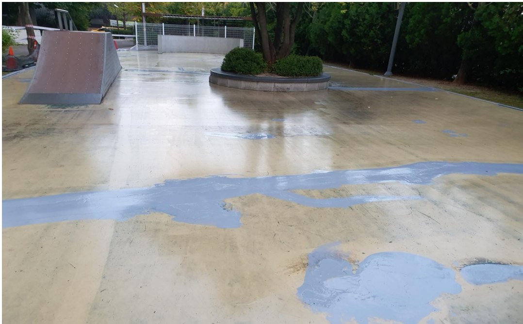
인라인장 우레탄하도 및 균열보수
