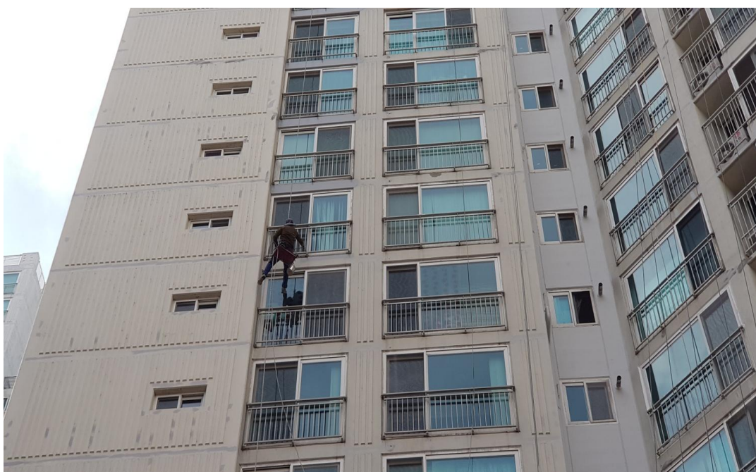
외벽 균열보수 및 도장
