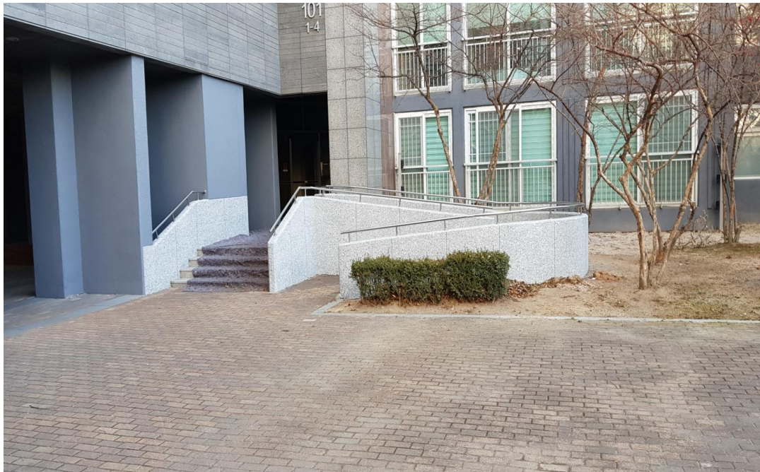
아파트출입구 노브레스 완료 후
