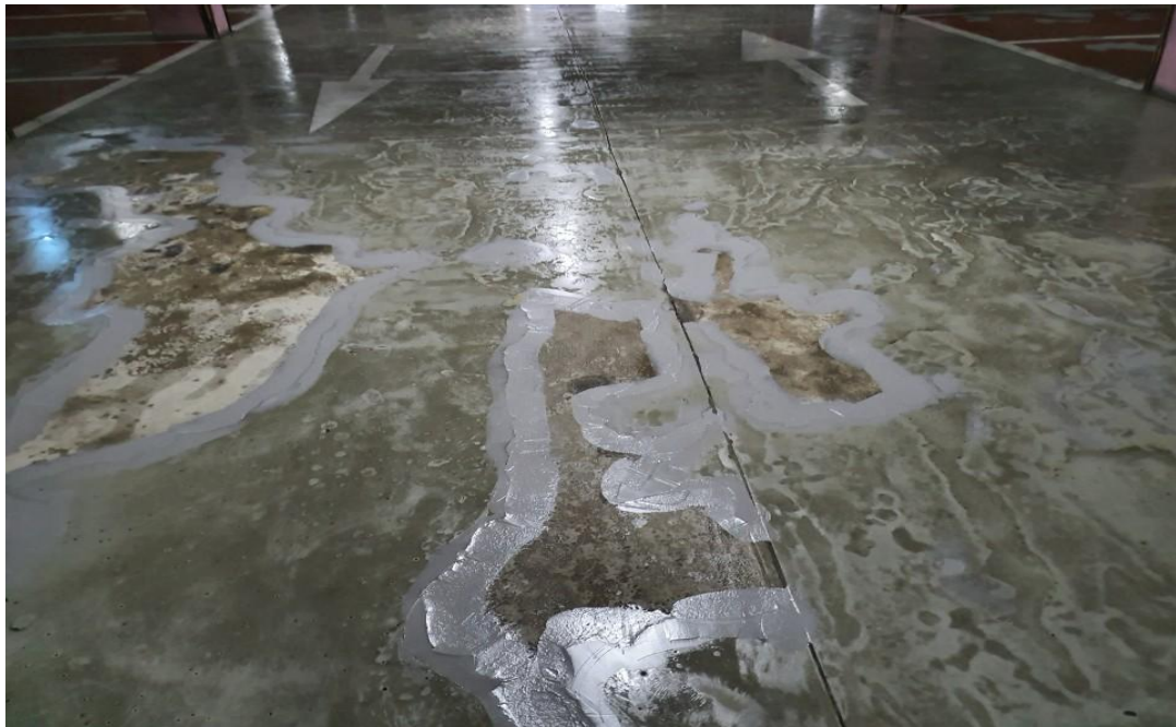
지하주차장 에폭시하도 및 균열보수
