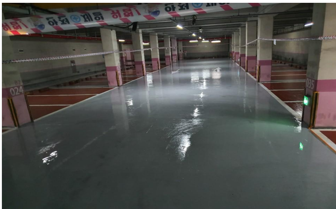
주차장 에폭시도장 완료 후
