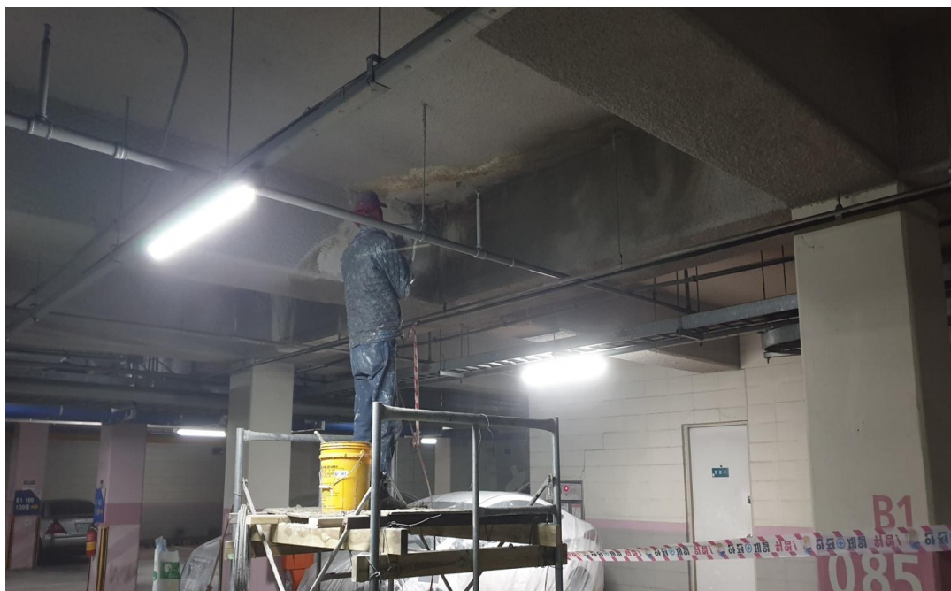
지하주차장 천장 뽐칠공사
