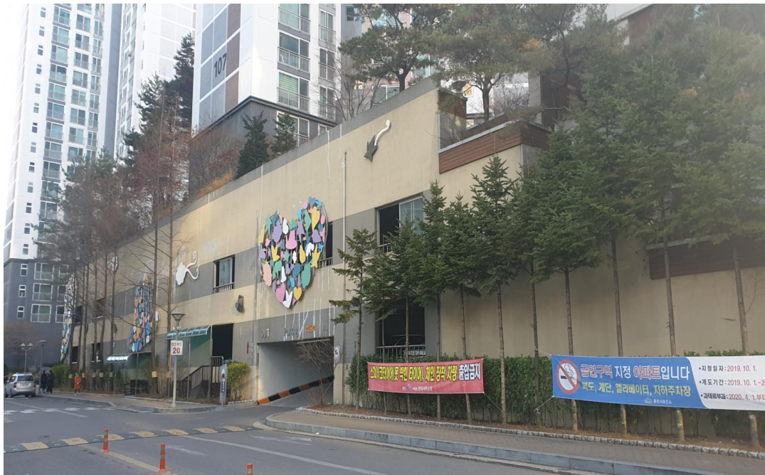
기타 부대시설 도장
