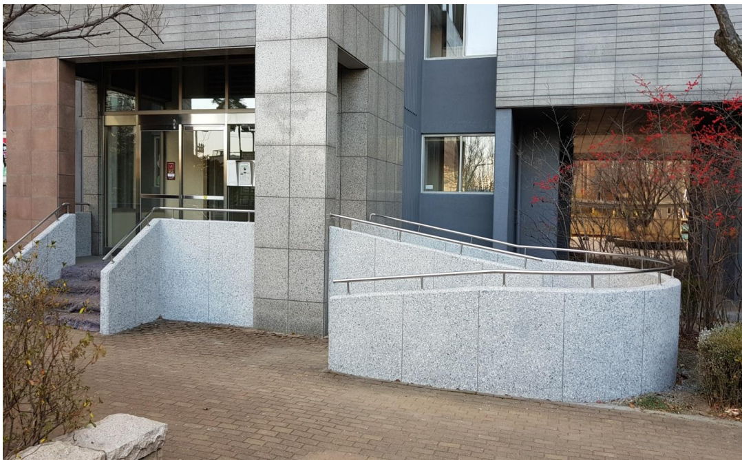
아파트출입구 노브레스 완료 후
