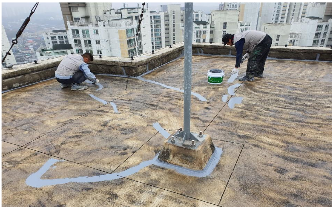
옥상 코너 및 균열부위 우레탄 실란트 충전
