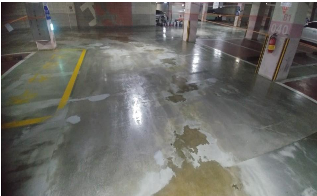
지하주차장 에폭시하도 및 균열보수
