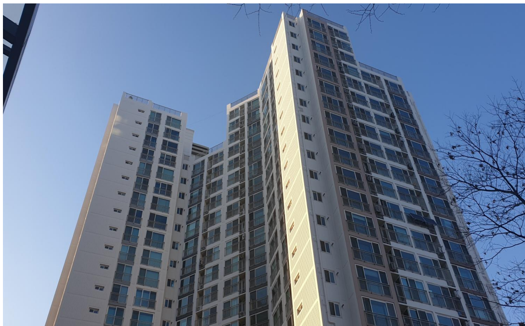
외벽 도장 완료전경
