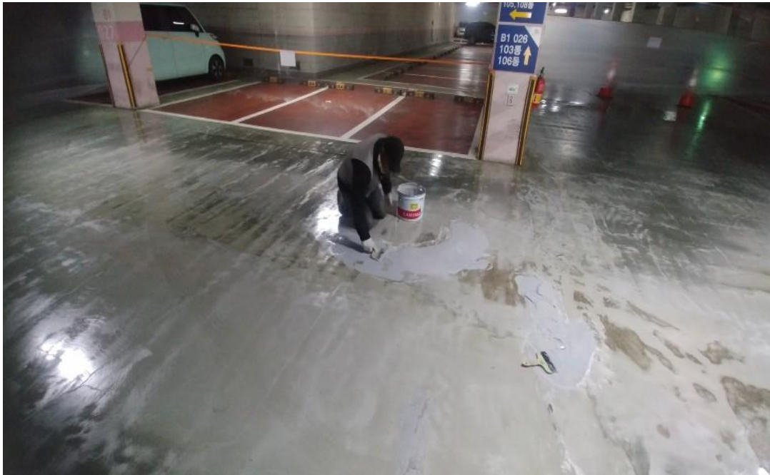
지하주차장 에폭시하도 및 균열보수
