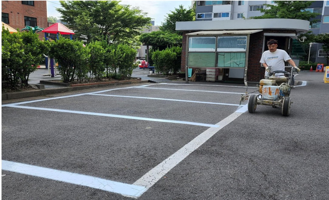
공사 중 : 지상차선 도장
