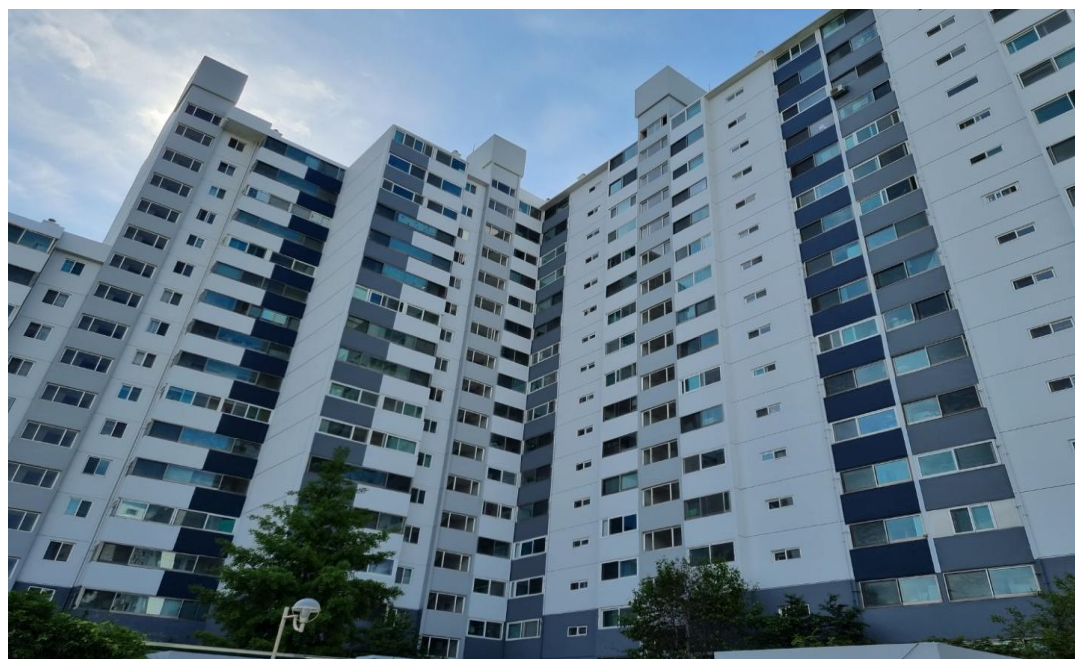
공사 후 : 외벽 전경
