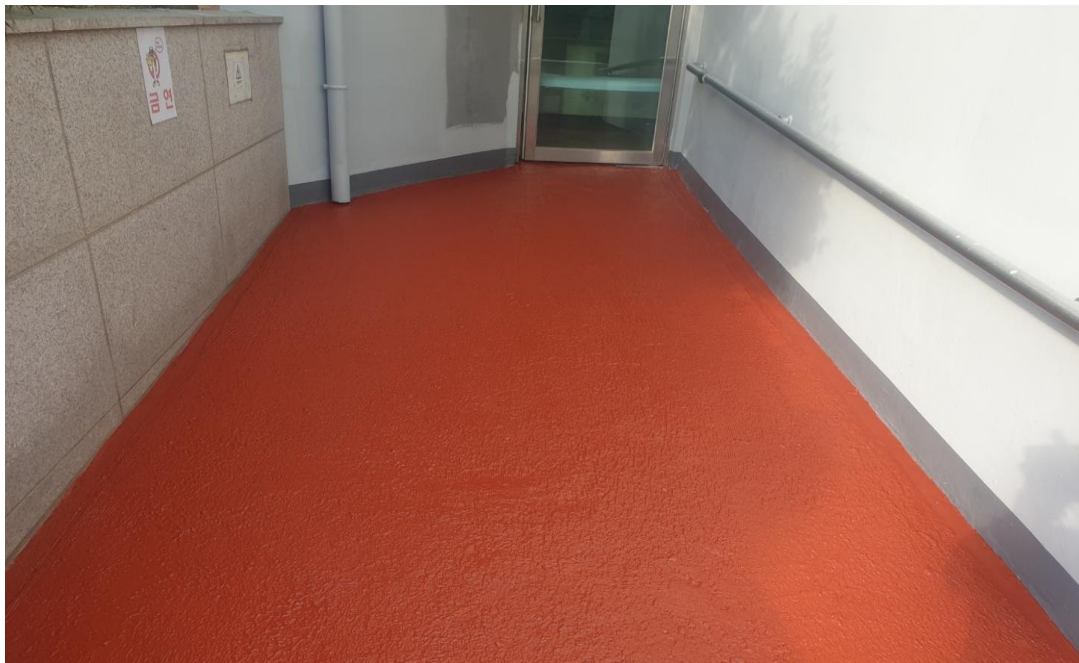
공사 후 : 부대시설 도장
