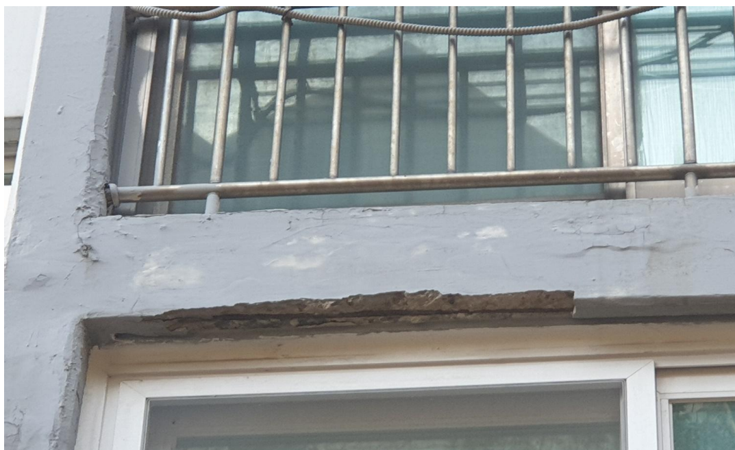
공사 전 : 외벽 상태
