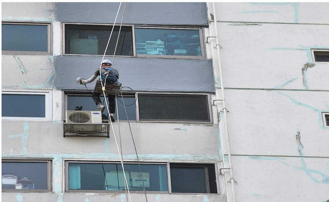
공사 중 : 외벽 도장작업
