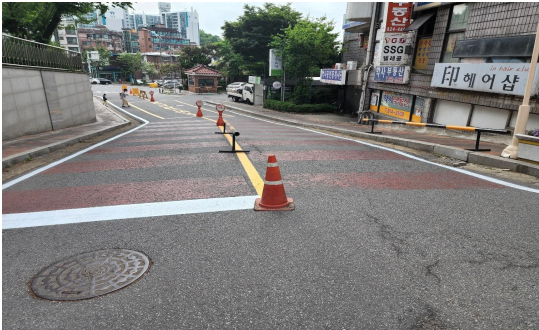
공사 후 : 지상차선 도장
