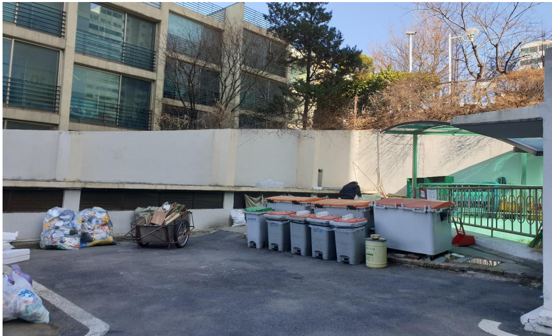
공사 전 : 부대시설 담장
