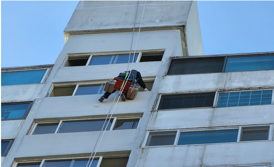
공사 중 : 외벽 계단 공용창 코킹공사
