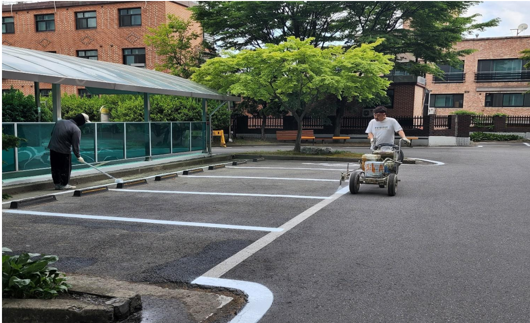
공사 중 : 지상차선 도장
