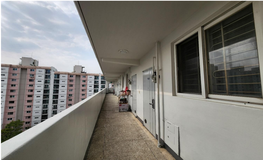
공사 후 : 5동 내부 복도
