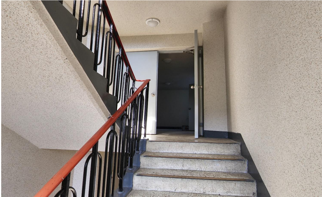
공사 중 : 5동 내부 계단실 무늬코트 도장
