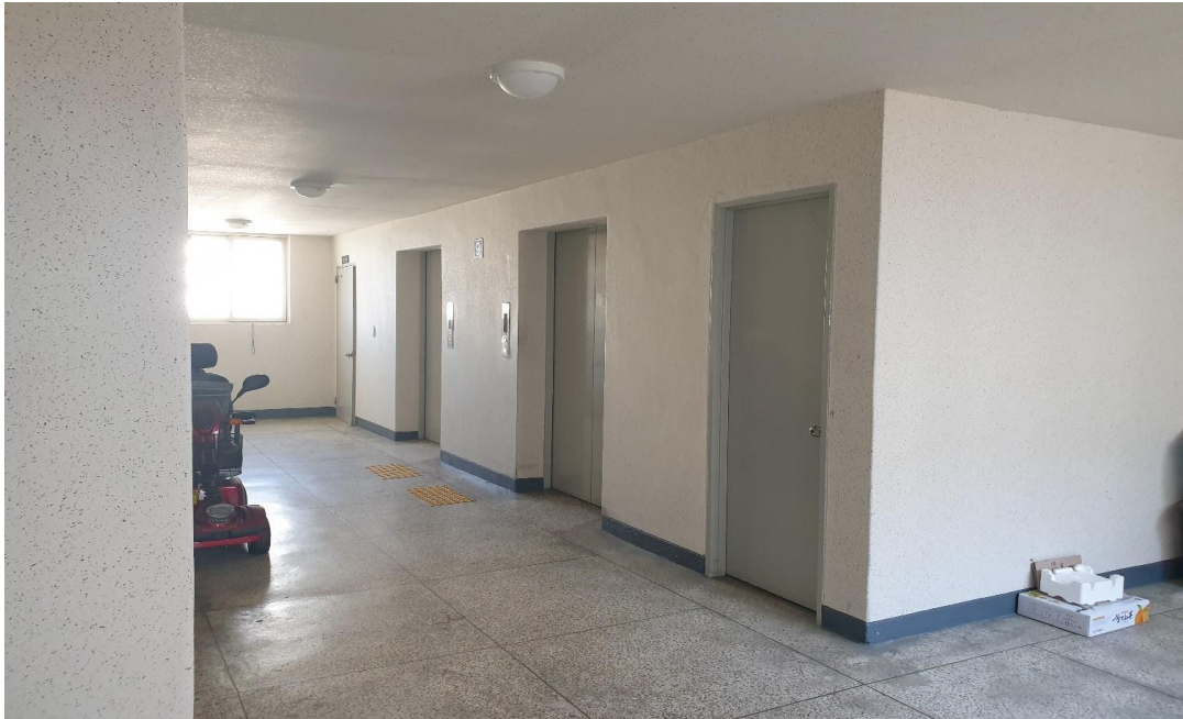
공사 전 : 5동 내부
