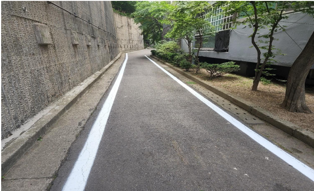
공사 후 : 지상차선 도장
