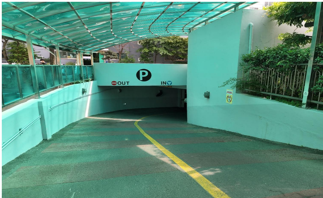
공사 후 : 부대시설 도장
