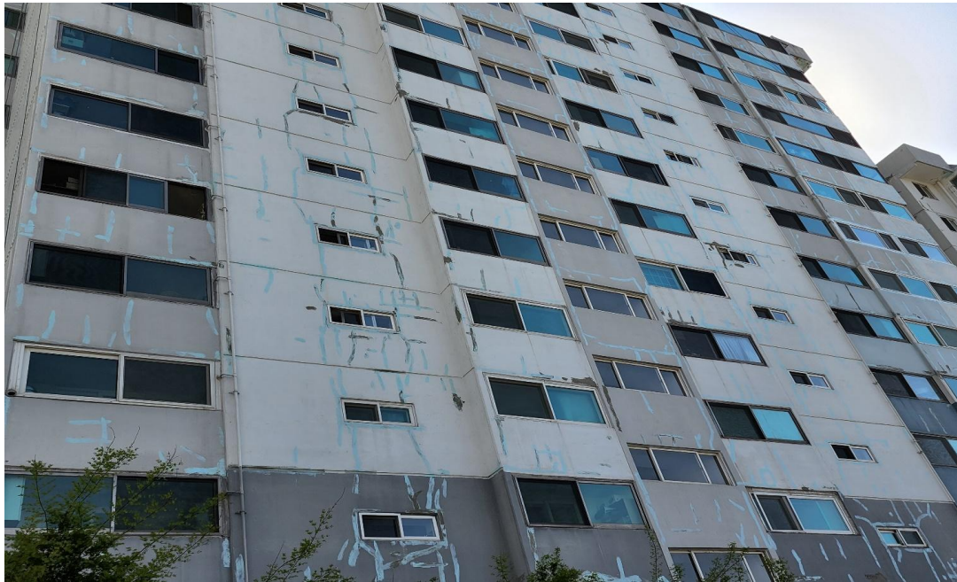
공사 중 : 외벽 균열보수
