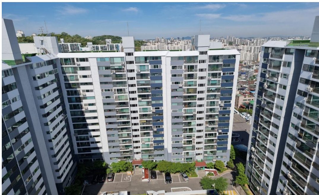
공사 후 : 외벽 전경
