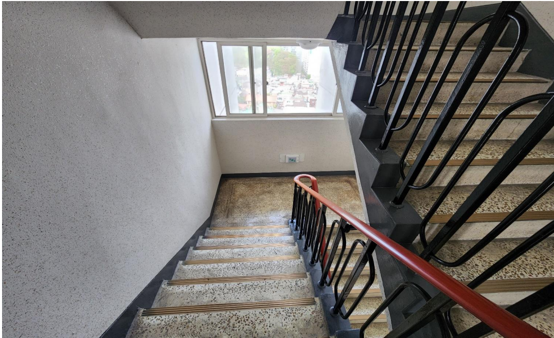
공사 후 : 5동 내부 계단실
