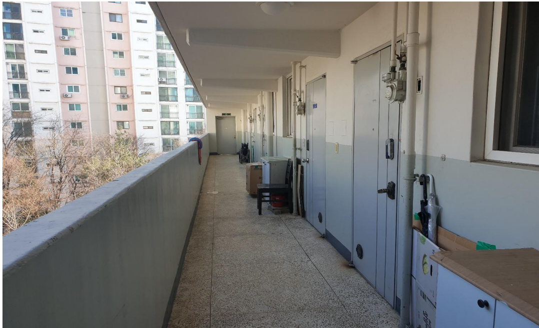
공사 전 : 5동 내부
