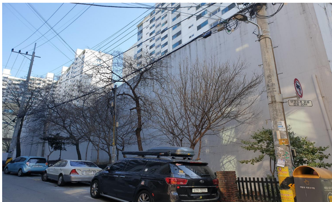
공사 전 : 부대시설 담장
