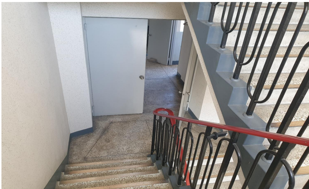
공사 전 : 5동 내부
