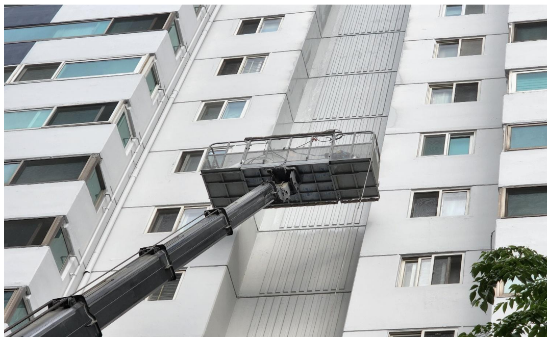
공사 중 : 외벽 도장작업
