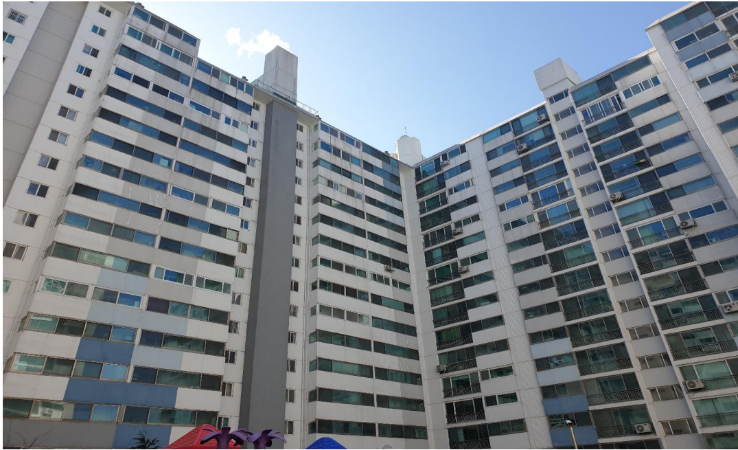
공사 전 : 외벽 전경
