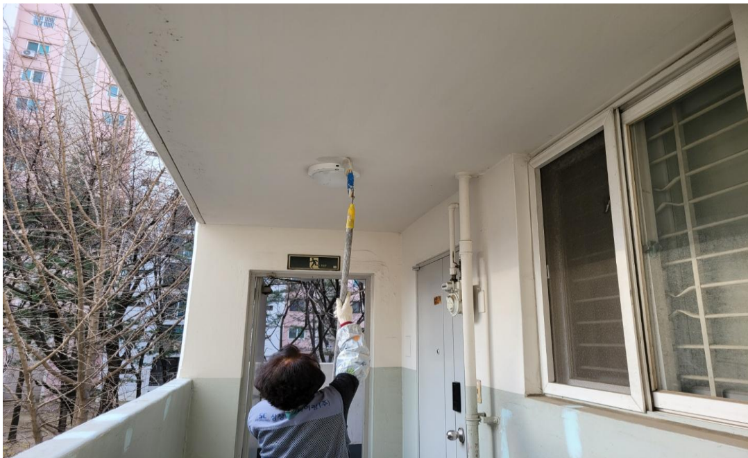
공사 중 : 5동 내부 수성페인트 도장
