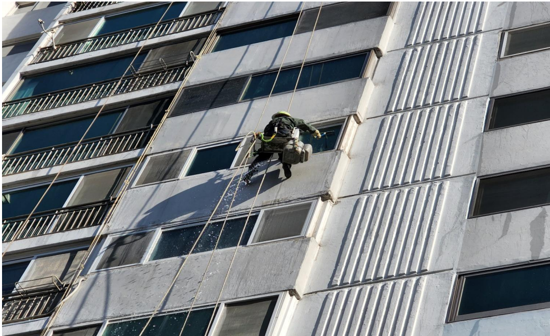
공사 중 : 외벽 고압세척
