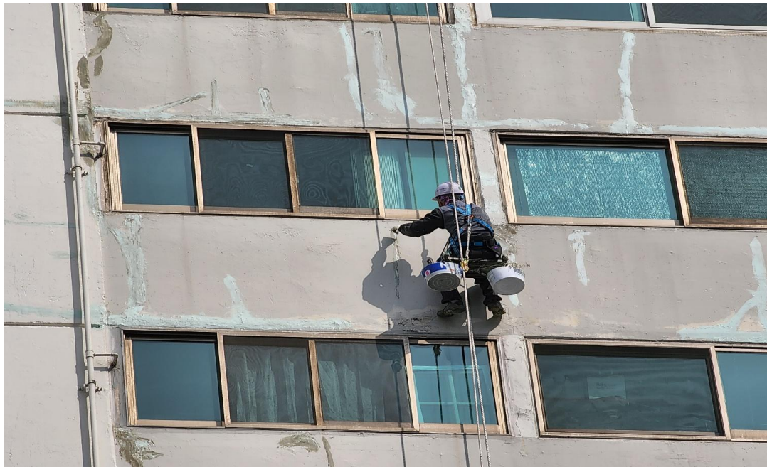
공사 중 : 외벽 균열보수
