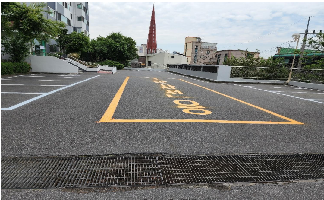
공사 후 : 지상차선 도장
