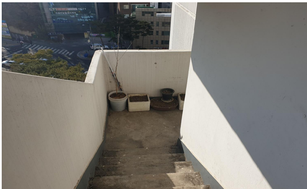
공사 전 : 5동 내부
