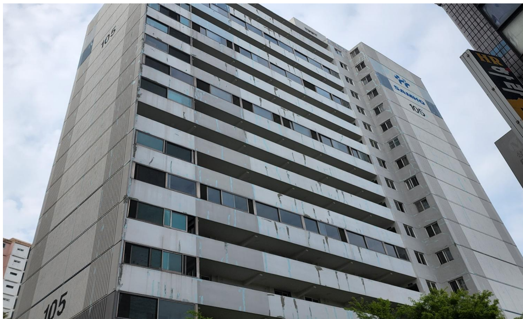
공사 중 : 외벽 바인더 완료 후
