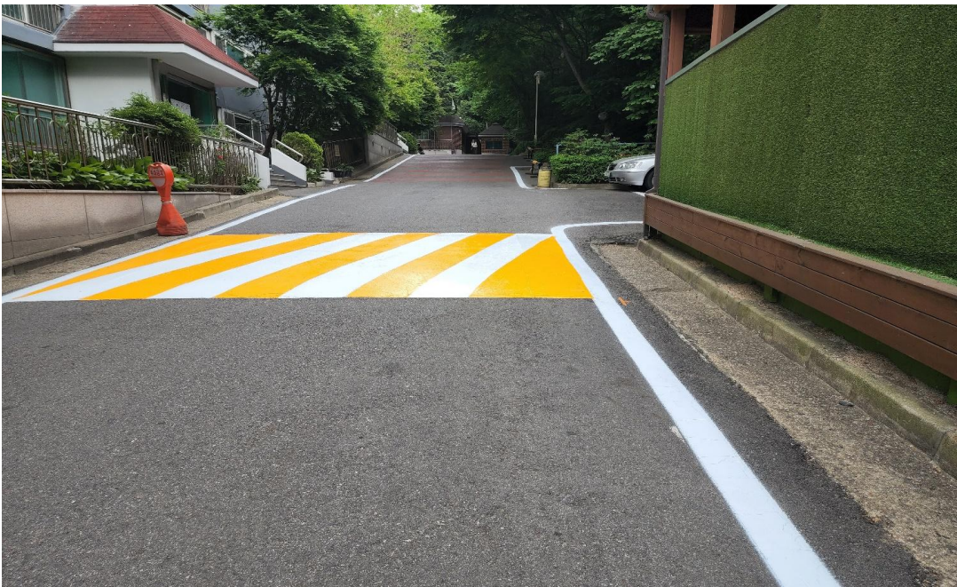
공사 후 : 지상차선 도장
