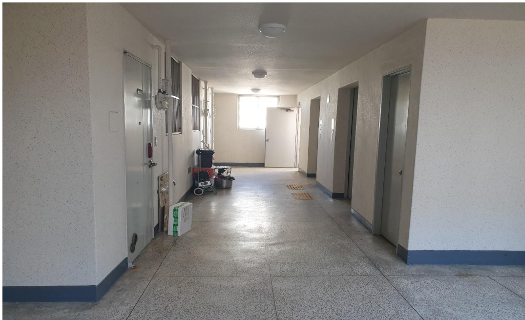
공사 전 : 5동 내부
