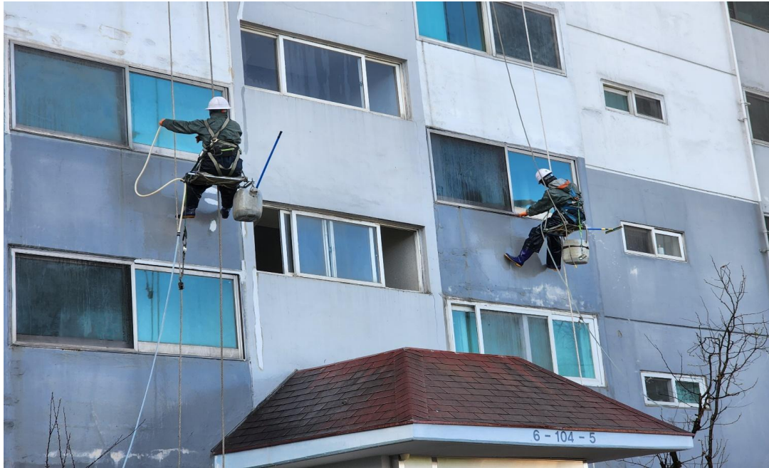
공사 중 : 외벽 고압세척
