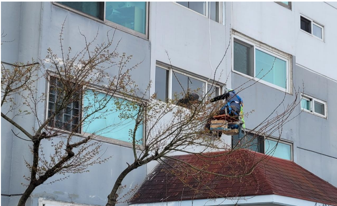
공사 중 : 외벽 계단 공용창 코킹공사
