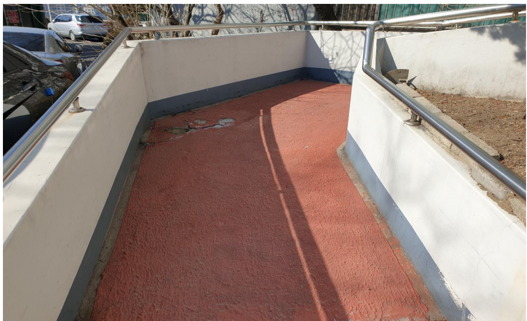
공사 전 : 부대시설 장애인 램프바닥
