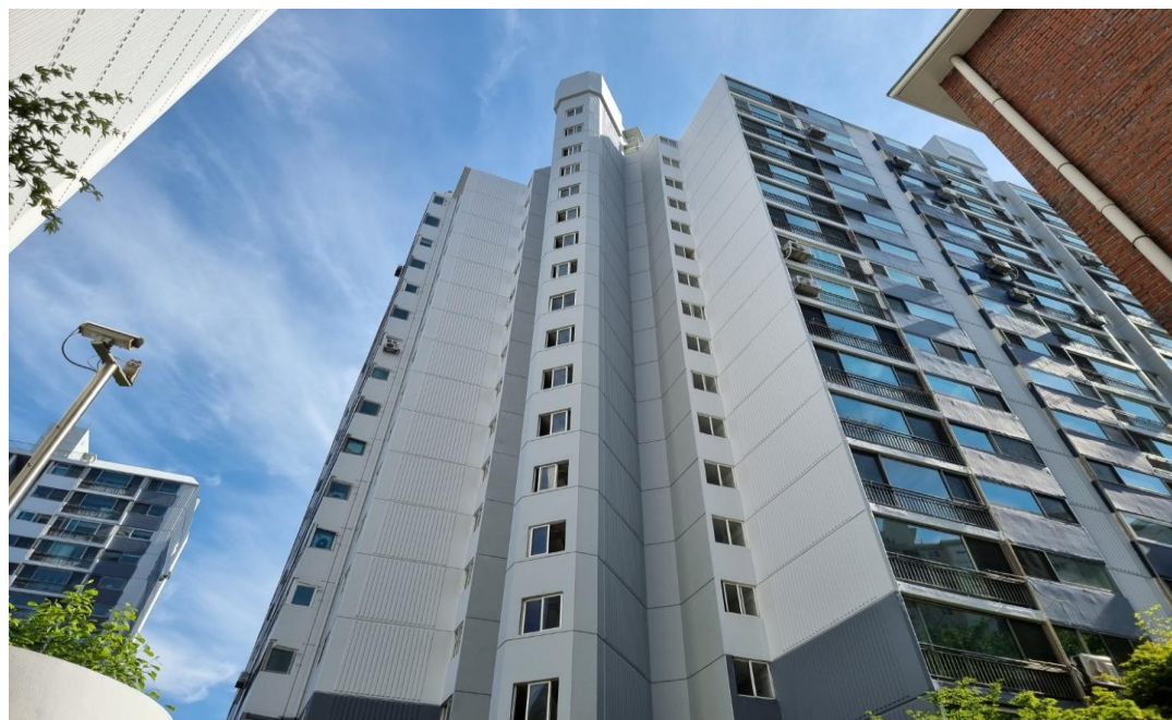
공사 후 : 외벽 전경
