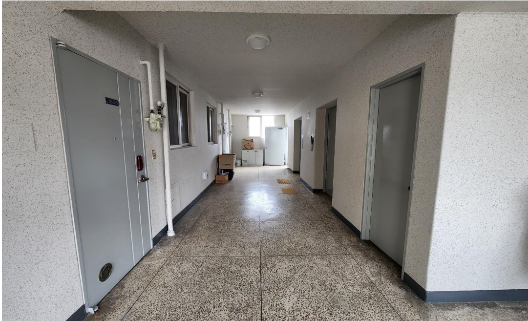
공사 후 : 5동 내부 E/V홀
