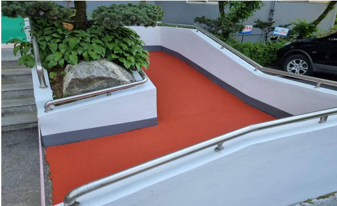
공사 후 : 부대시설 도장
