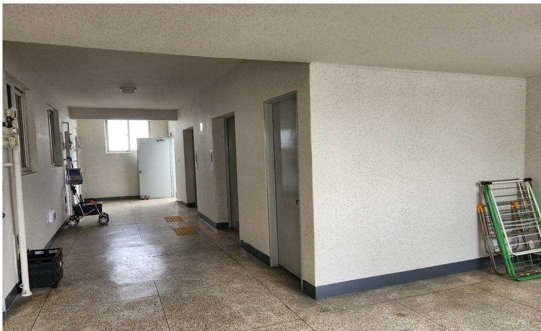
공사 중 : 5동 내부 E/V홀 무늬코트 도장
