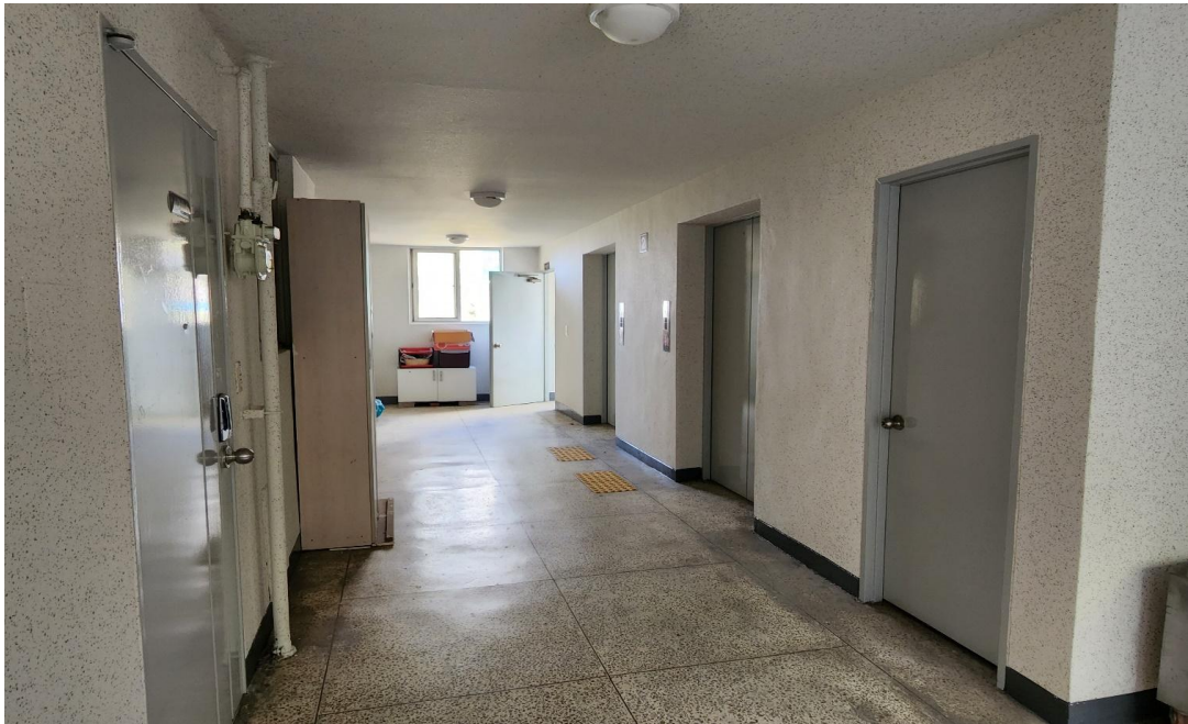
공사 중 : 5동 내부 E/V홀 무늬코트 도장
