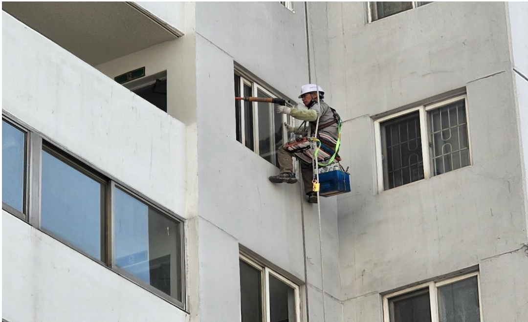
공사 중 : 외벽 계단 공용창 코킹공사
