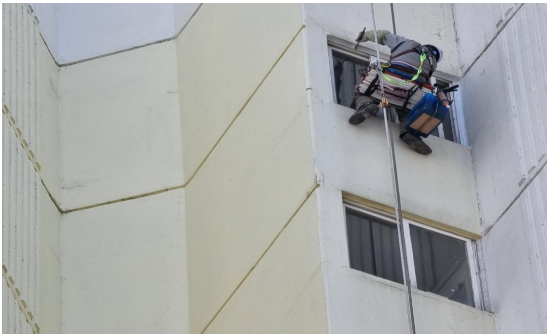
공사 중 : 외벽 계단 공용창 코킹공사
