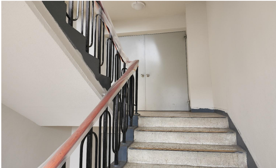
공사 중 : 5동 내부 수성페인트 도장
