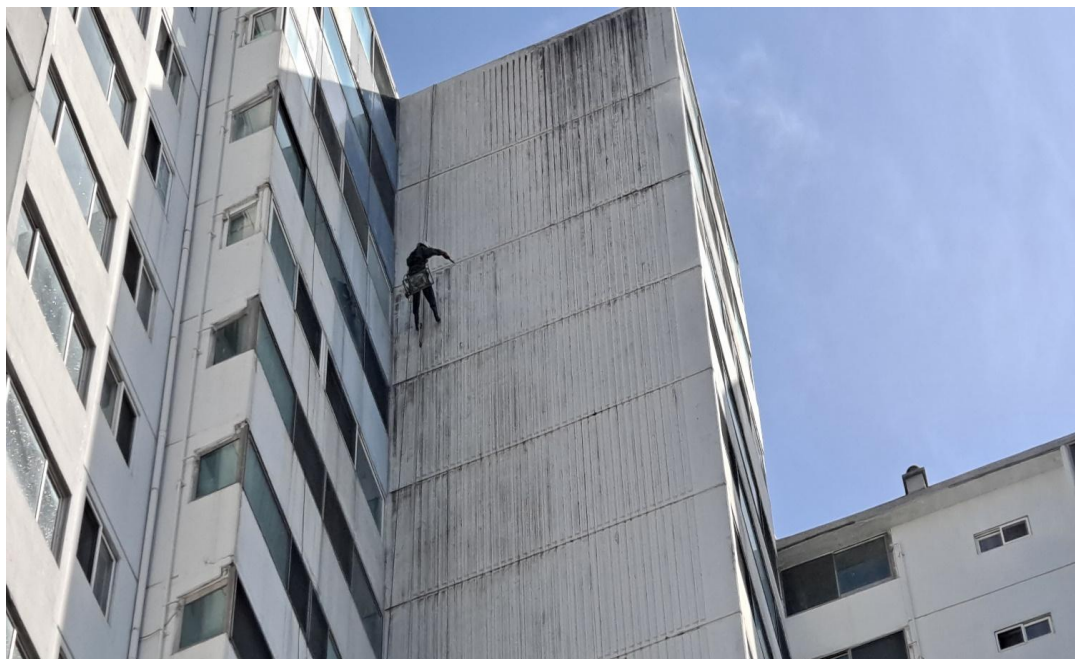
공사 중 : 외벽 고압세척
