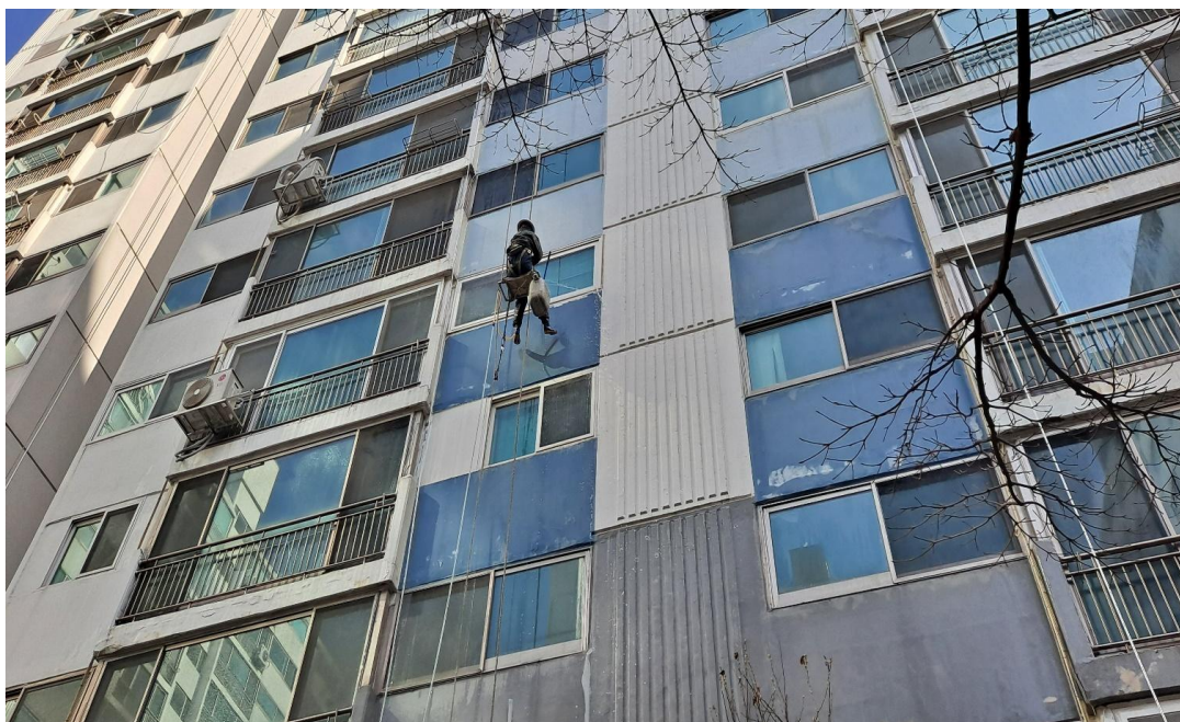
공사 중 : 외벽 고압세척
