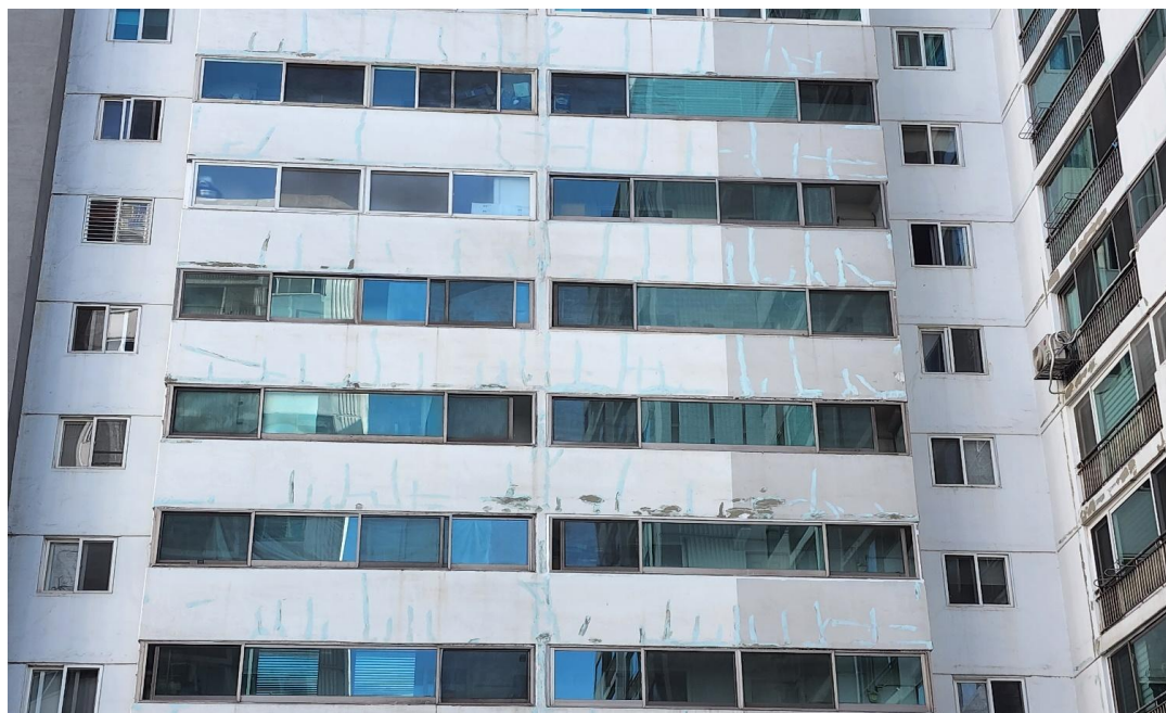
공사 중 : 외벽 균열보수
