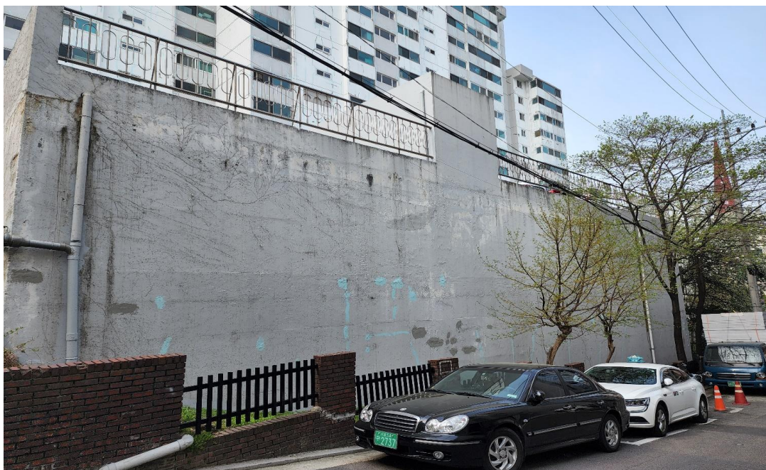
공사 중 : 부대시설 도장
