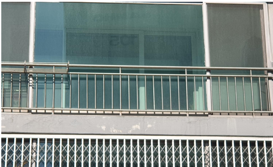
공사 전 : 외벽 상태
