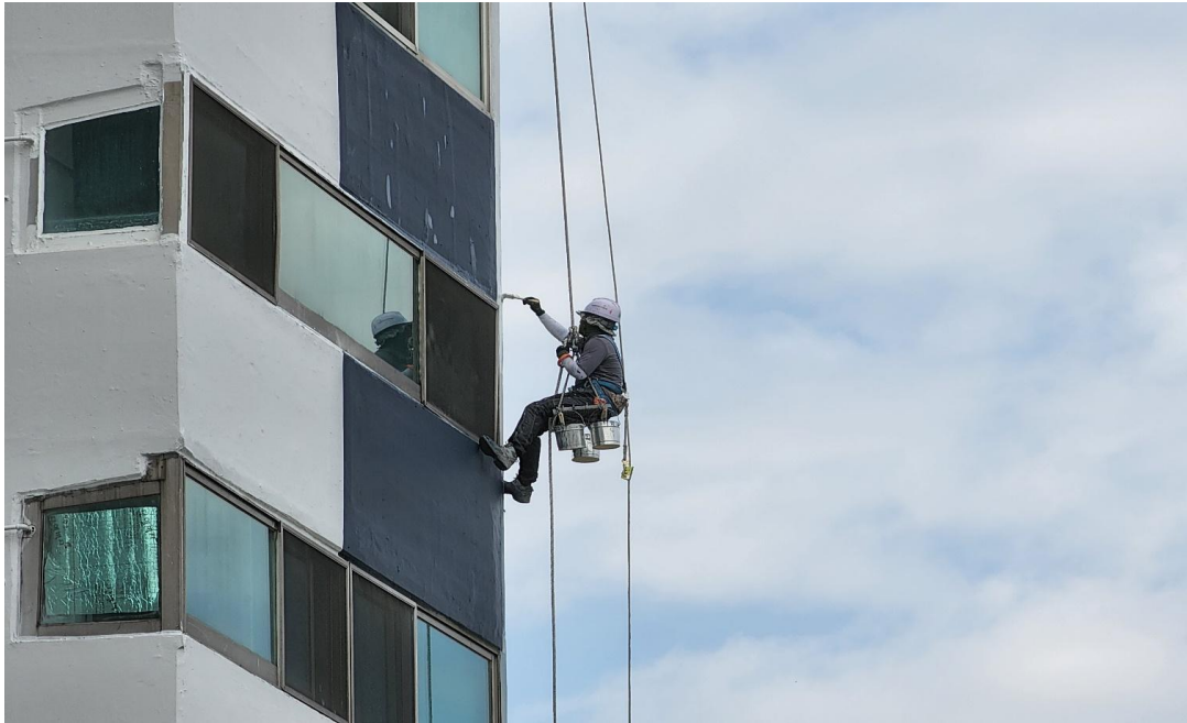
공사 중 : 외벽 도장작업
