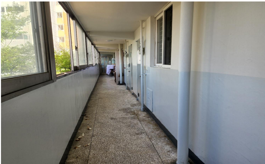
공사 후 : 5동 내부 복도
