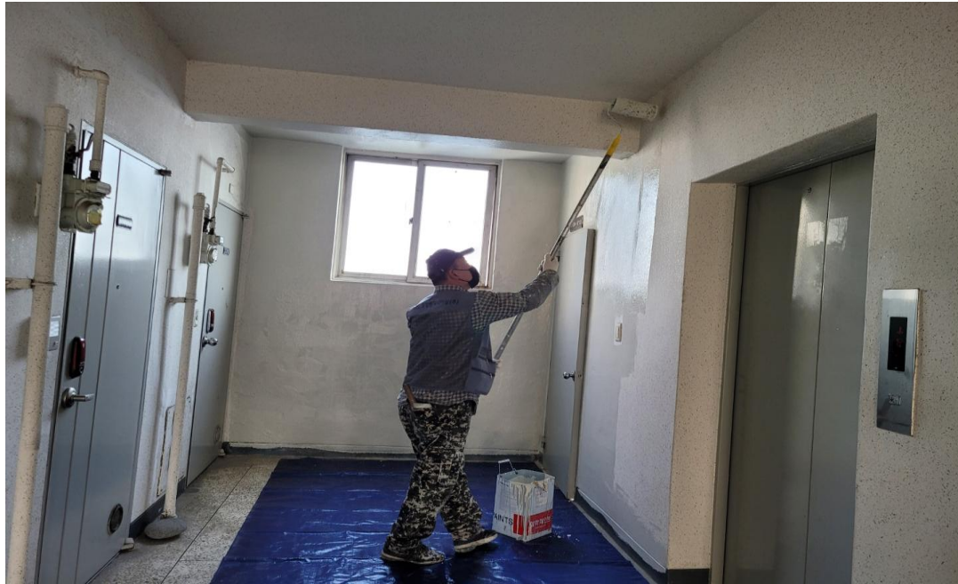
공사 중 : 5동 내부 수성페인트 도장
