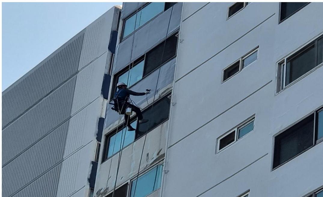
공사 중 : 외벽 도장작업
