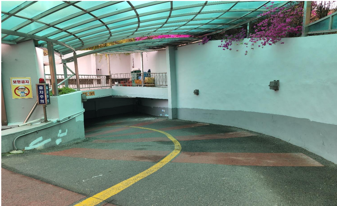
공사 중 : 부대시설 도장
