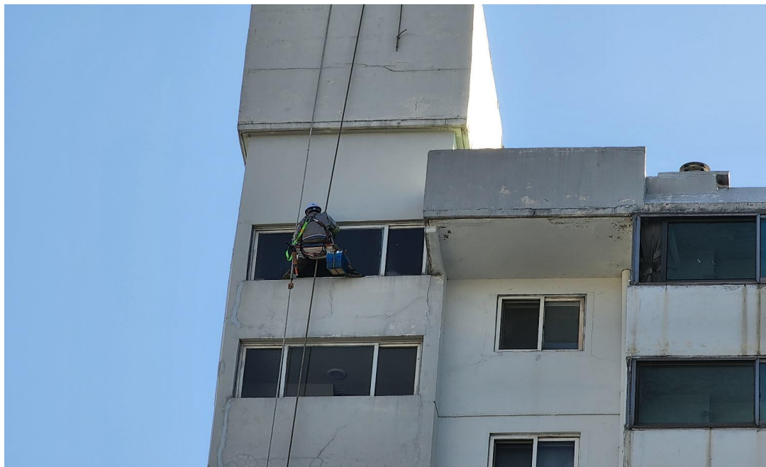
공사 중 : 외벽 계단 공용창 코킹공사
