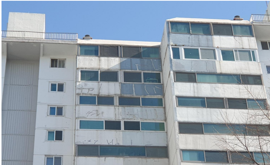
공사 전 : 외벽 상태
