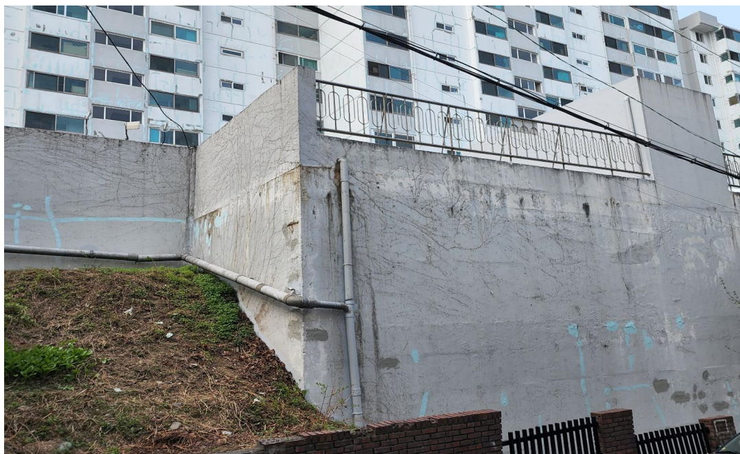
공사 중 : 부대시설 도장
