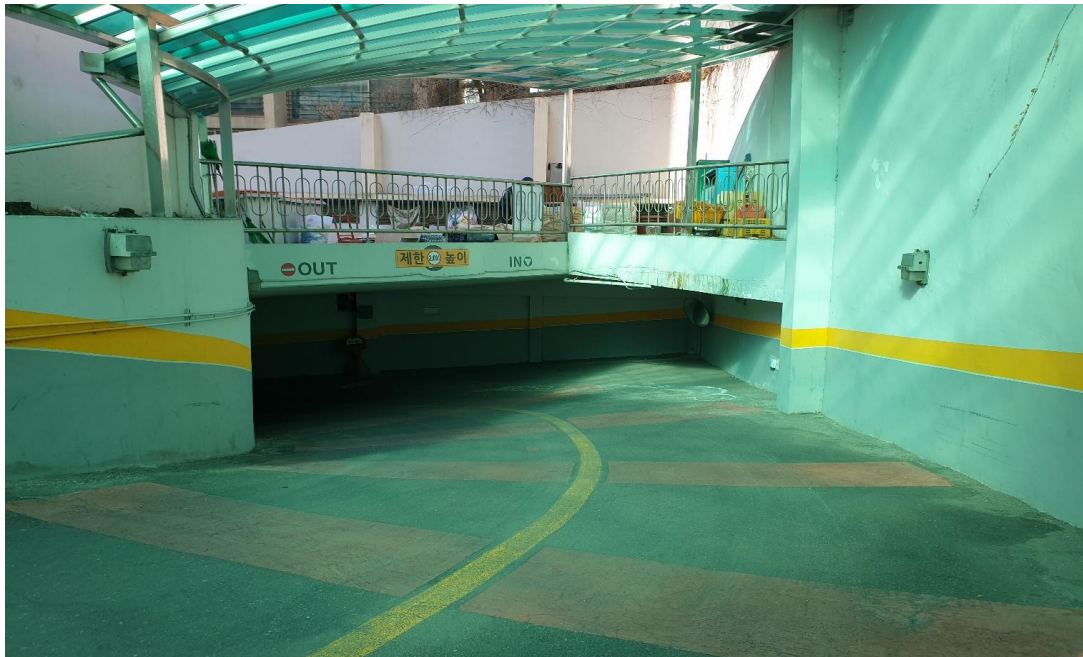
공사 전 : 부대시설 지하주차장 진입램프
