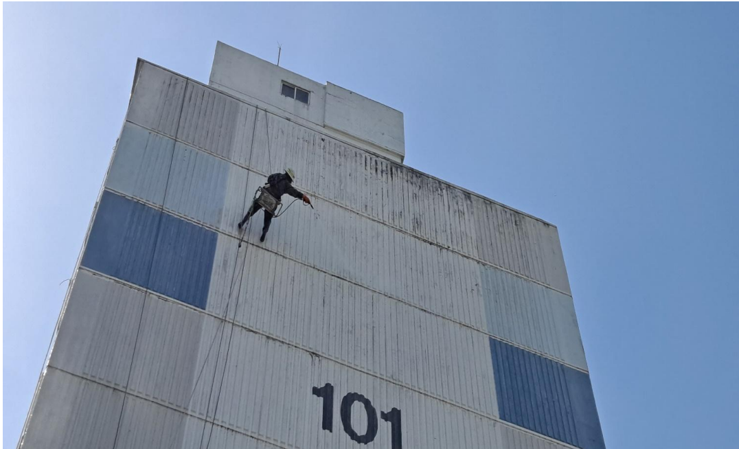
공사 중 : 외벽 고압세척
