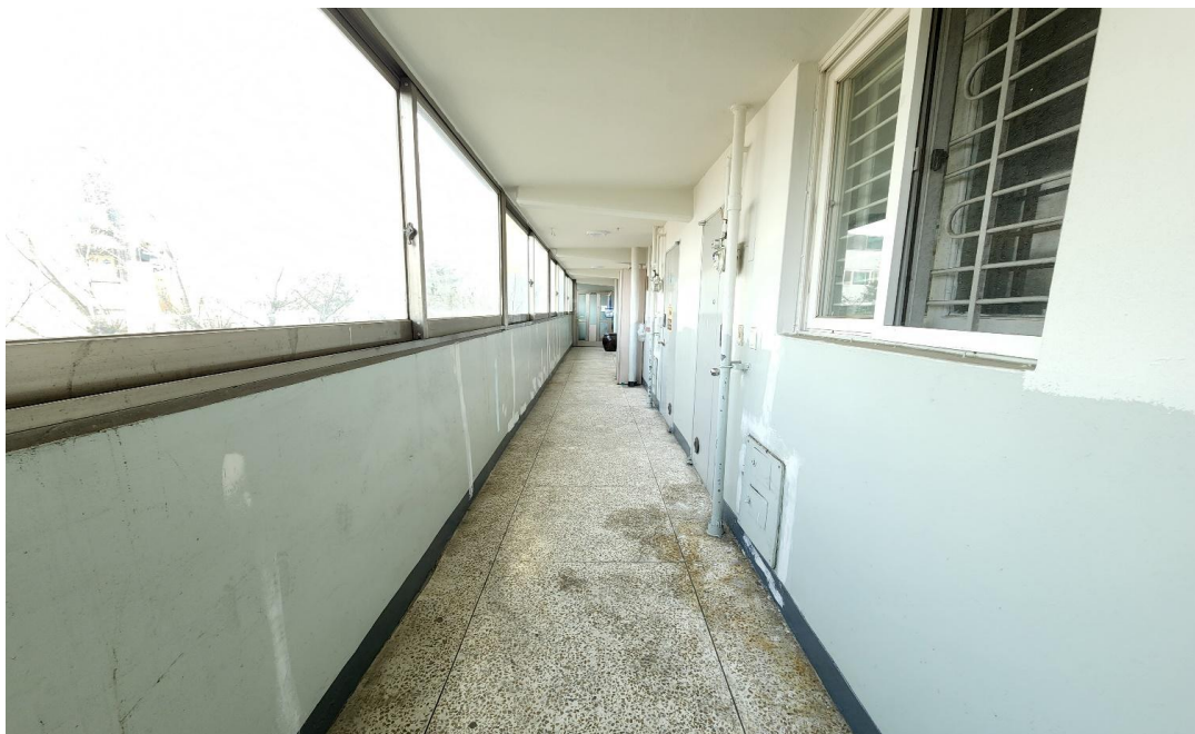
공사 중 : 5동 내부 균열보수
