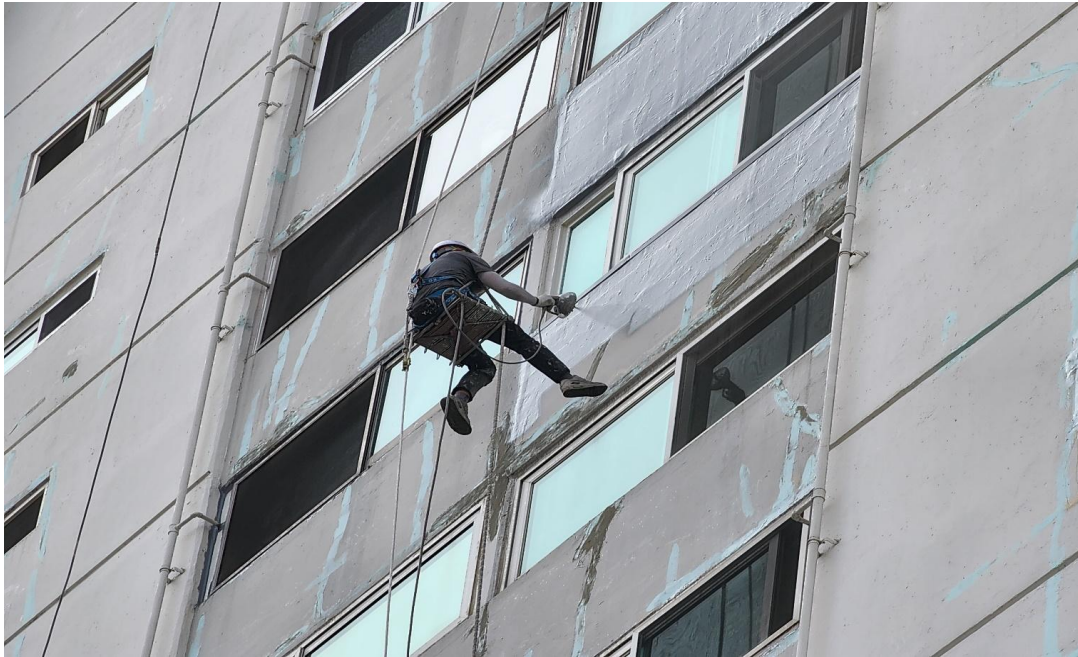
공사 중 : 외벽 도장작업
