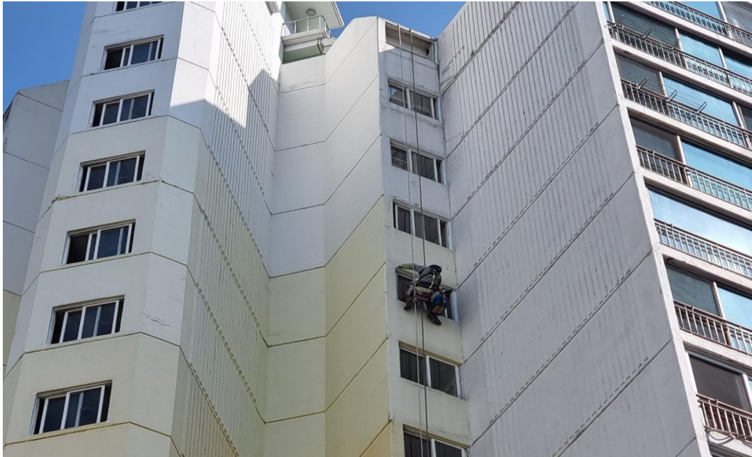
공사 중 : 외벽 계단 공용창 코킹공사
