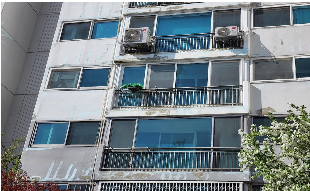
공사 중 : 외벽 균열보수
