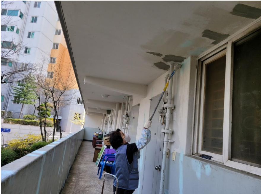
공사 중 : 5동 내부 수성페인트 도장
