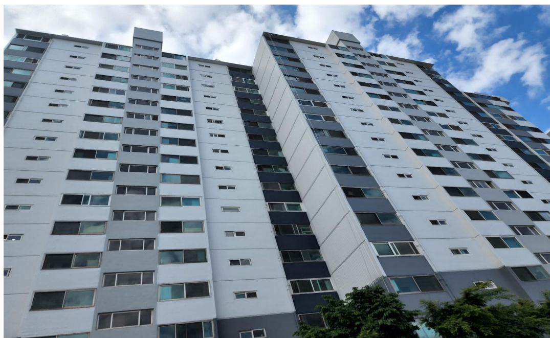
공사 후 : 외벽 전경
