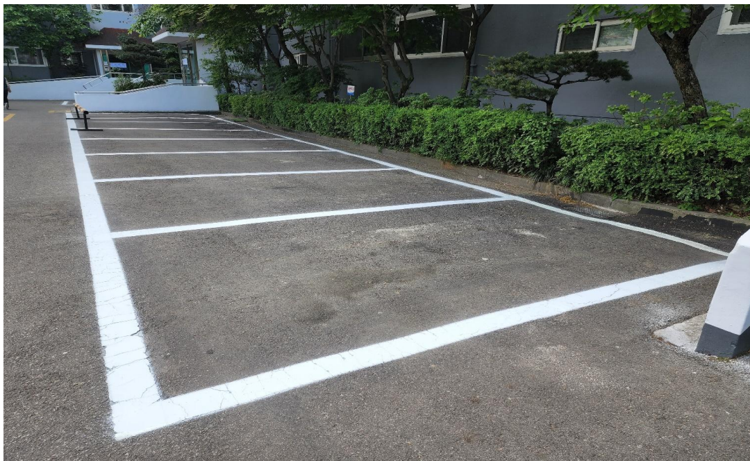
공사 후 : 지상차선 도장
