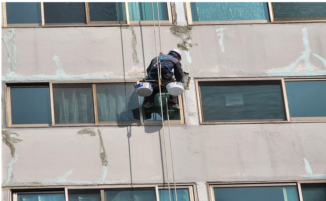
공사 중 : 외벽 균열보수
