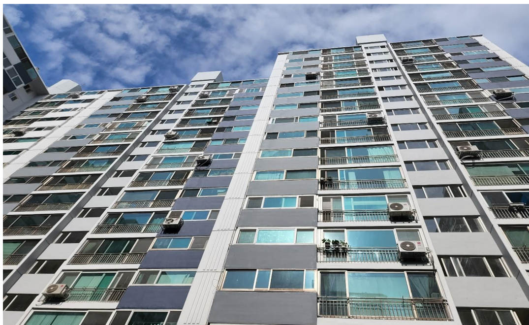
공사 후 : 외벽 전경
