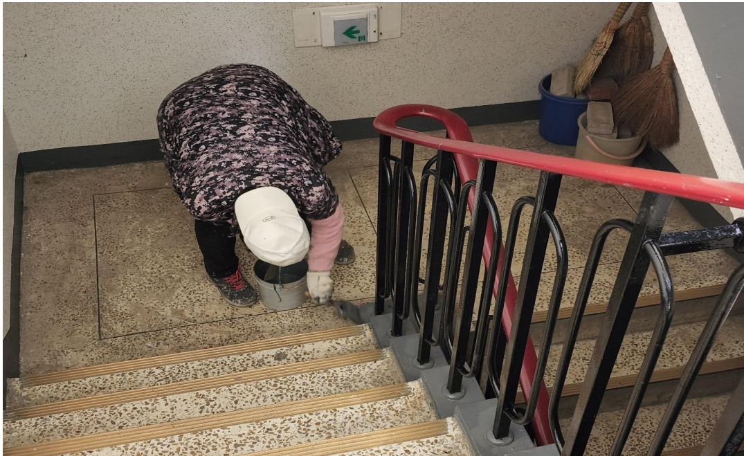
공사 중 : 5동 내부 걸레받이 도장
