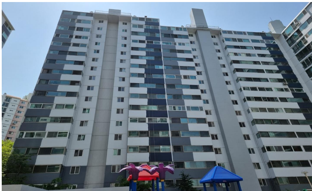
공사 후 : 외벽 전경
