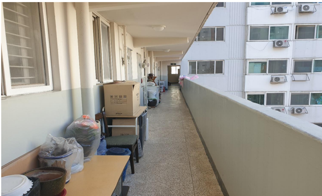
공사 전 : 5동 내부
