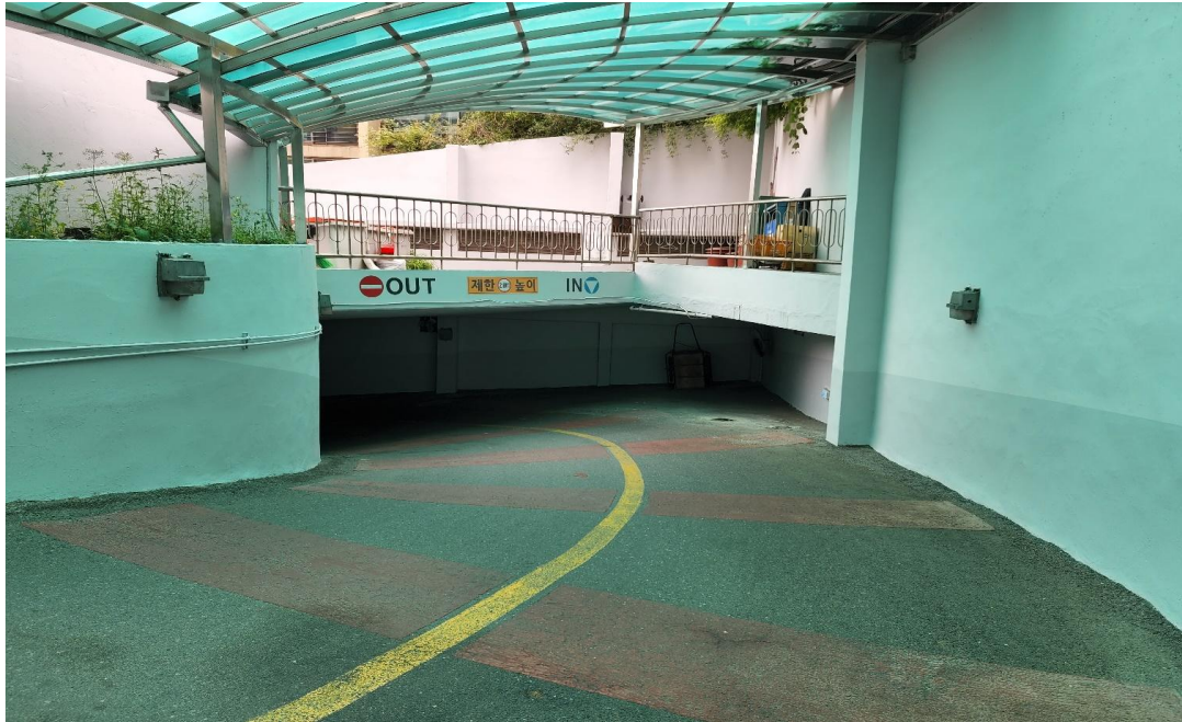
공사 후 : 부대시설 도장
