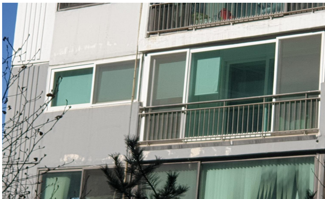
공사 전 : 외벽 상태
