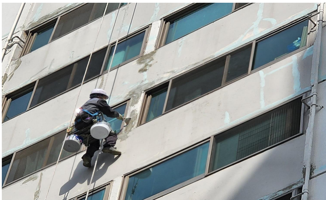
공사 중 : 외벽 균열보수
