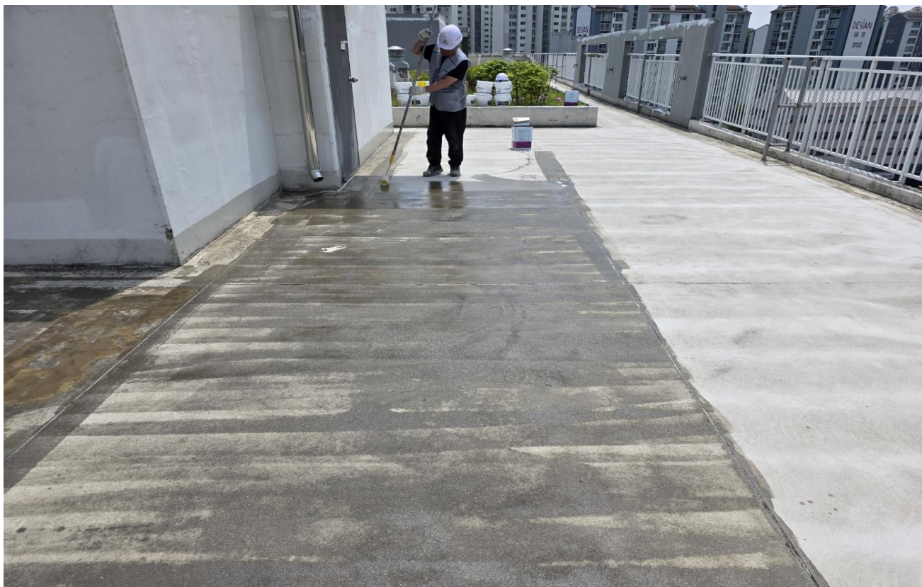
공사 중 (옥상 : 우레탄 하도 도포)
