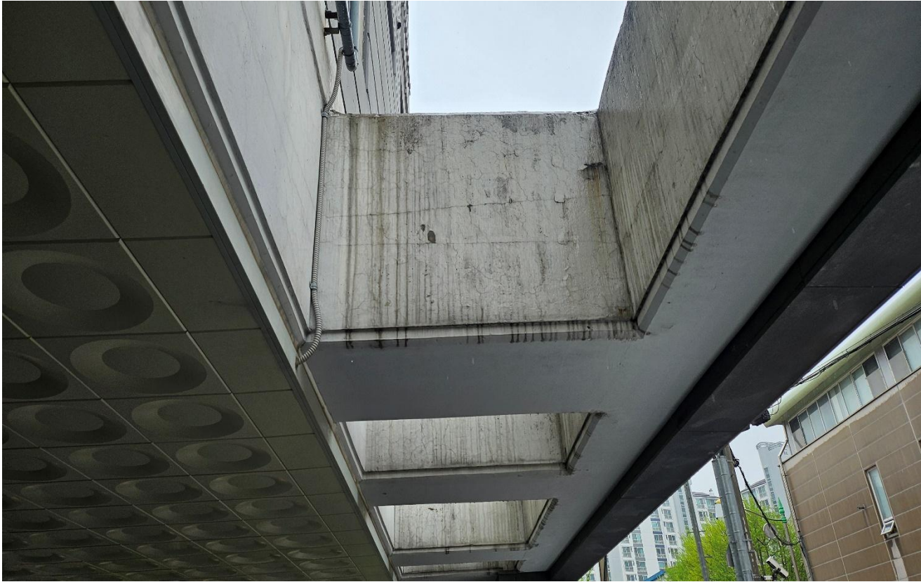
공사 전 (외부)
