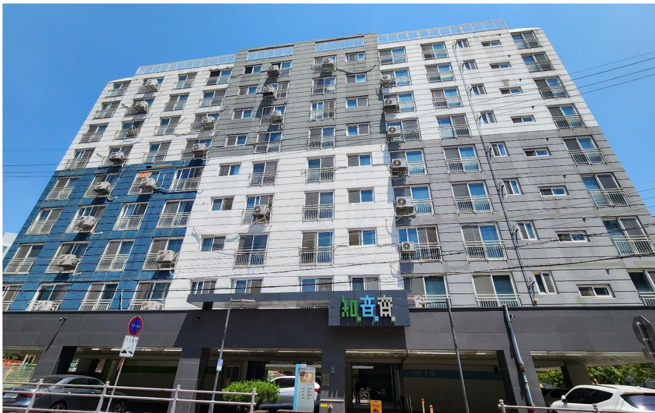
공사 전 (외부)
