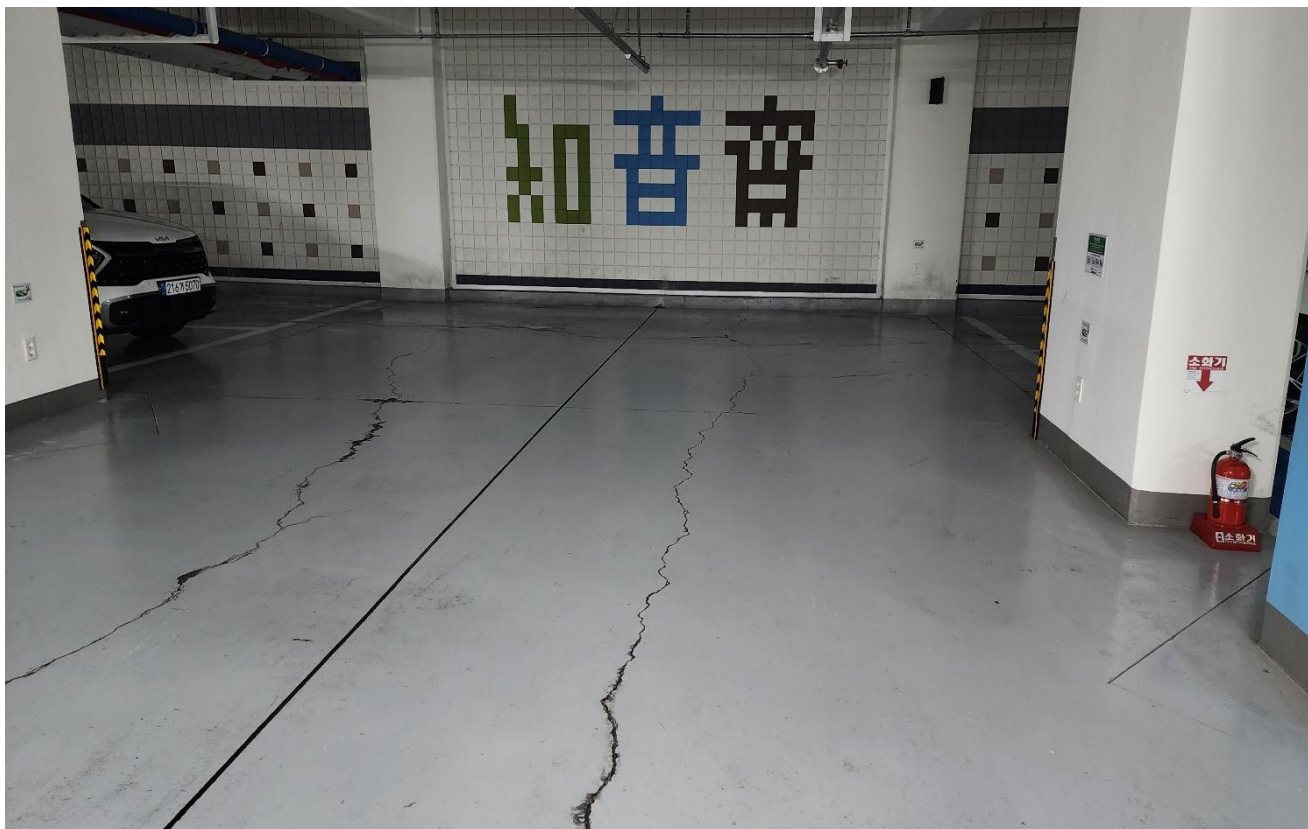
공사 전 (지하주차장)
