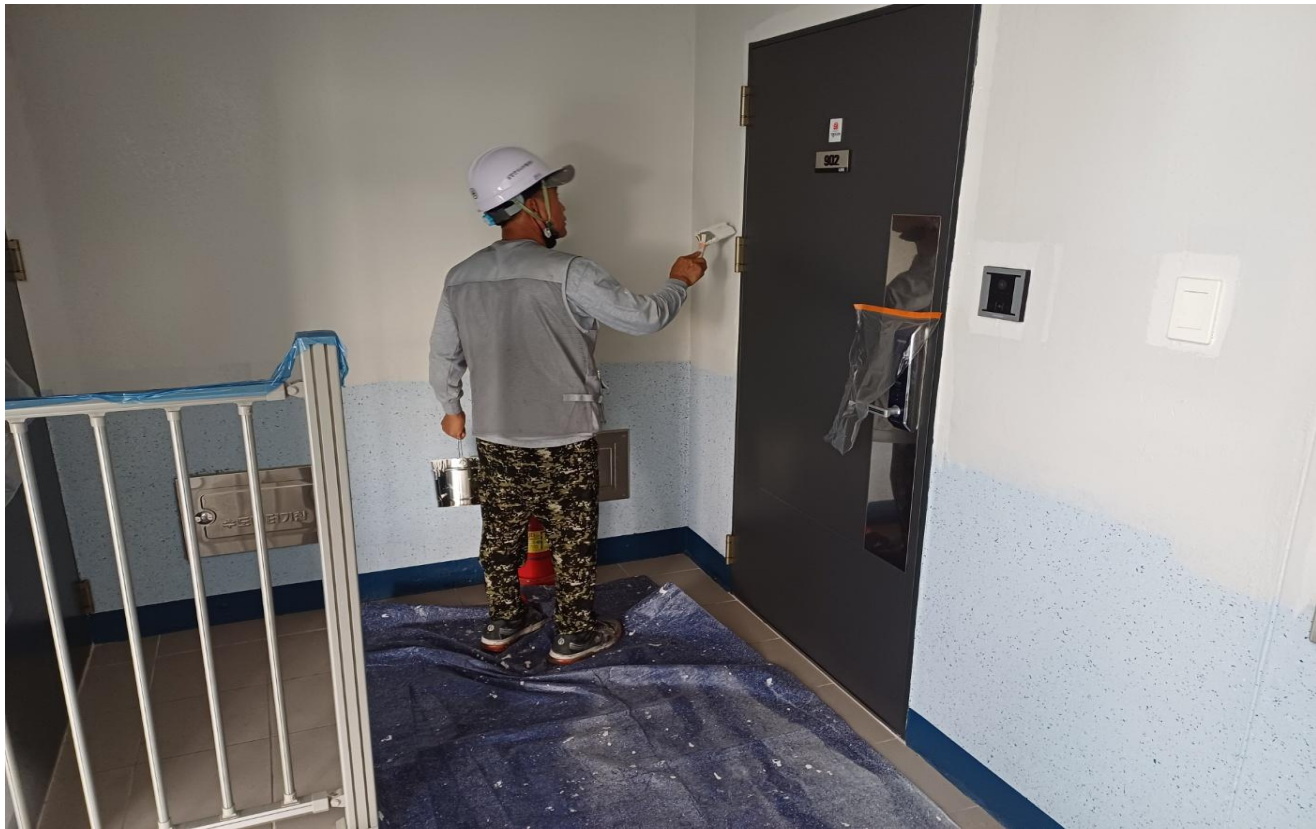
공사 중 (내부 : 수성페인트 도장)
