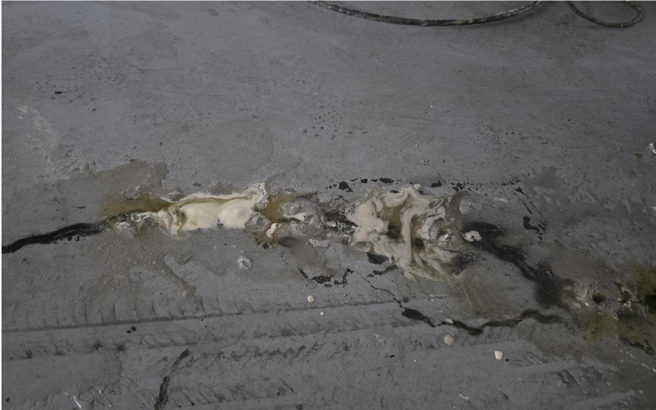
공사 중 (지하주차장 : 인젝션)
