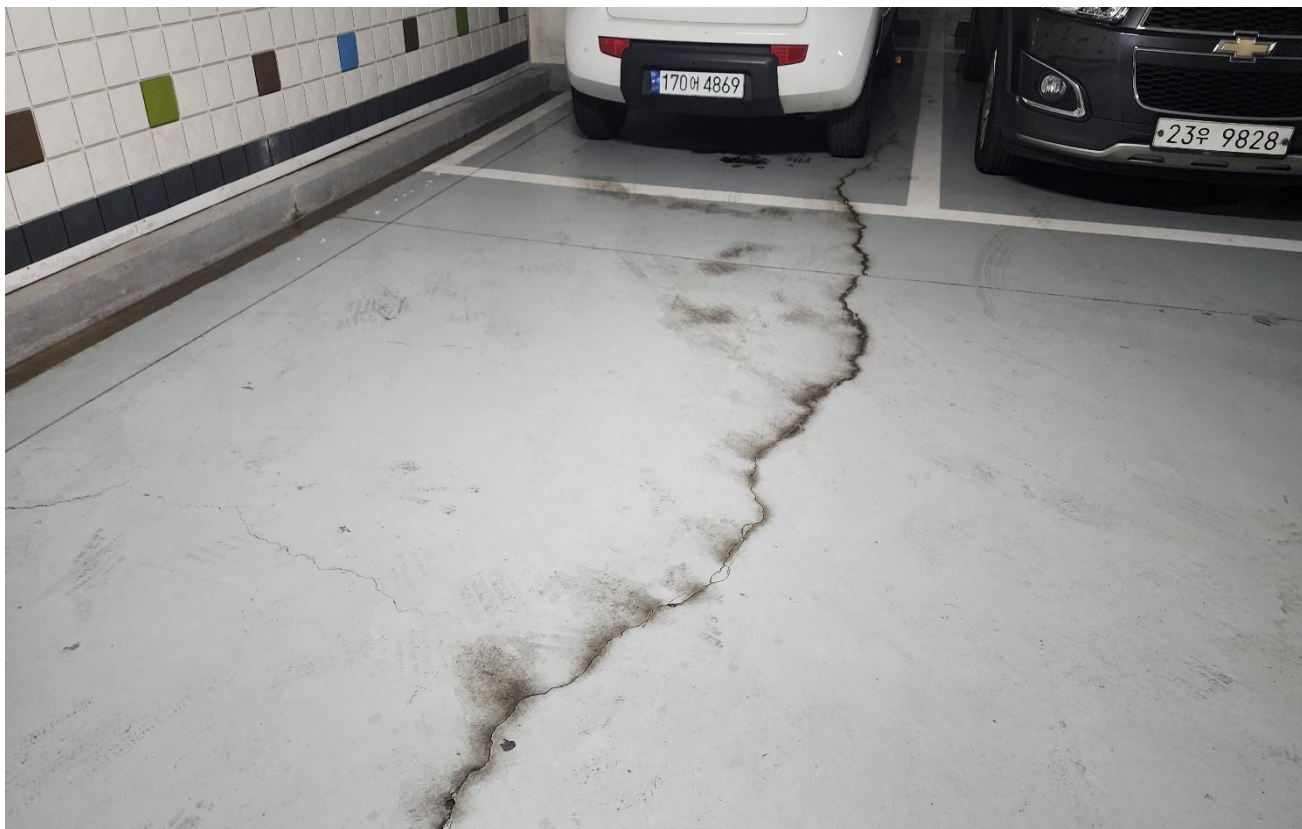
공사 전 (지하주차장)
