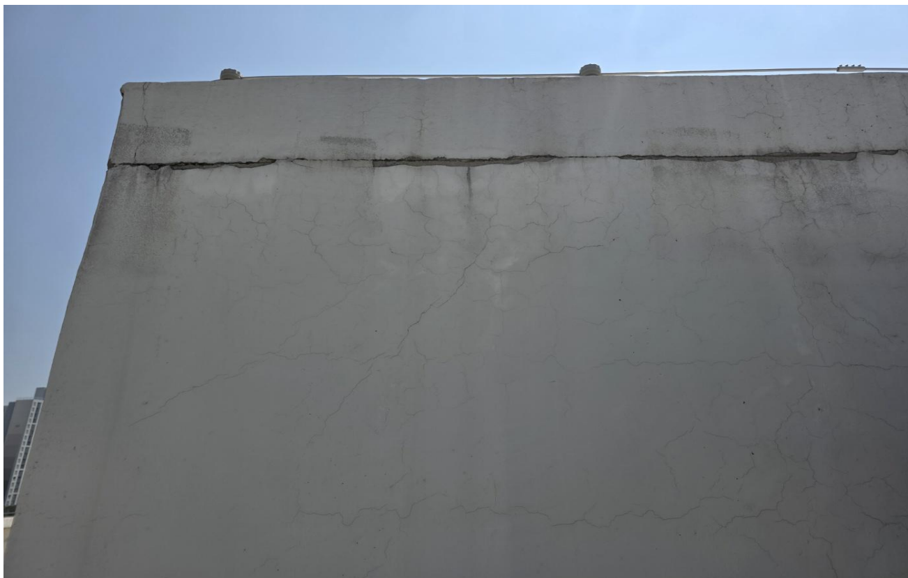
공사 전 (옥상)
