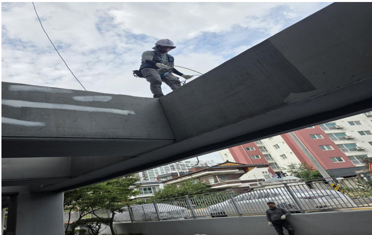
공사 중 (외부 : 수성페인트 도장)
