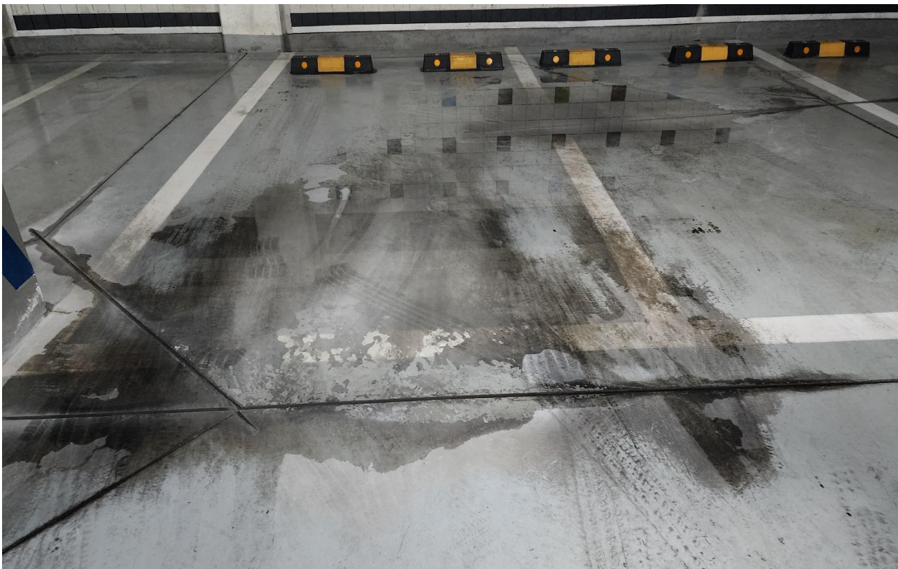
공사 전 (지하주차장)
