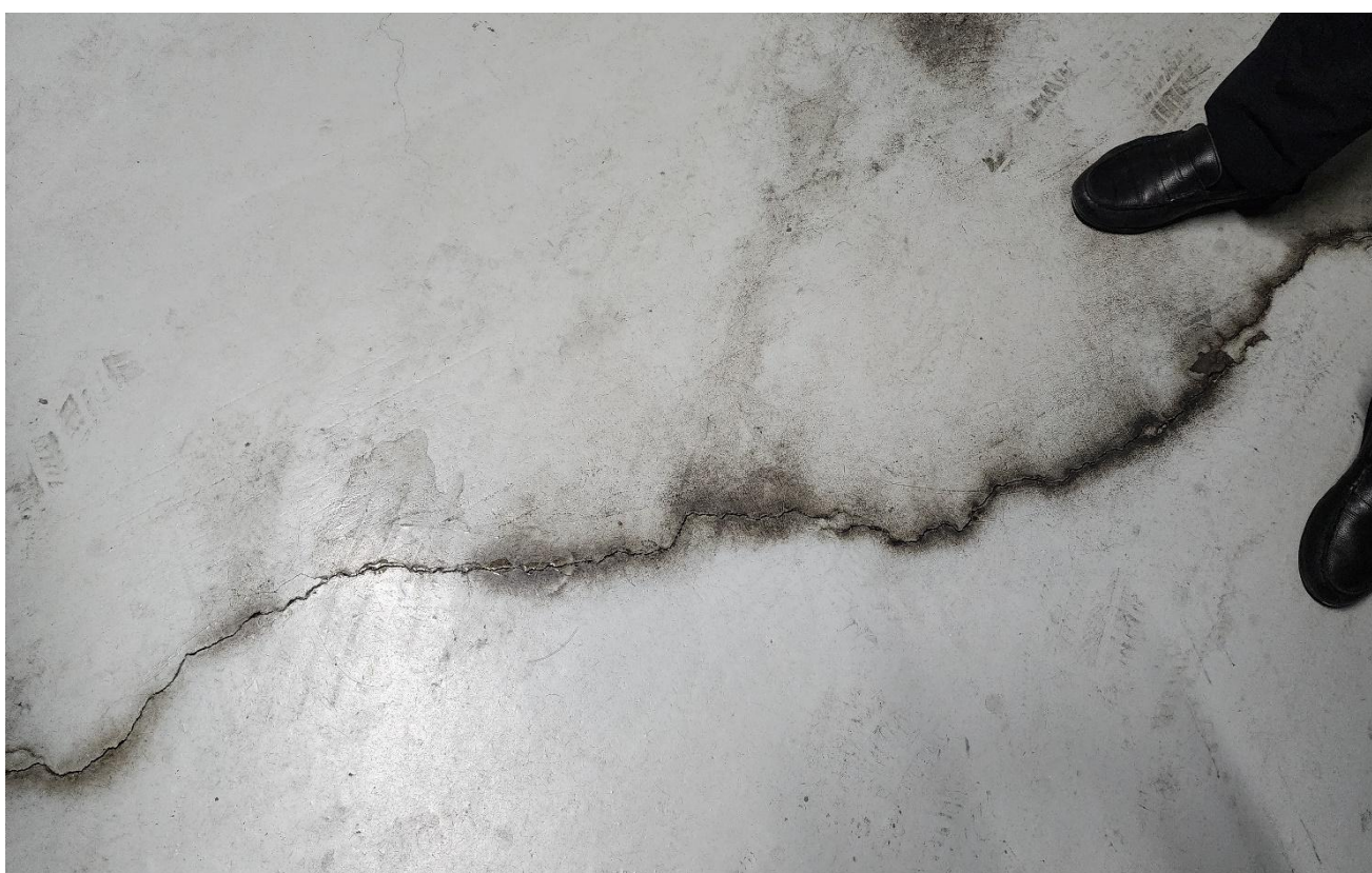
공사 전 (지하주차장)
