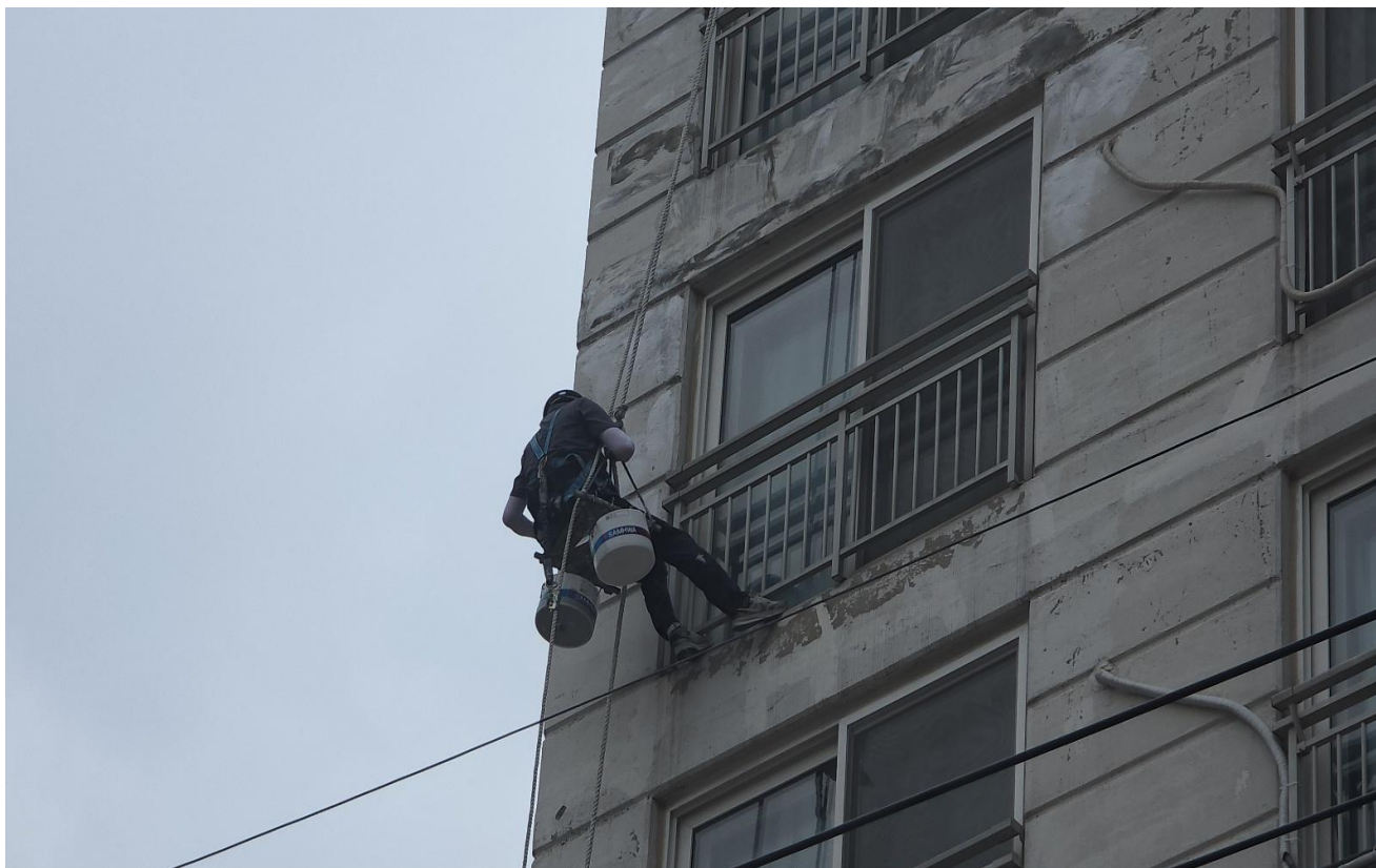
공사 중 (외부 : 균열보수)
