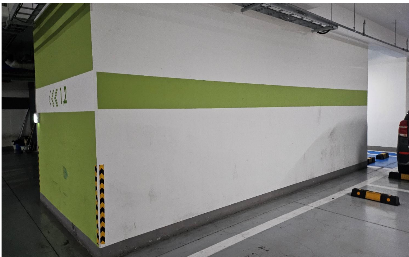
공사 전 (지하주차장)
