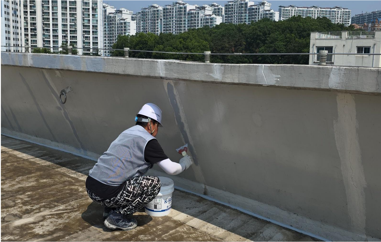
공사 중 (옥상 : 우레탄 실란트 도포)
