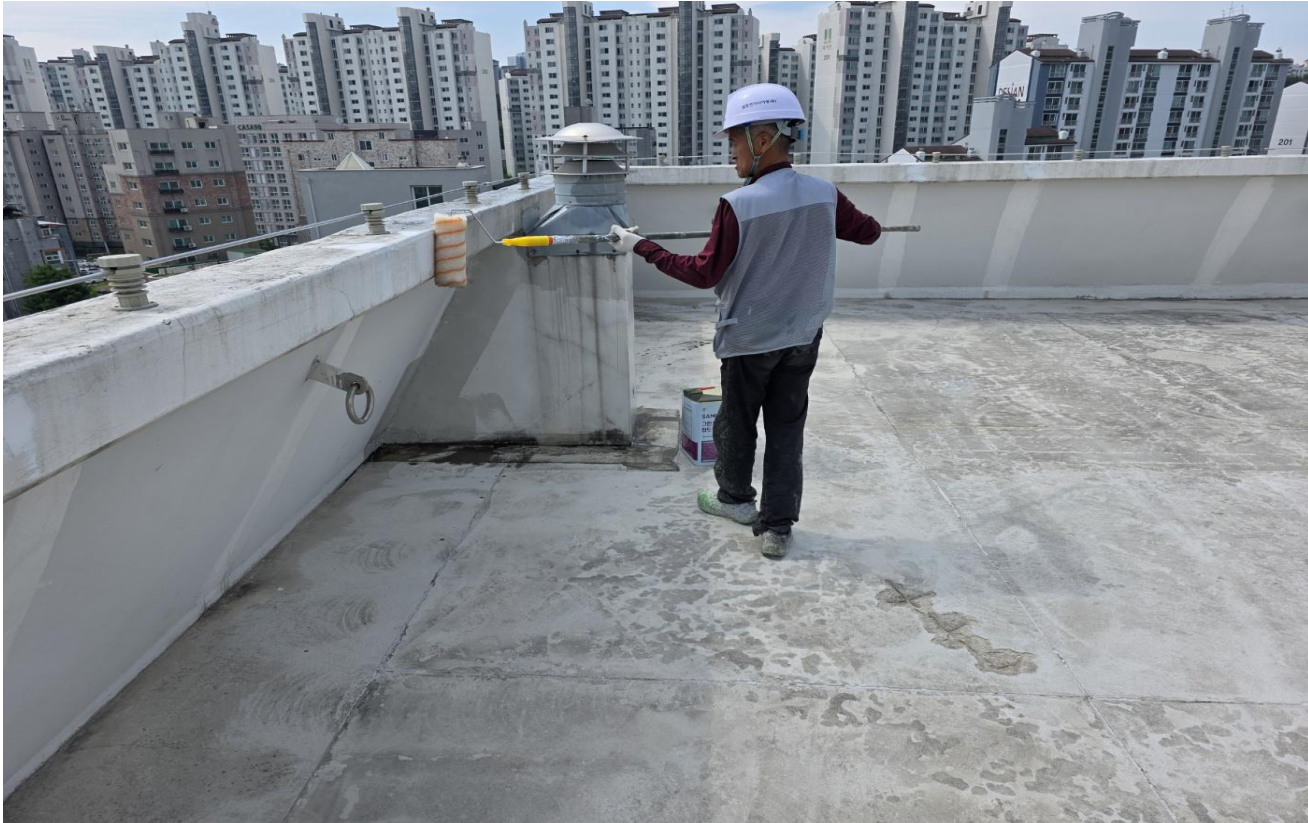
공사 중 (옥상 : 우레탄 하도 도포)
