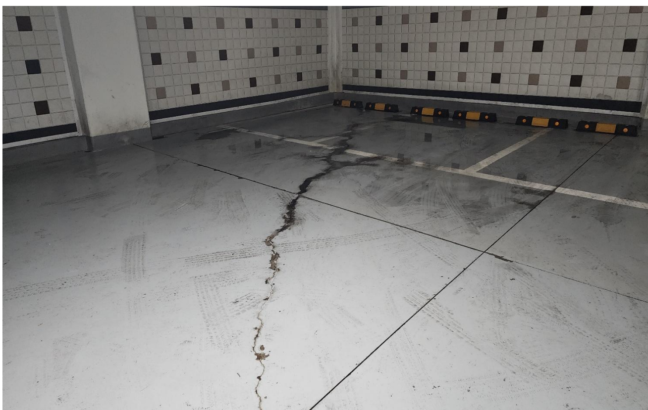
공사 전 (지하주차장)
