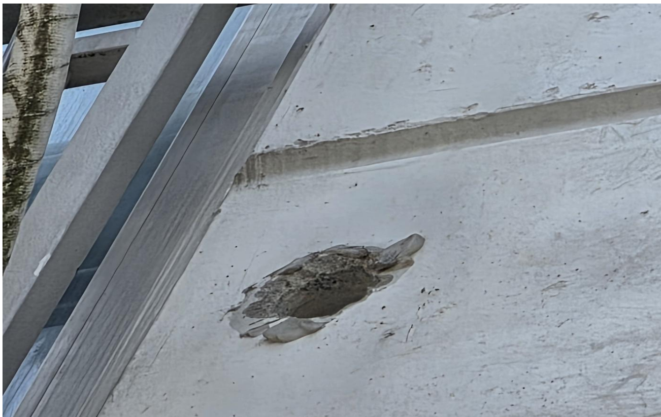
공사 전 (외부)
