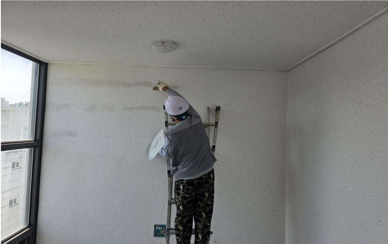
공사 중 (내부 : 균열보수)
