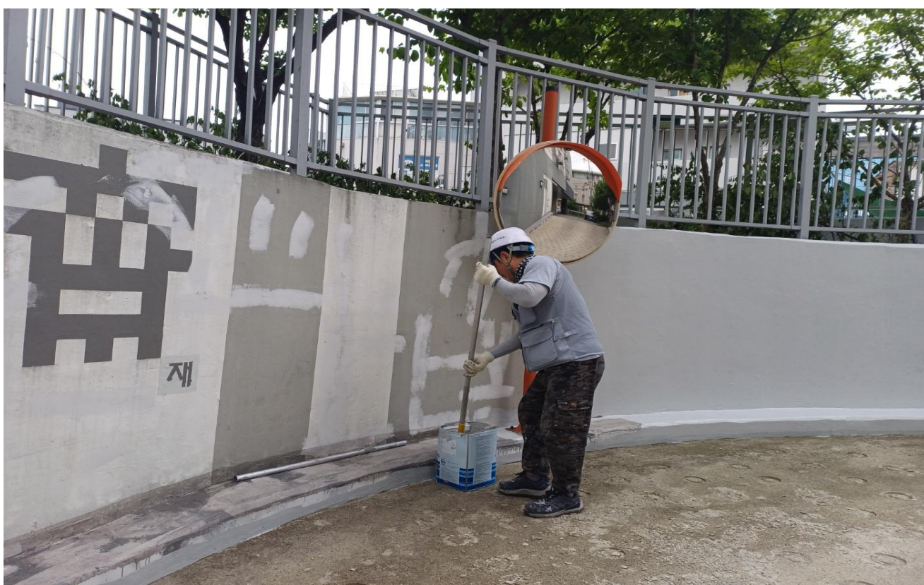
공사 중 (부대시설 도장)
