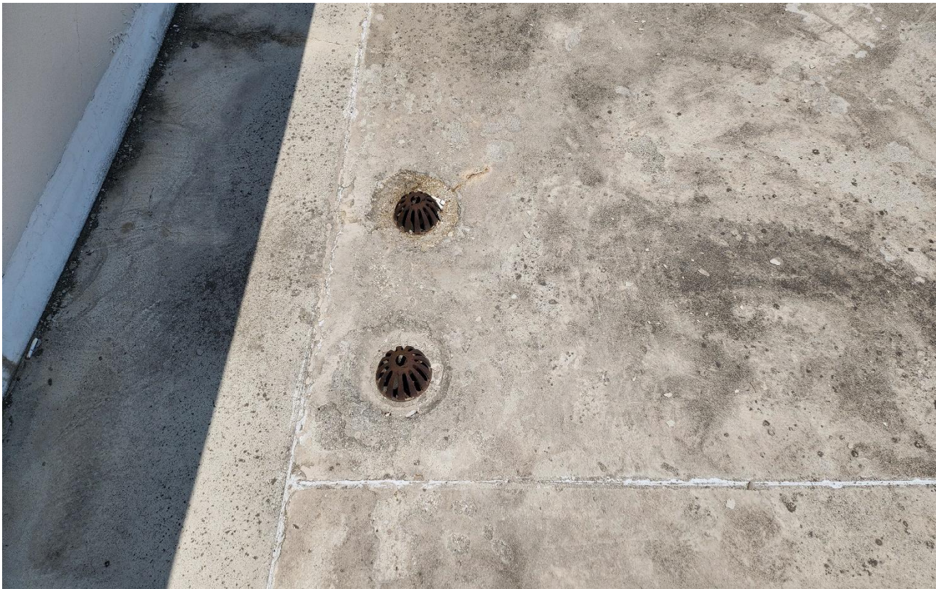
공사 전 (옥상)
