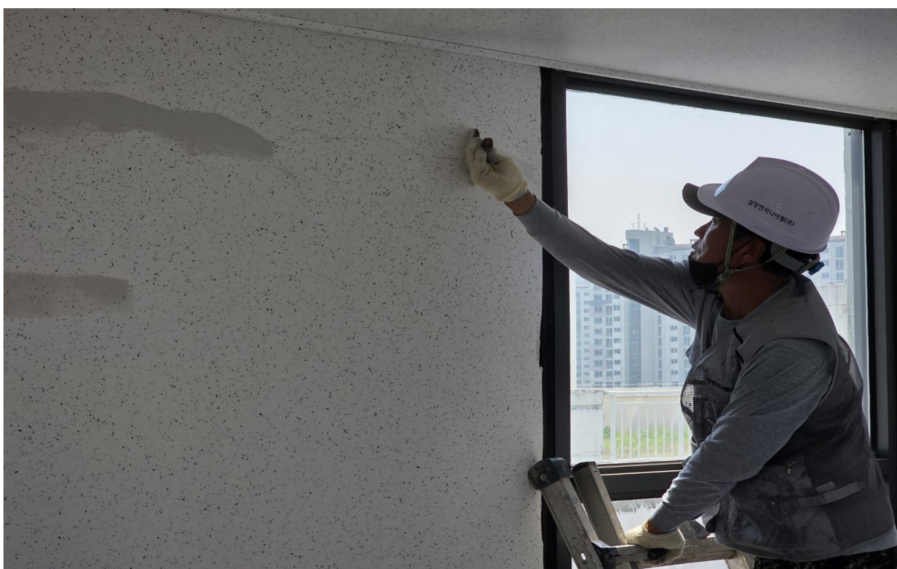
공사 중 (내부 : 균열보수)
