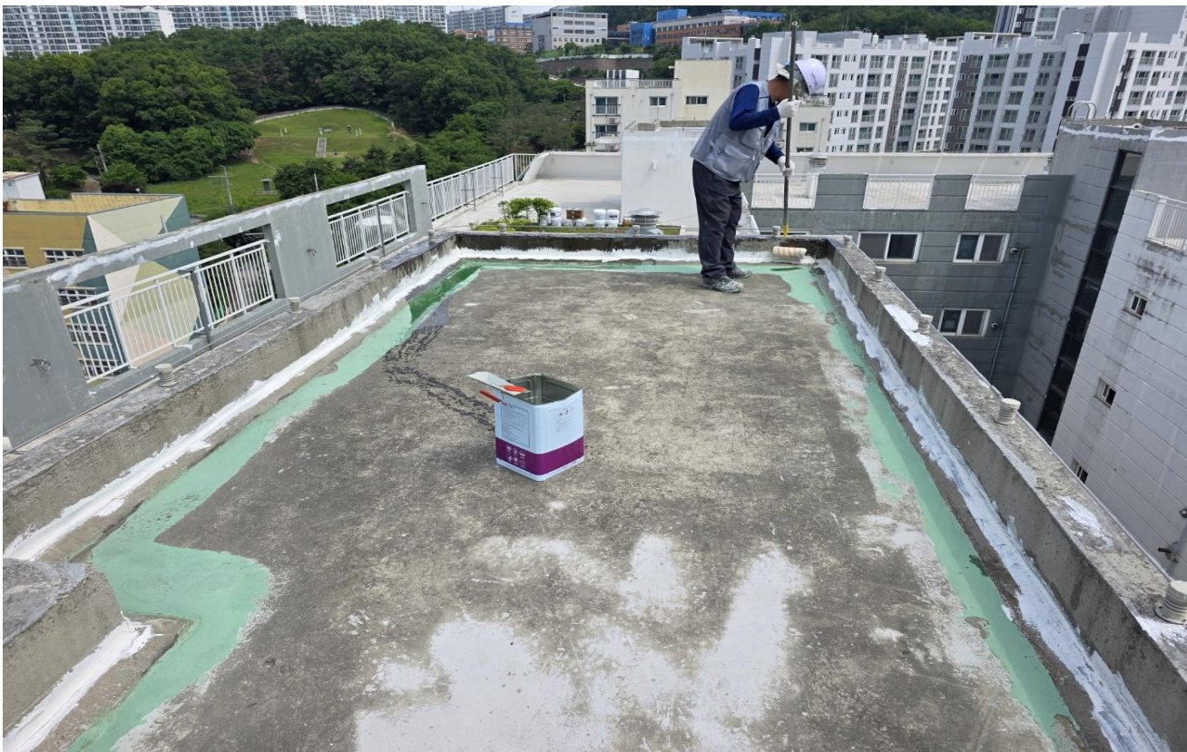
공사 중 (옥상 : 우레탄 하도 도포)
