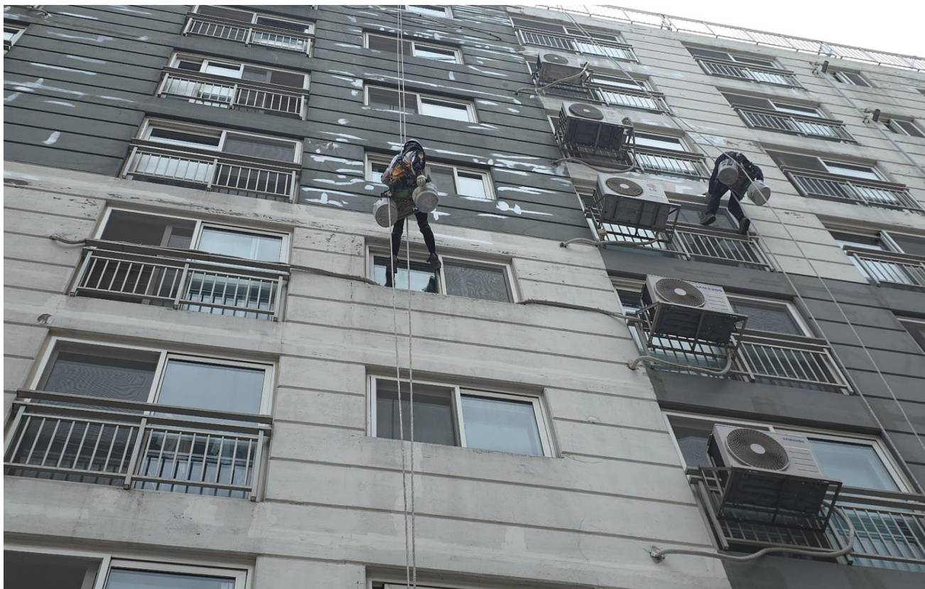
공사 중 (외부 : 균열보수)
