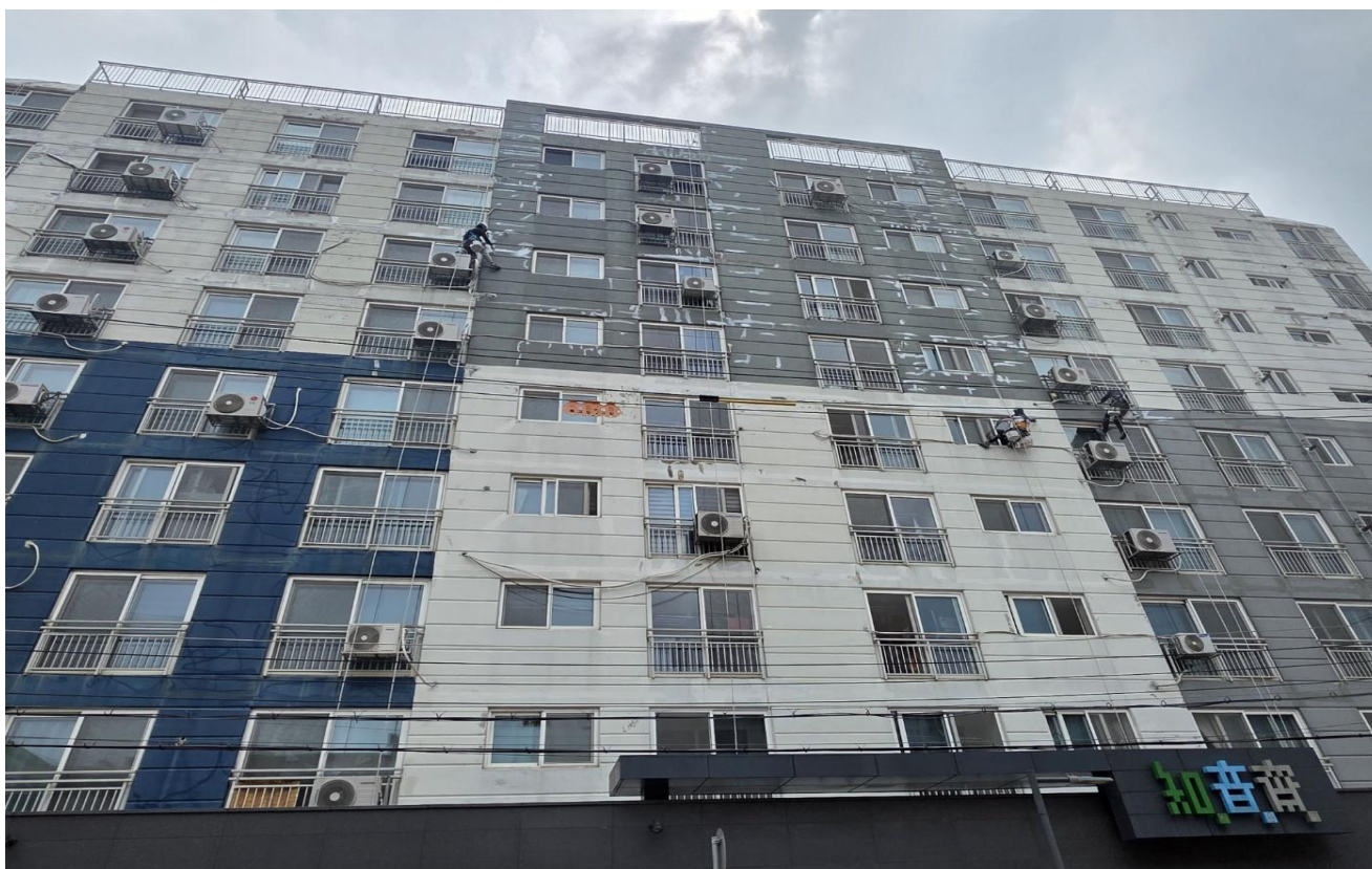
공사 중 (외부 : 균열보수)
