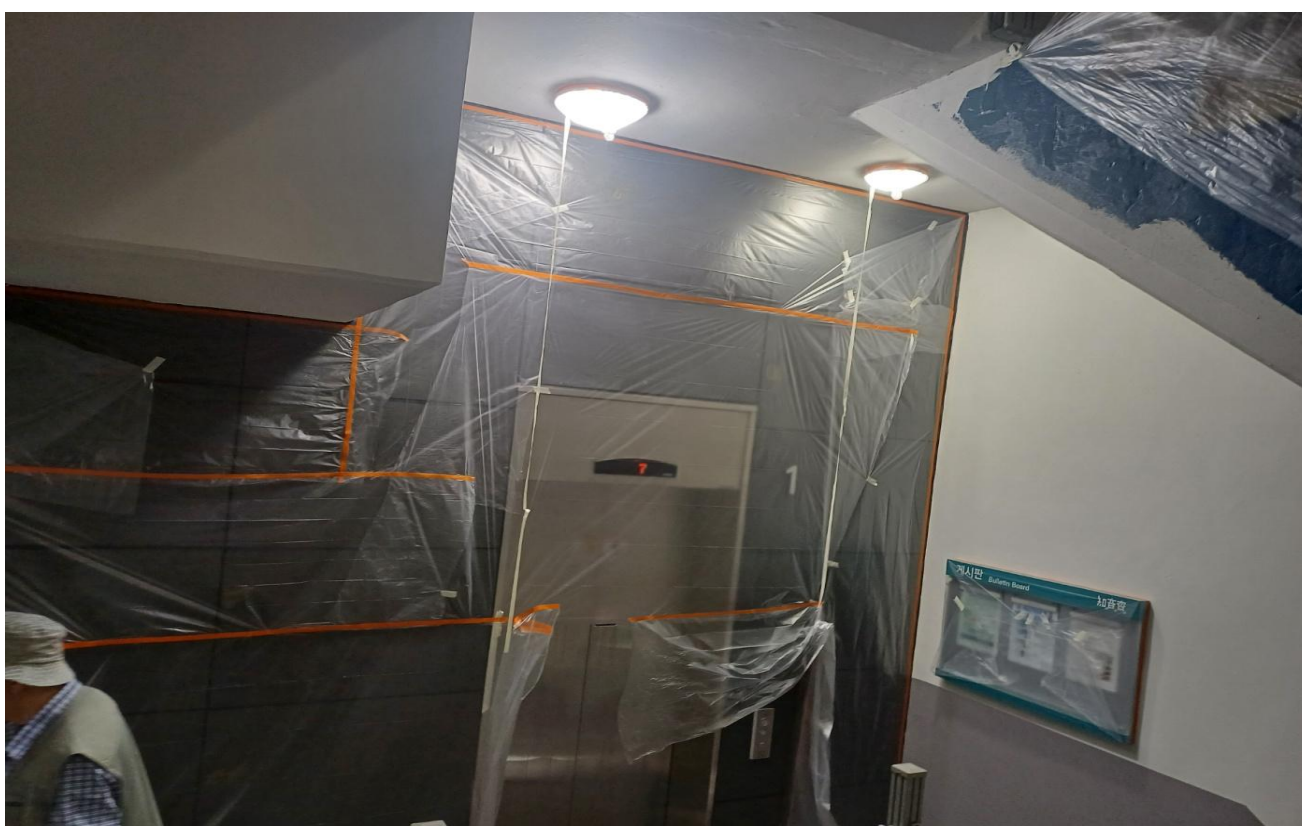
공사 중 (내부 : 무늬코트 도장)
