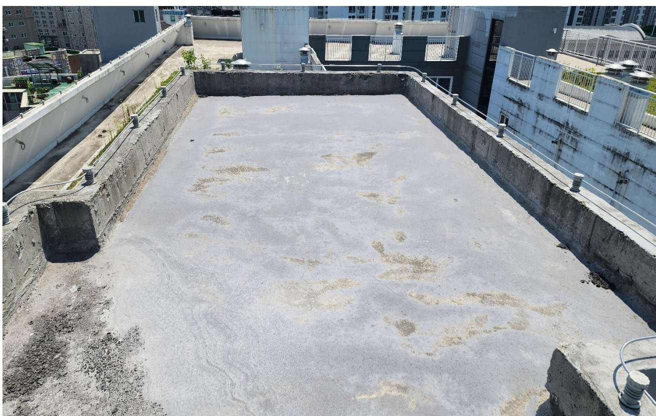
공사 전 (옥상)
