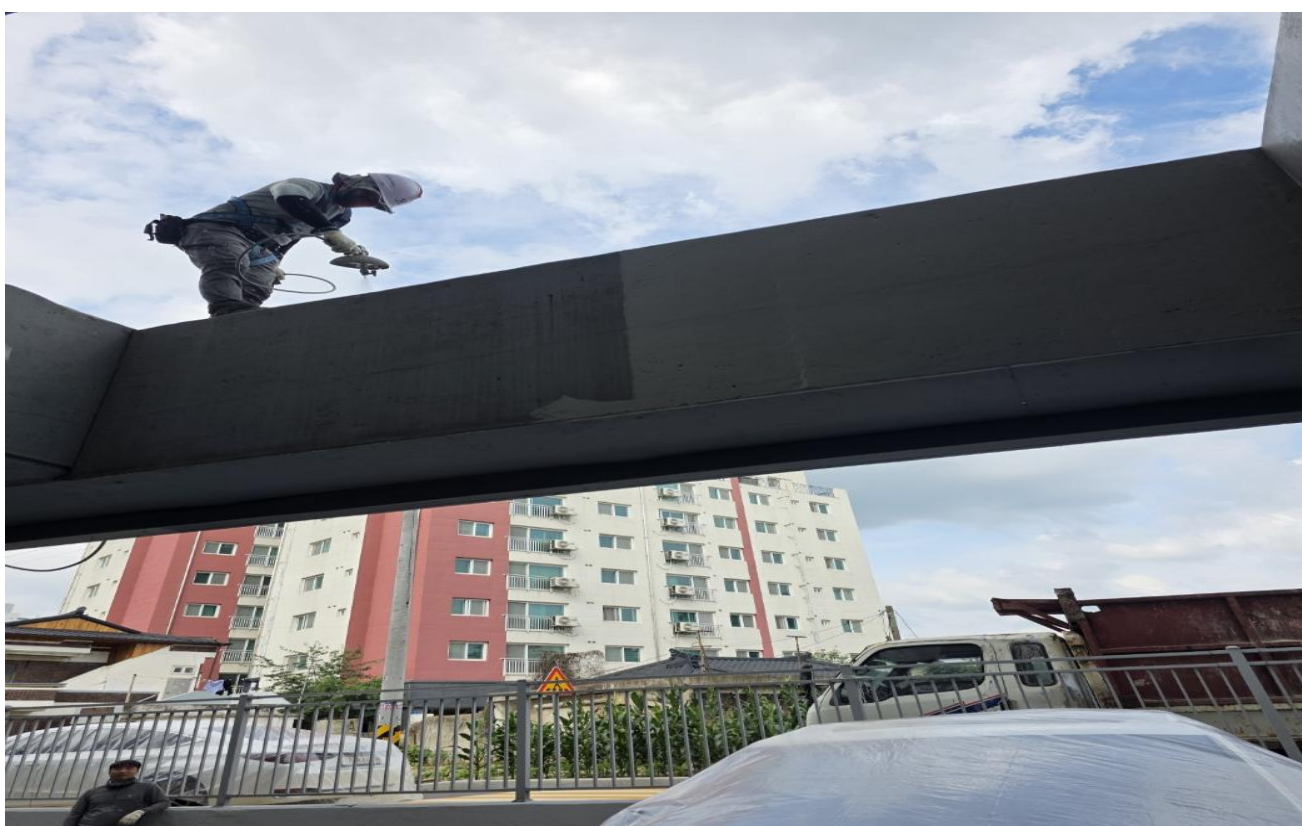
공사 중 (외부 : 수성페인트 도장)
