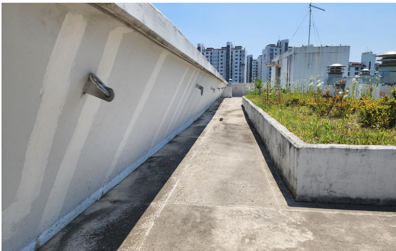
공사 전 (옥상)
