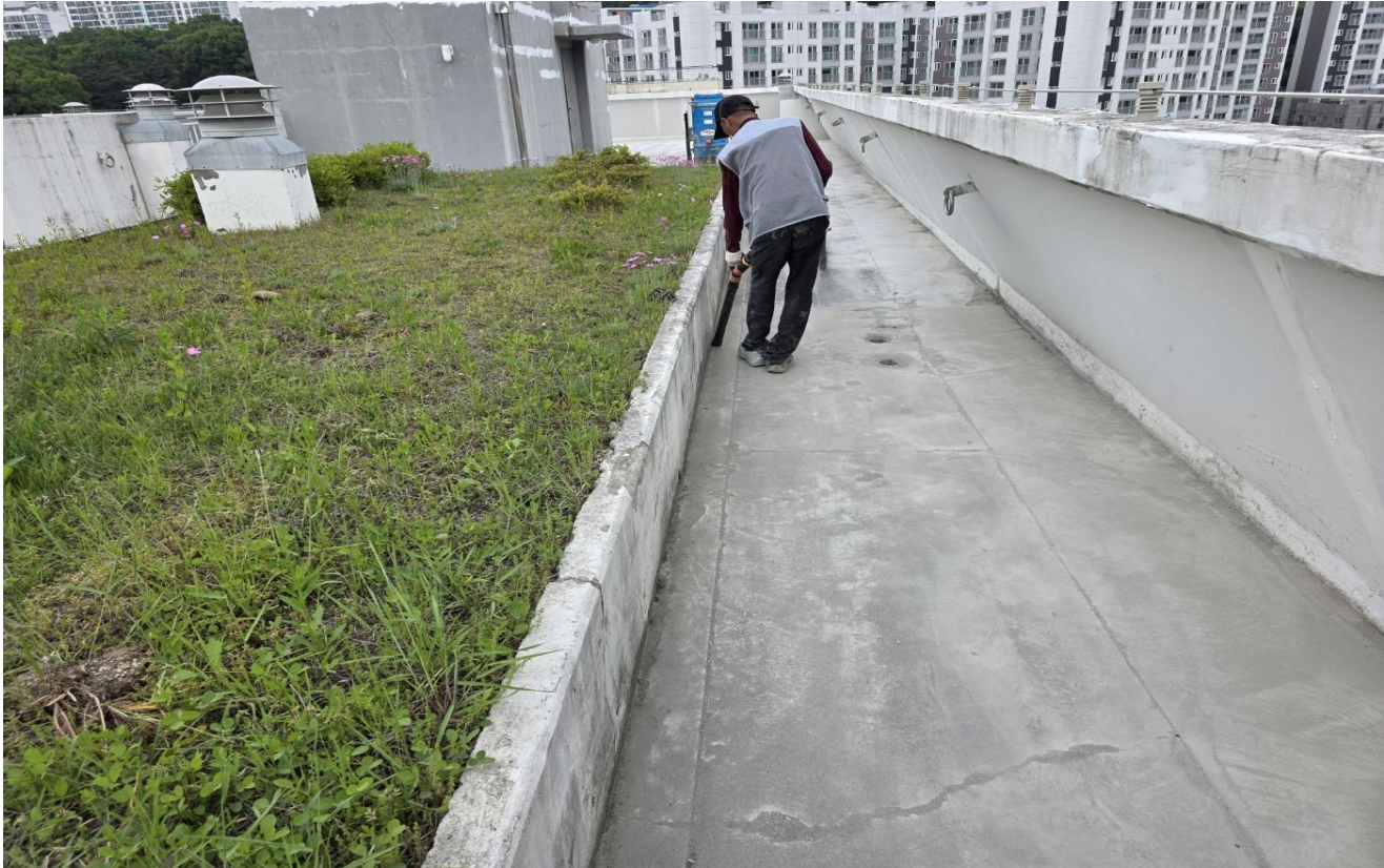
공사 중 (옥상 : 바탕면 정리)
