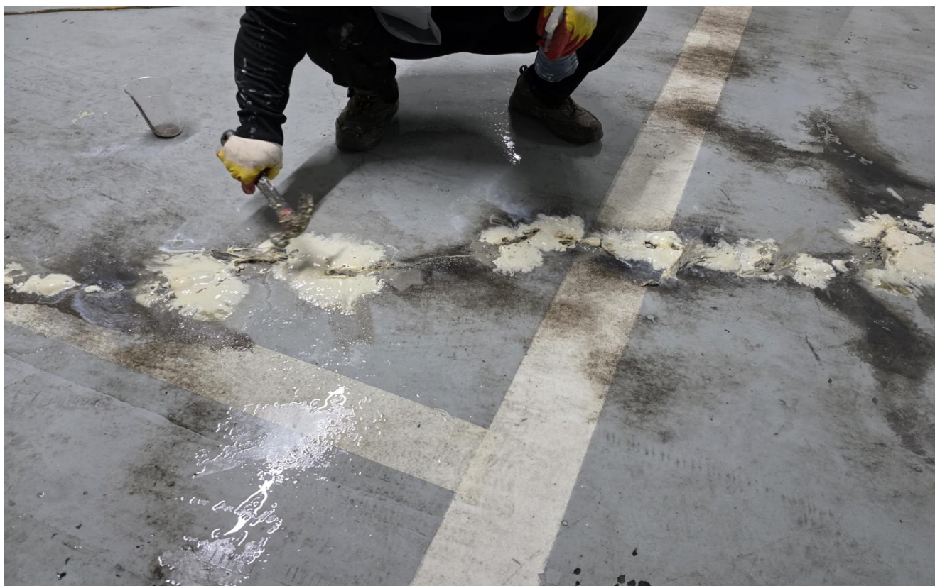
공사 중 (지하주차장 : 인젝션)
