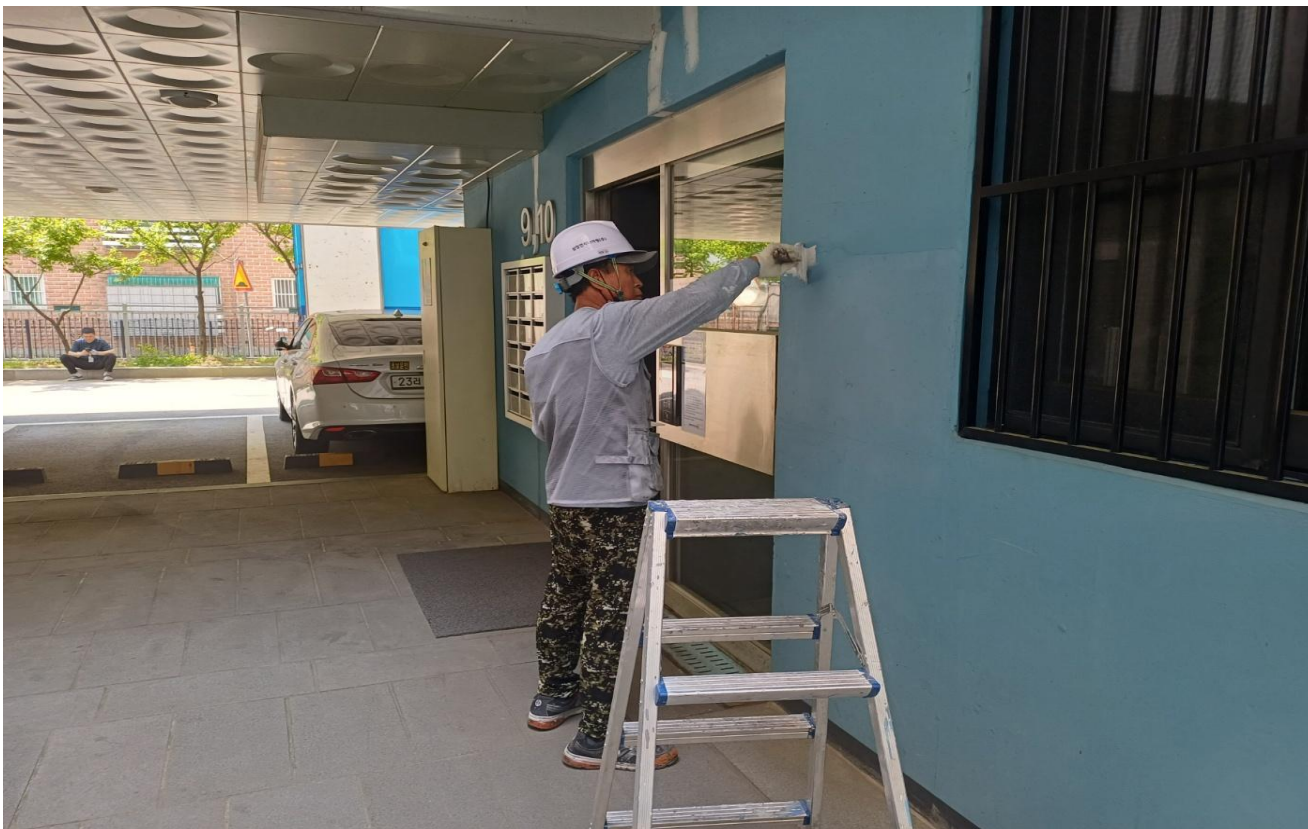
공사 중 (내부 : 균열보수)
