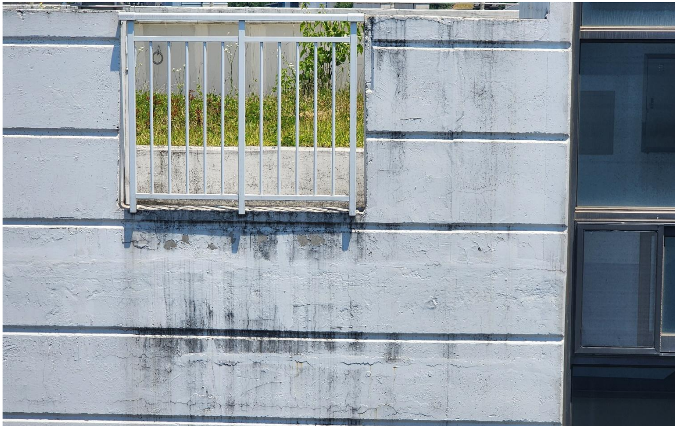
공사 전 (외부)
