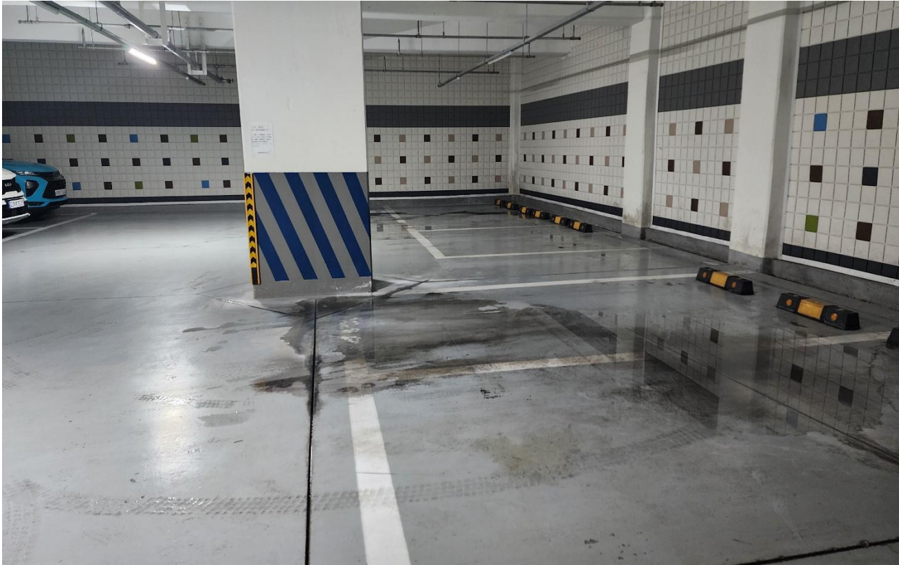
공사 전 (지하주차장)
