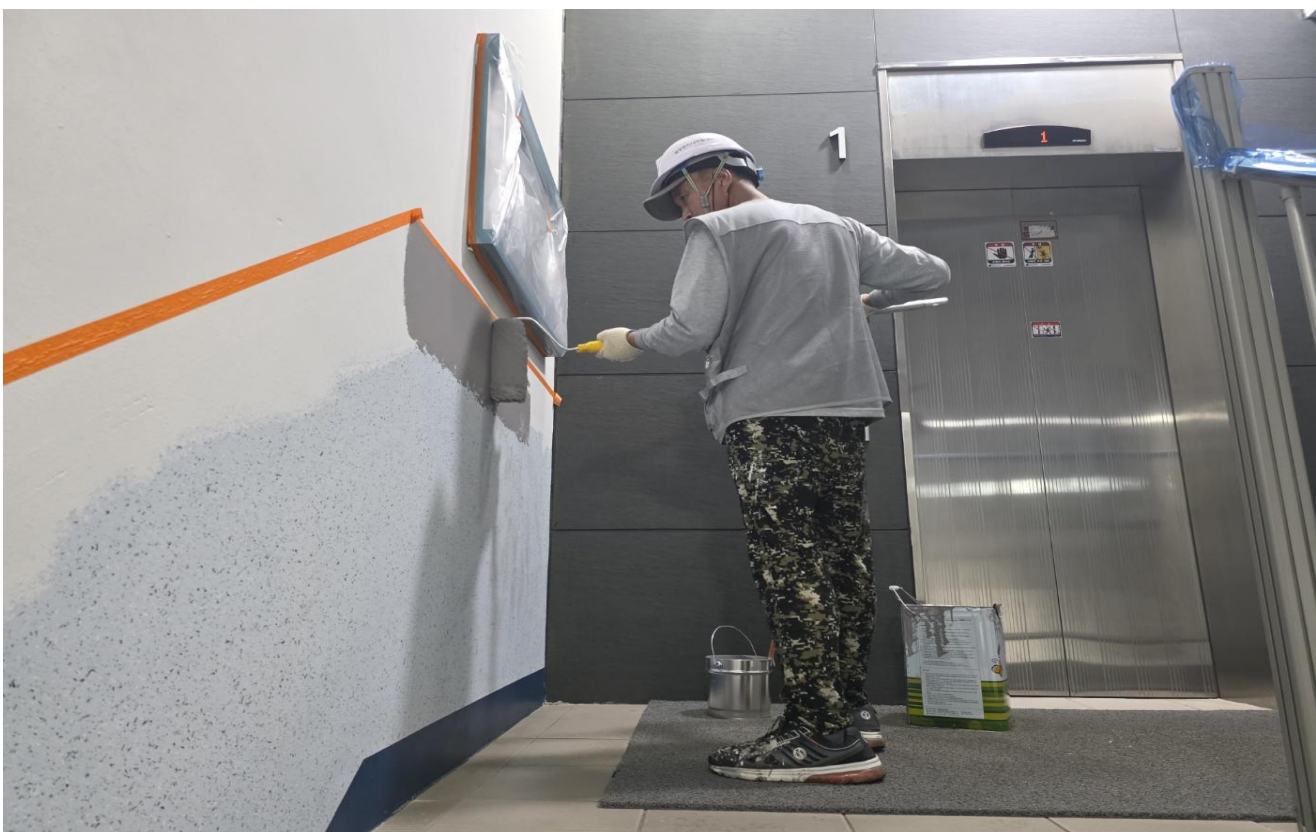
공사 중 (내부 : 수성페인트 도장)
