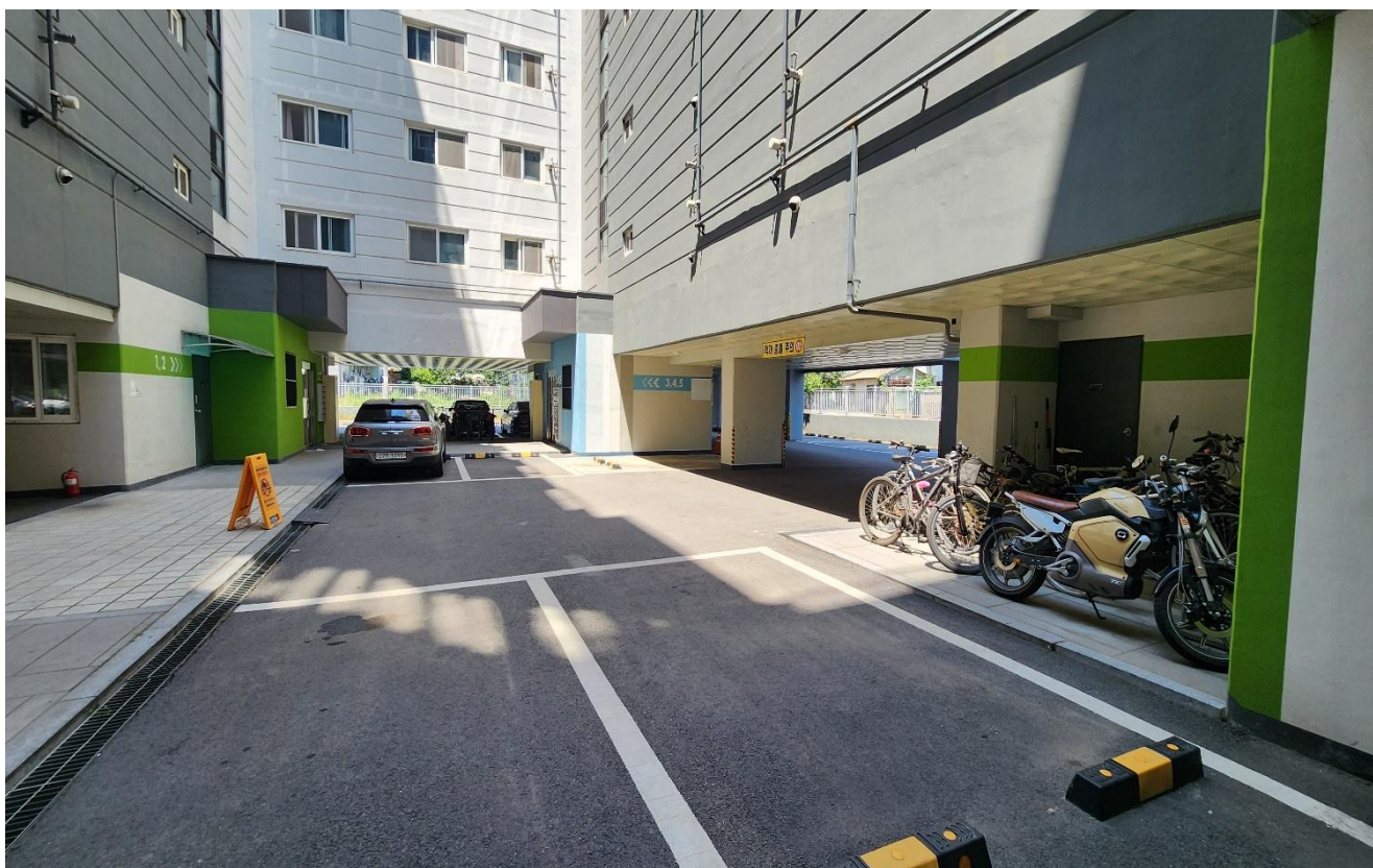
공사 전 (부대시설)
