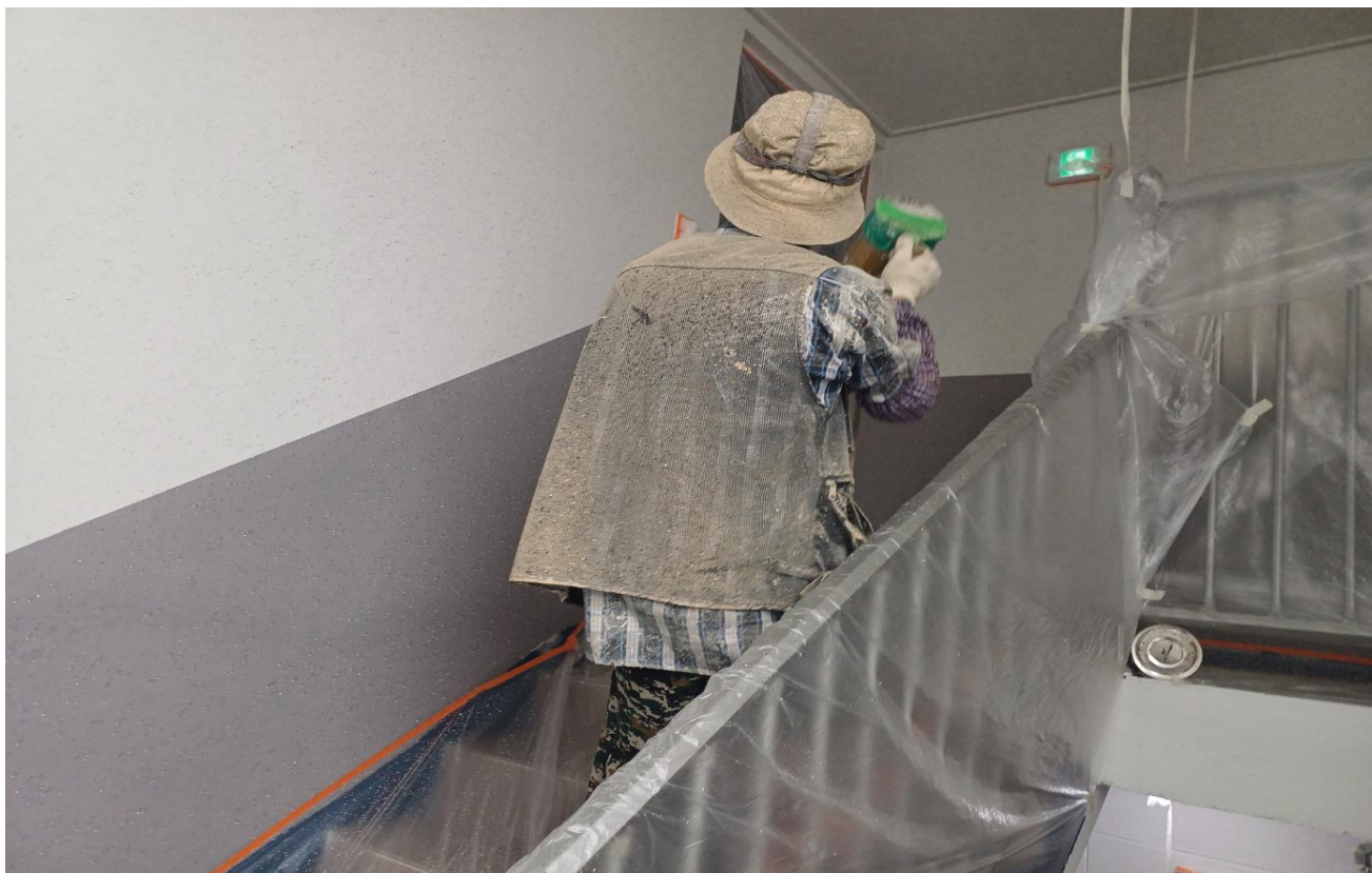
공사 중 (내부 : 무늬코트 도장)
