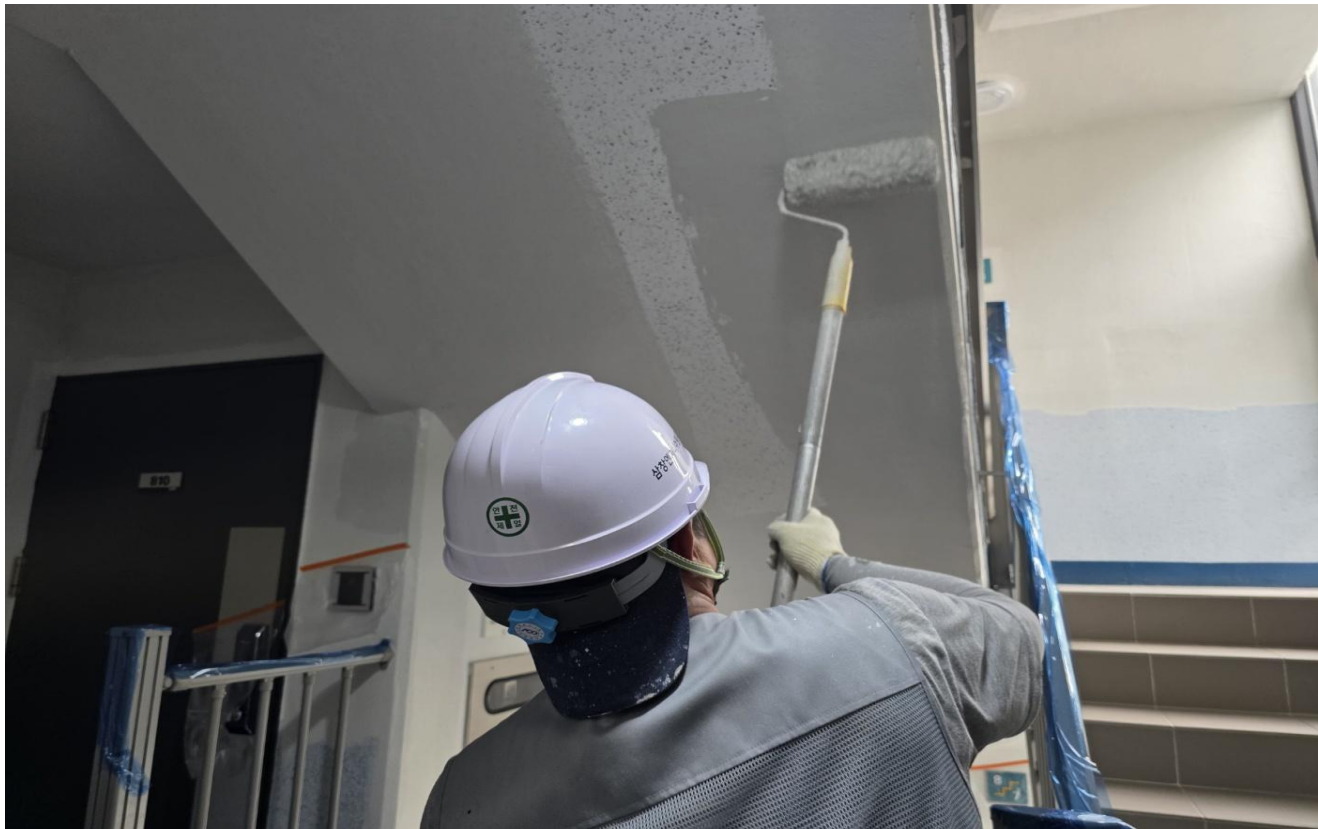
공사 중 (내부 : 수성페인트 도장)
