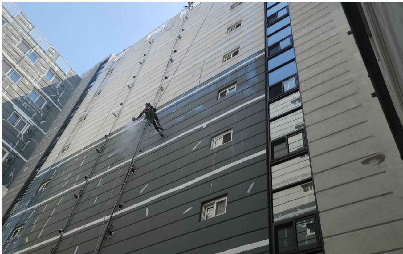
공사 중 (외부 : 바인다 도포)
