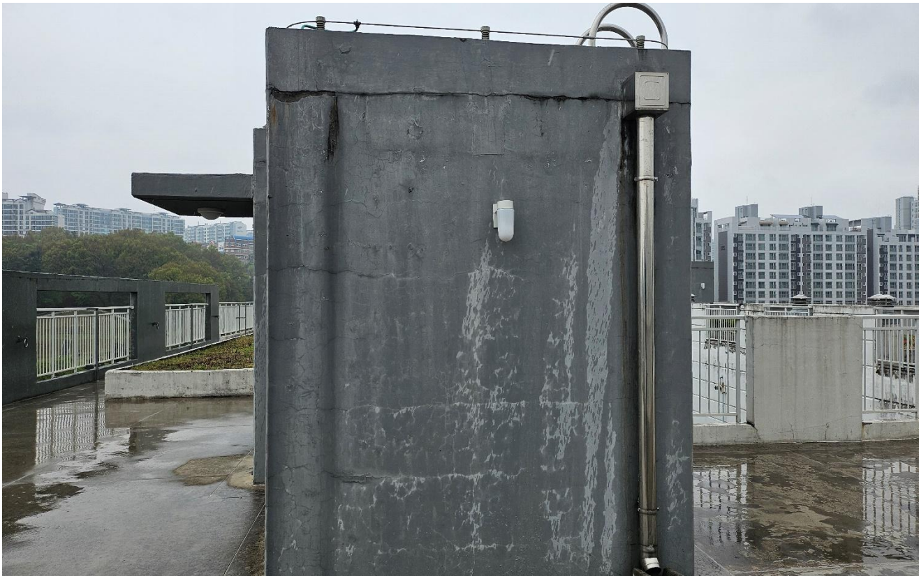
공사 전 (외부)
