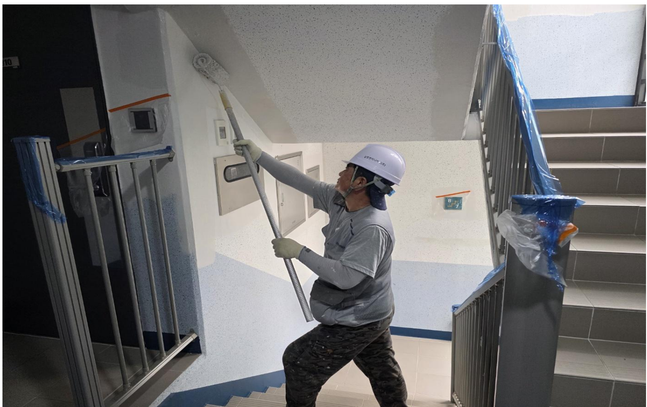
공사 중 (내부 : 수성페인트 도장)
