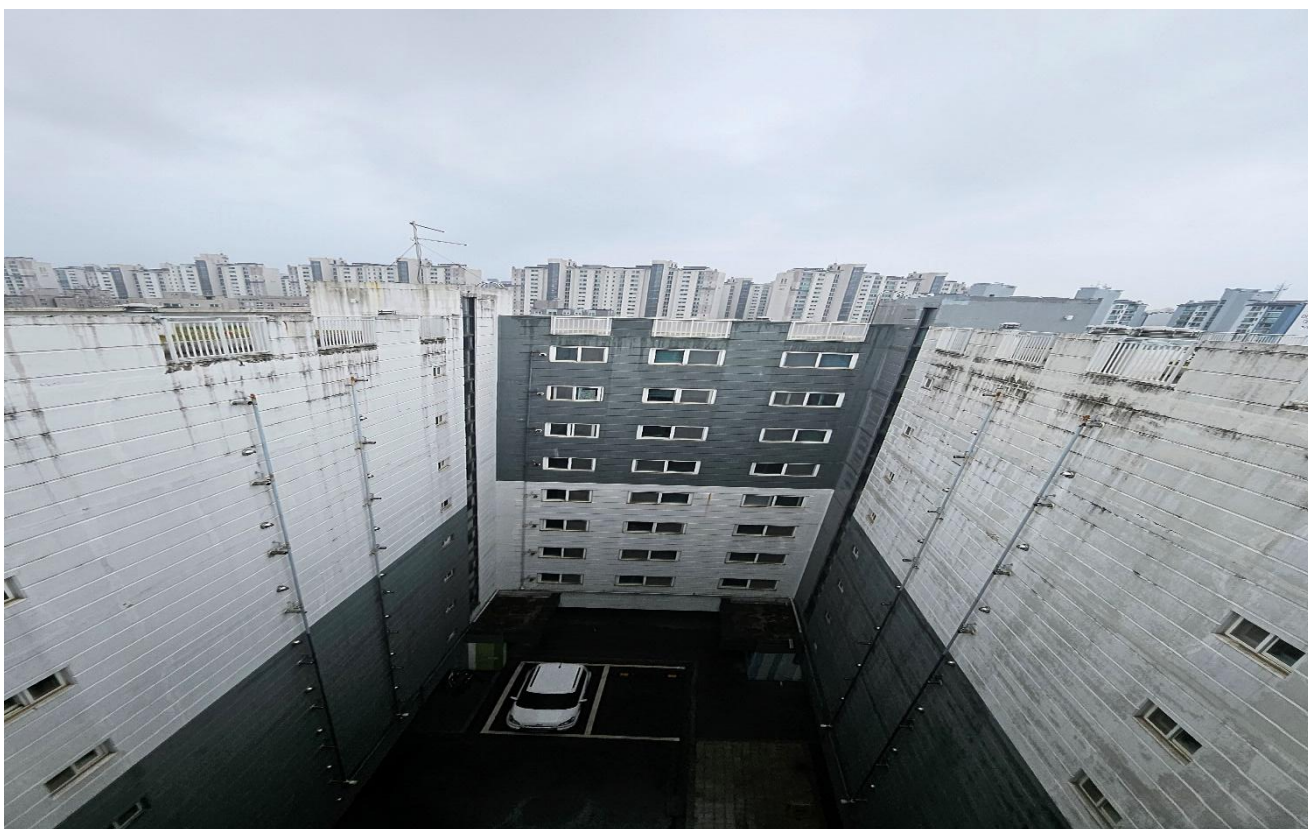
공사 전 (외부)
