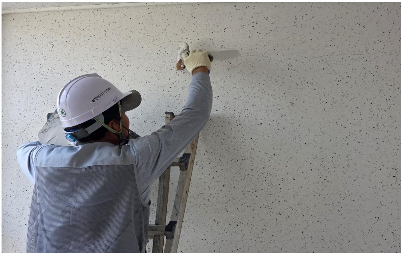
공사 중 (내부 : 균열보수)
