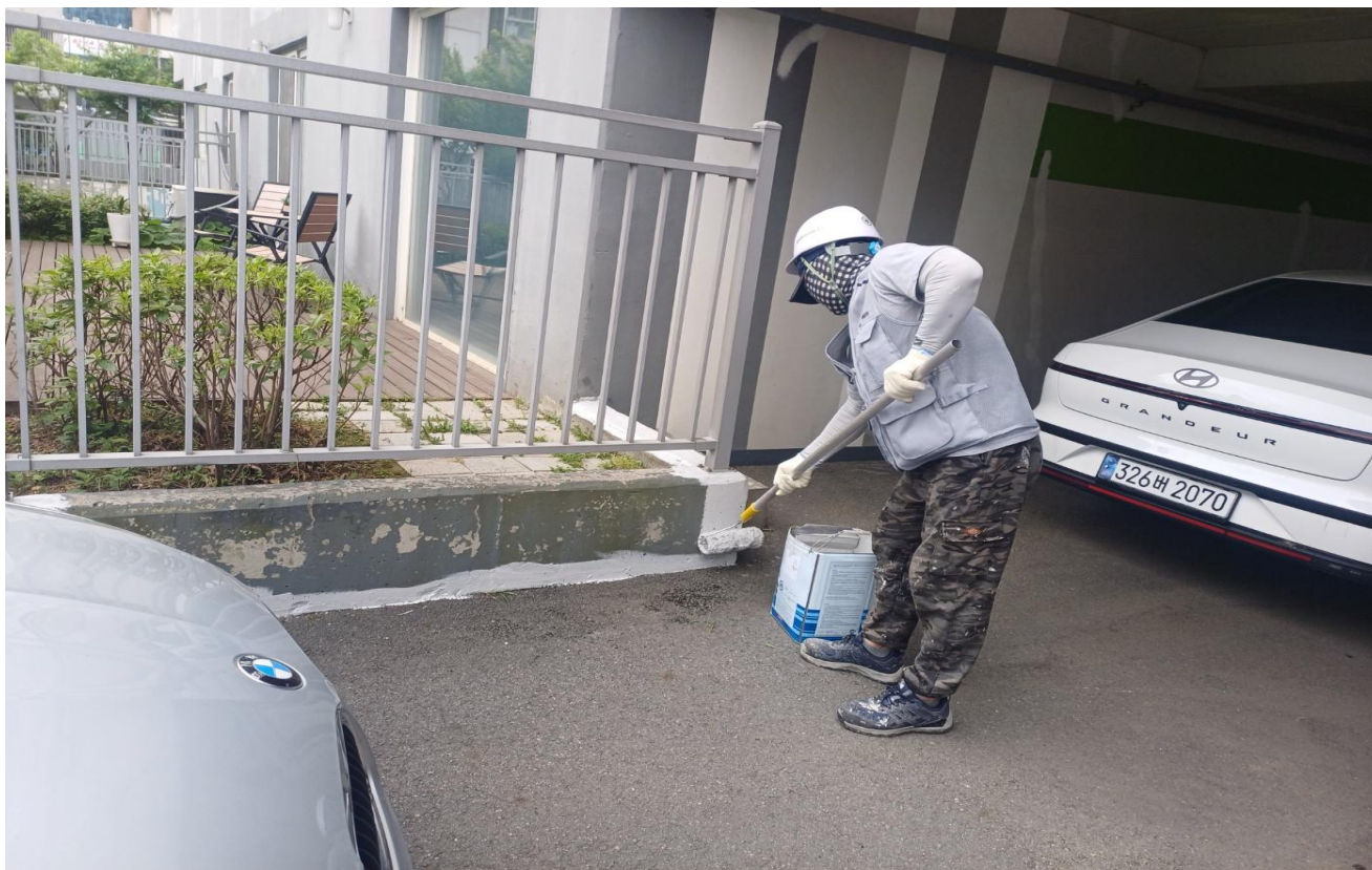
공사 중 (부대시설 도장)
