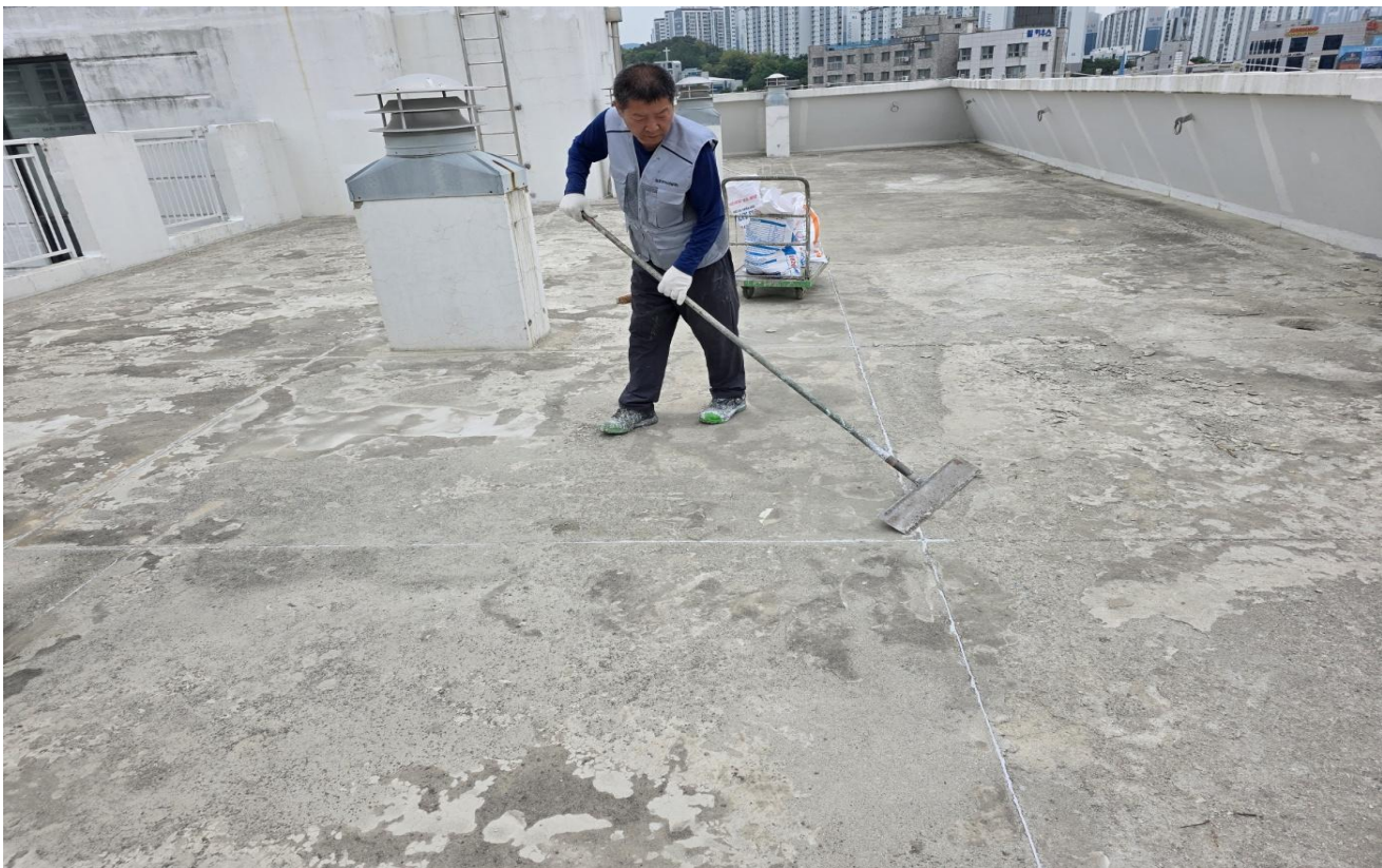
공사 중 (옥상 : 바탕면 정리)
