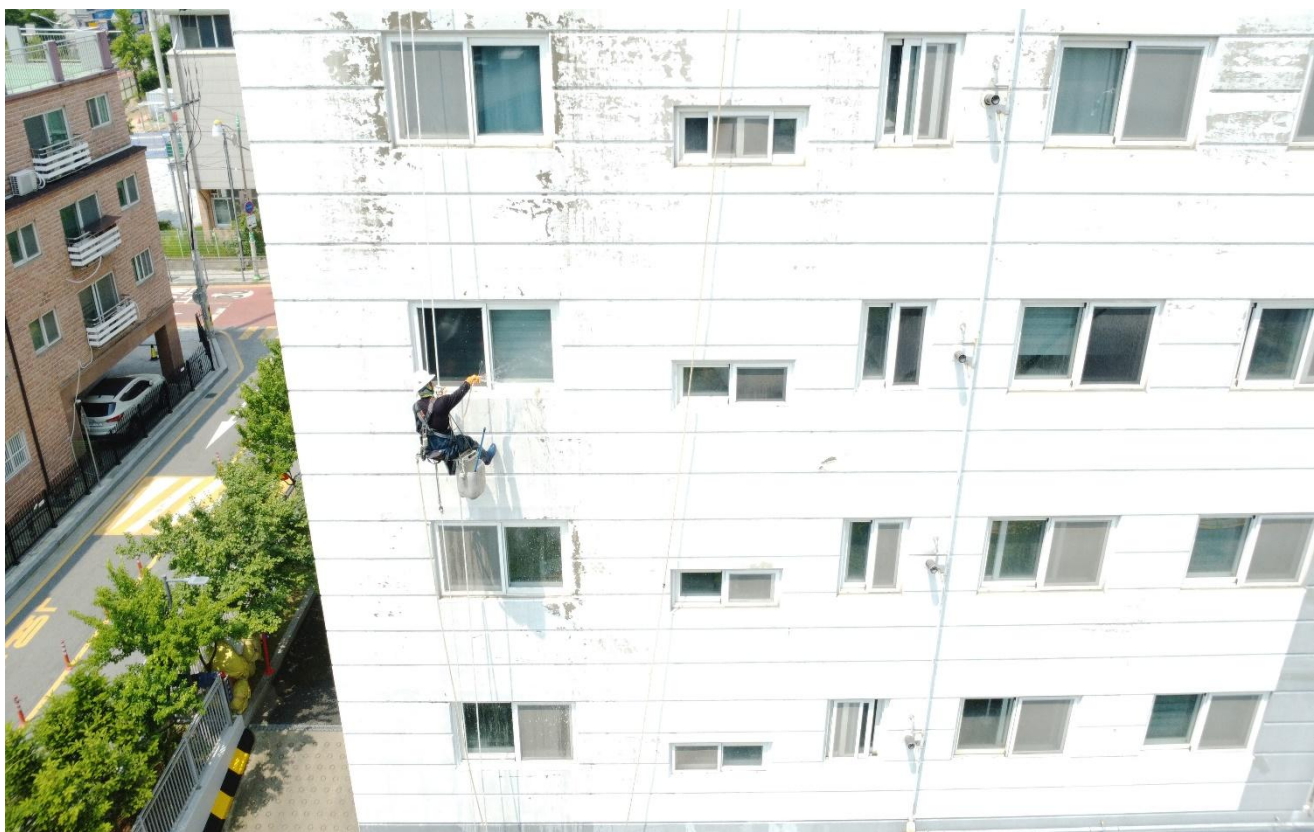
공사 중 (외부 : 고압세척)
