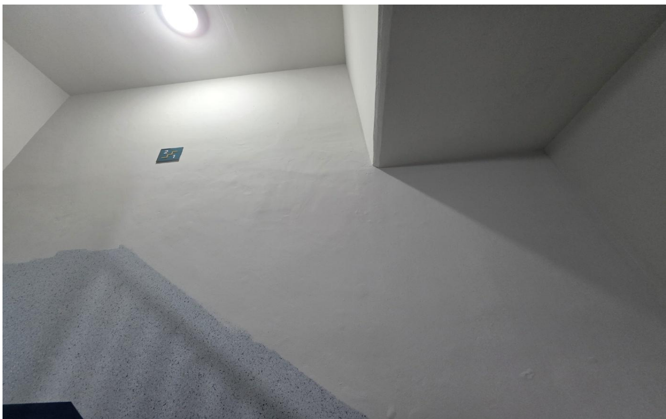
공사 중 (내부 : 수성페인트 도장)
