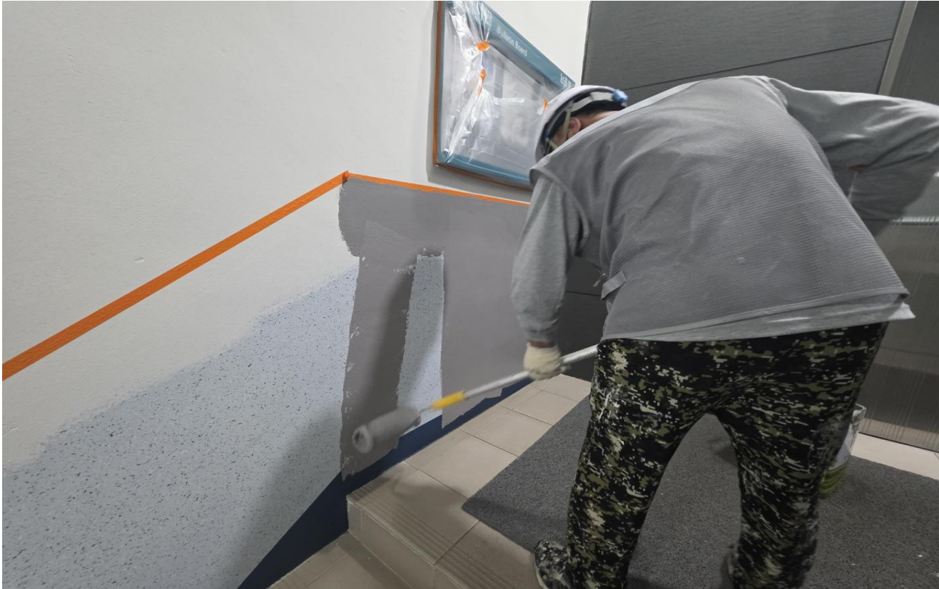
공사 중 (내부 : 수성페인트 도장)
