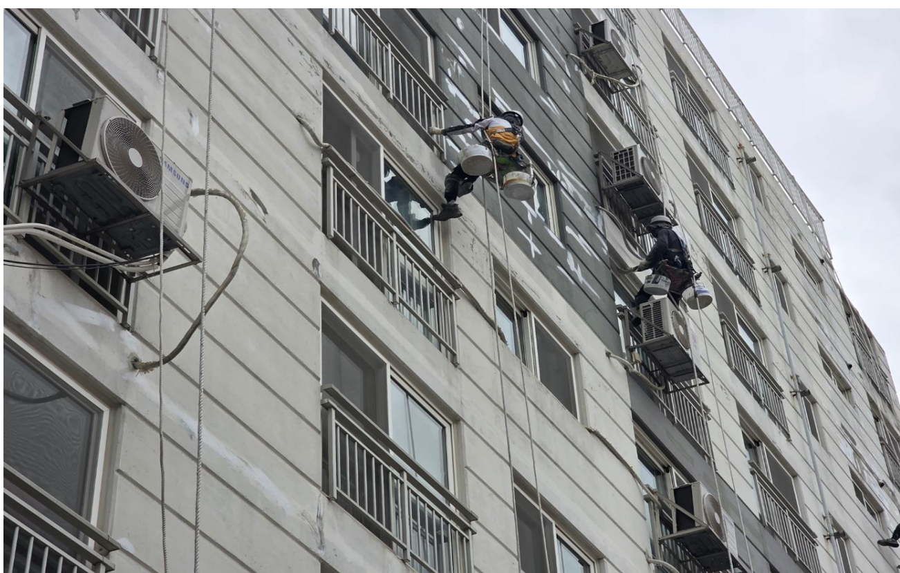
공사 중 (외부 : 균열보수)
