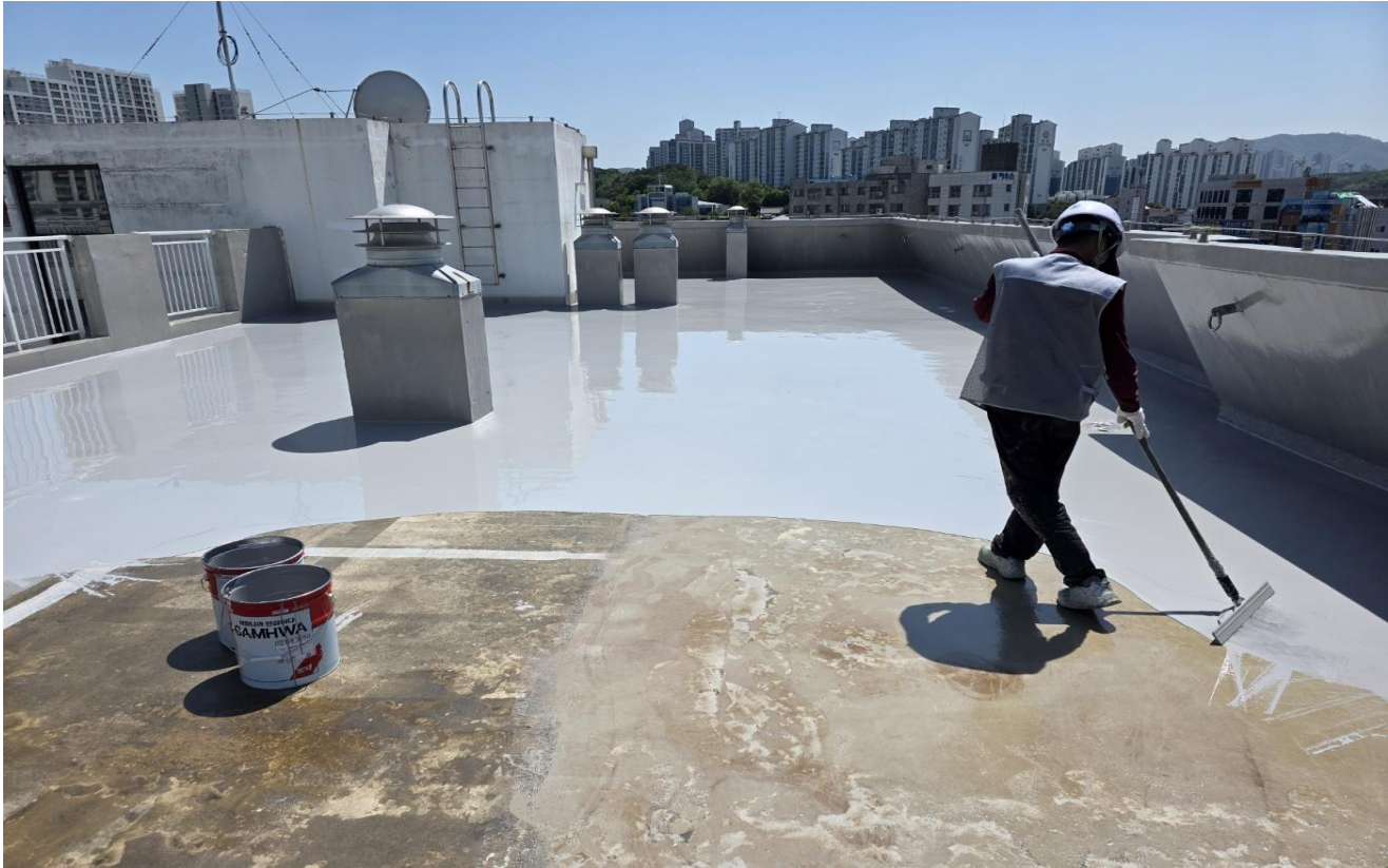
공사 중 (옥상 : 우레탄 중도 1차)
