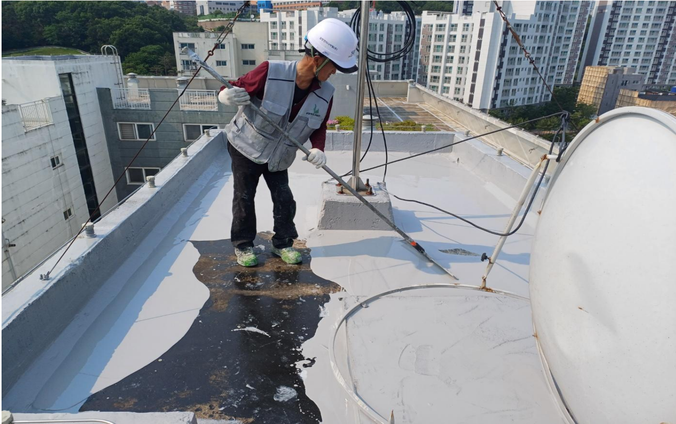
공사 중 (옥상 : 우레탄 중도 1차)
