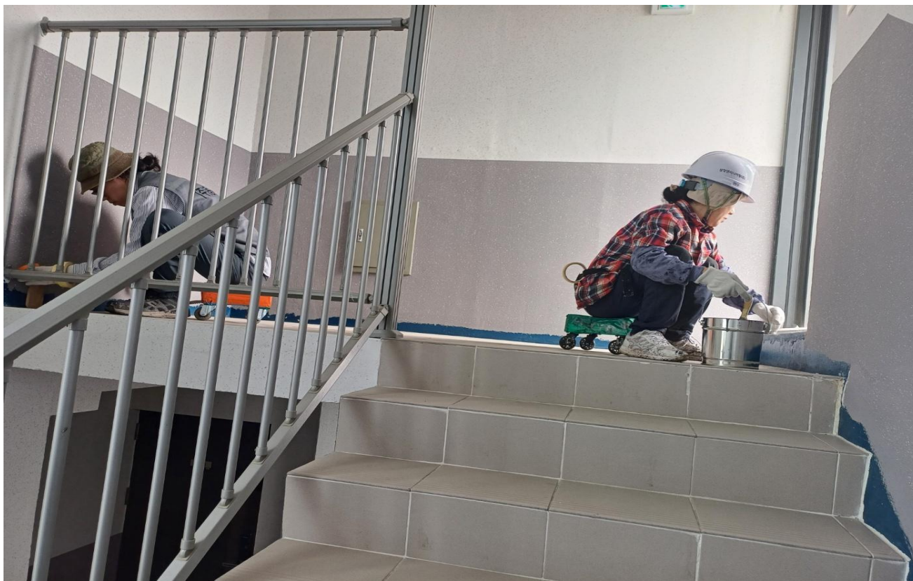
공사 중 (내부 : 걸레받이 도장)
