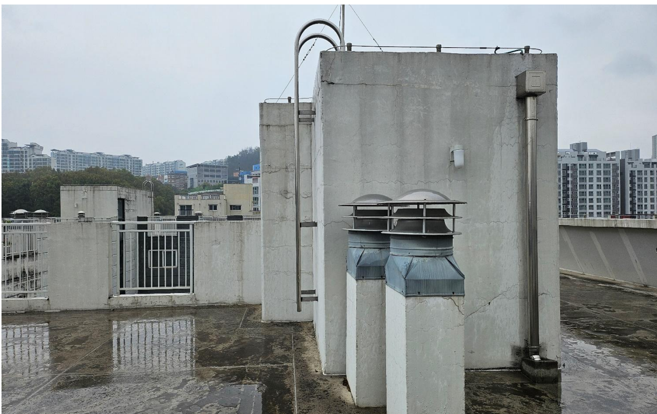
공사 전 (외부)
