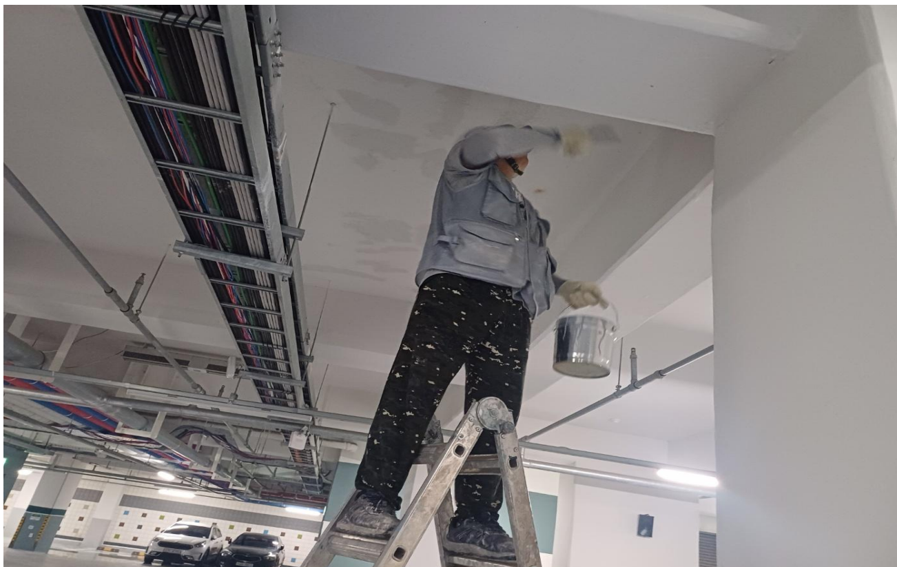
공사 중 (지하주차장 : 수성페인트 도장)
