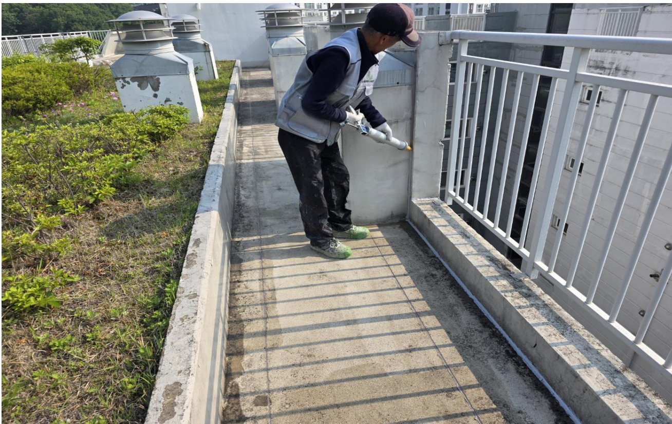
공사 중 (옥상 : 우레탄 실란트 도포)
