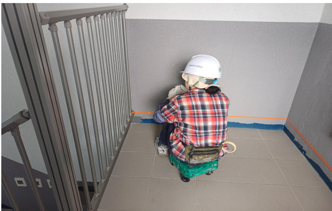
공사 중 (내부 : 걸레받이 도장)
