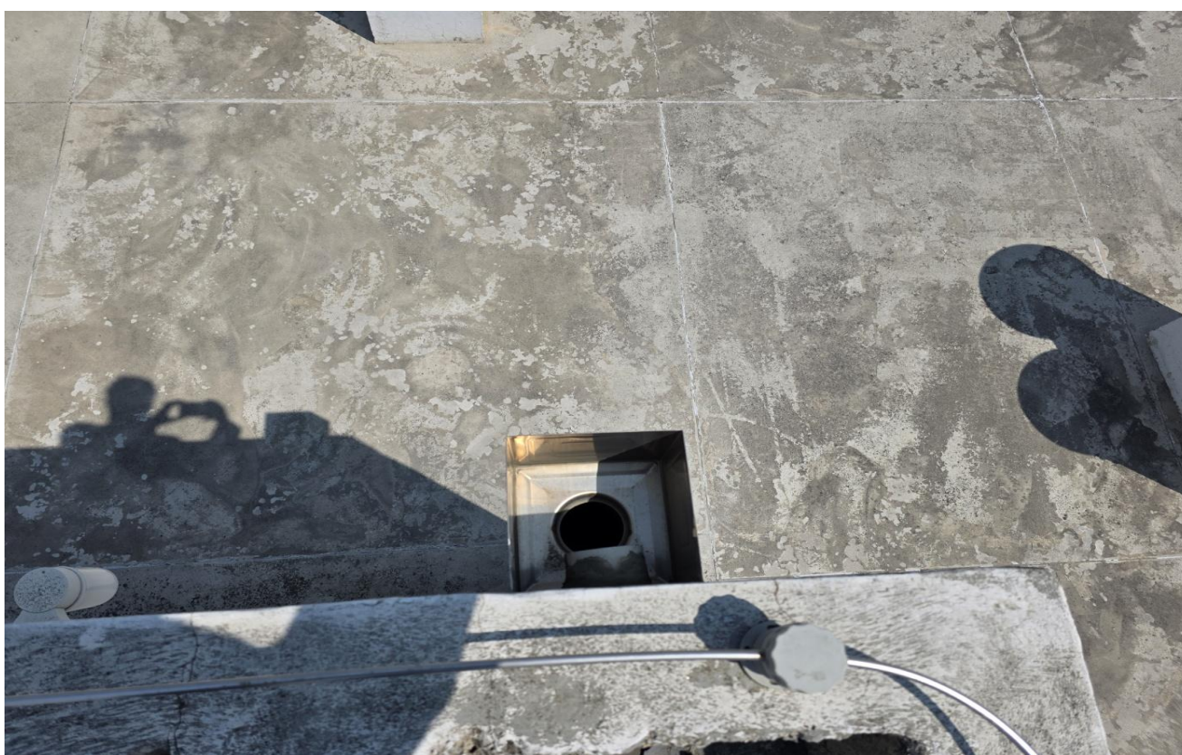
공사 전 (옥상)
