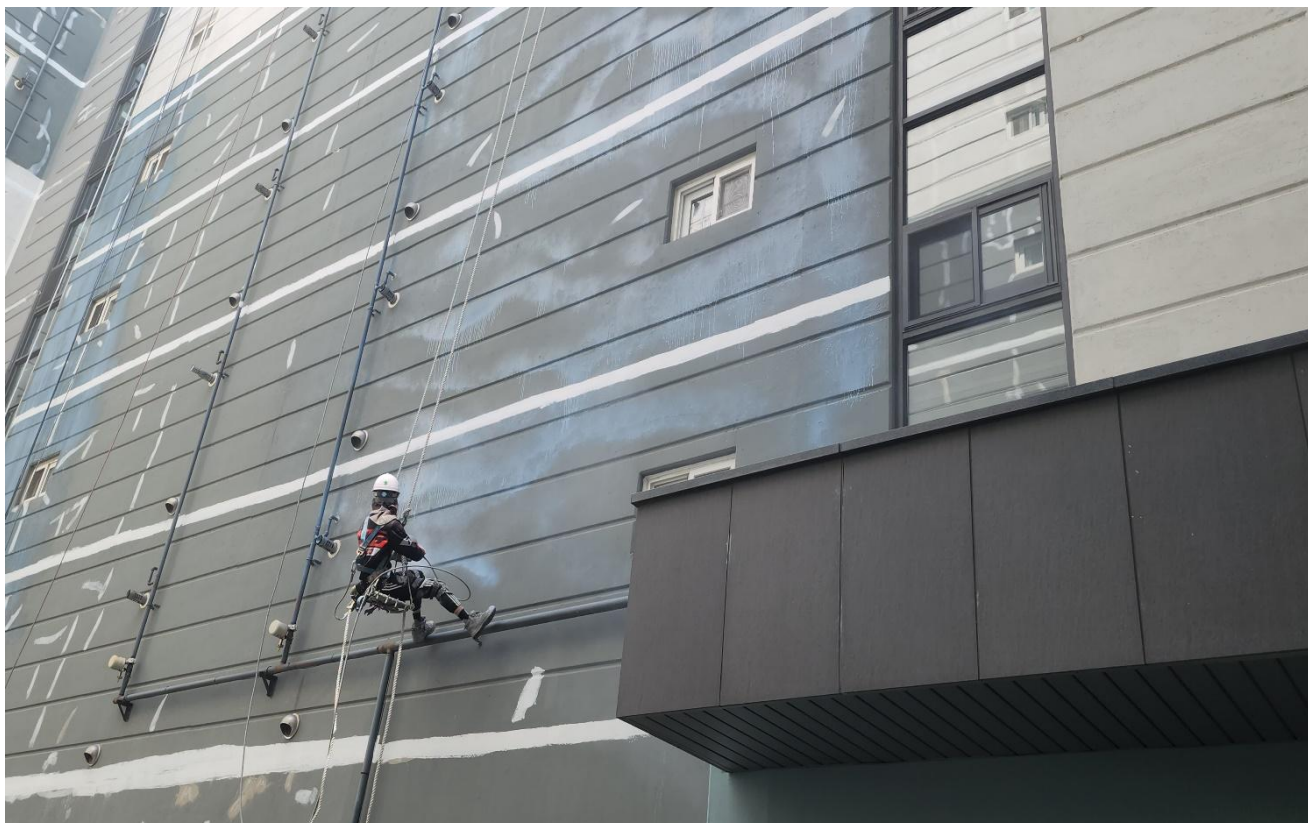
공사 중 (외부 : 바인다 도포)
