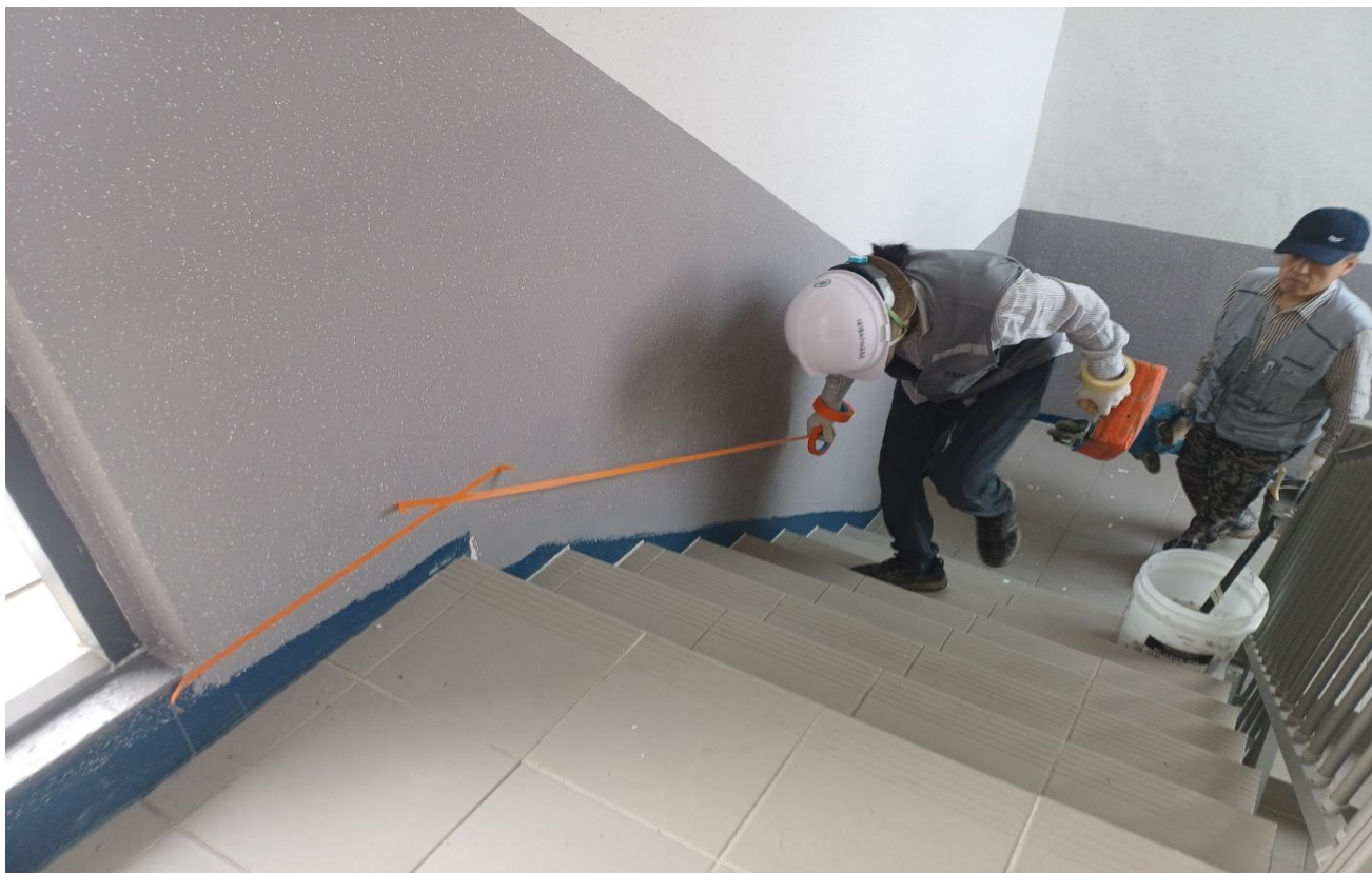
공사 중 (내부 : 걸레받이 도장)
