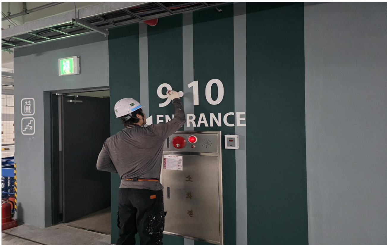
공사 중 (지하주차장 : 그래픽 도장)
