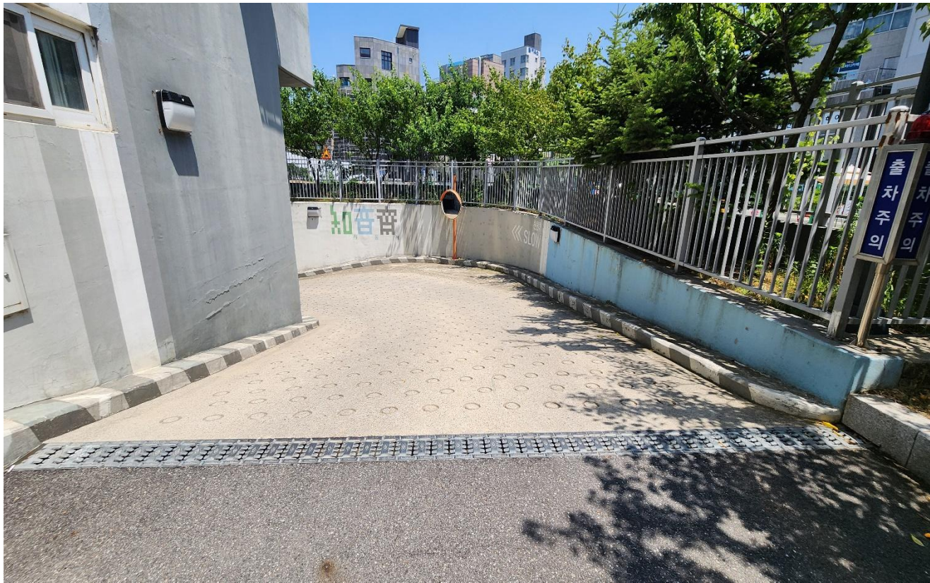
공사 전 (부대시설)
