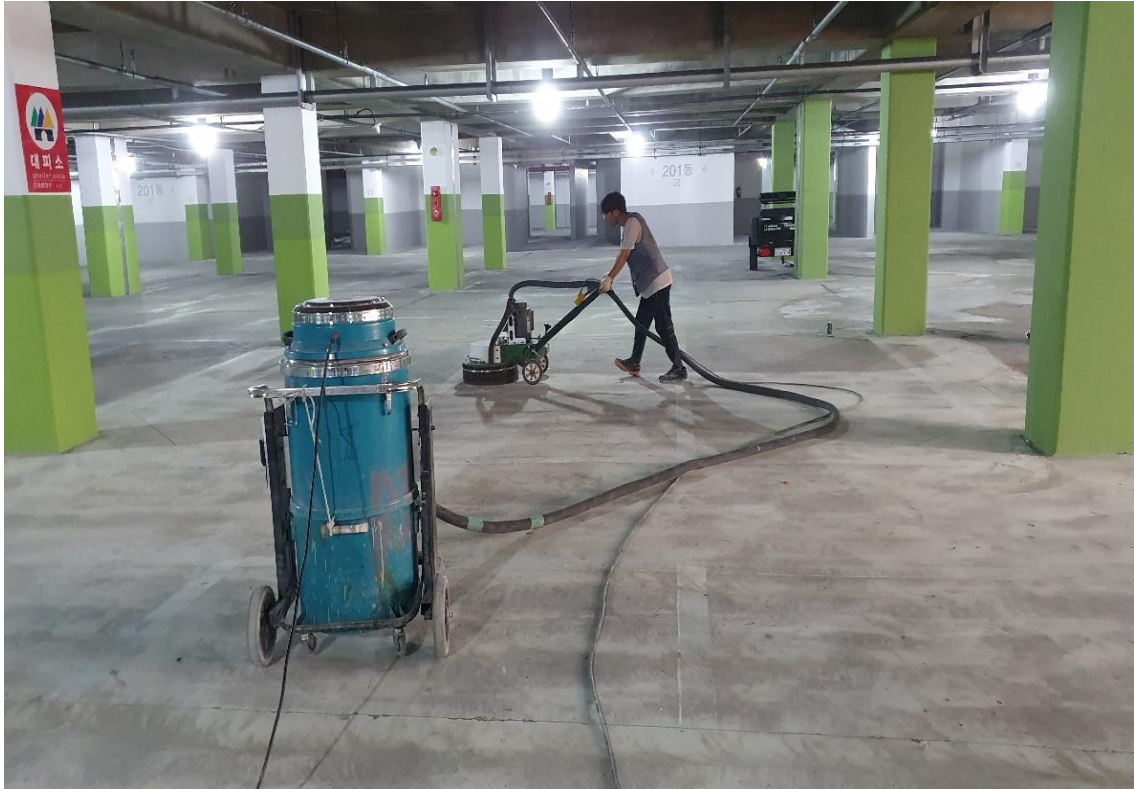
바닥 먼처리 작업중
