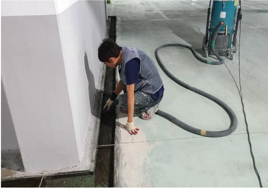
배수로 청소 작업중
