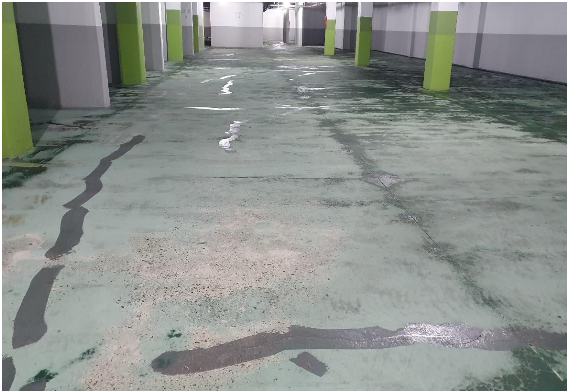
바닥 균열보수 작업중
