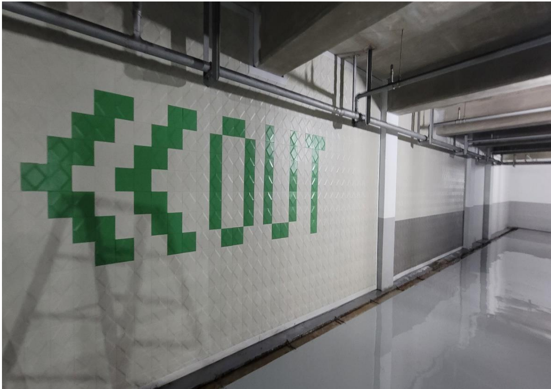
벽체 배수판 설치 마감후
