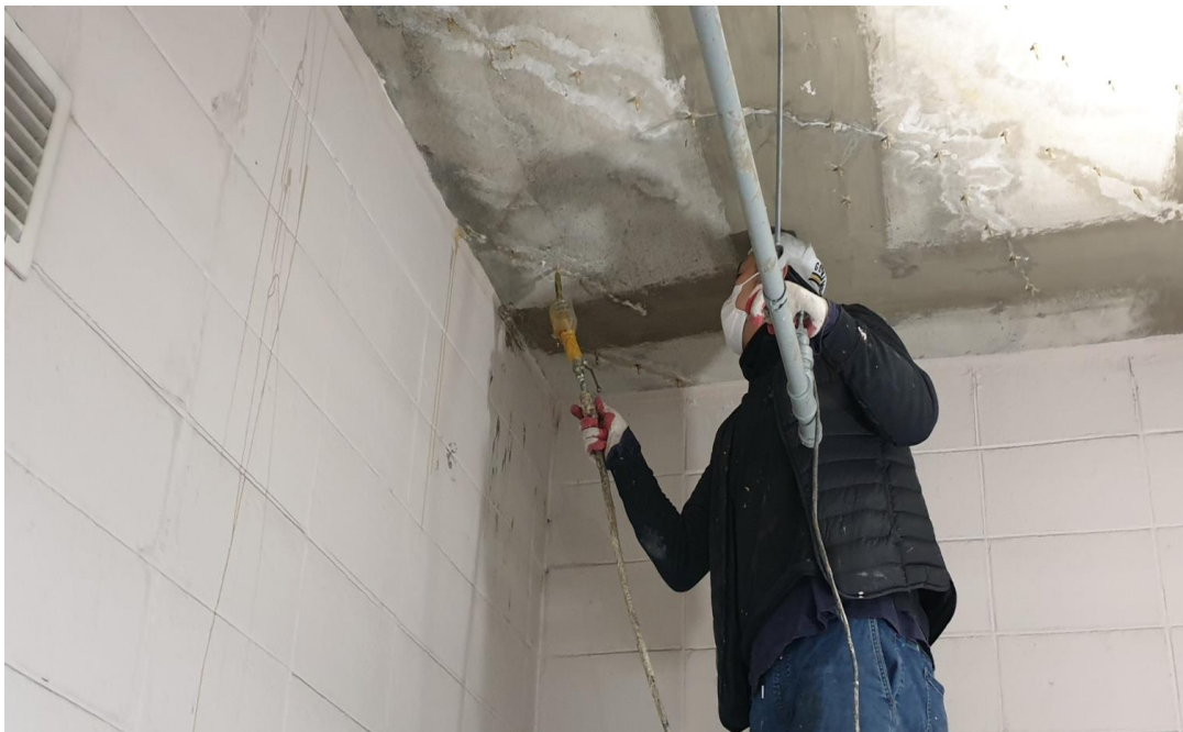
지하2층 인젝션 주입공사
