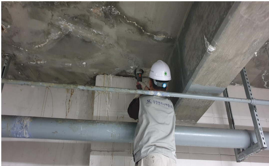
지하주차장 트렌치부위 액체방수 및 배관보수
