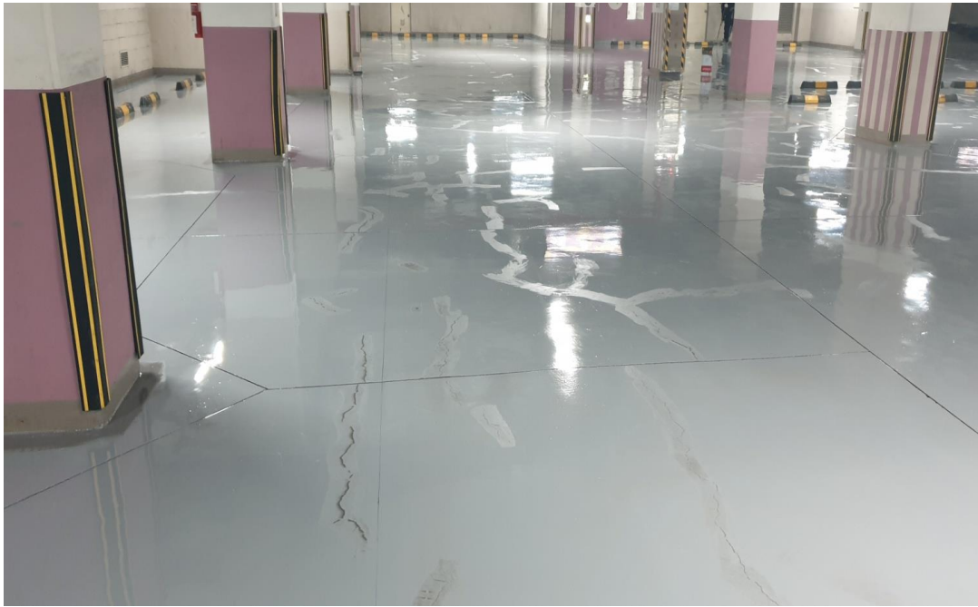
무용제 도포후 균열보수
