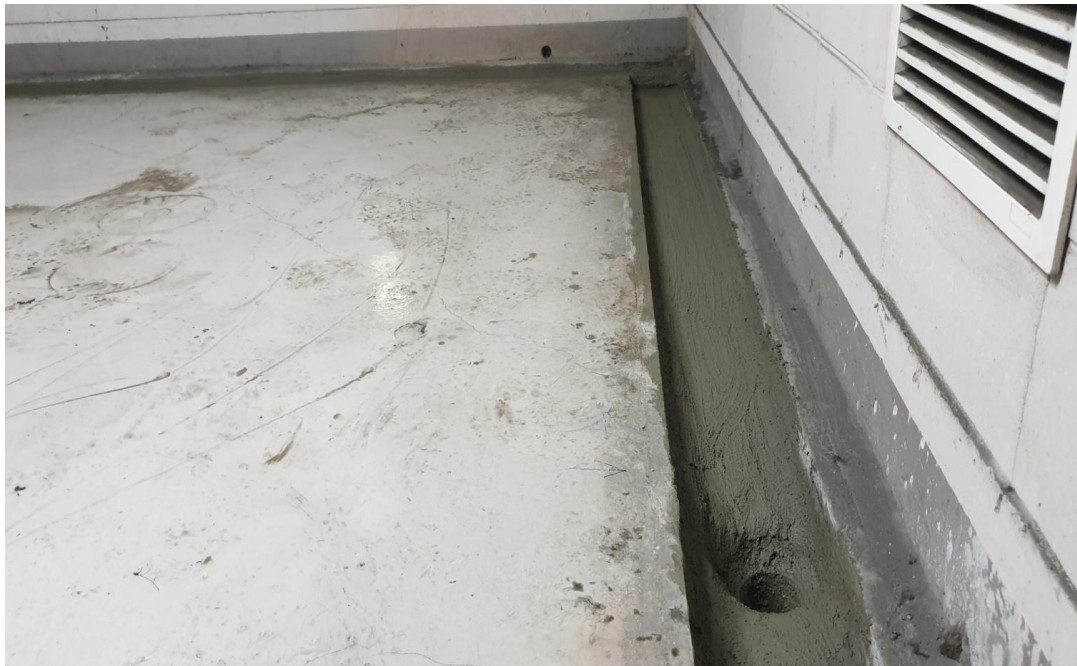
지하주차장 트렌치부위 액체방수 및 배관보수
