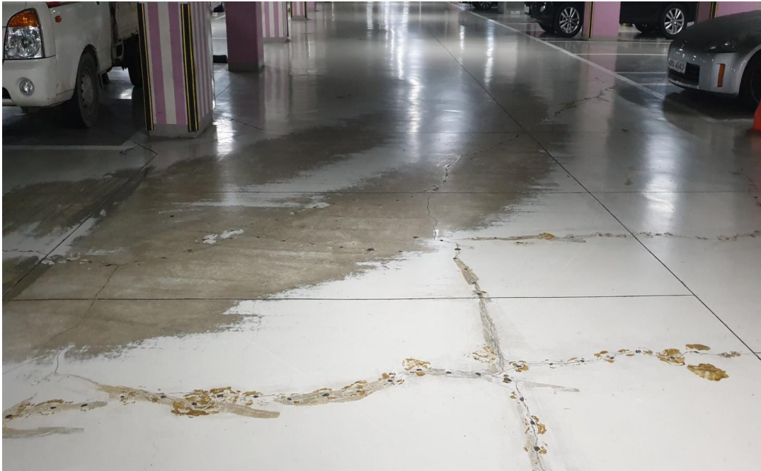
공사전 기존 지하주차장
