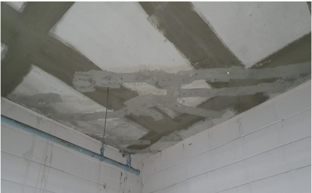
인젝션주입 완료 후
