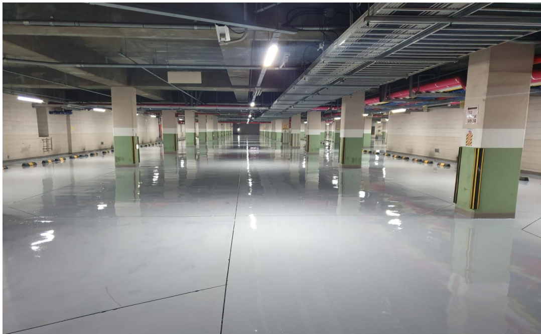
주차장 바닥 전체 무용제 도포
