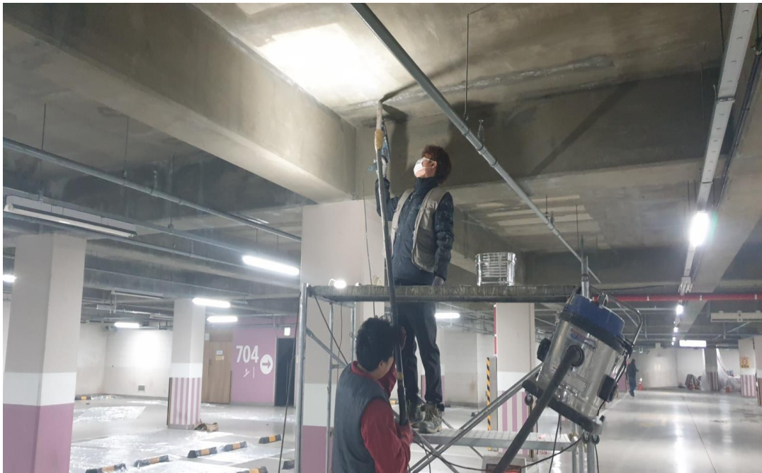
지하2층 인젝션 주입공사
