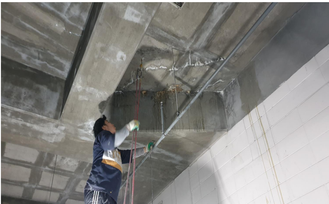
지하1층 아크릴 배면차수 공사
