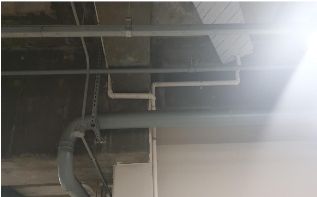
유도배수판 설치 후
