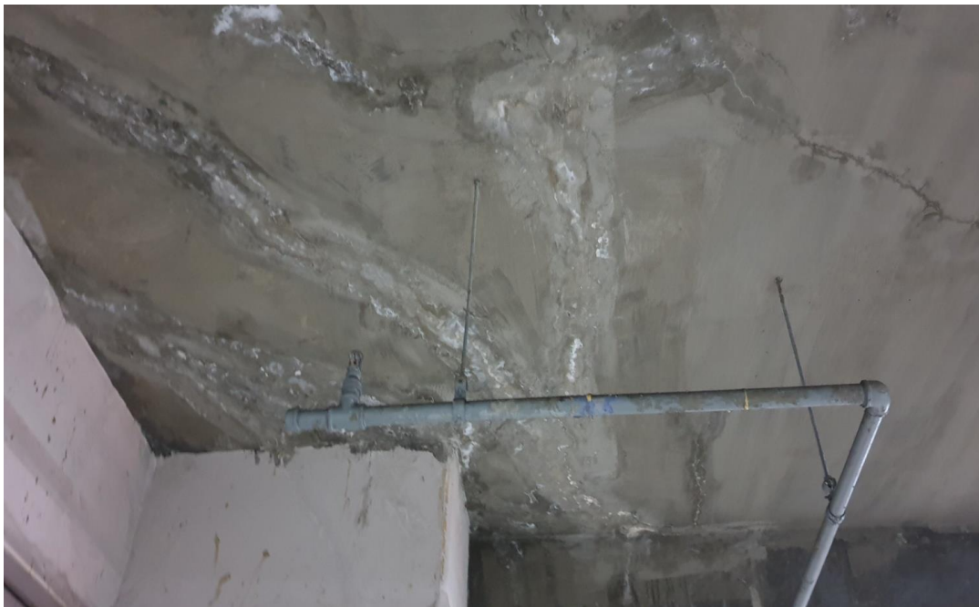
공사전 기존 지하주차장 천장
