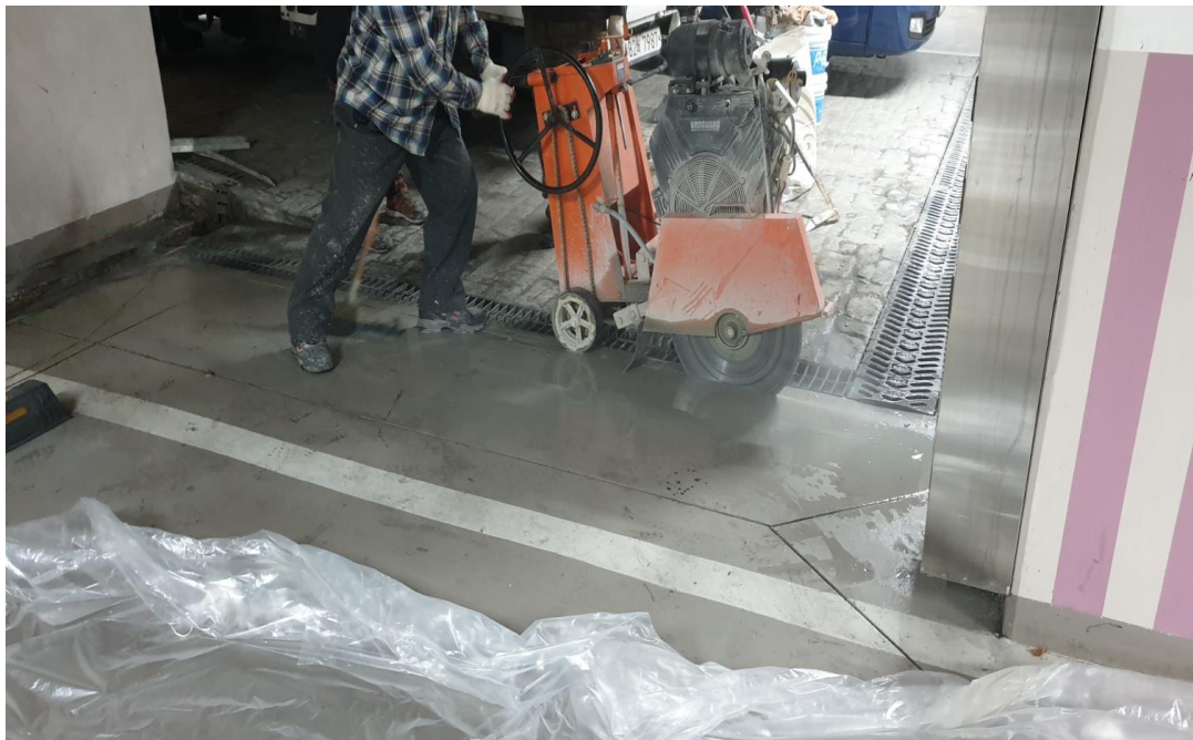
지하2층 트렌치 차수공법 시공
