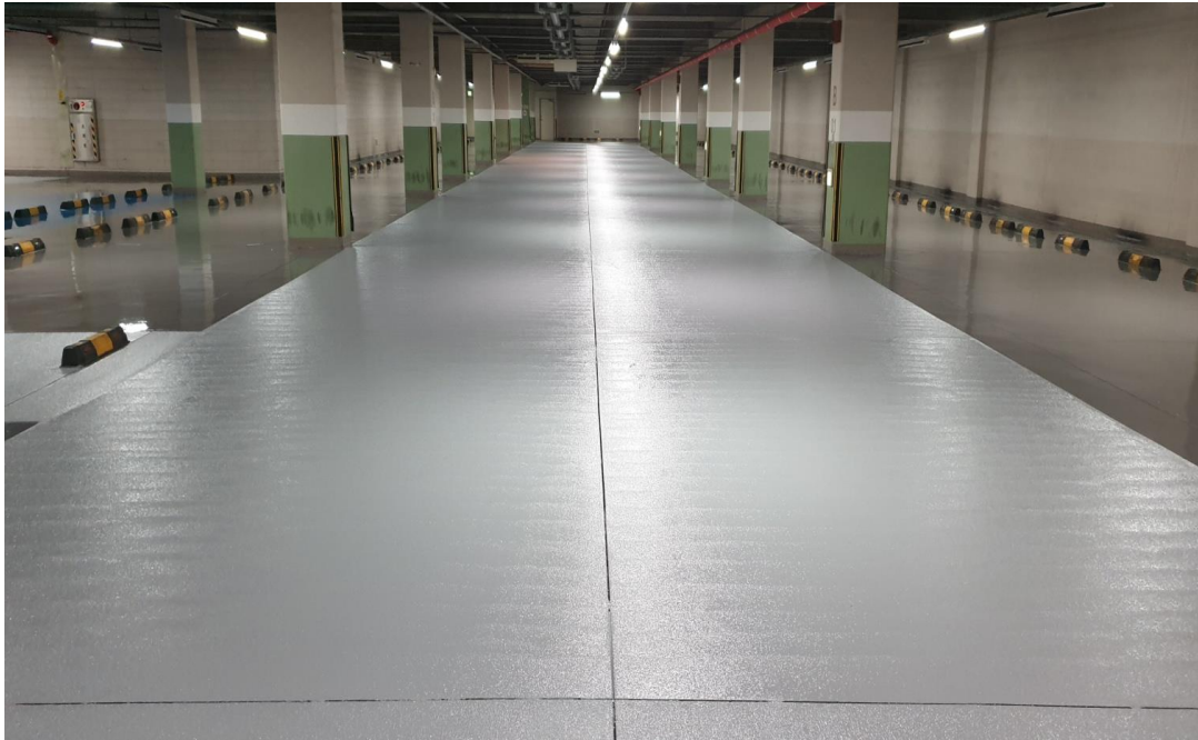
지하주차장 에폭시 도장공사 완료 후
