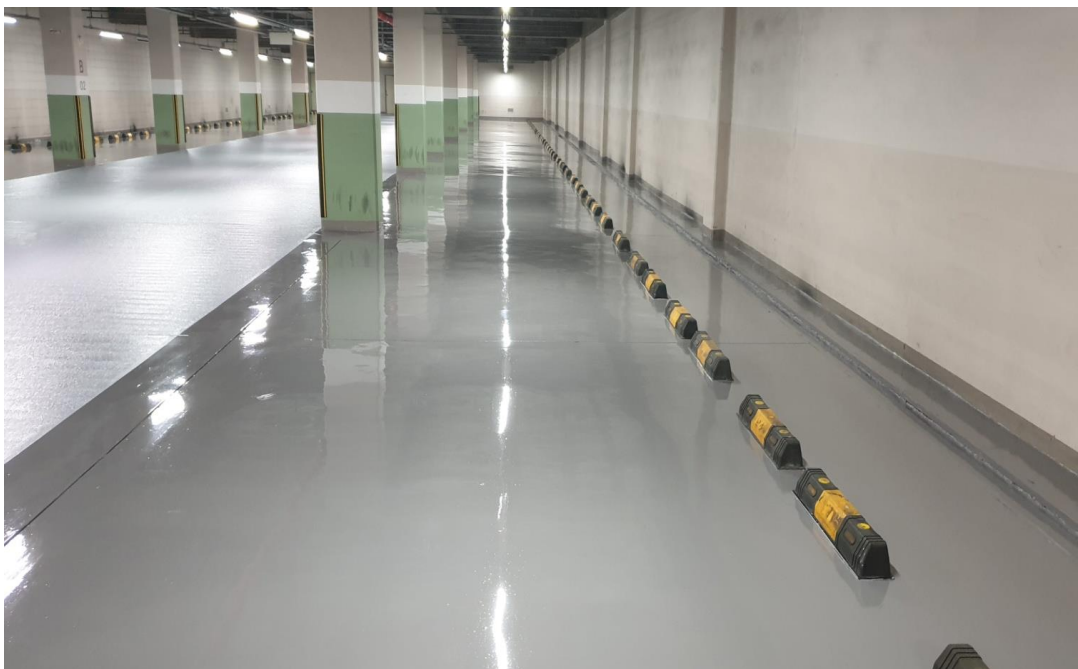
지하주차장 에폭시 도장공사 완료 후
