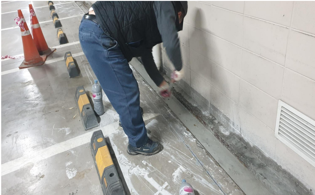
지하2층 트렌치 차수공법 시공
