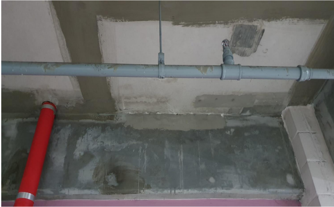
인젝션주입 완료 후
