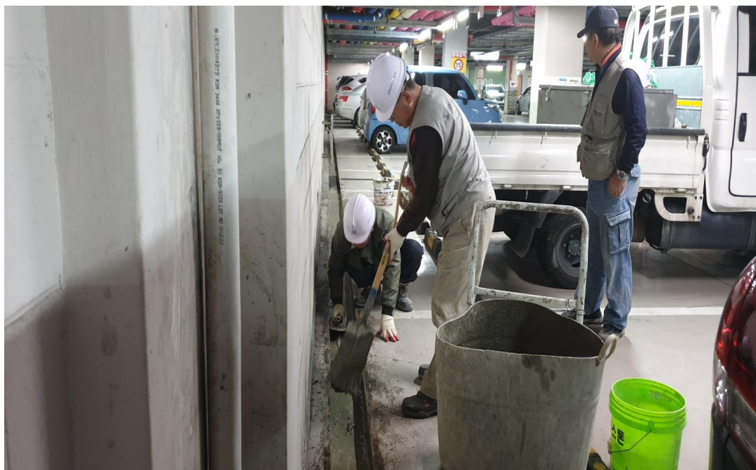
지하주차장 트렌치부위 액체방수 및 배관보수
