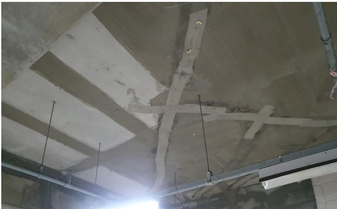
인젝션주입 완료 후
