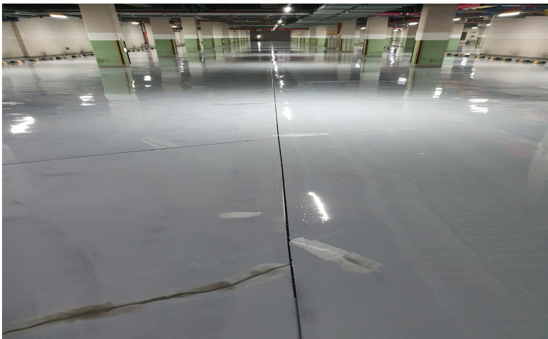
무용제 도포후 균열보수
