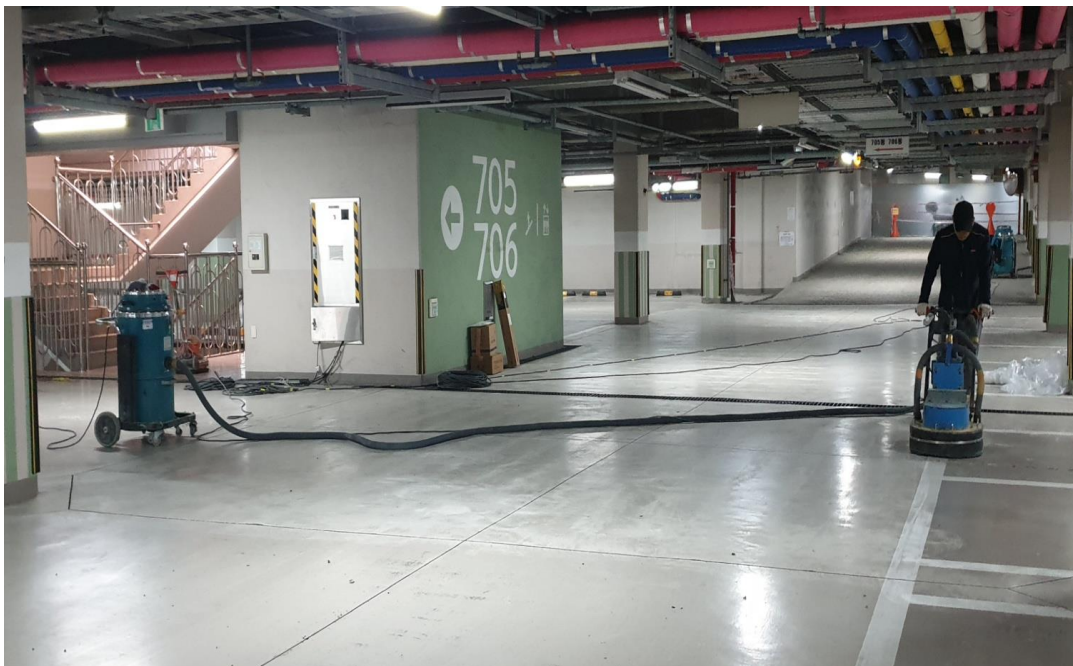
지하주차장 바닥 바탕정리(표면처리)
