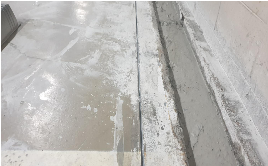
지하2층 트렌치 차수공법 시공
