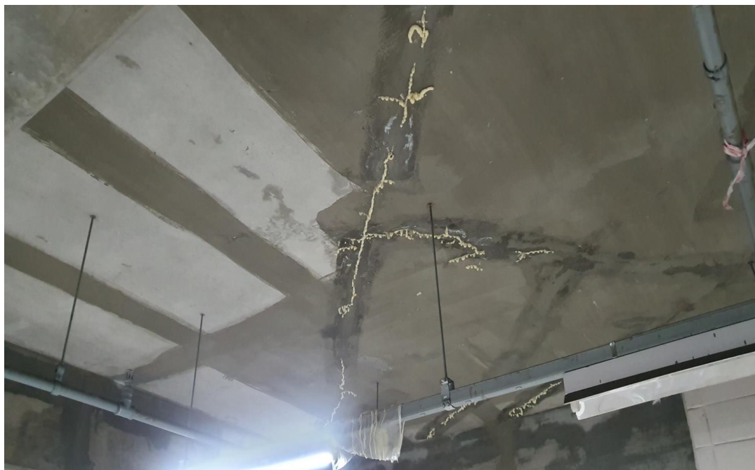
인젝션주입 공사 중
