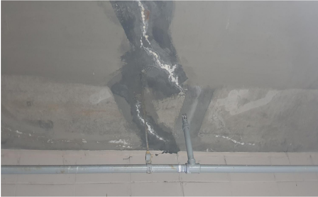
공사전 기존 지하주차장 천장
