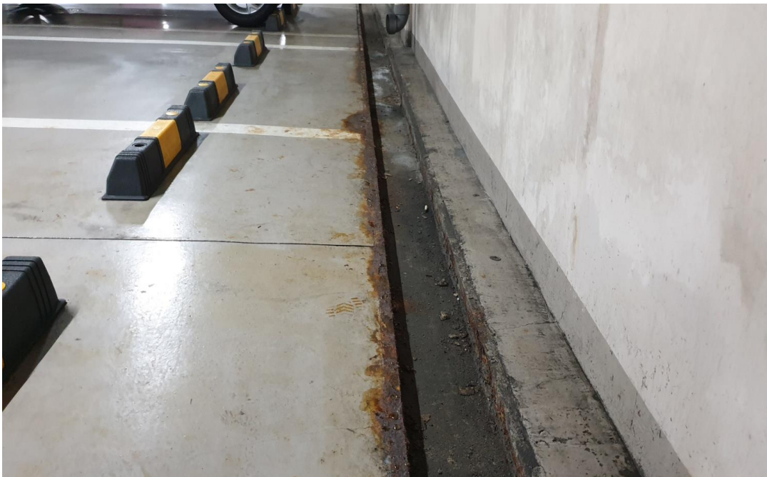
공사전 기존 지하주차장
