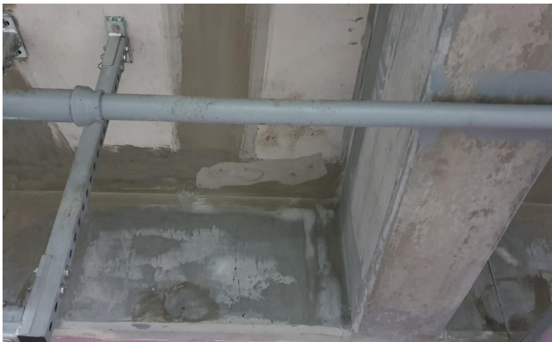
인젝션주입 완료 후
