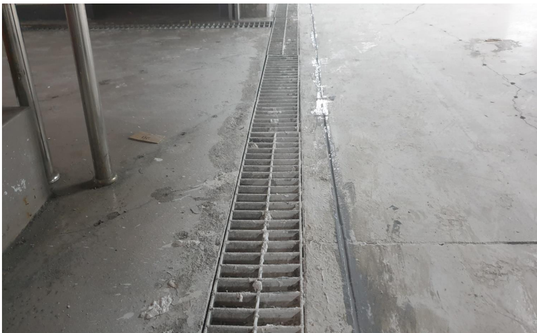
지하2층 트렌치 차수공법 시공
