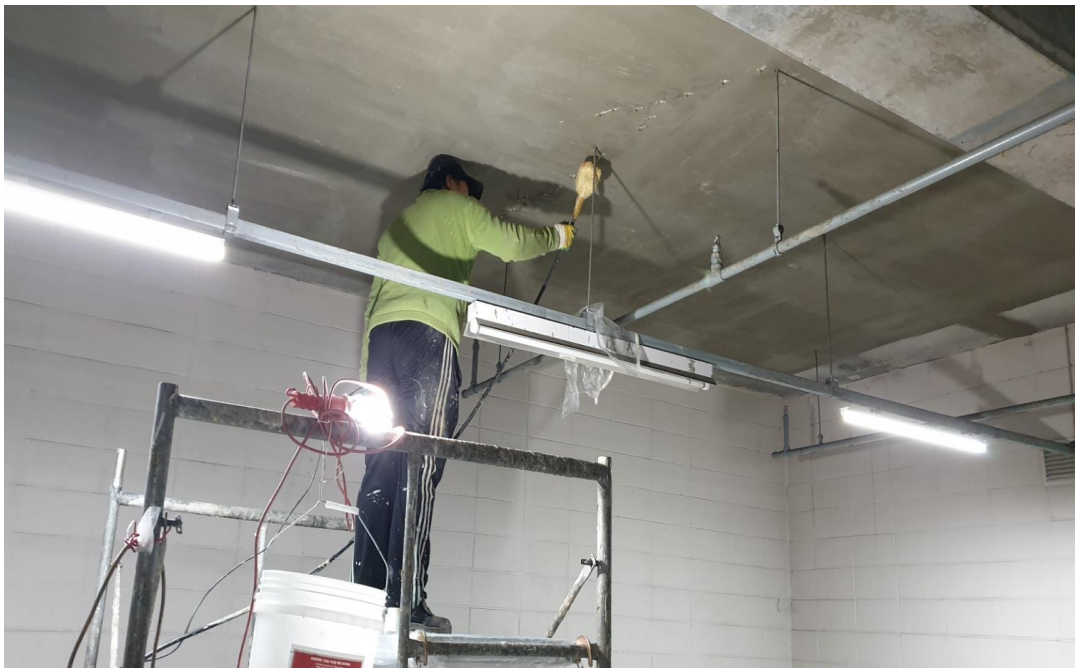
지하2층 인젝션 주입공사
