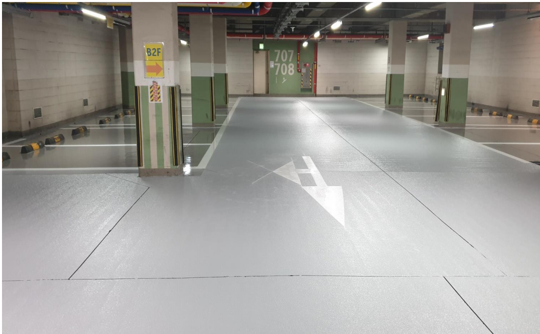
지하주차장 에폭시 도장 완료 후
