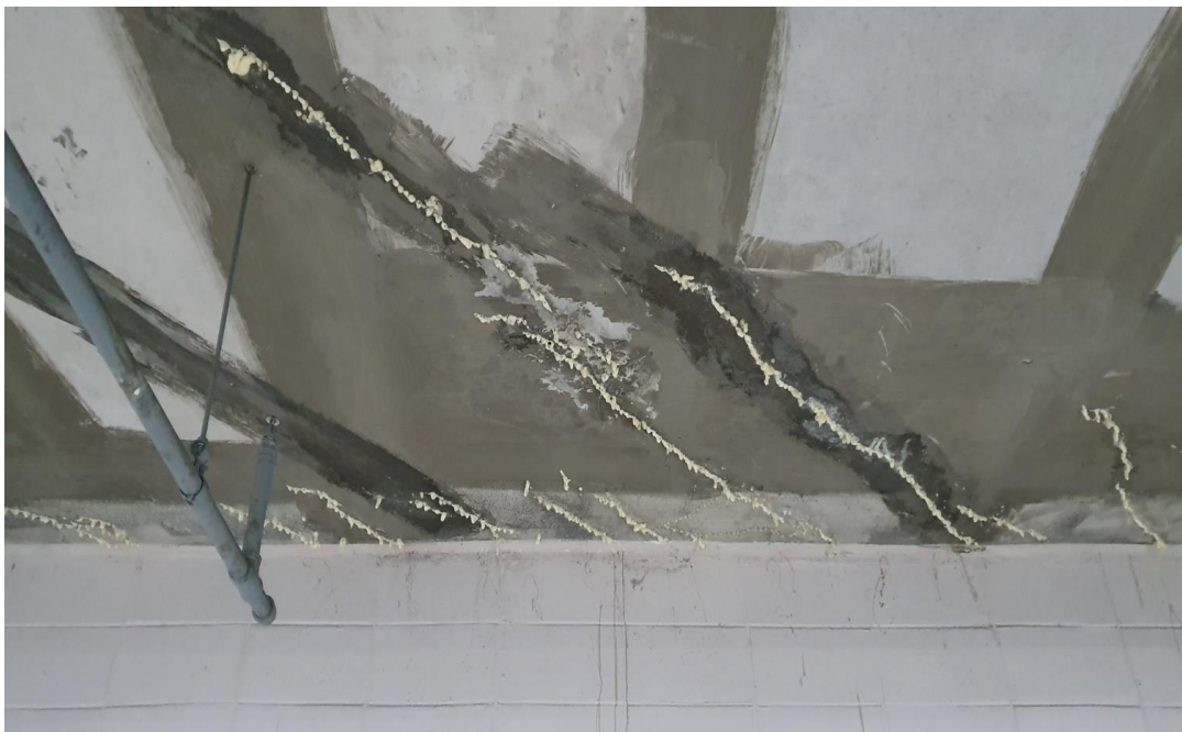
인젝션주입 공사 중
