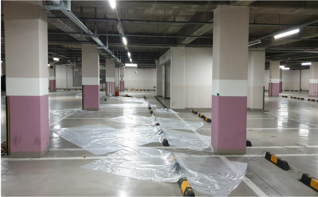
인젝션주입 공사 중
