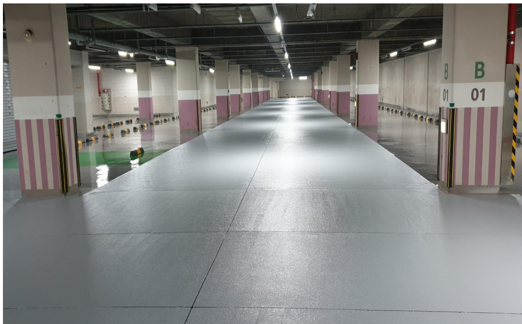
지하주차장 에폭시 도장공사 완료 후
