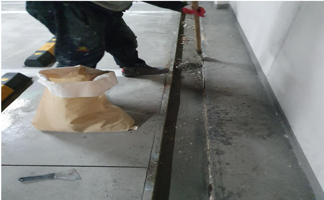
지하주차장 바닥 바탕정리(표면처리)
