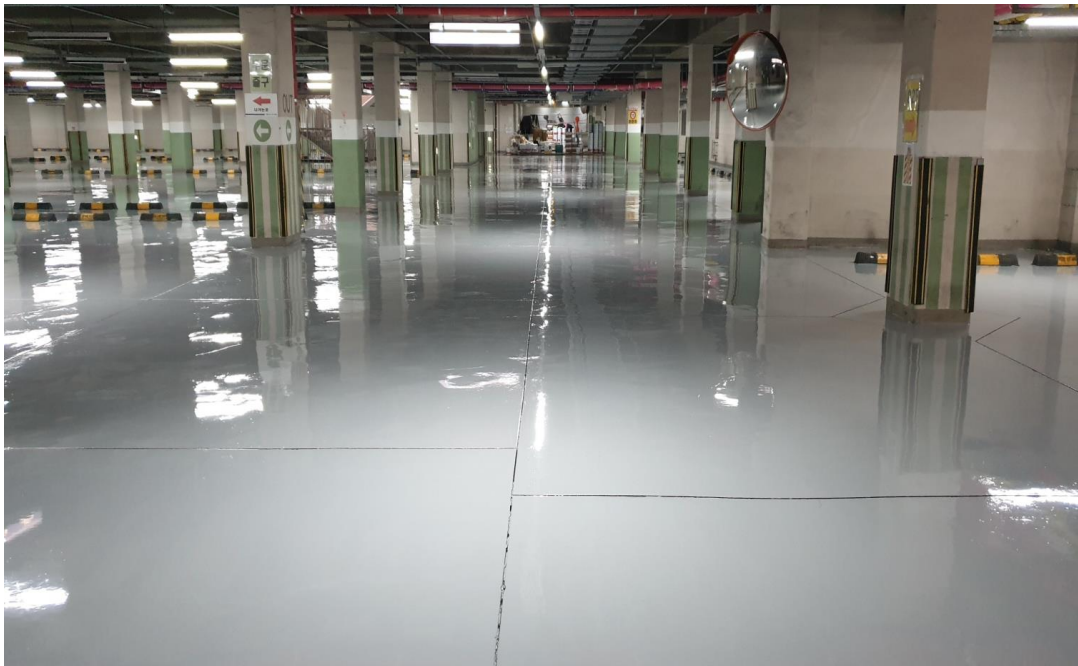
주차장 바닥 전체 무용제 도포
