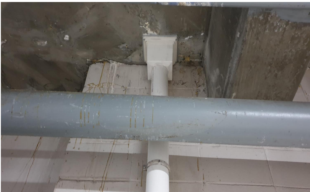
지하주차장 트렌치부위 액체방수 및 배관보수
