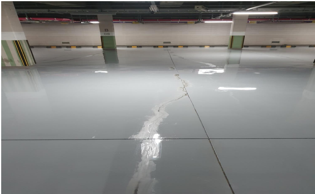
무용제 도포후 균열보수
