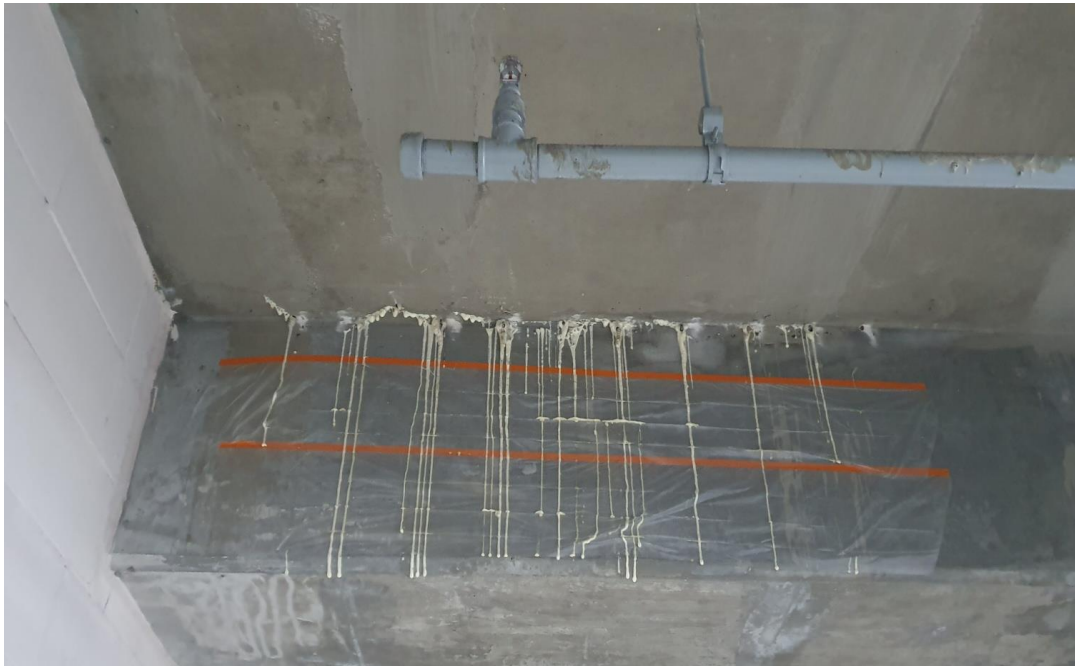
인젝션주입 공사 중
