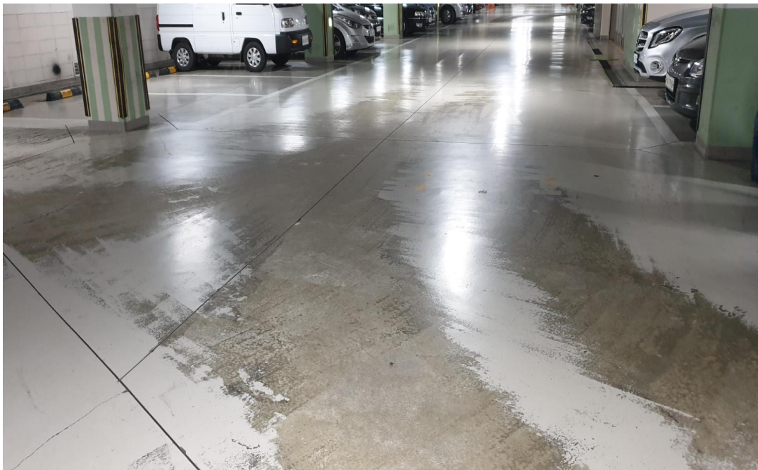
공사전 기존 지하주차장
