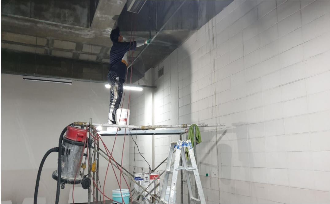
지하1층 아크릴 배면차수 공사
