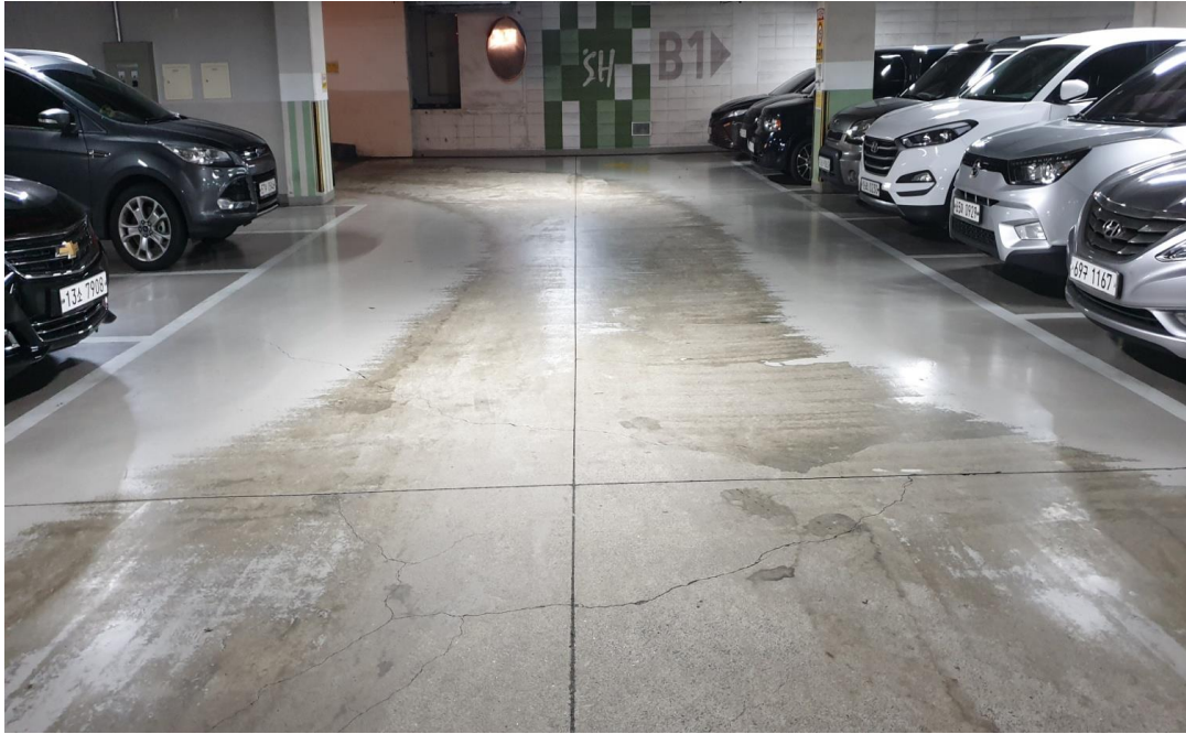
공사전 기존 지하주차장
