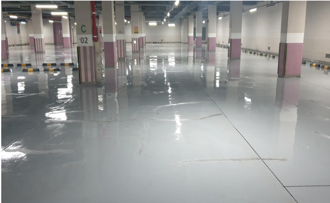
무용제 도포후 균열보수
