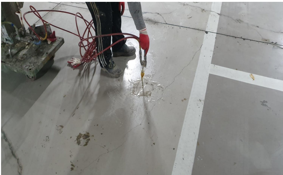
바닥주입 공사 중
