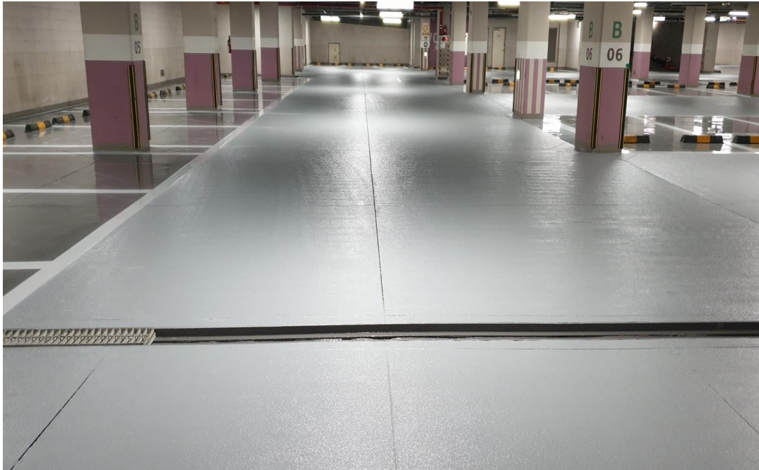
지하주차장 에폭시 도장 완료 후
