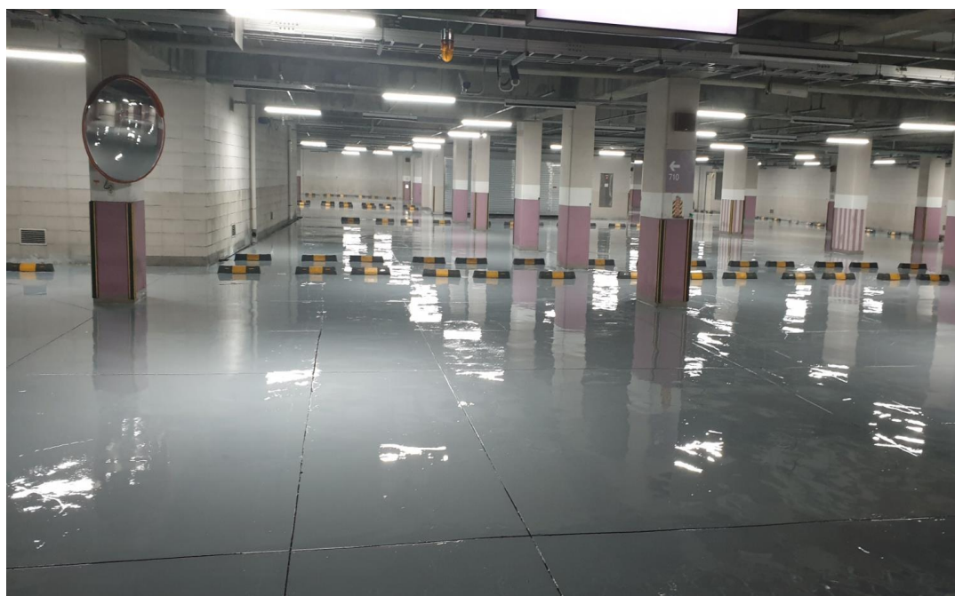
주차장 바닥 전체 무용제 도포
