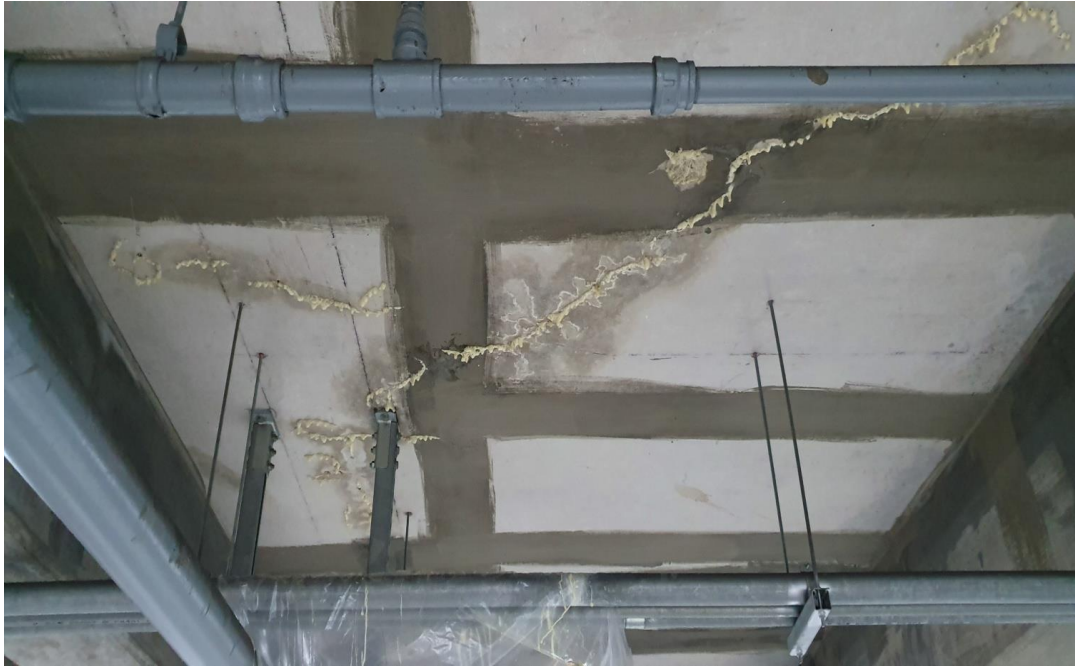
인젝션주입 공사 중
