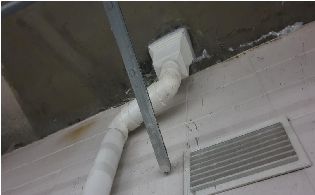
지하주차장 트렌치부위 액체방수 및 배관보수
