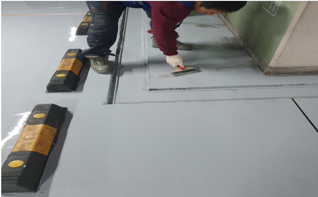
무용제 도포후 균열보수
