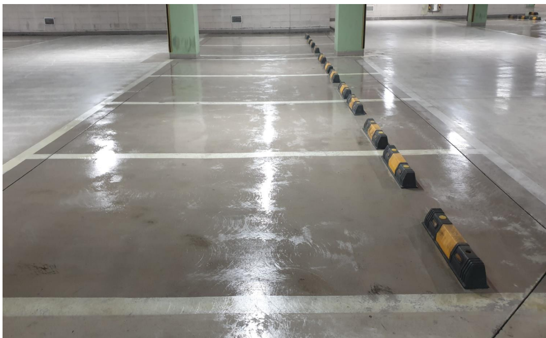
바닥 에폭시하도 도포
