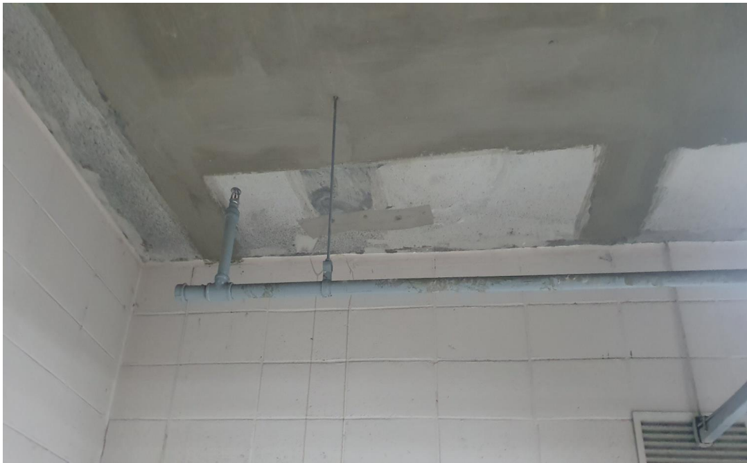
인젝션주입 완료 후
