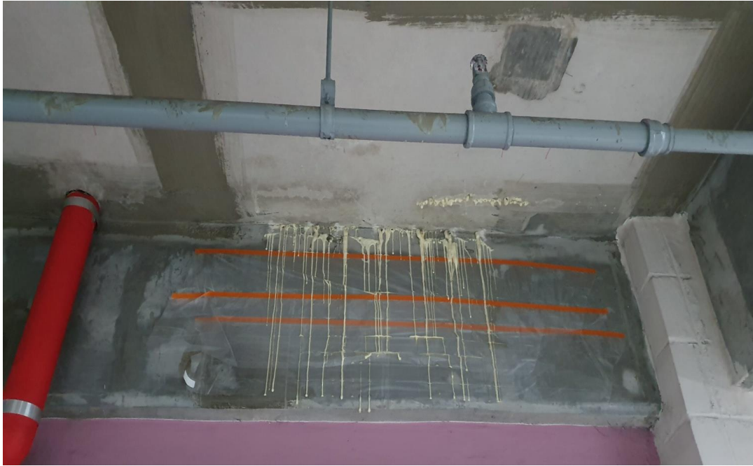
인젝션주입 공사 중
