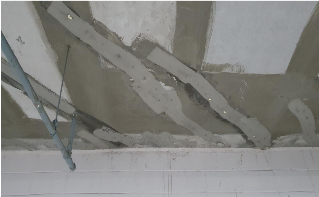
인젝션주입 완료 후
