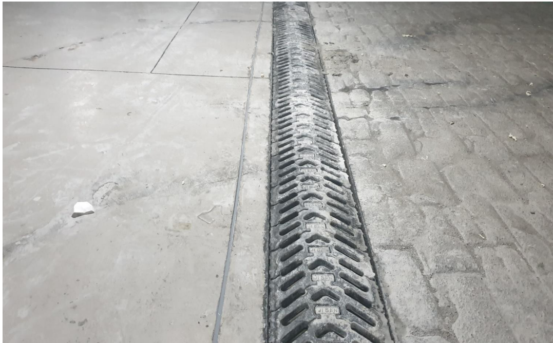
지하2층 트렌치 차수공법 시공
