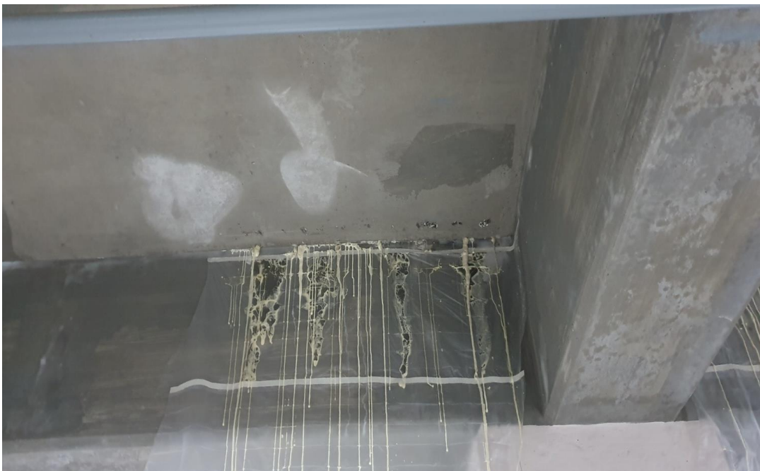
인젝션주입 공사 중
