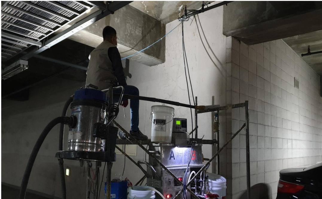
지하1층 아크릴 배면차수 공사
