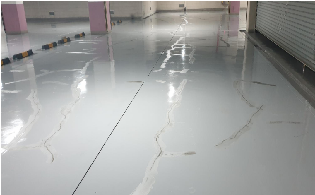
무용제 도포후 균열보수
