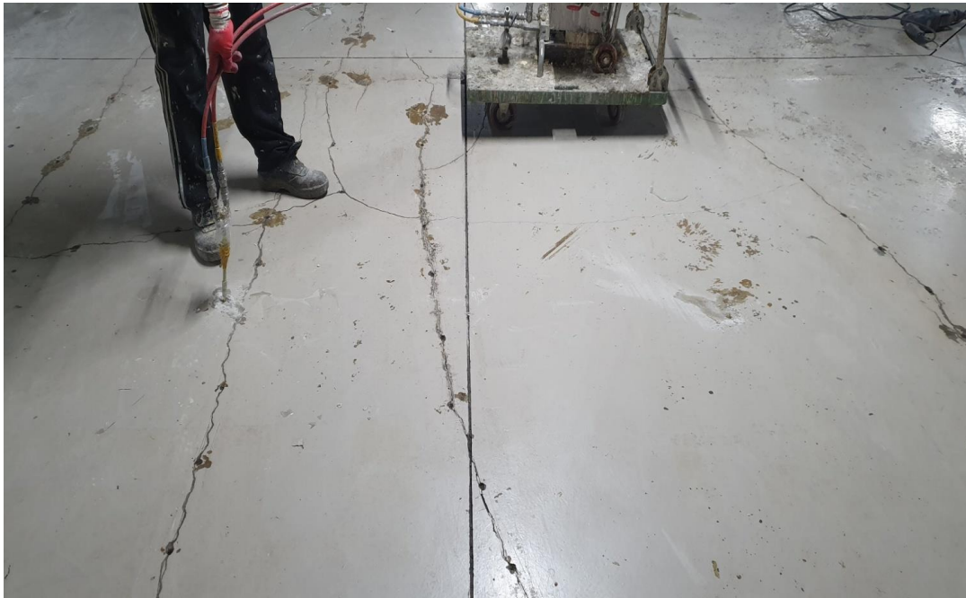
바닥주입 공사 중
