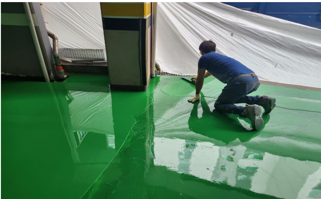
공사 중 (에폭시 중도 2차)
