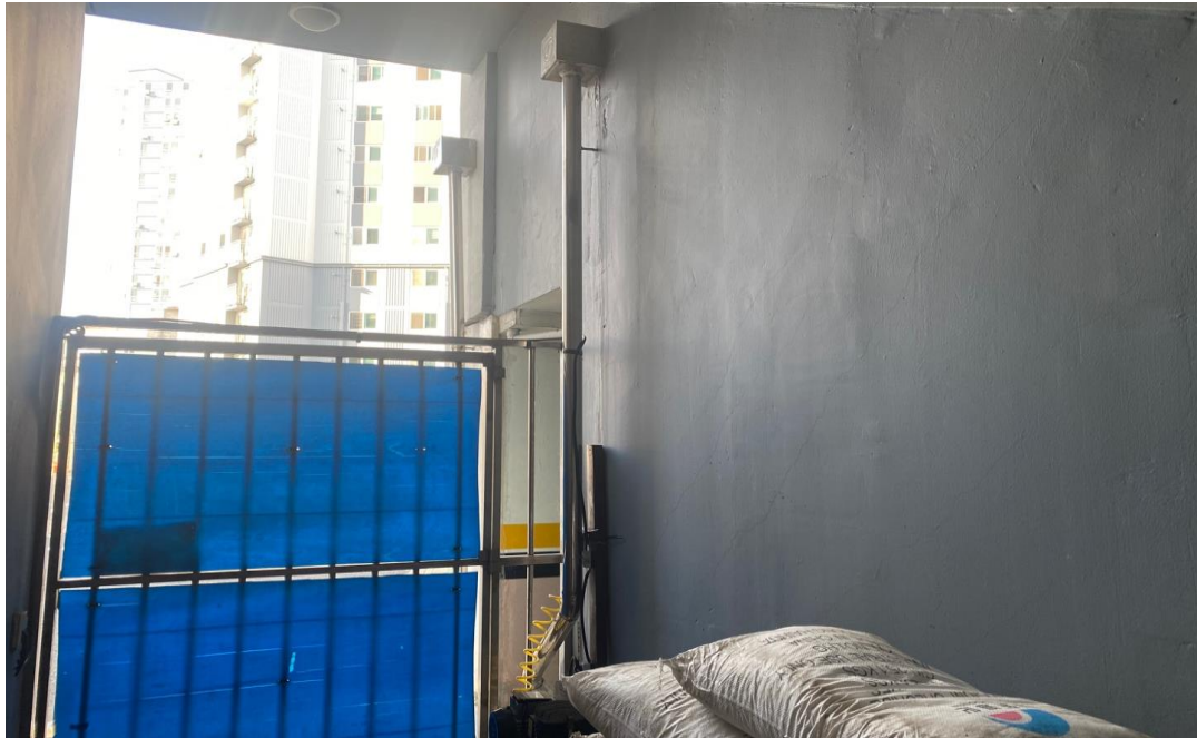
공사 전 (배관작업부위)
