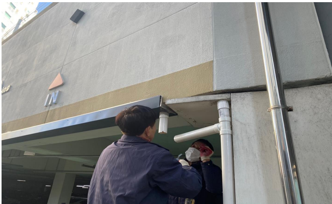
공사 중 (유도처리부위)
