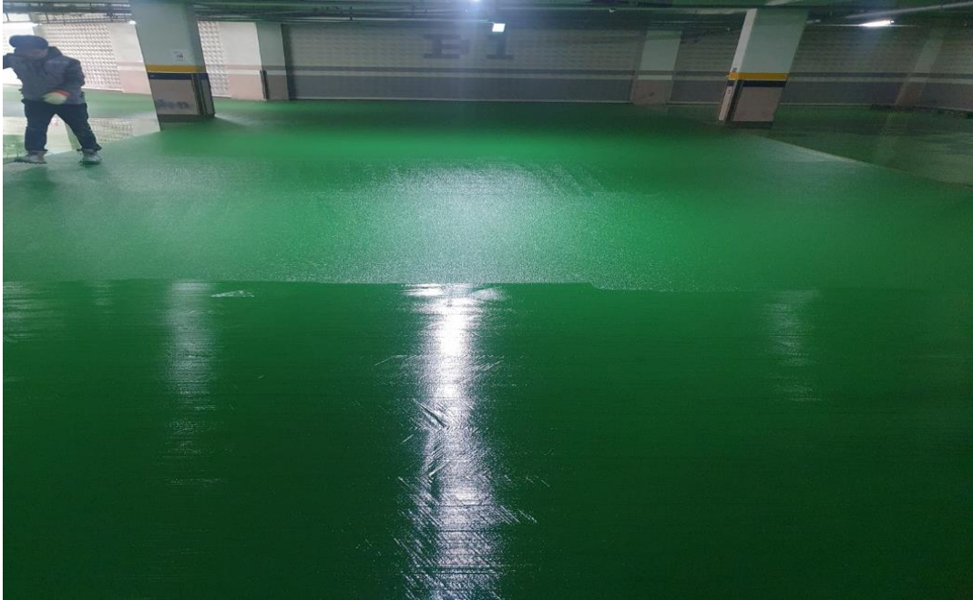
공사 중 (에폭시 엠보)
