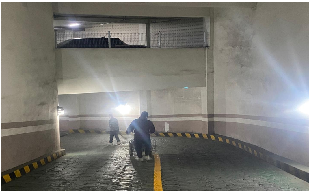
공사 중 (차선 작업)
