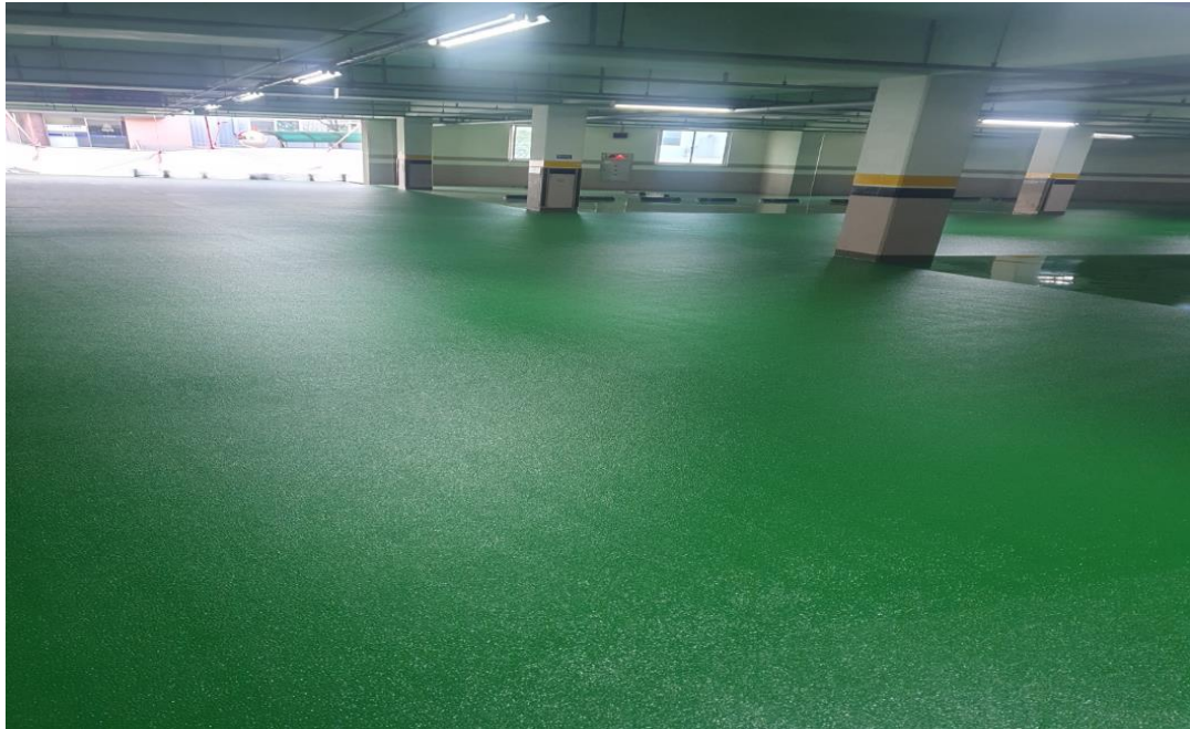
공사 중 (에폭시 엠보)
