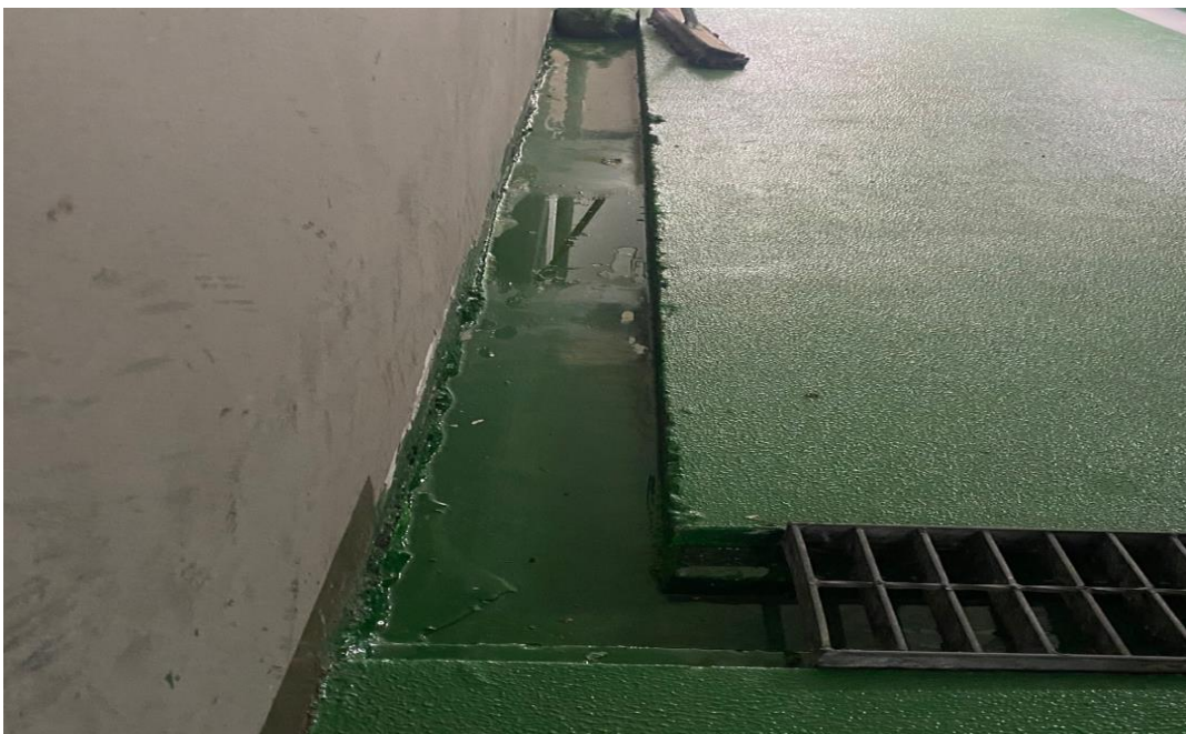
공사 후 (우레탄 시공 공사완료)
