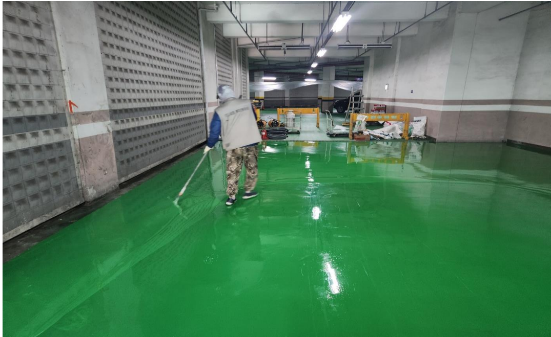
공사 중 (에폭시 중도 2차)
