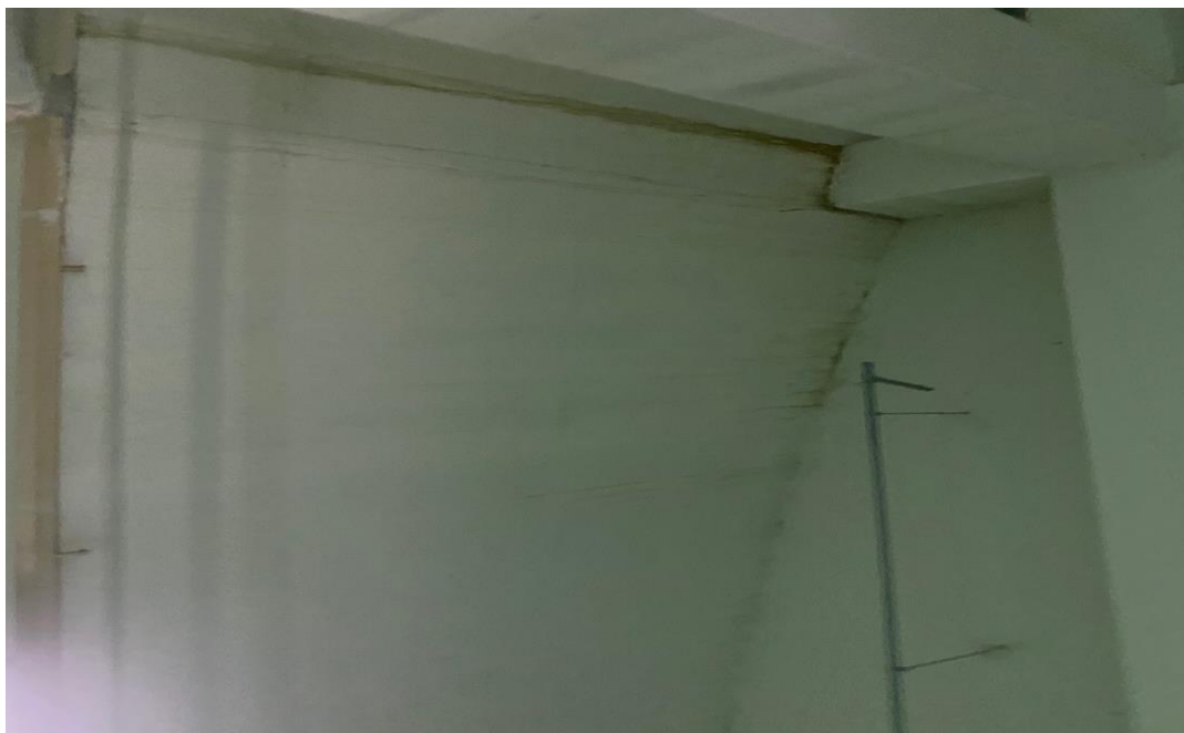
공사 전 (인젝션부위)
