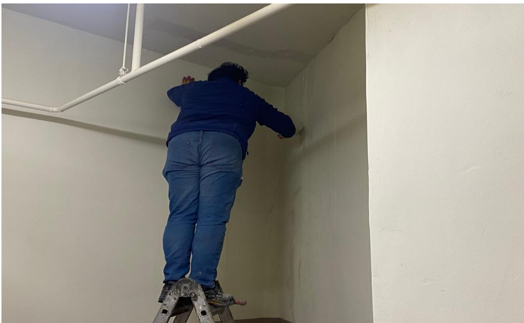
공사 중 (인젝션 주입)
