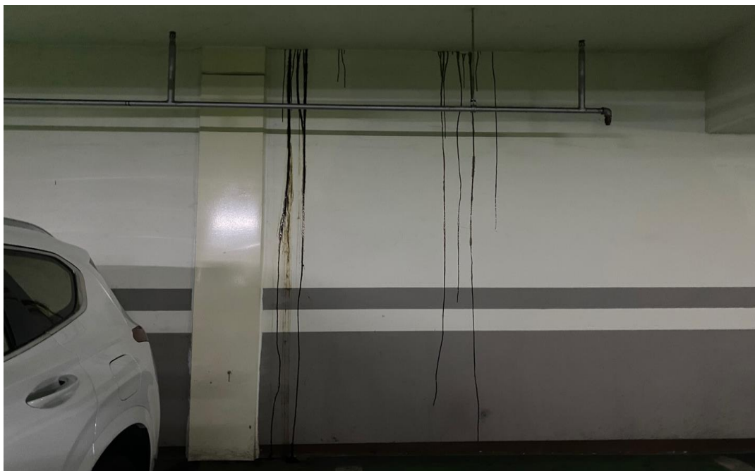
공사 전 (보호판 설치부위)
