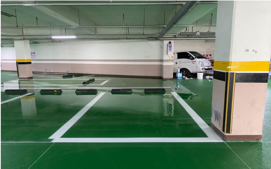
공사 중 (차선 작업)
