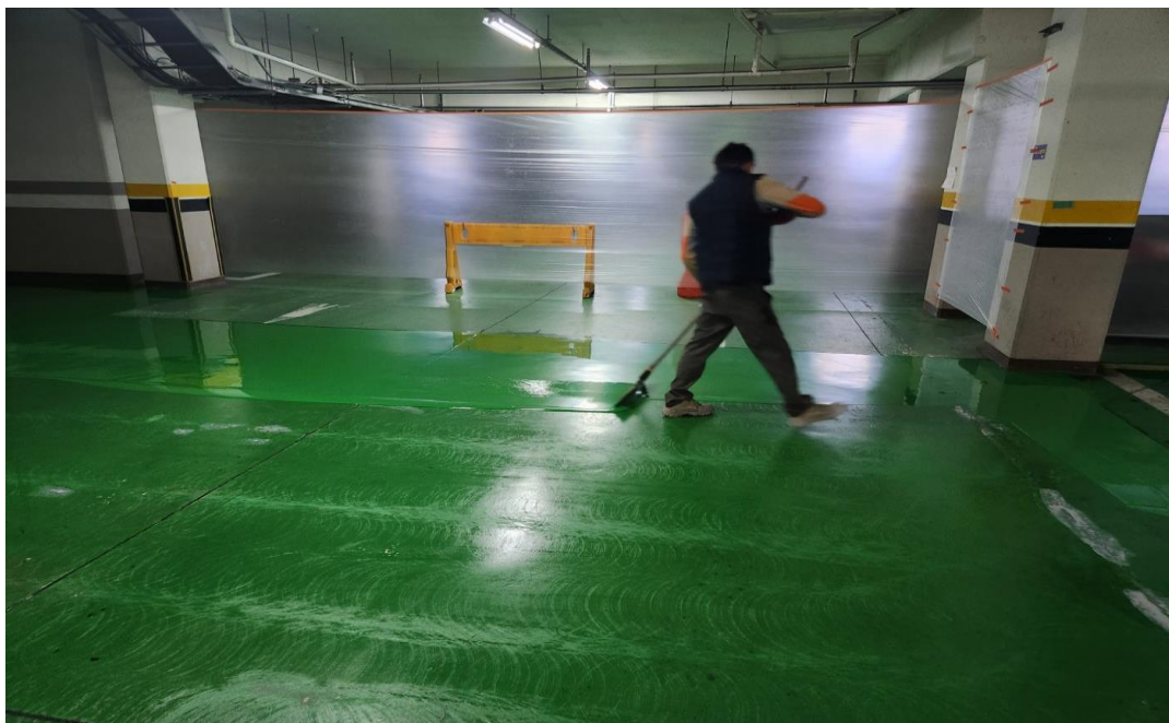
공사 중 (에폭시 중도 1차)
