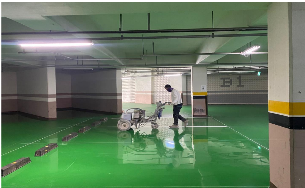
공사 중 (차선 작업)
