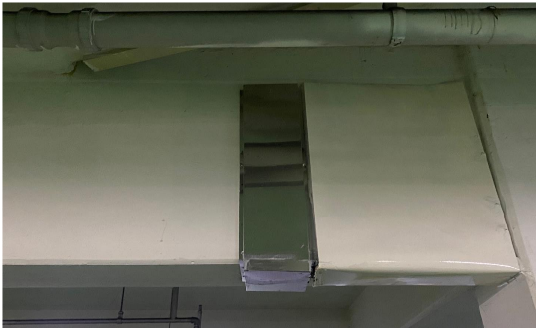
공사 후 (보호판 설치 공사완료)
