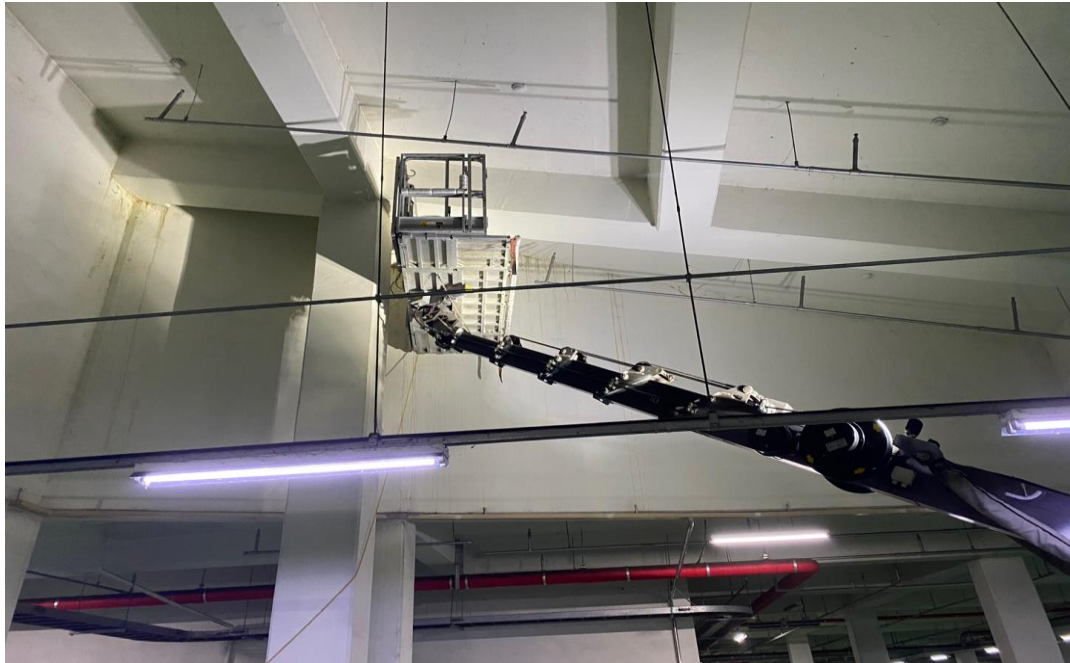
공사 중 (인젝션 주입)
