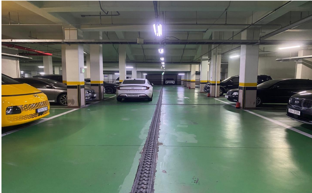
공사 전 (지하 2층)
