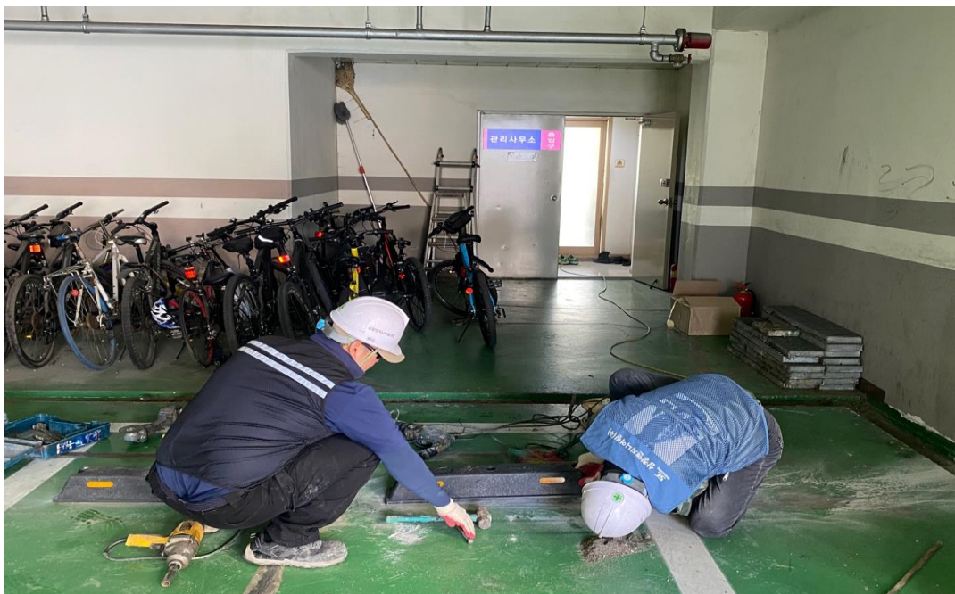
공사 중 (카스톱바 설치작업)
