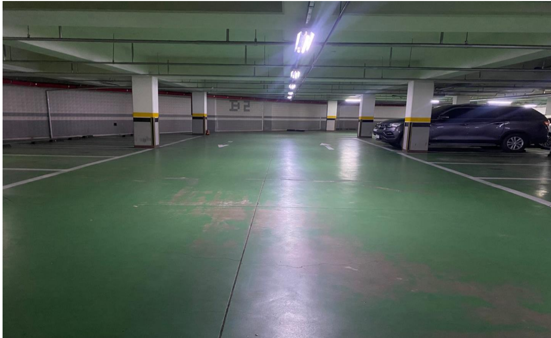
공사 전 (지하 2층)
