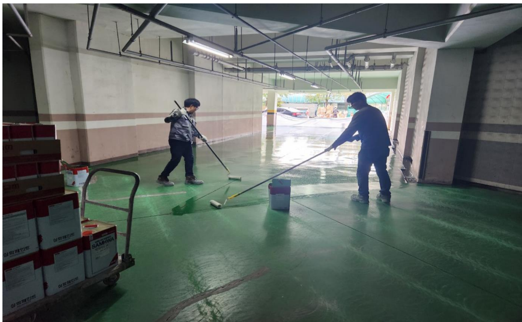
공사 중 (에폭시 하도 작업)
