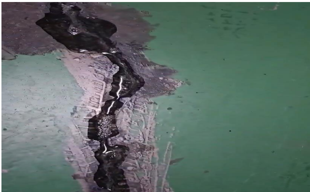
공사 중 (바닥 배면차수)
