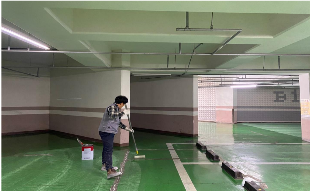
공사 중 (에폭시 하도 작업)
