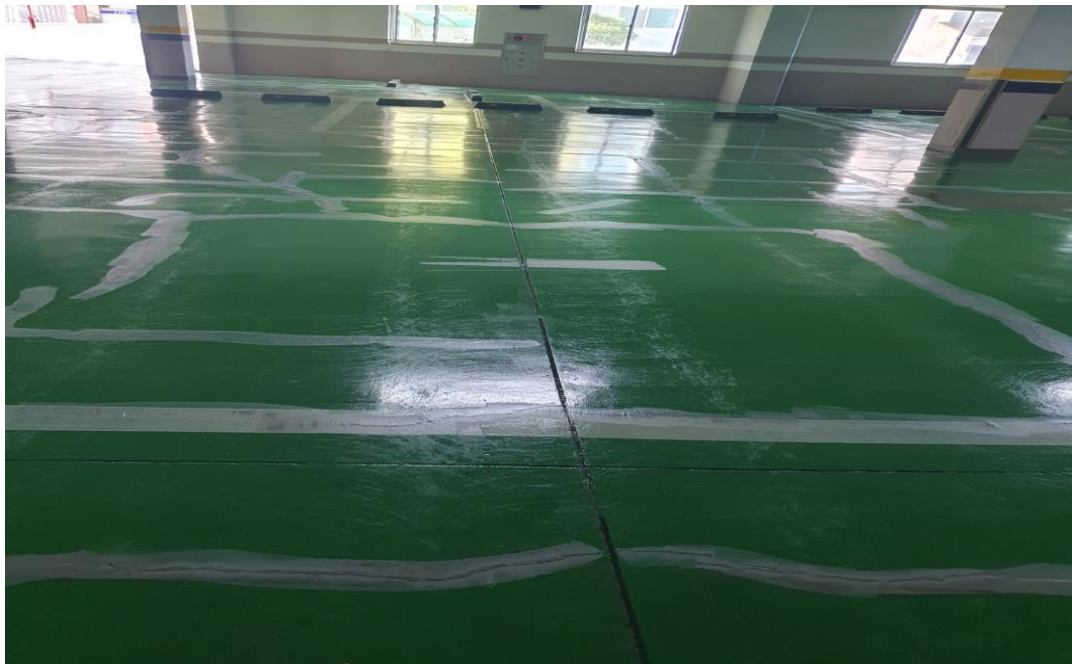
공사 중 (에폭시 하도 작업)
