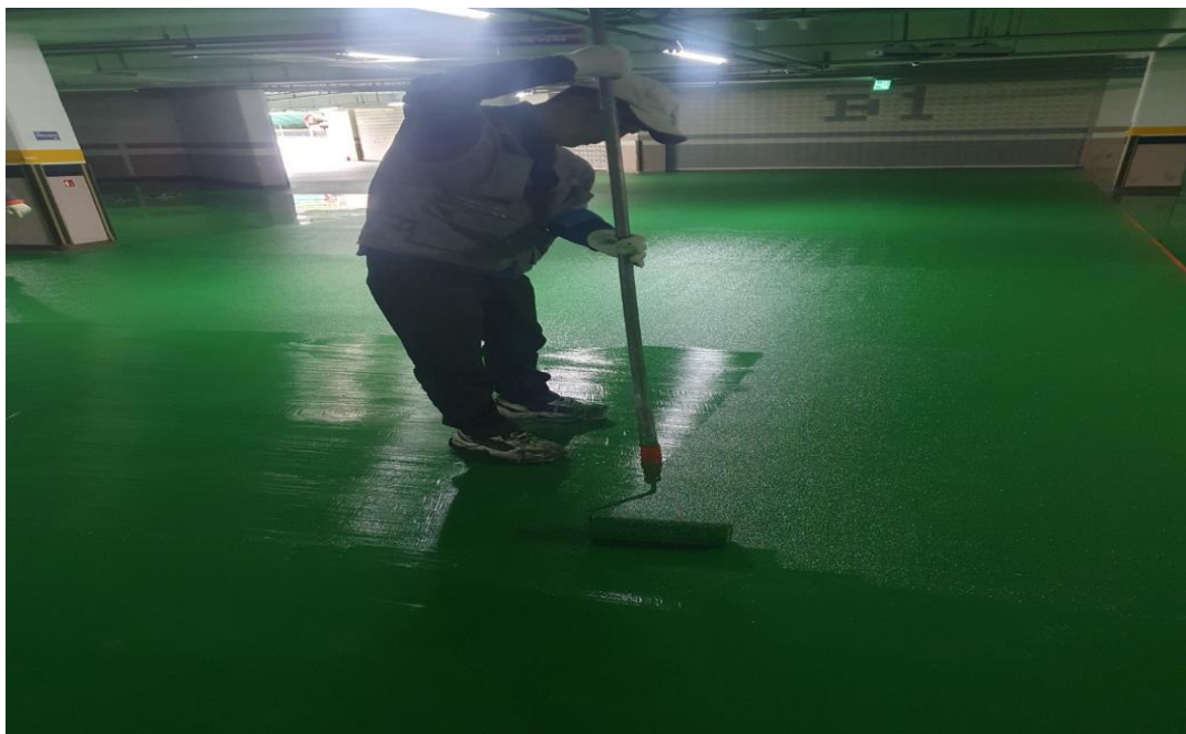
공사 중 (에폭시 엠보)
