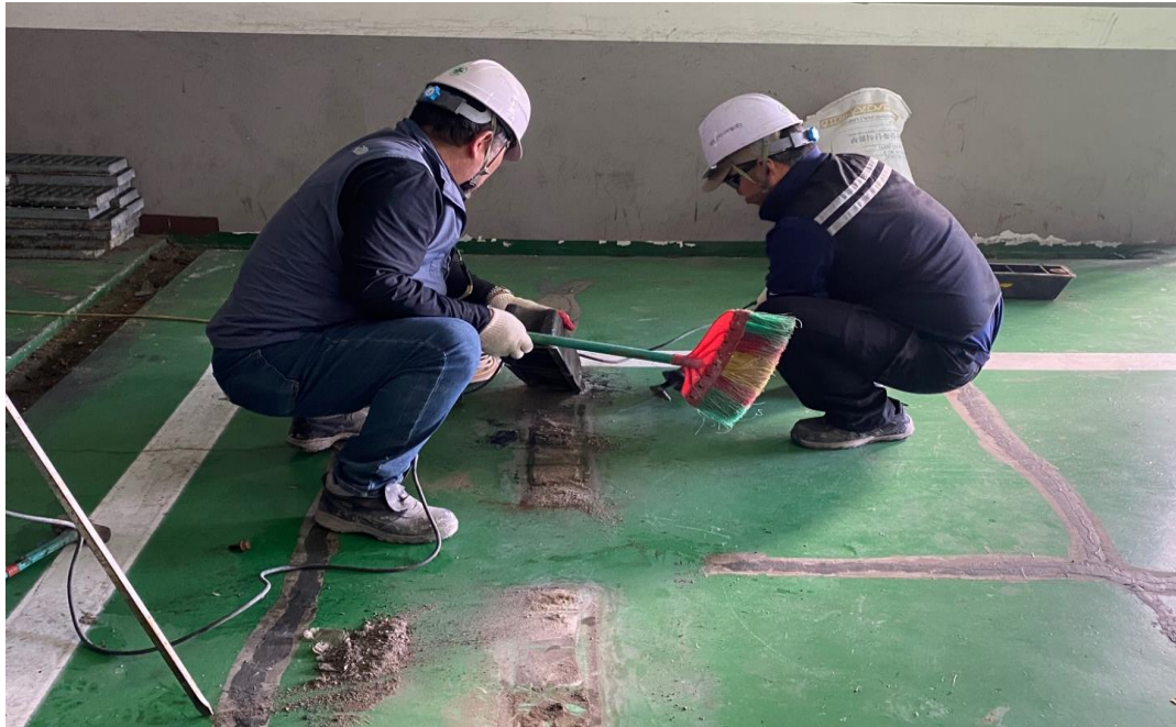
공사 중 (카스톱바 설치작업)
