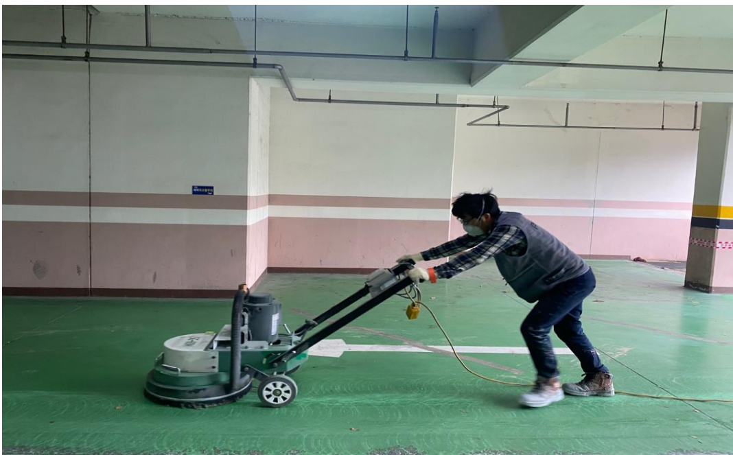
공사 중 (바탕면 정리)
