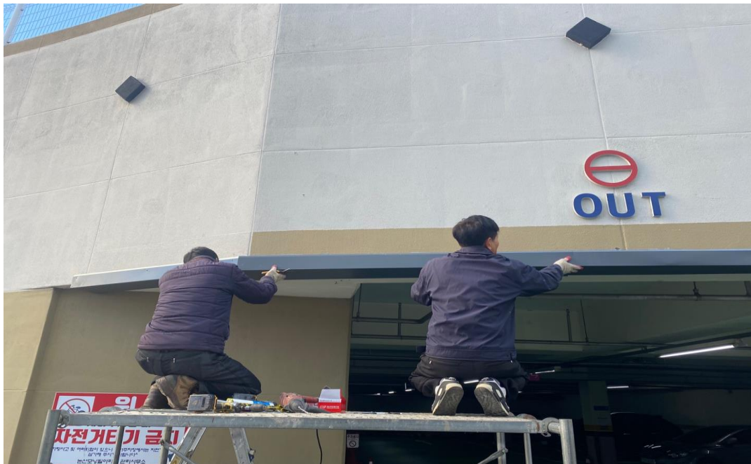
공사 중 (유도처리부위)
