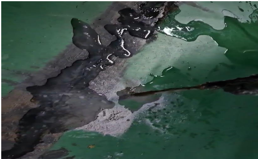
공사 중 (바닥 배면차수)
