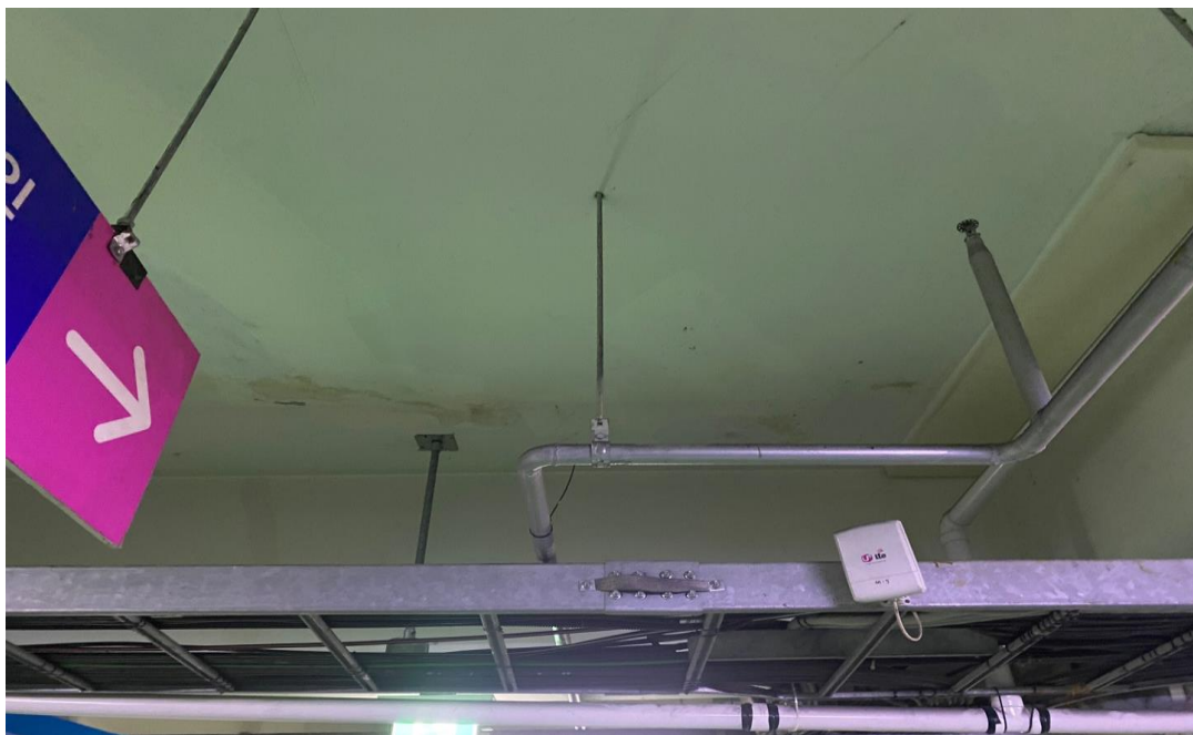
공사 후 (인젝션 주입 공사완료)
