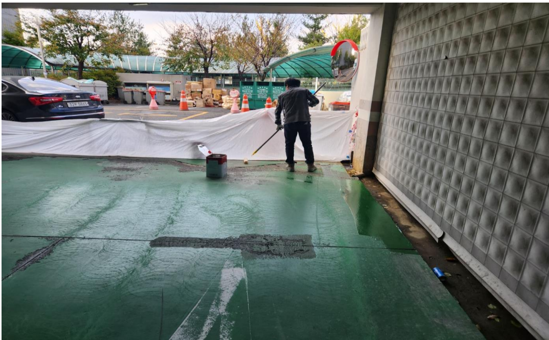
공사 중 (에폭시 하도 작업)
