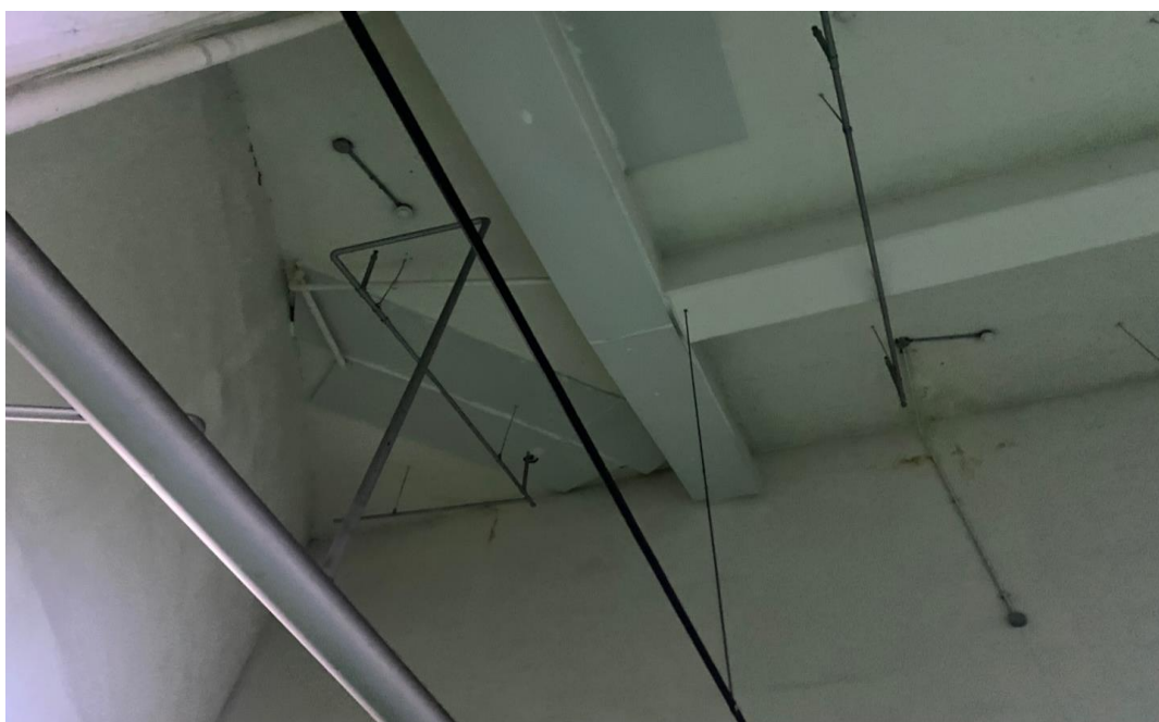
공사 전 (인젝션부위)
