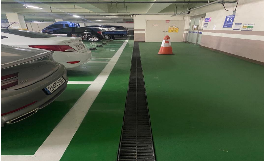
공사 후 (우레탄 시공 공사완료)
