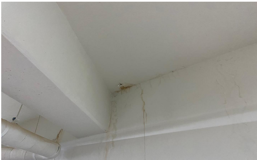
공사 전 (인젝션부위)
