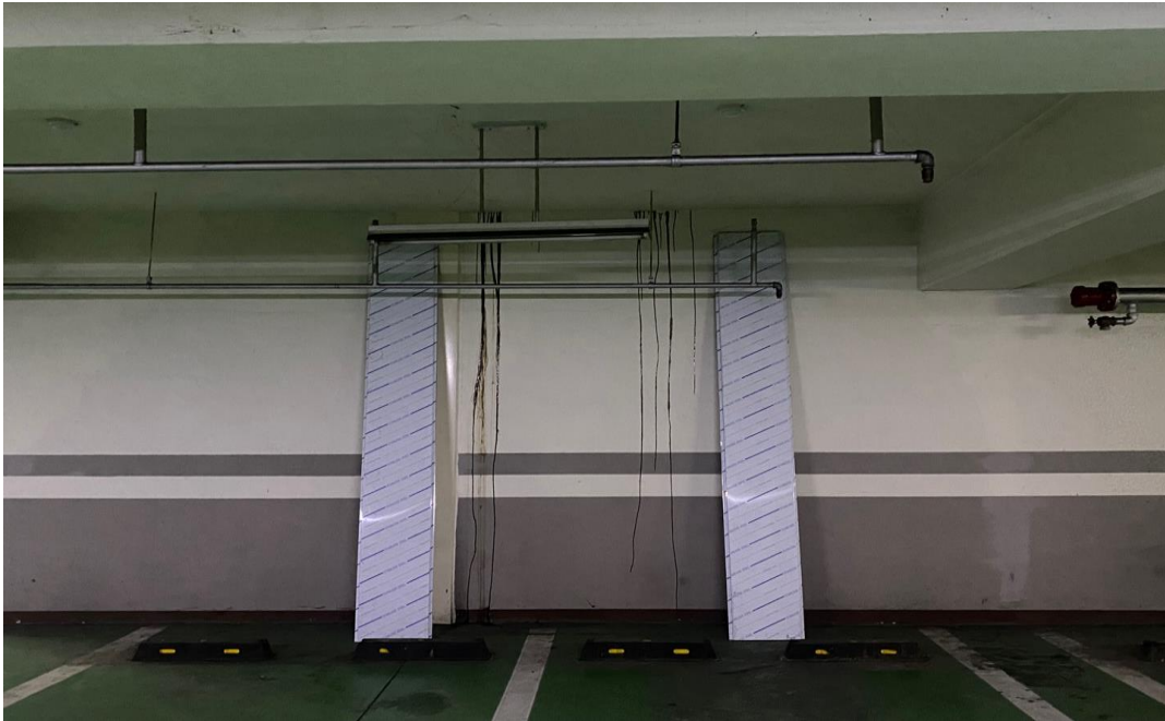
공사 중 (보호판 설치)
