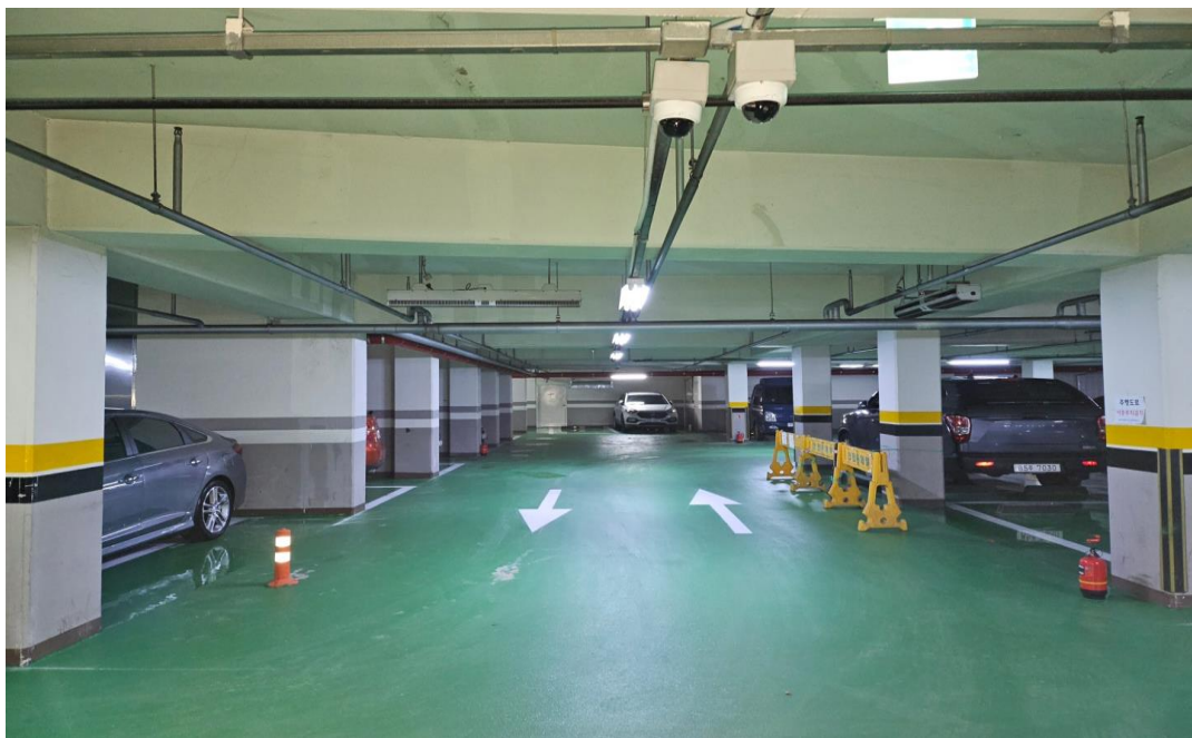
공사 후 (지하2층 공사완료)
