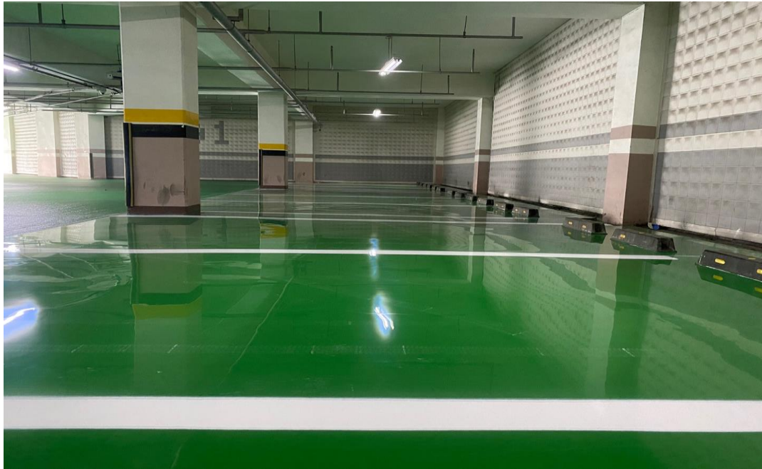
공사 중 (차선 작업)
