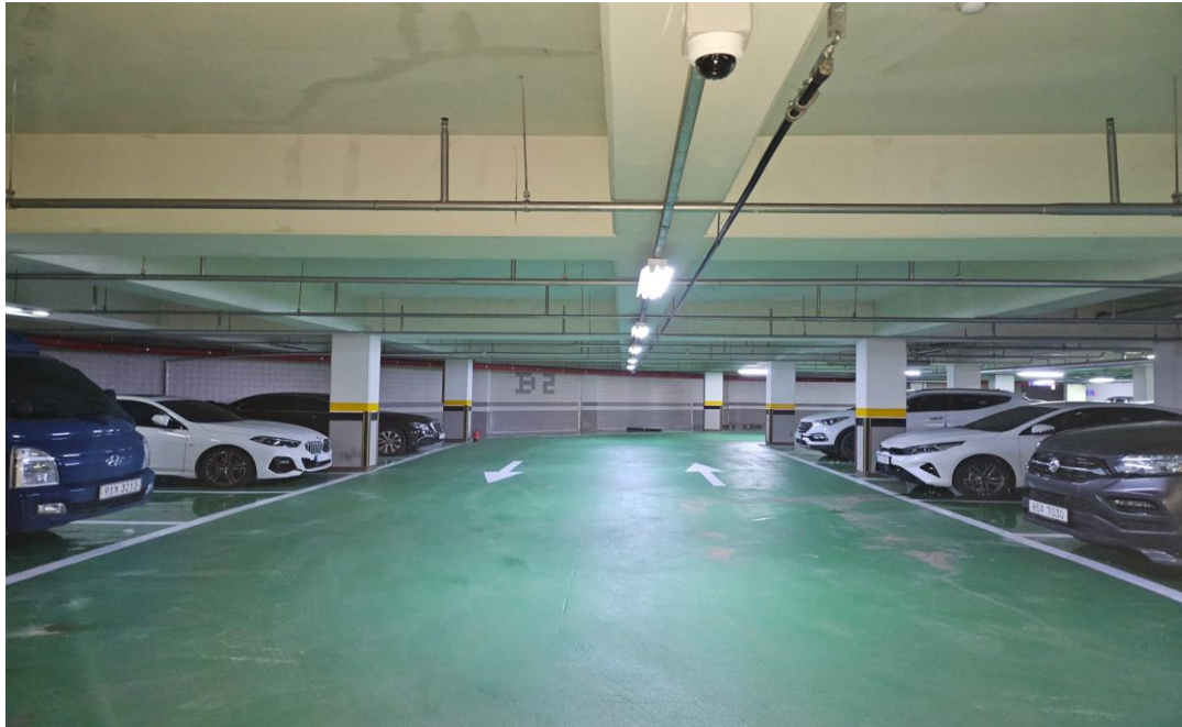
공사 후 (지하2층 공사완료)
