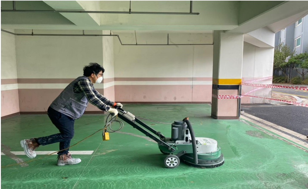
공사 중 (바탕면 정리)
