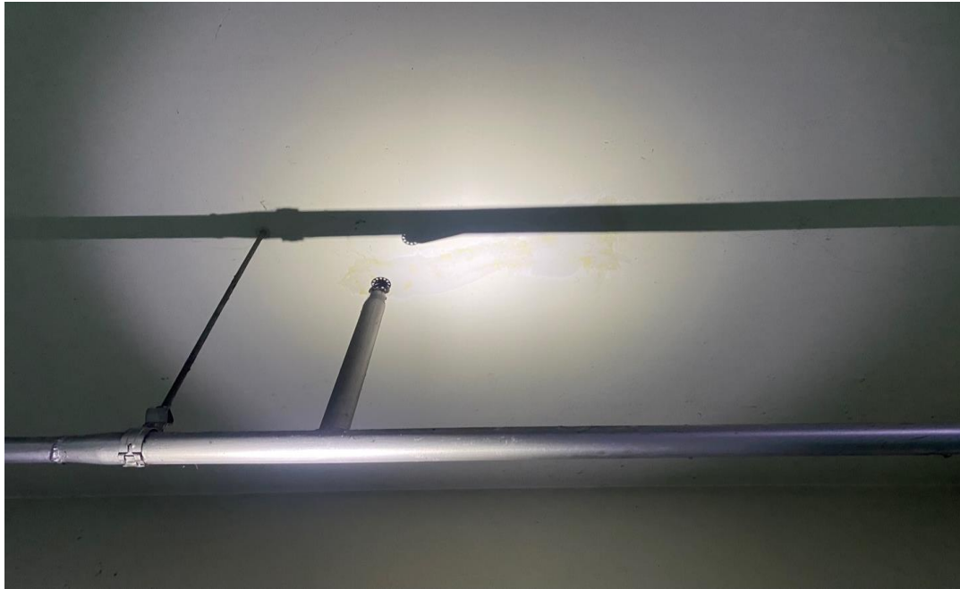
공사 후 (인젝션 주입 공사완료)
