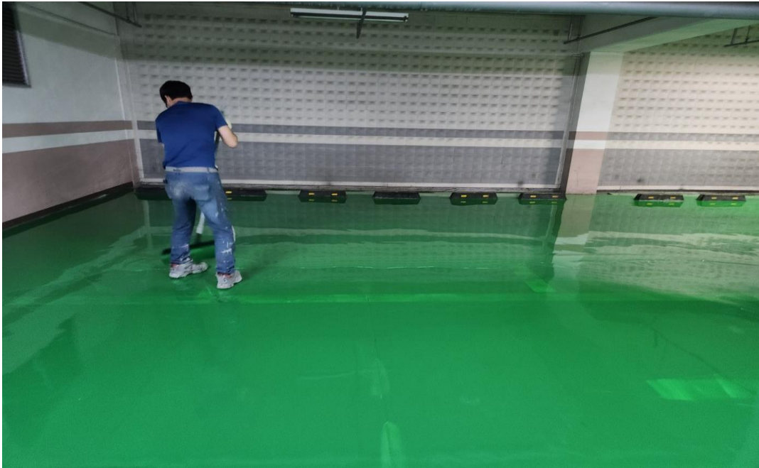
공사 중 (에폭시 중도 2차)
