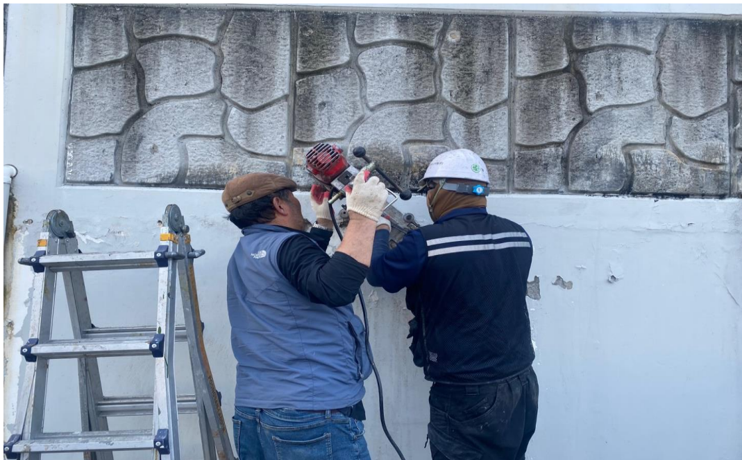
공사 중 (배관 설치 작업)
