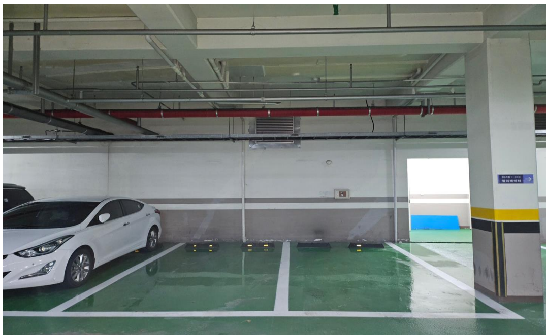
공사 후 (지하2층 공사완료)
