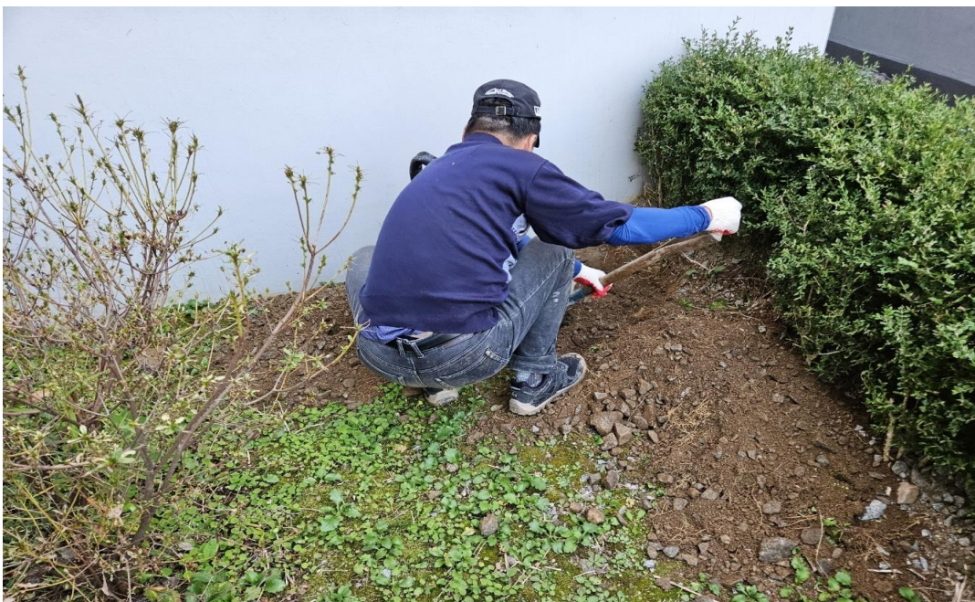
공사 중 (배관 설치 작업)
