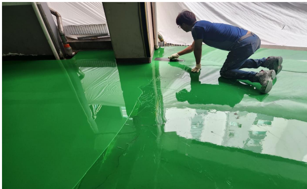
공사 중 (에폭시 중도 2차)
