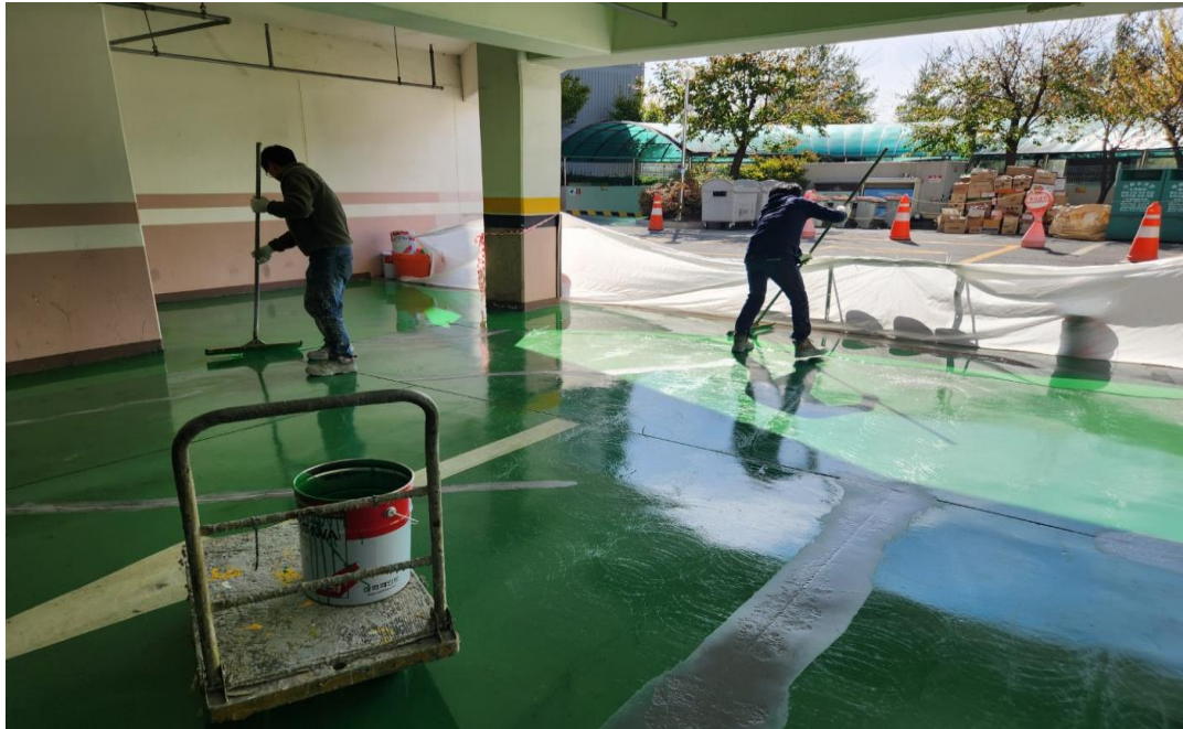
공사 중 (에폭시 중도 1차)
