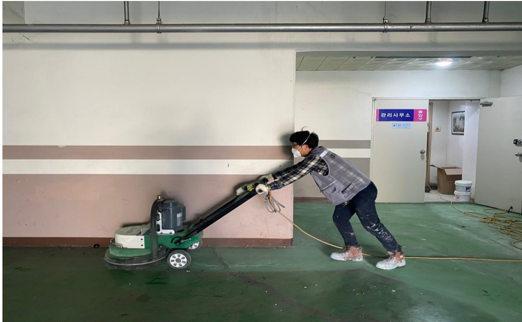
공사 중 (바탕면 정리)
