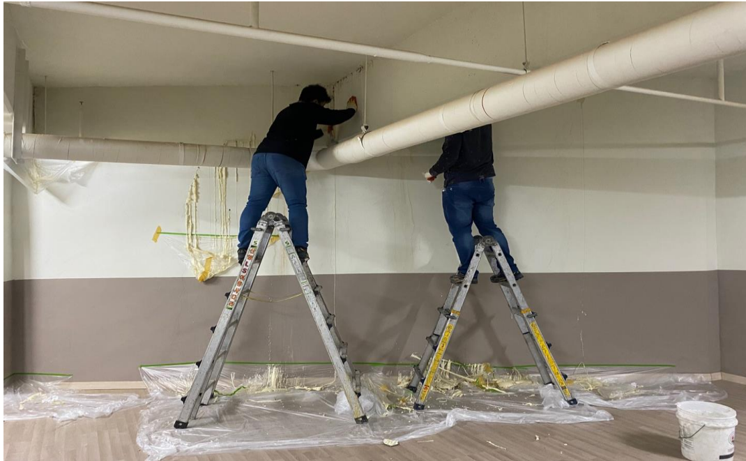
공사 중 (인젝션 주입)
