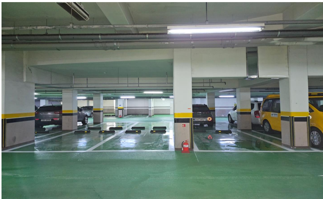
공사 후 (지하2층 공사완료)
