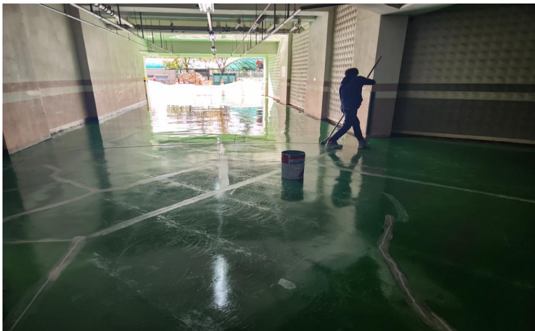
공사 중 (에폭시 중도 1차)
