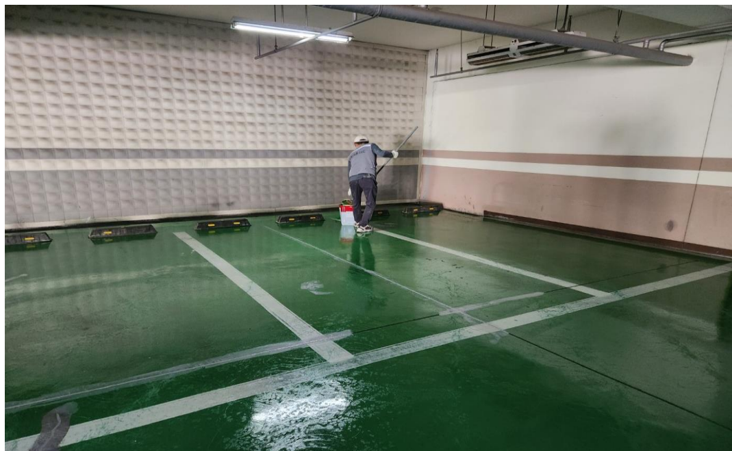
공사 중 (에폭시 중도 1차)
