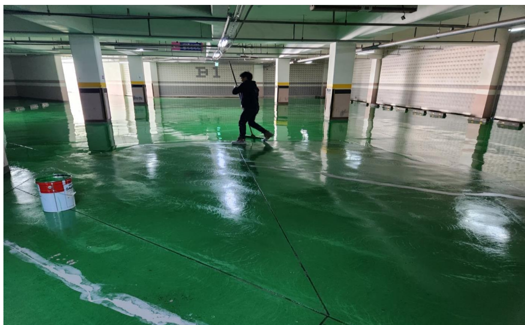
공사 중 (에폭시 중도 1차)
