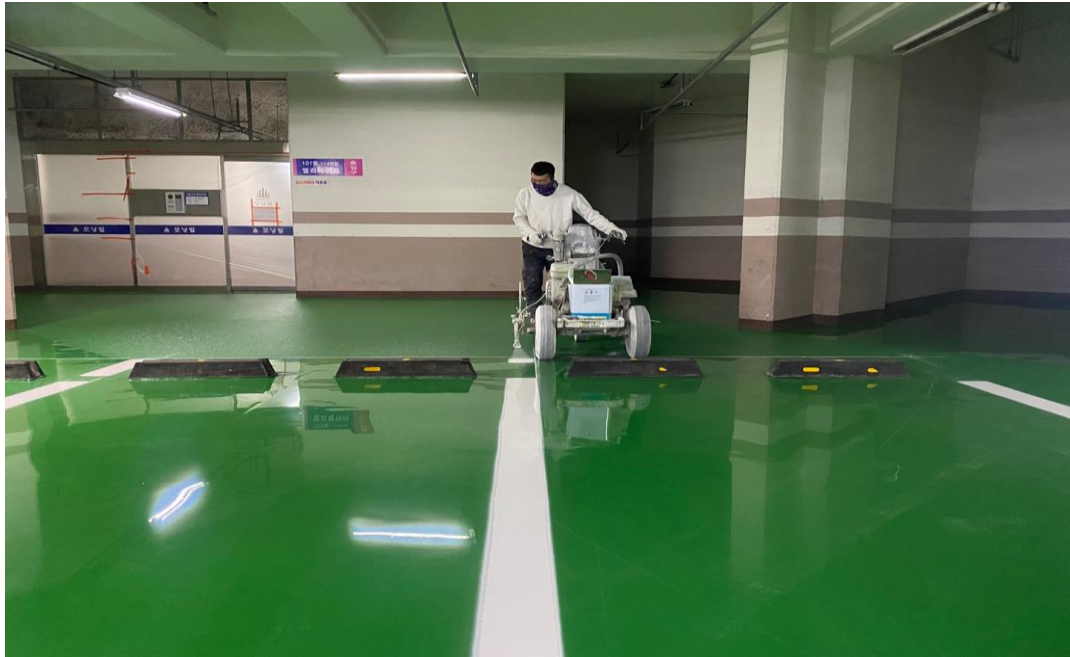
공사 중 (차선 작업)
