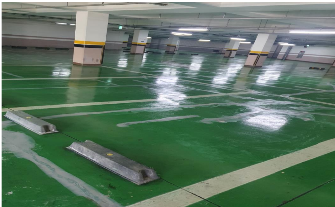
공사 중 (에폭시 하도 작업)
