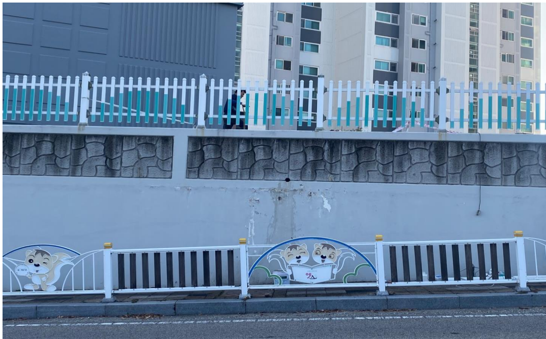
공사 전 (배관설치부위)
