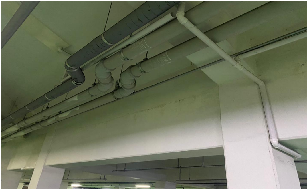
공사 전 (인젝션부위)
