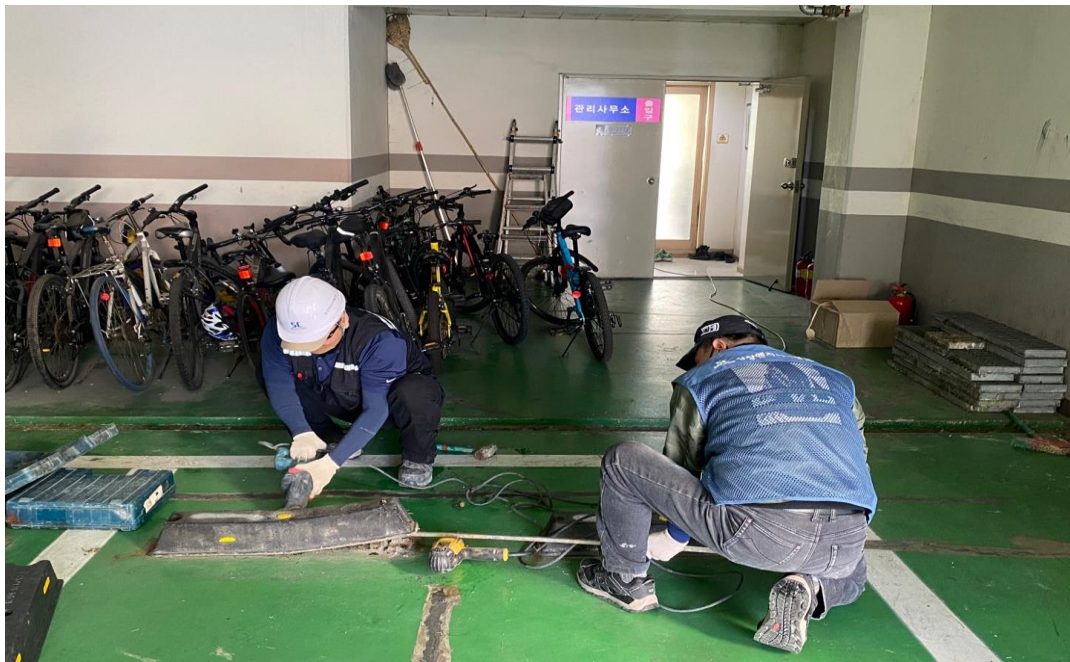
공사 중 (카스톱바 설치작업)
