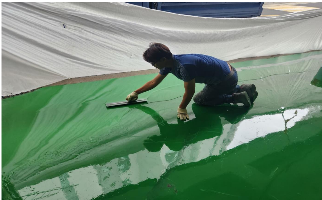
공사 중 (에폭시 중도 2차)
