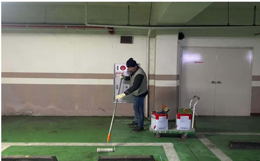
공사 중 (에폭시 하도 작업)
