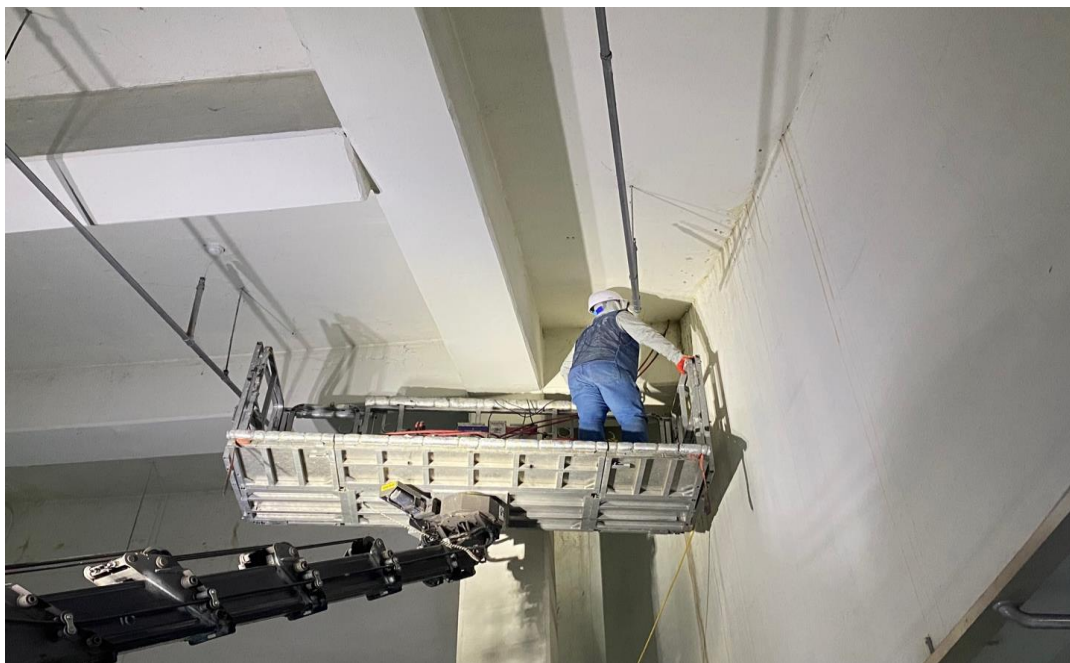
공사 중 (인젝션 주입)
