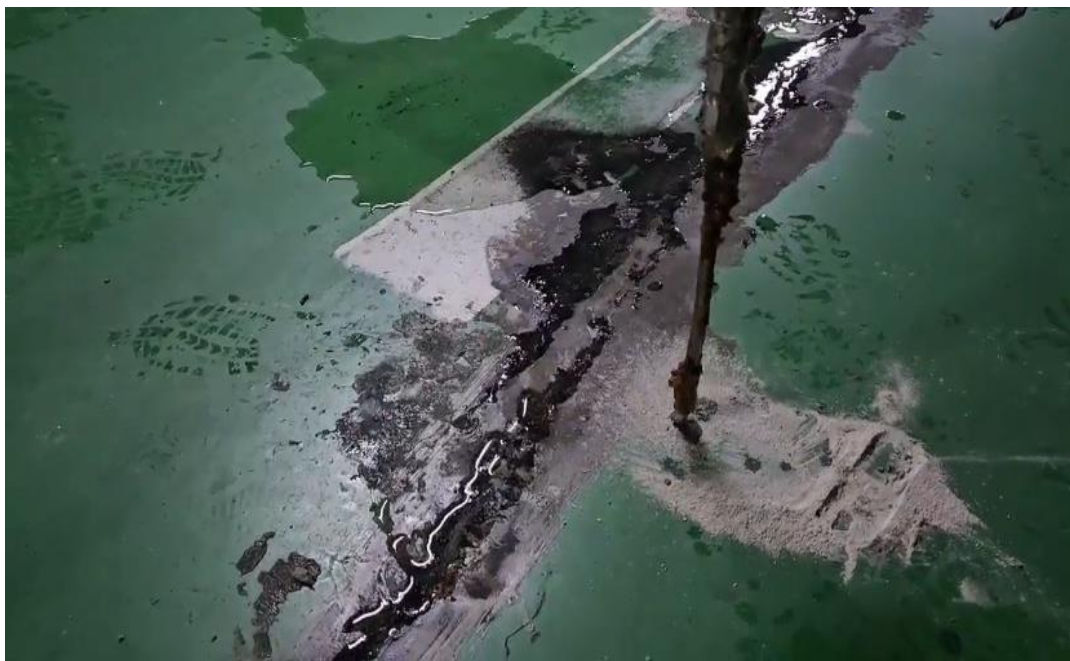
공사 중 (바닥 배면차수)
