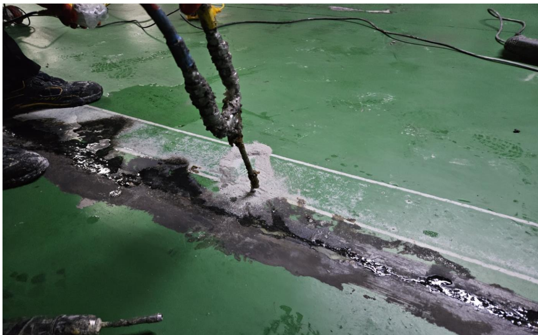
공사 중 (바닥 배면차수)
