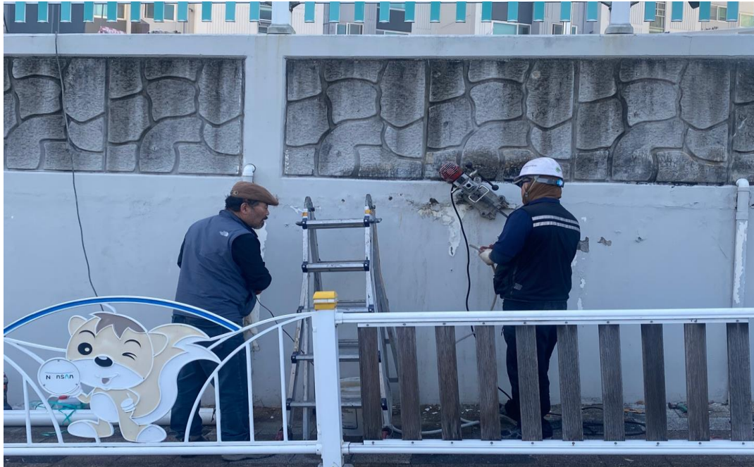
공사 중 (배관 설치 작업)
