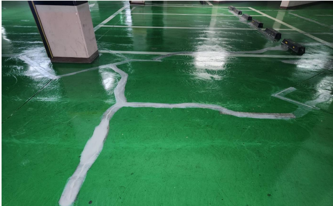
공사 중 (에폭시 하도 작업)
