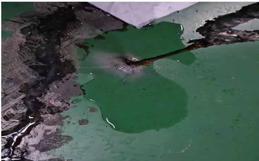
공사 중 (바닥 배면차수)
