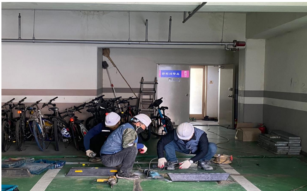
공사 중 (카스톱바 설치작업)
