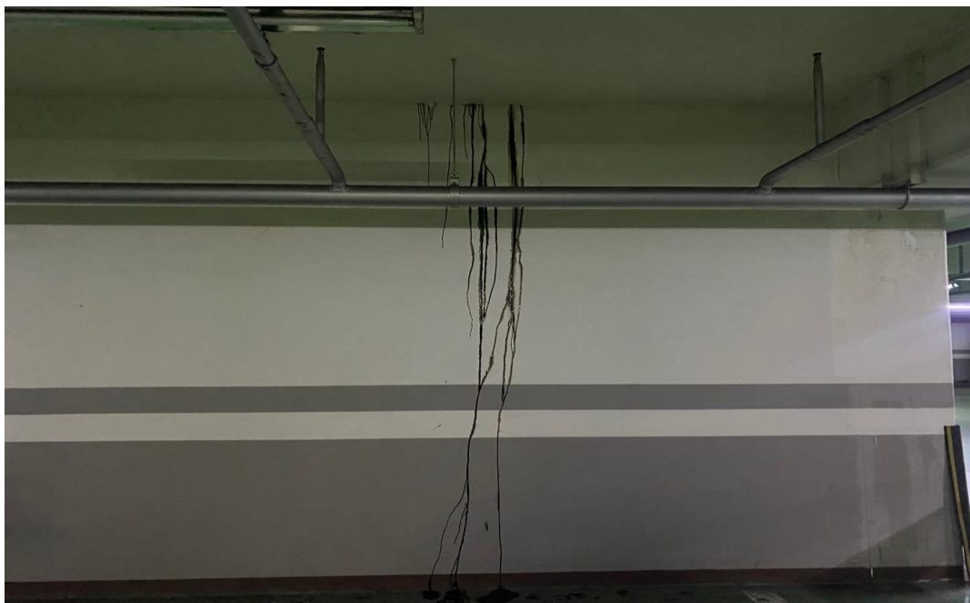
공사 전 (보호판 설치부위)
