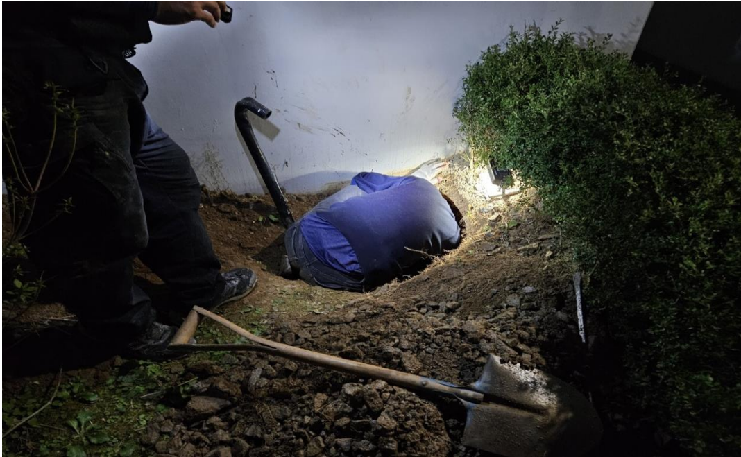
공사 중 (배관 설치 작업)
