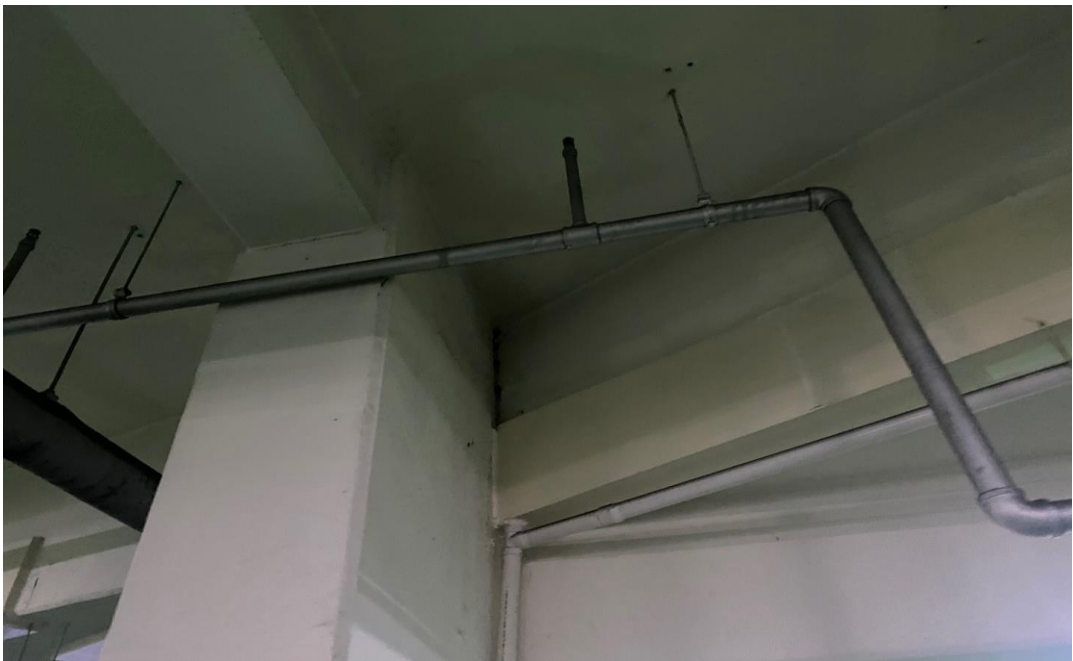
공사 전 (인젝션부위)
