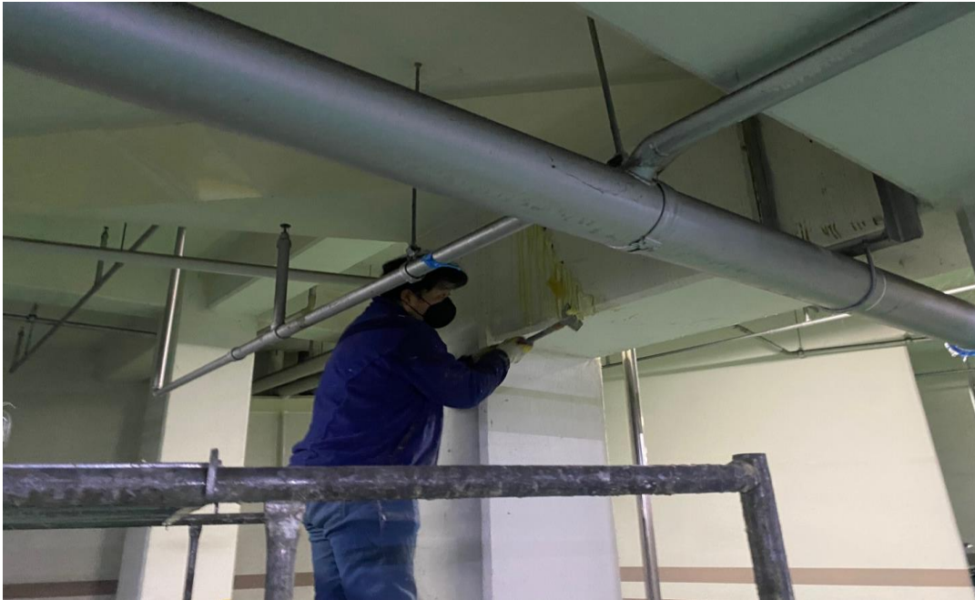
공사 중 (인젝션 주입)
