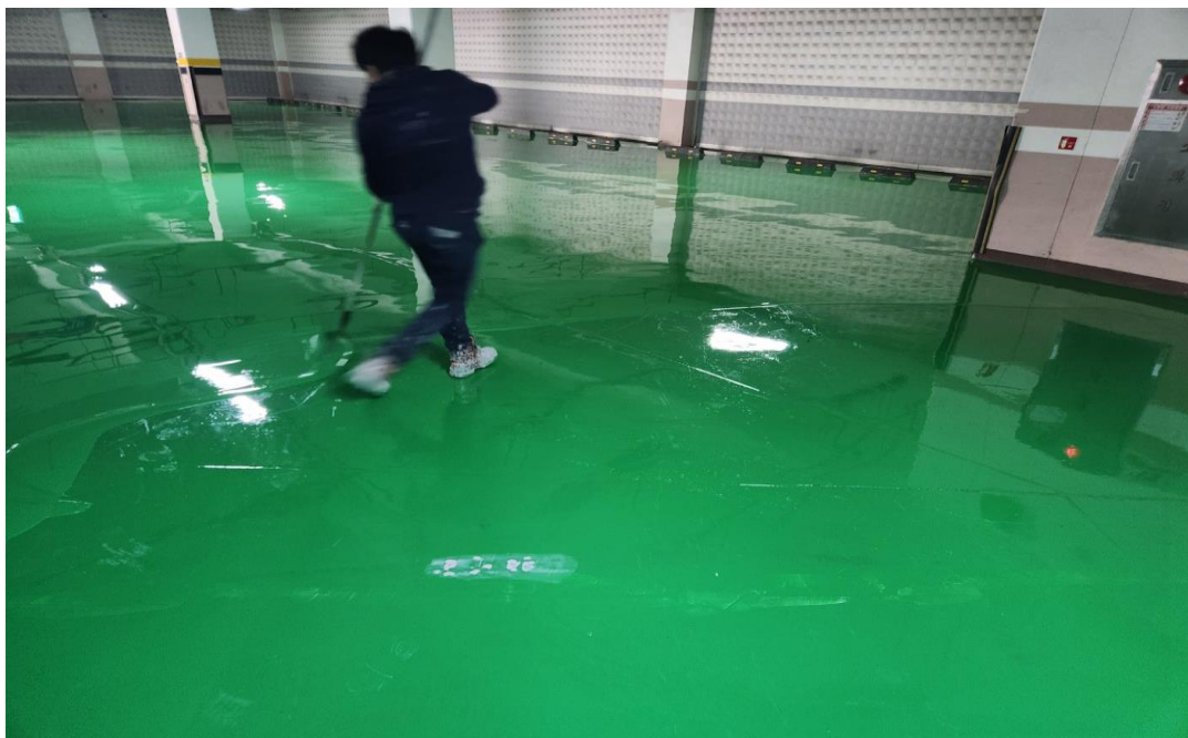
공사 중 (에폭시 중도 2차)
