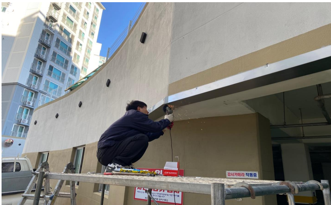
공사 중 (유도처리부위)
