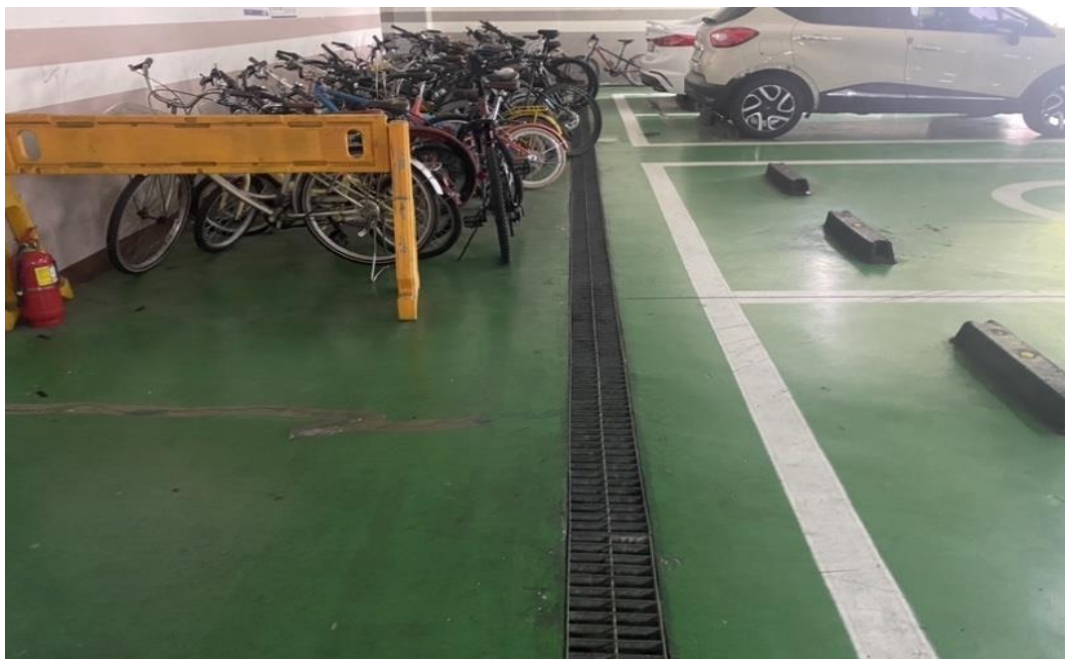
공사 전 (트렌치철거부위)
