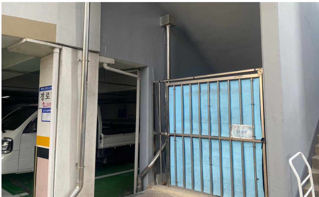
공사 전 (배관작업부위)
