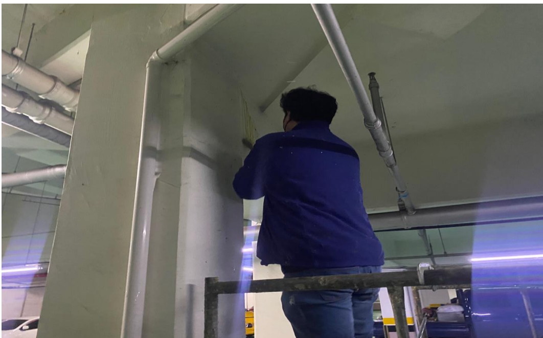
공사 중 (인젝션 주입)
