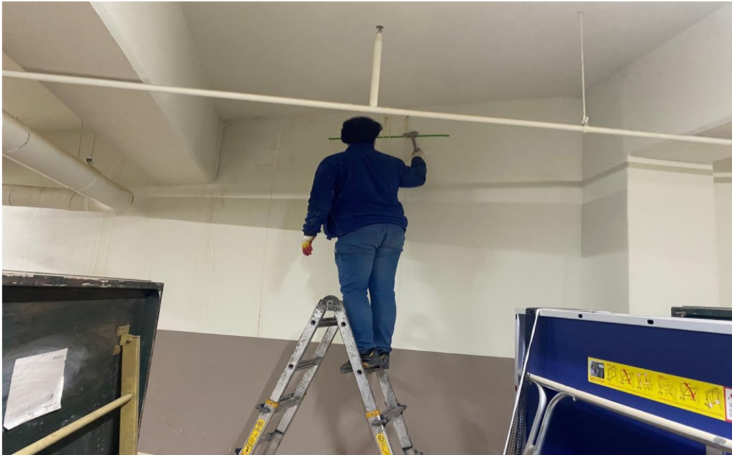
공사 중 (인젝션 주입)
