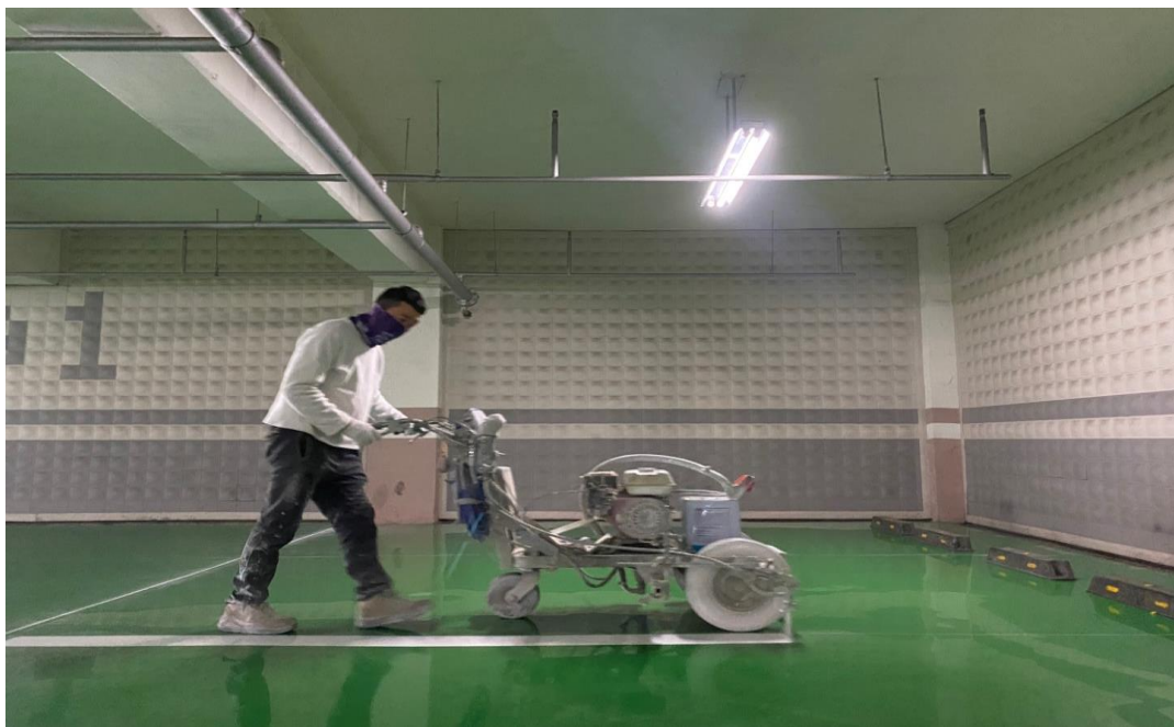
공사 중 (차선 작업)
