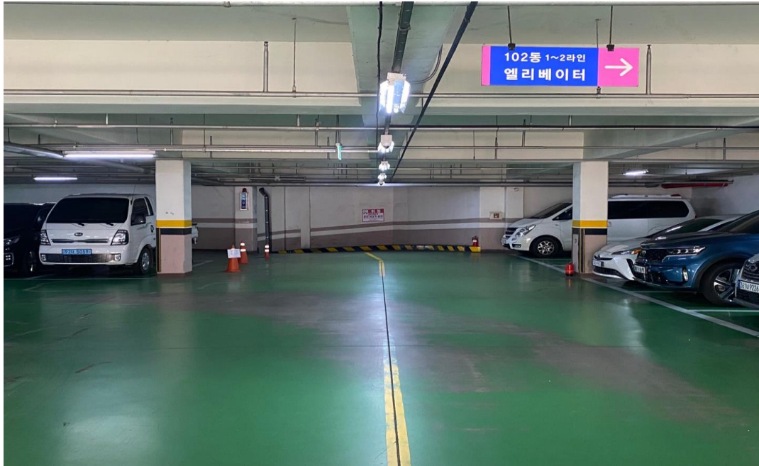
공사 전 (지하1층)
