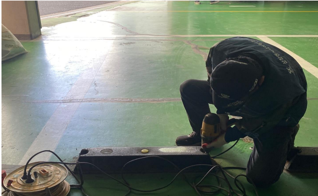
공사 중 (카스톱바 설치작업)
