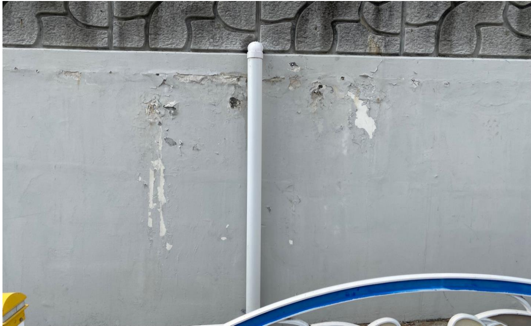
공사 후 (배관설치 공사완료)
