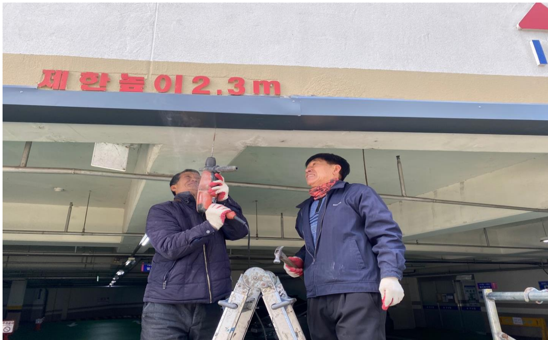
공사 중 (유도처리부위)
