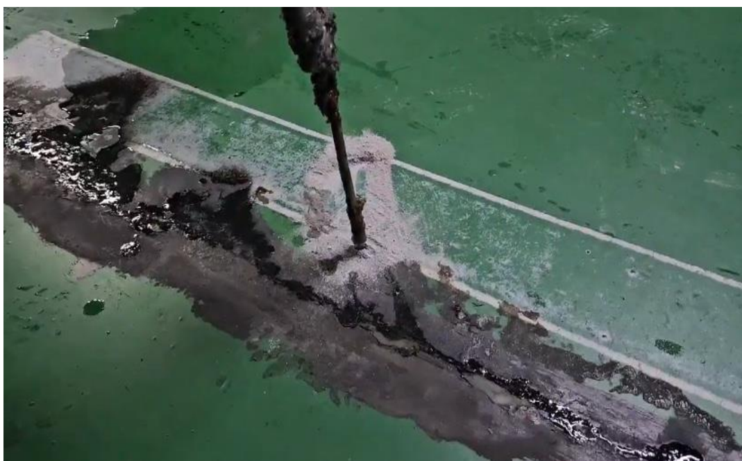
공사 중 (바닥 배면차수)
