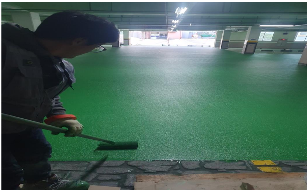
공사 중 (에폭시 엠보)
