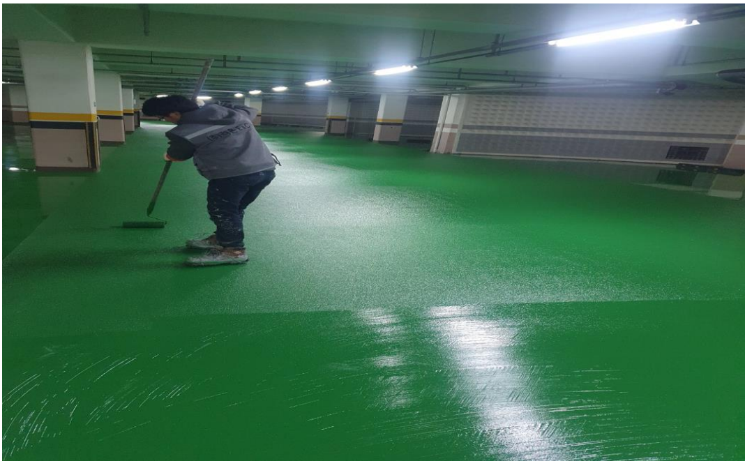
공사 중 (에폭시 엠보)
