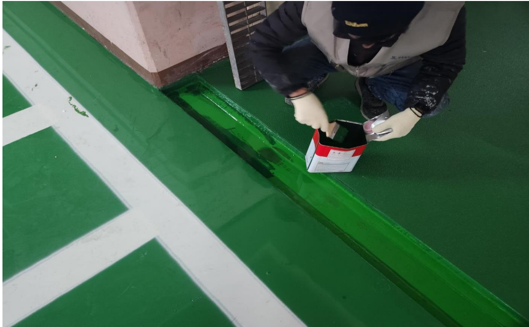
공사 중 (우레탄 시공)
