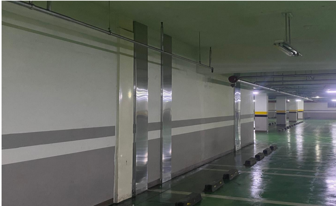
공사 후 (보호판 설치 공사완료)
