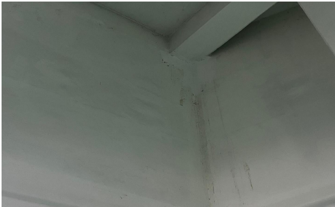
공사 후 (인젝션 주입 공사완료)
