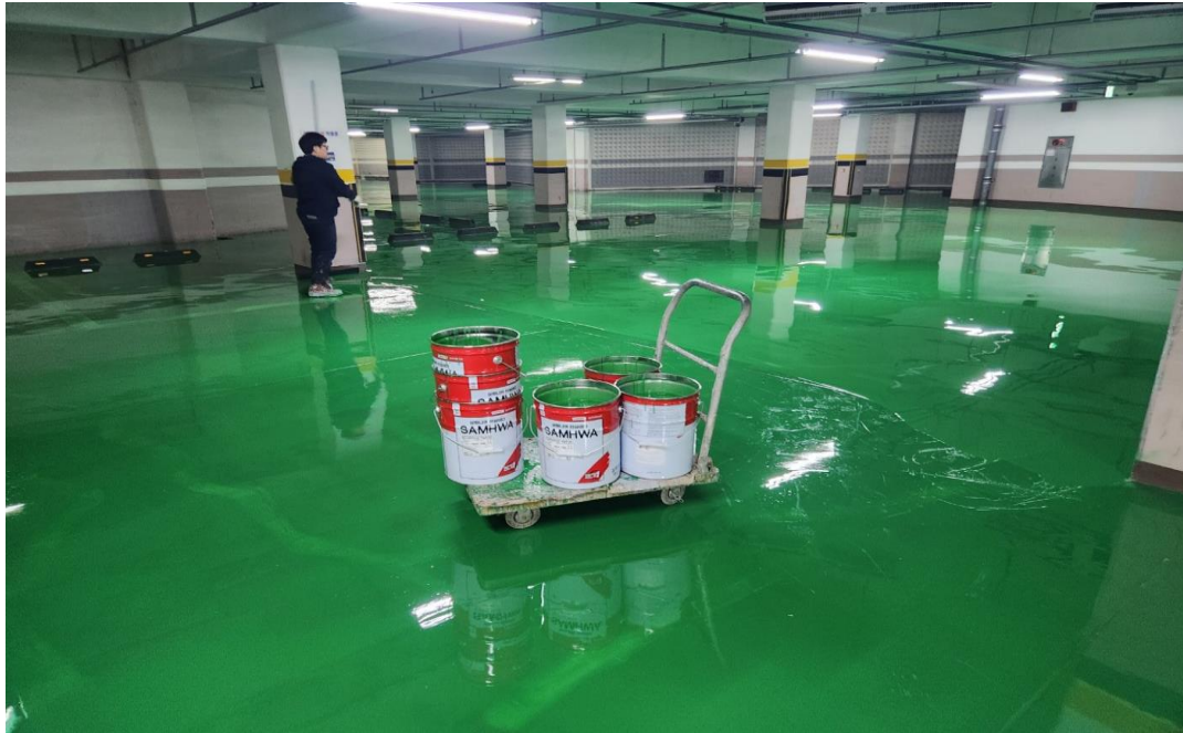
공사 중 (에폭시 중도 2차)
