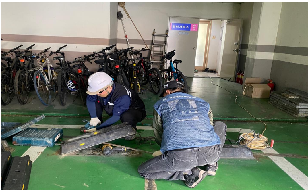
공사 중 (카스톱바 설치작업)
