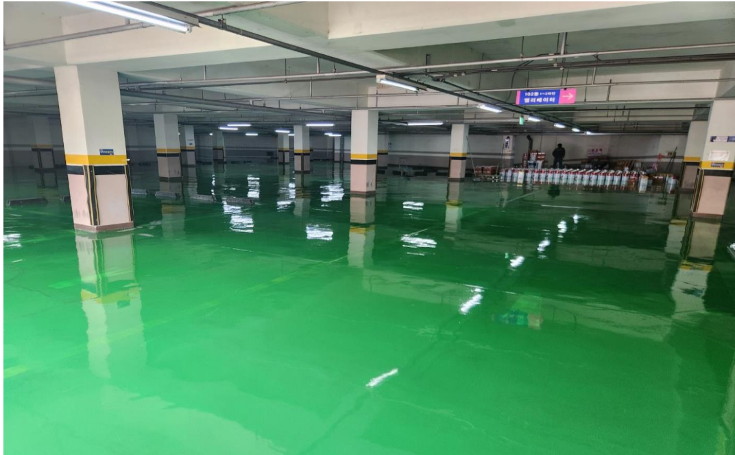
공사 중 (에폭시 중도 2차)
