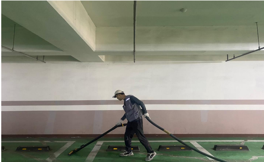
공사 중 (청소 작업)
