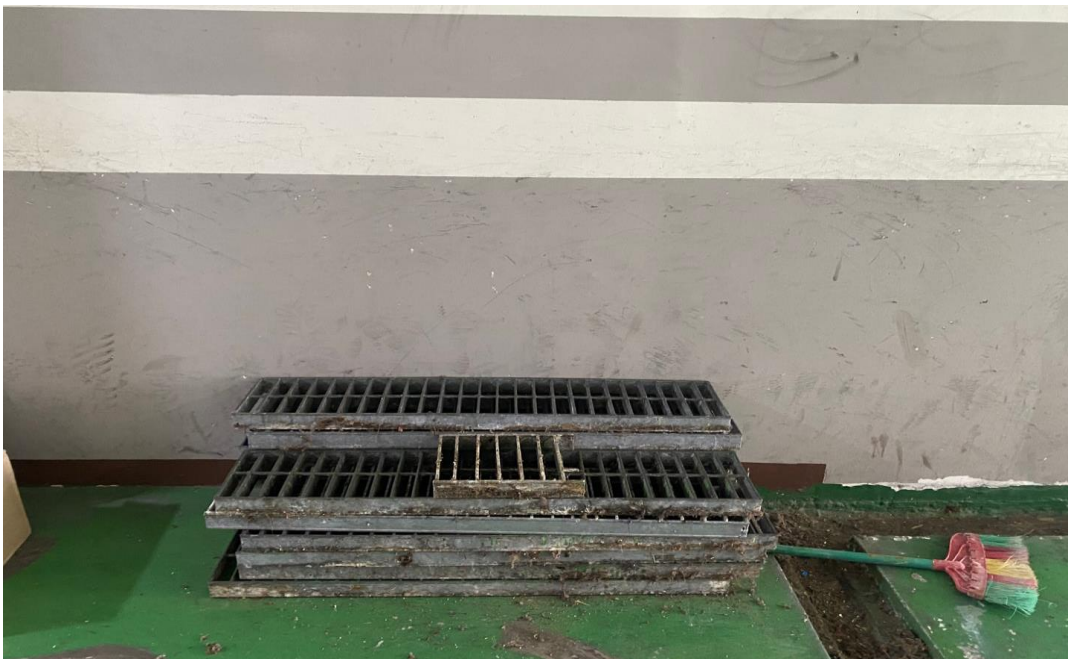
공사 중 (트렌치 절거)
