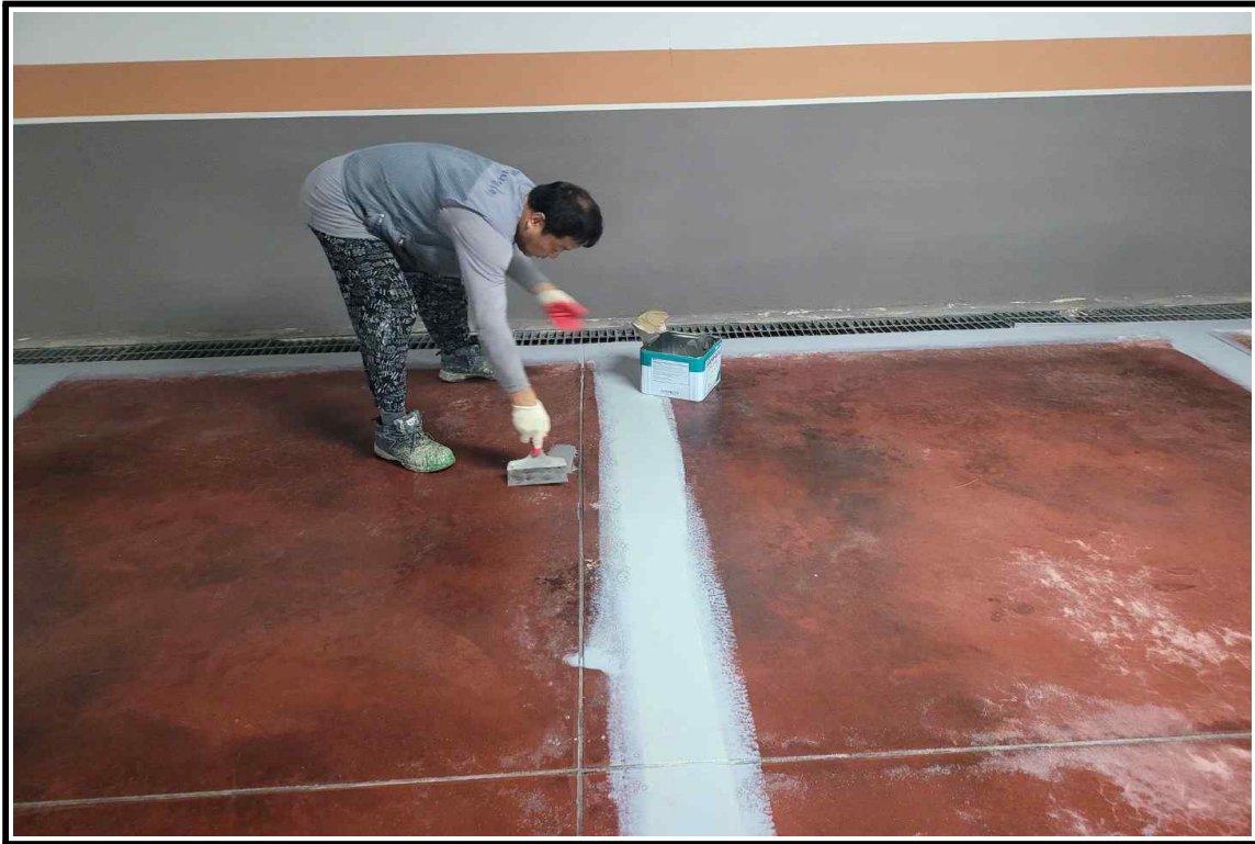
◎ 에폭시 균열보수 작업 중
