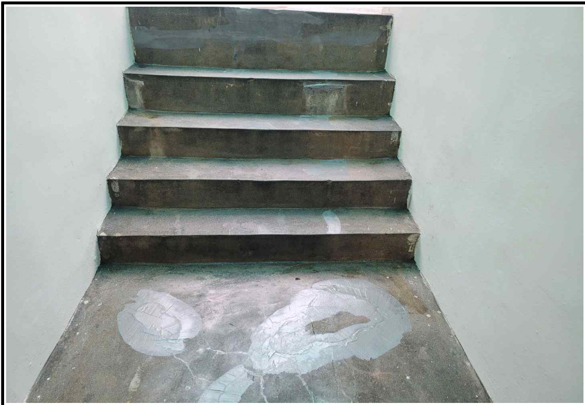
◎ 에폭시 균열보수 작업 중
