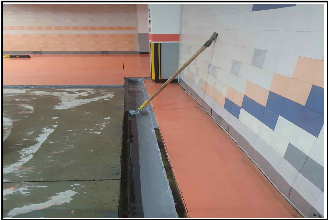
◎ 트렌치 방수 작업 중
