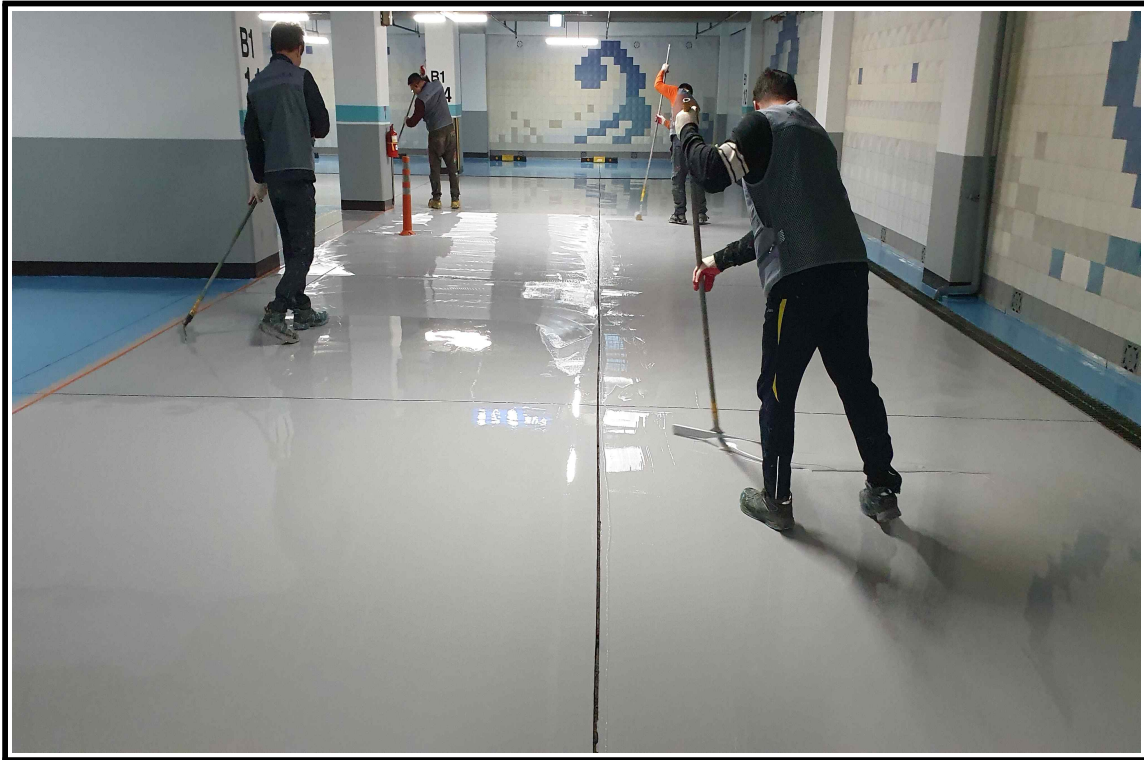
◎ 에폭시 엠보 작업 중
