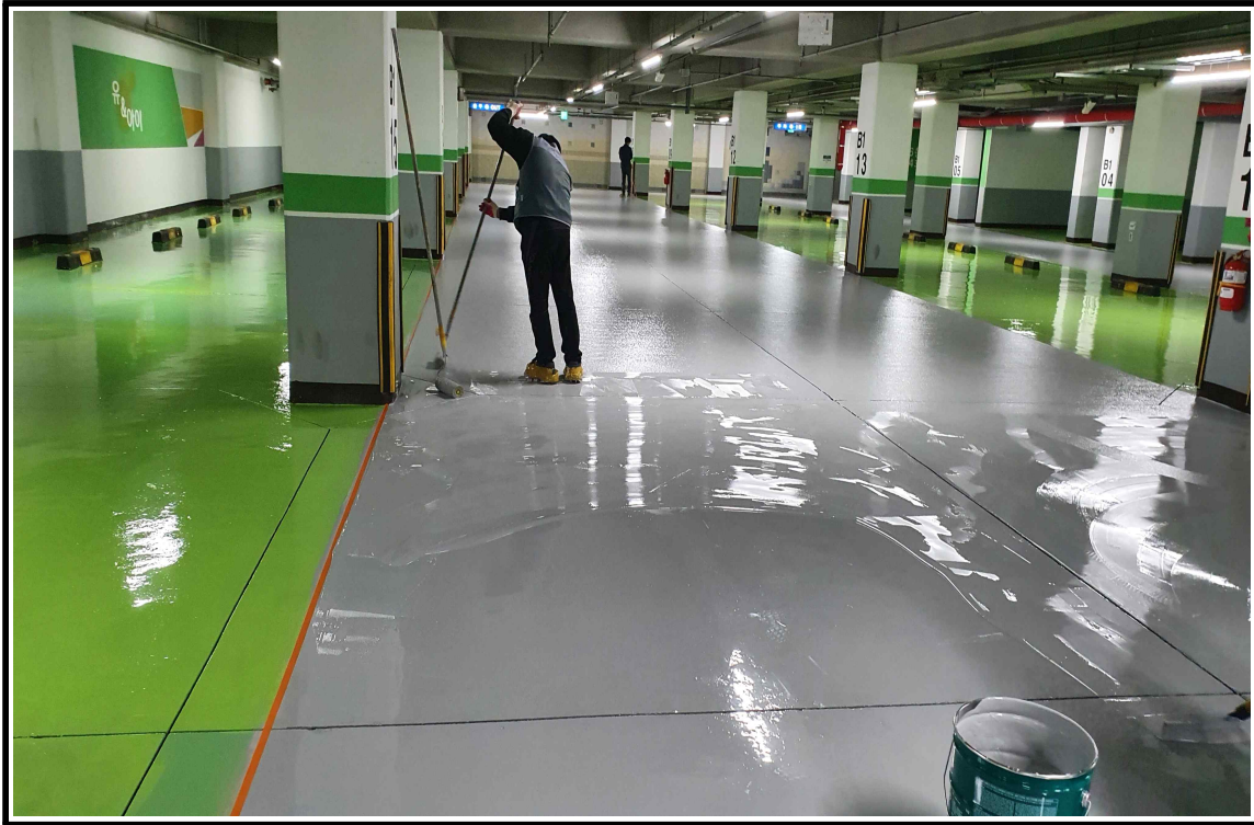
◎ 에폭시 엠보 작업 중
