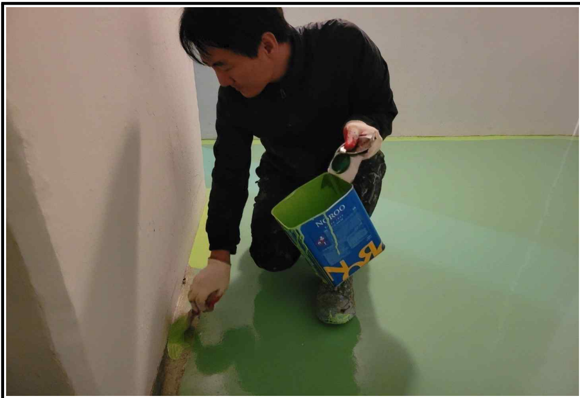
◎ 에폭시 상도 작업 중
