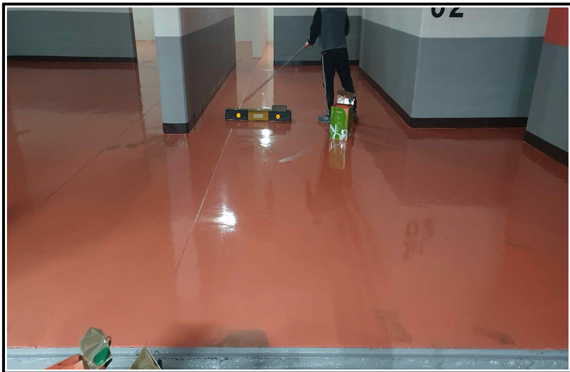
◎ 에폭시 상도 작업 중
