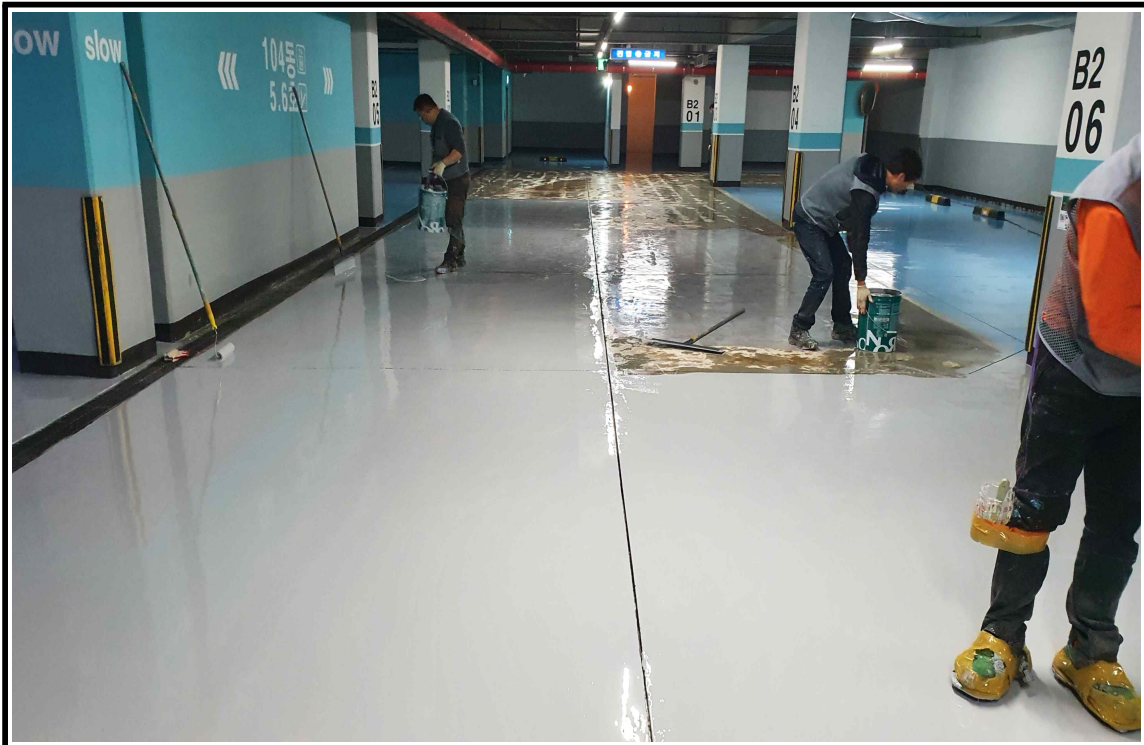
◎ 에폭시 중도 작업 중
