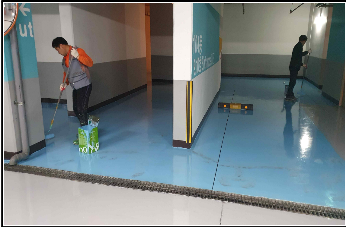
◎ 에폭시 상도 작업 중
