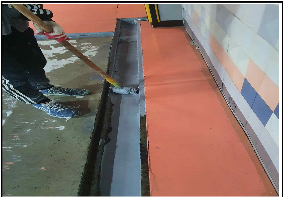
◎트렌치 방수 작업 중
