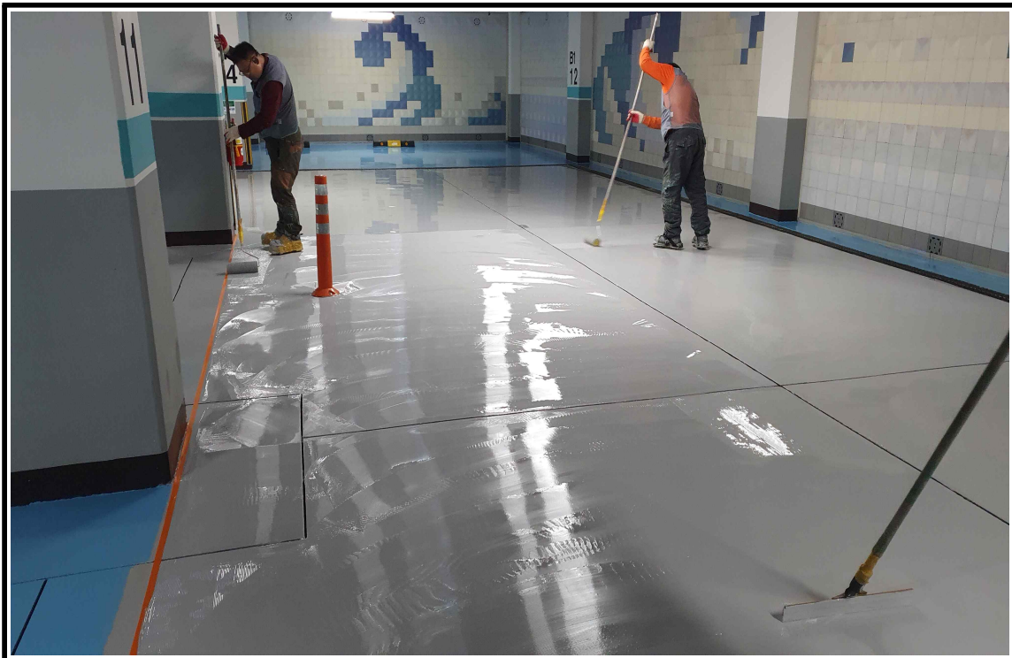
◎ 에폭시 엠보 작업 중
