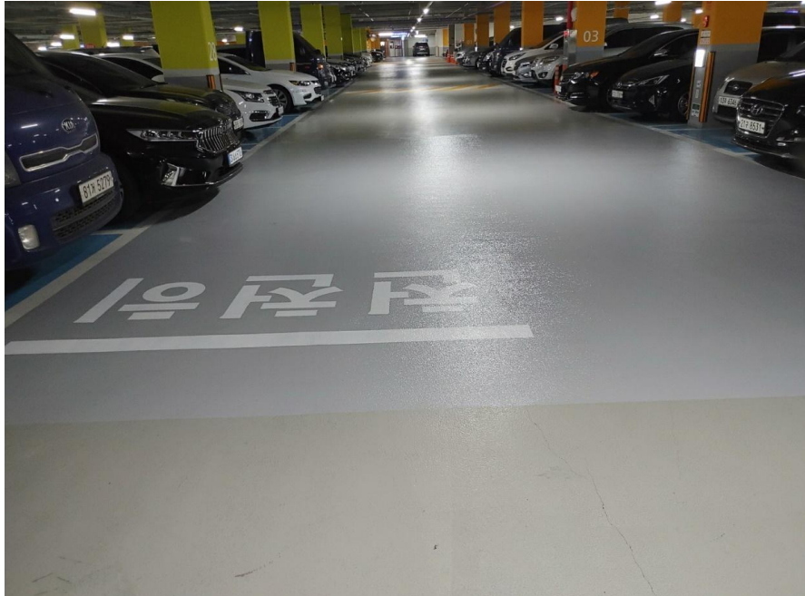
지하주차장 바닥 에폭시 도장 완료
