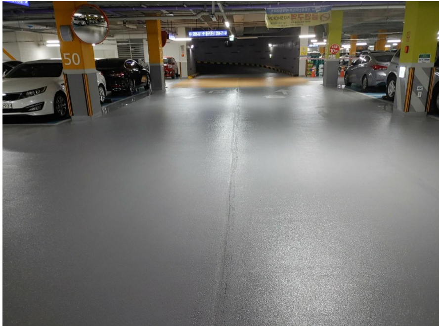
지하주차장 바닥 에폭시 도장 완료
