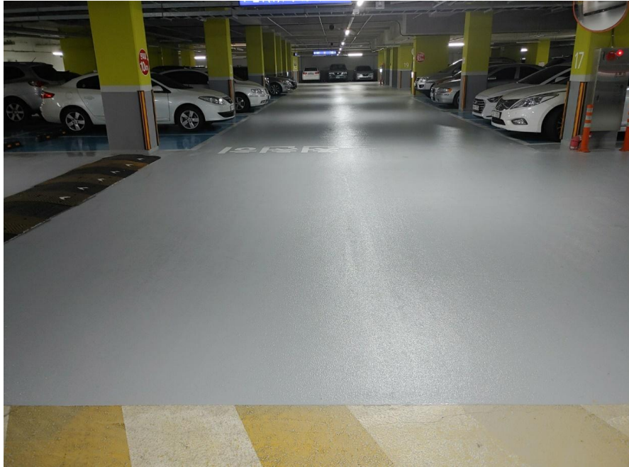
지하주차장 바닥 에폭시 도장 완료
