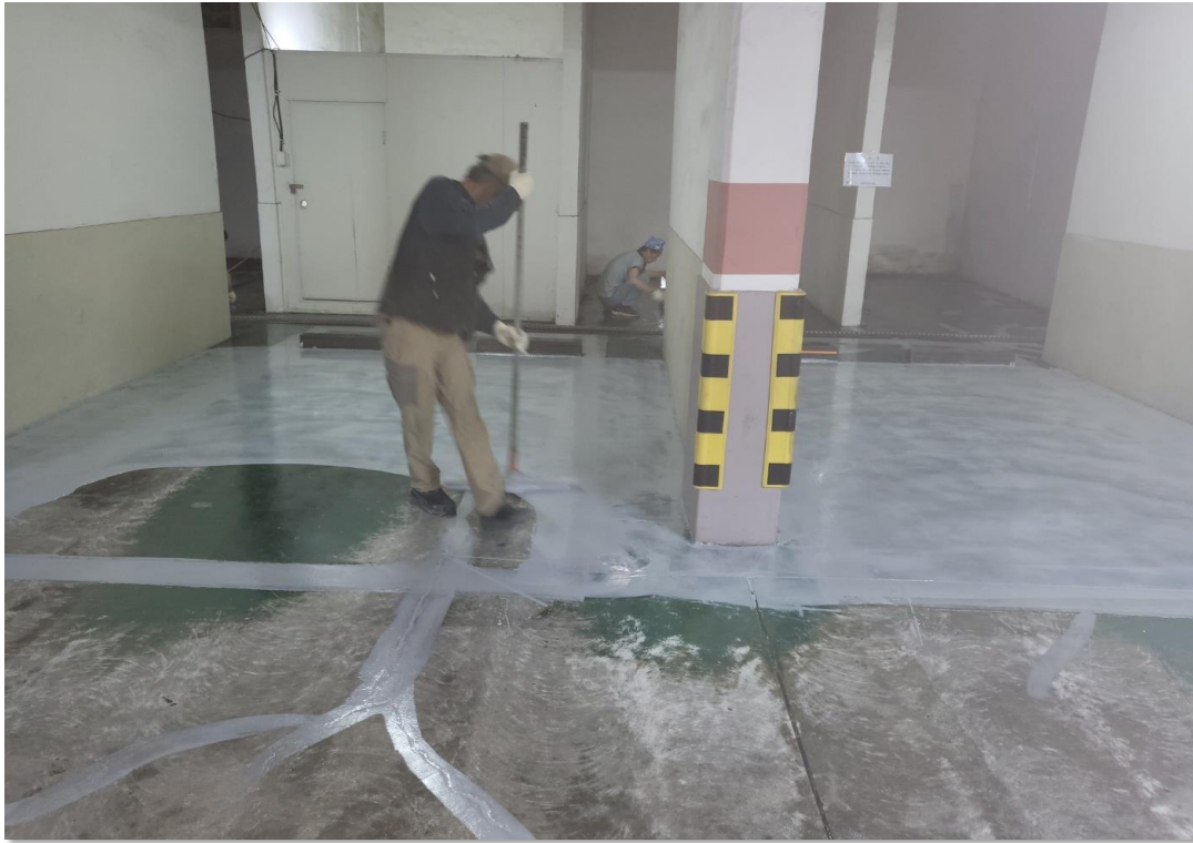
주차면 바닥 라이닝 평균 0.5mm 도포 작업 - (기존 바닥 아크릴 재질로인하여 추가로포 하였음)
