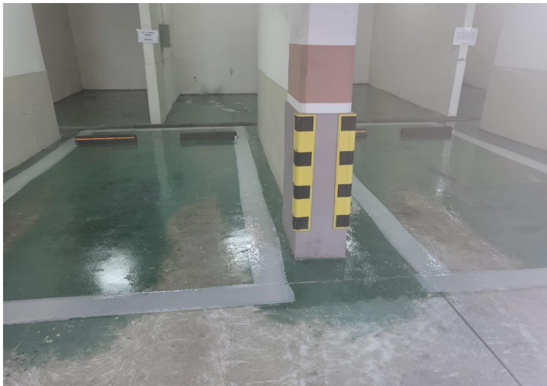
주차장 바닥 에폭시 프라이머 도포 작업
