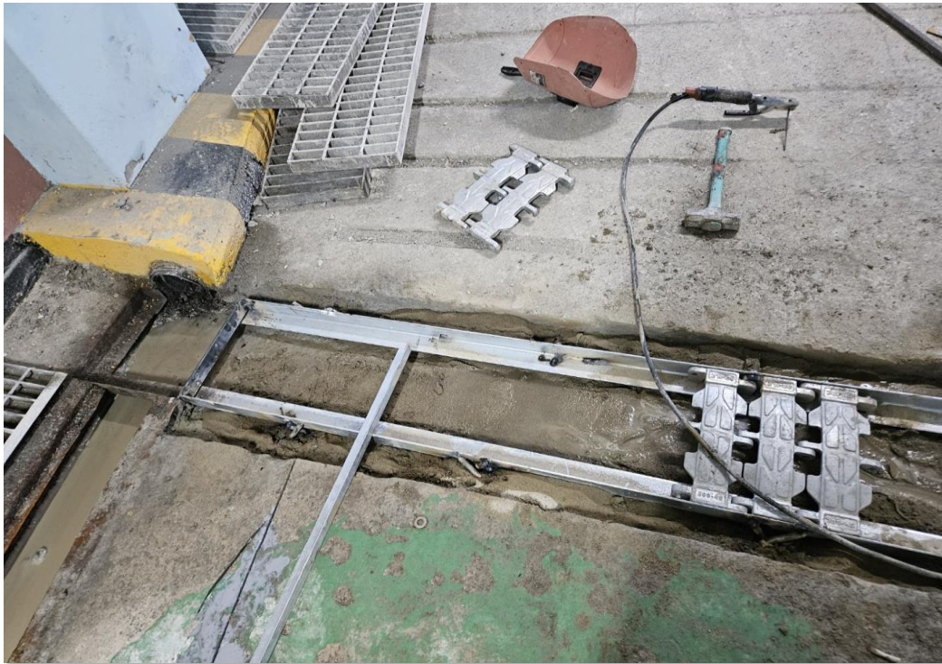
무소음 트랜치 설치
