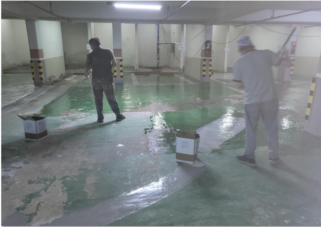
주차장 바닥 균열 보수 작업
