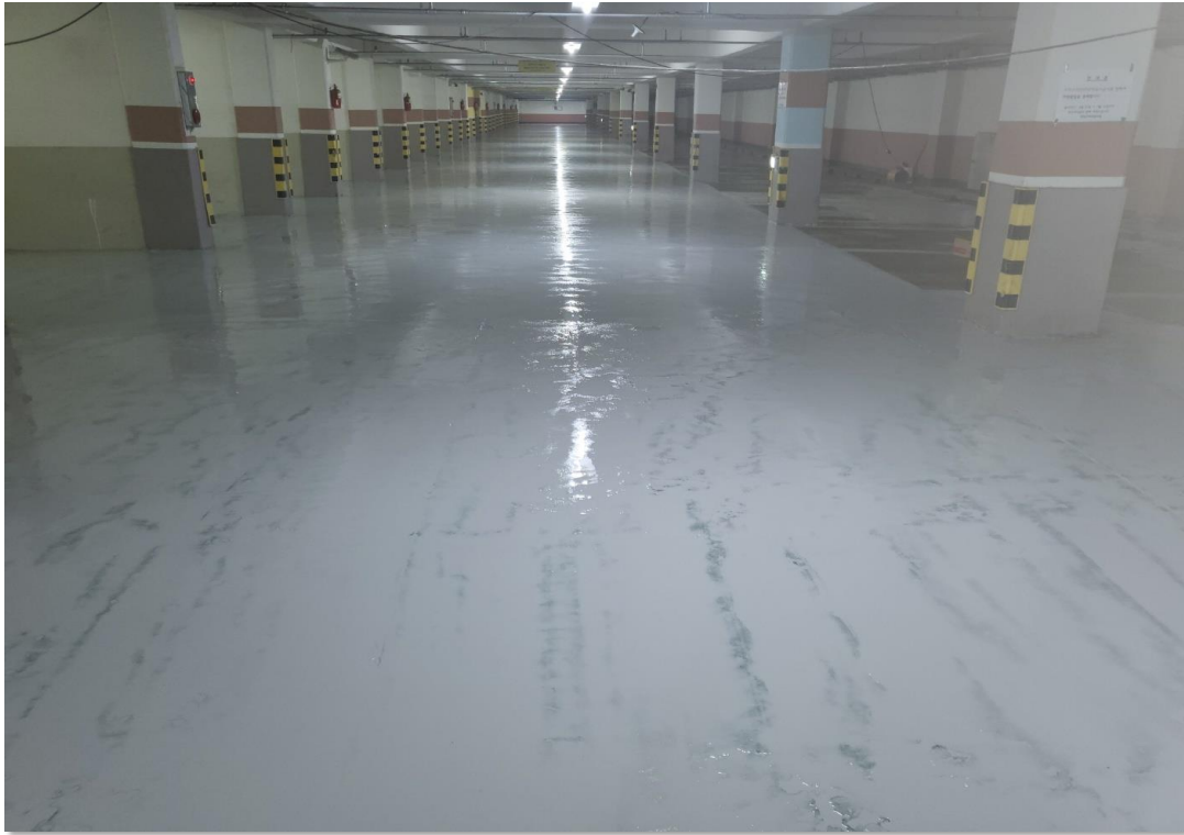
주행로 바닥 라이닝 평균 0.5mm 도포 작업
