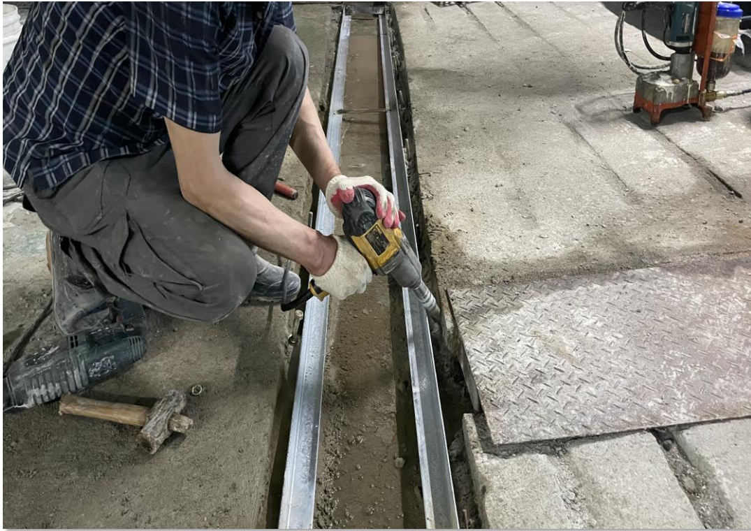
무소음 트랜치 양카 시공 및 앵글 설치
