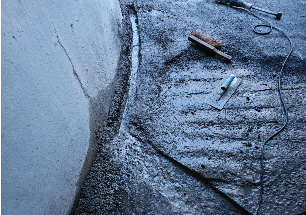
램프 출구 쪽 바닥 유도 배수로 컷팅
