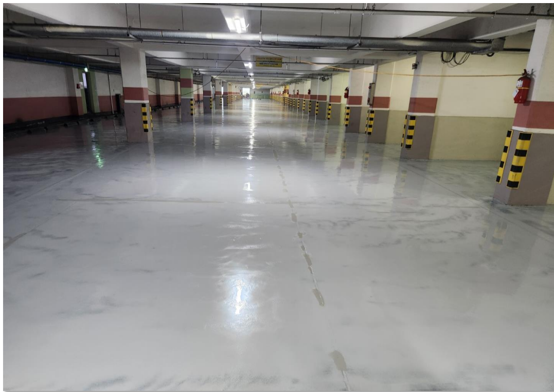
주행로 바닥 라이닝 평균 0.5mm 도포 작업
