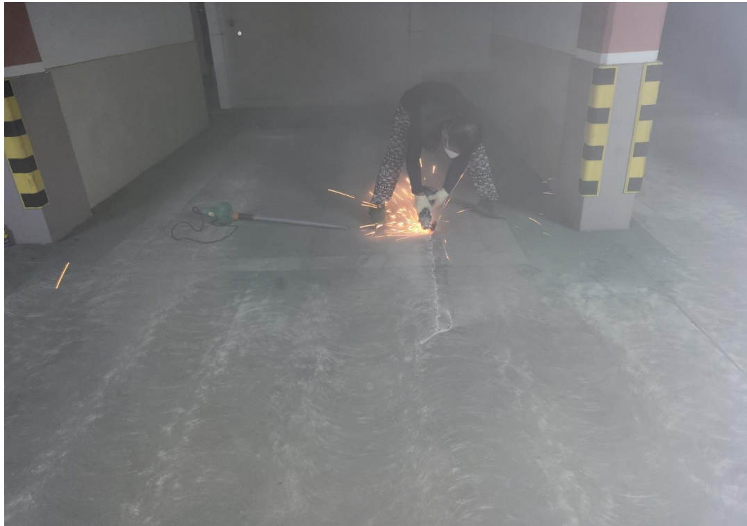
균열 v컷팅 작업
