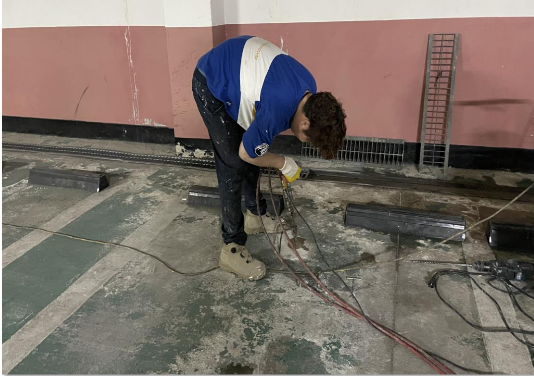
바닥 천공 후 아크릴 지수제 주입-차수공법
