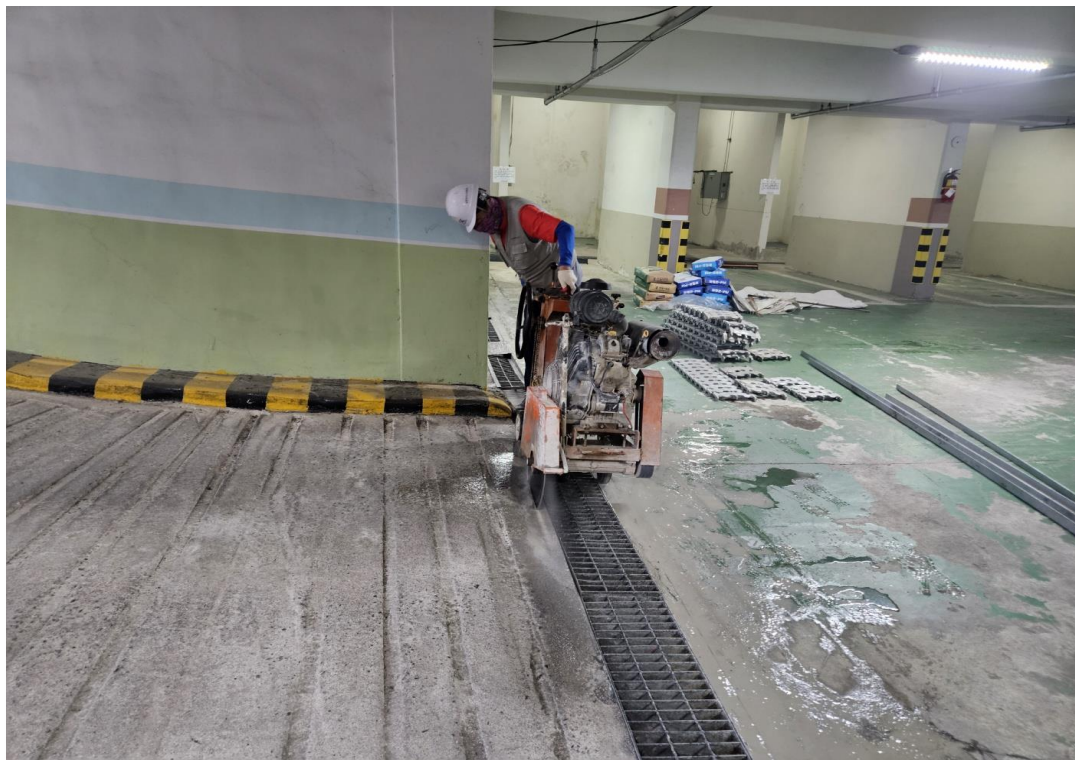
램프 앞 트랜치 바닥 커팅
