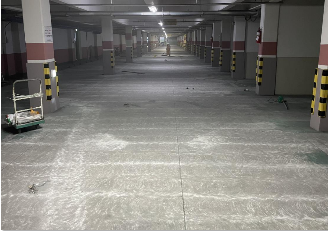
주차장 바닥 바탕면 처리
