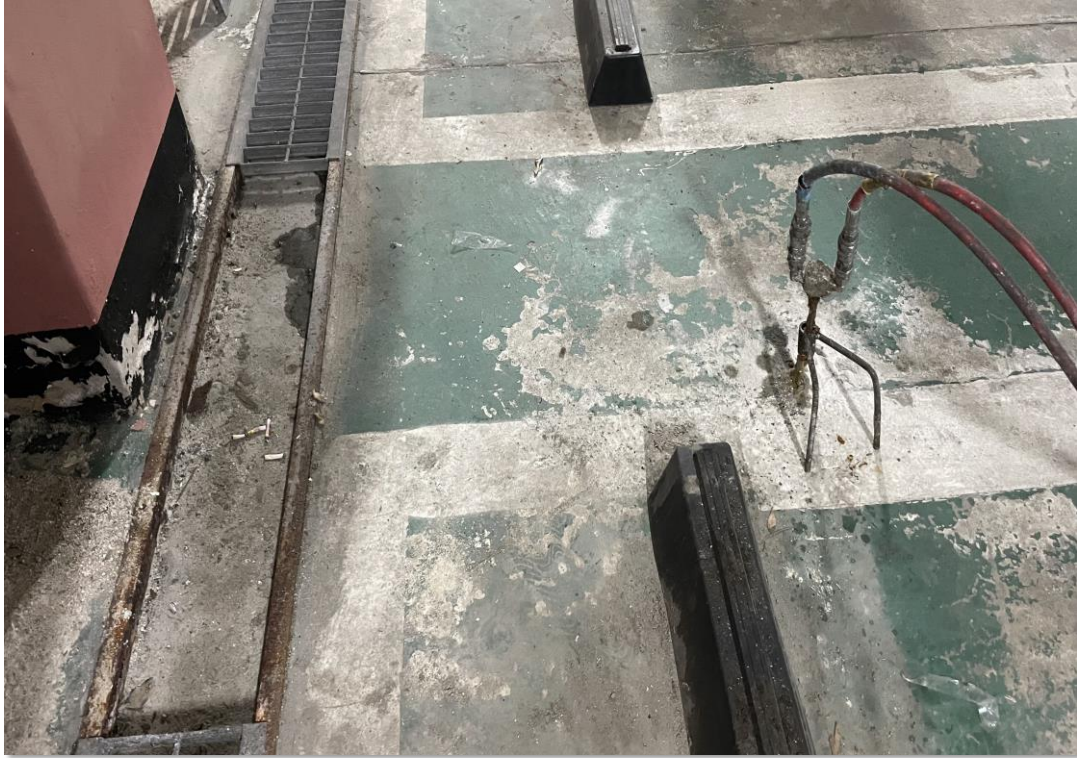
바닥 천공 후 아크릴 지수제 주입-차수공법
