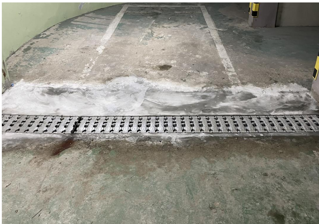
무소음 트랜치 설치
