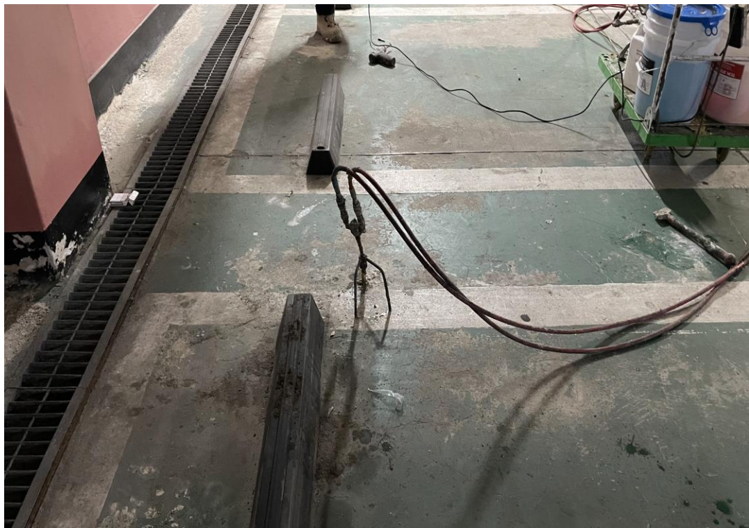
바닥 천공 후 아크릴 지수제 주입-차수공법
