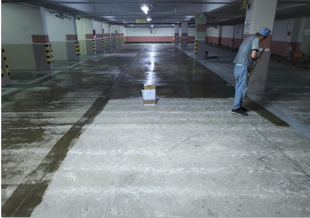
주차장 바닥 에폭시 프라이머 도포 작업
