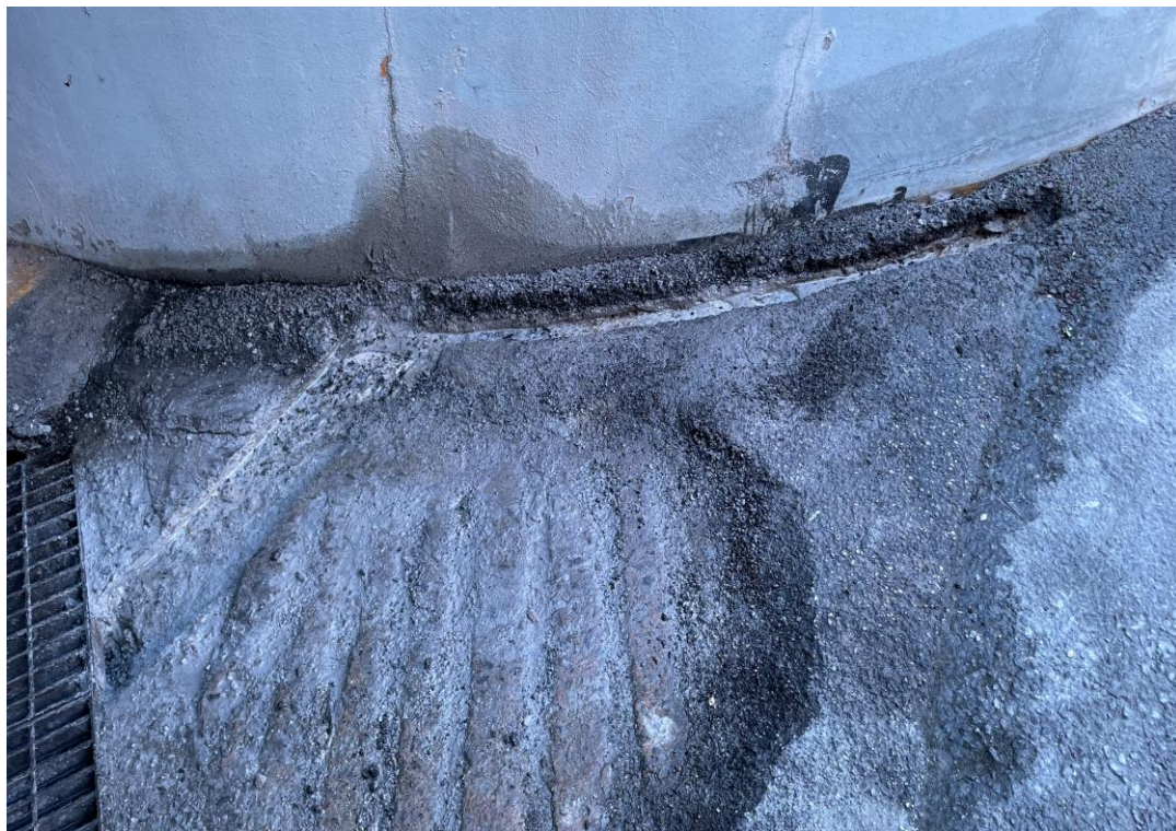
램프 출구 쪽 바닥 유도 배수로 컷팅
