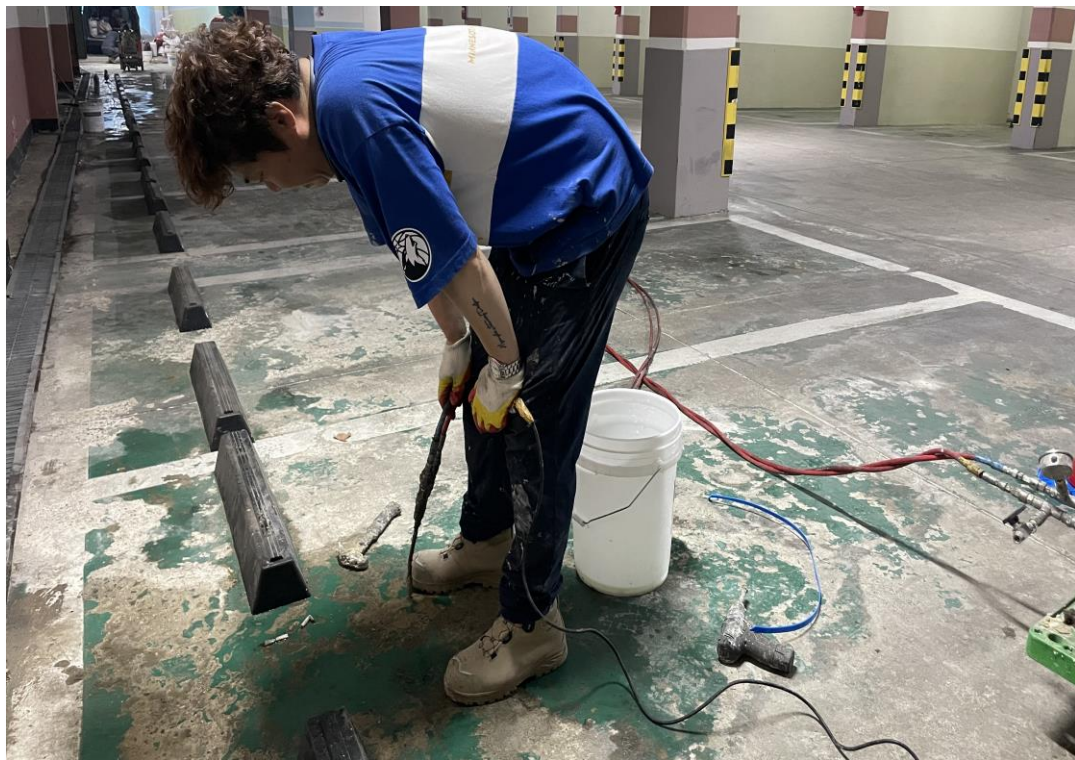
바닥 천공 후 아크릴 지수제 주입-차수공법
