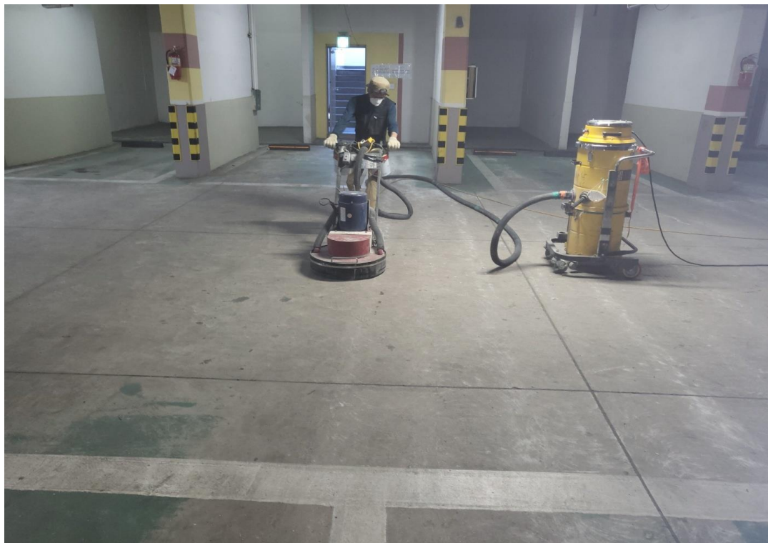
주차장 바닥 바탕면 처리
