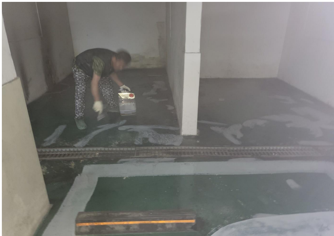
주차장 바닥 균열 보수 작업
