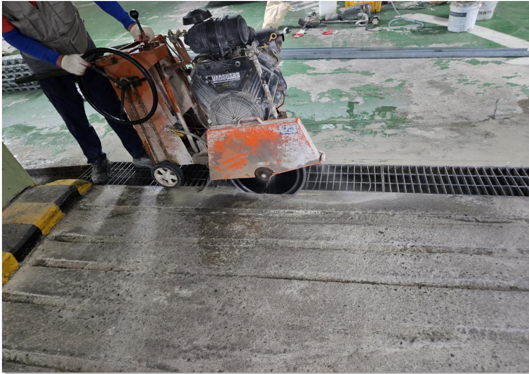
램프 앞 트랜치 바닥 커팅
