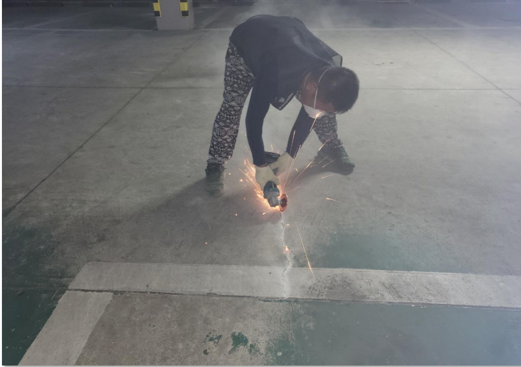
균열 v컷팅 작업
